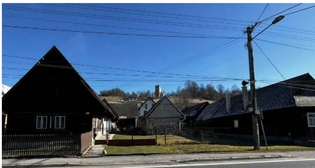
3. Pohľad z hlavnej komunikácie na hrádok, ruinu kostola s areálom ako aj rozostavanú stavbu rodinného domu
