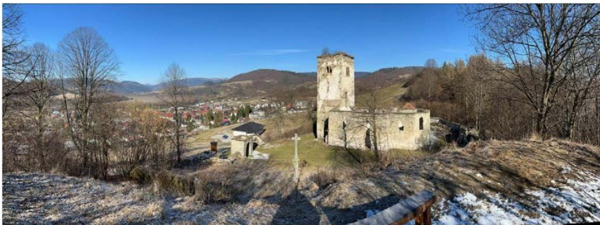
7. Panoramatický pohľad z hrádku na areál ruiny kostola s areálom ako aj v pozadí rozostavanú stavbu rodinného domu a SZ časť obce
