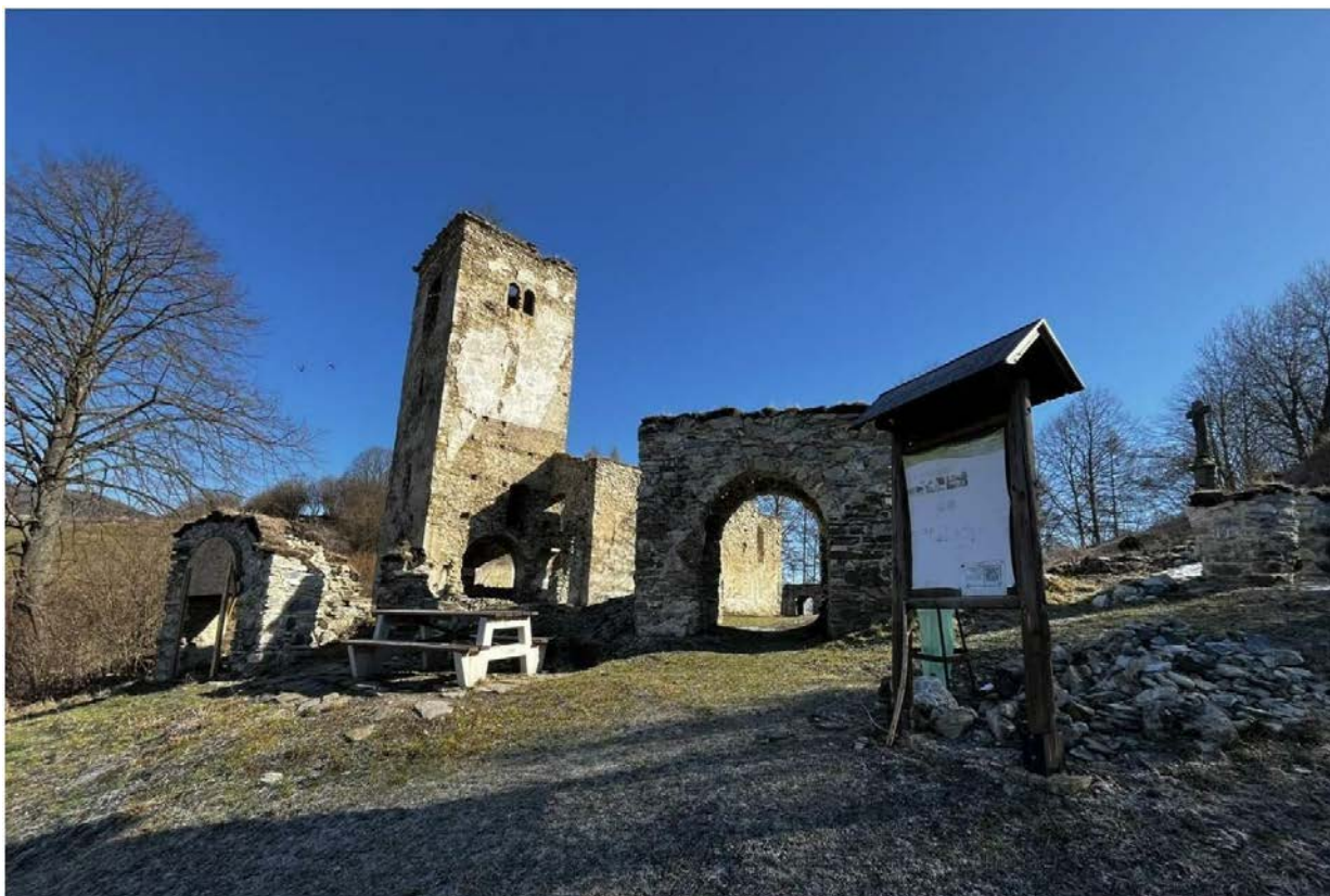
8. Pohľad na areál ruiny kostola od obce na návrší
