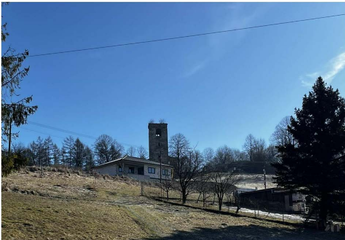
4. Pohľad od paralelnej ulice a obecného úradu na hrádok, ruinu kostola s areálom ako aj rozostavanú stavbu rodinného domu
