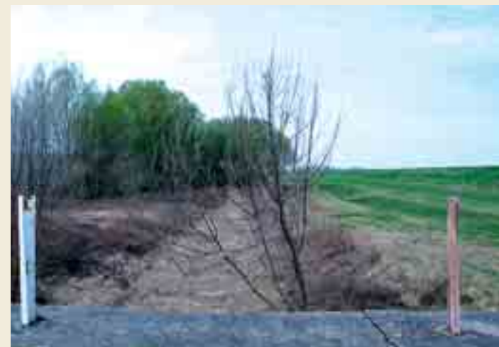
Pohľad na odtokový kanál a ochrannú protipovodňovú hrádzu v ochrannom pásme Rímskeho vojenského tábora v Iži. View of the drain canal and a protective flood dam in the buffer zone of the Roman military camp (fort) in Iža.
