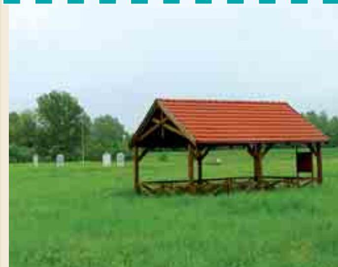
Rímsky vojenský tábor v Iži, ochranný prístrešok nad cisternou. Roman military camp (fort) in Iža, protective shelter over the cistern.
