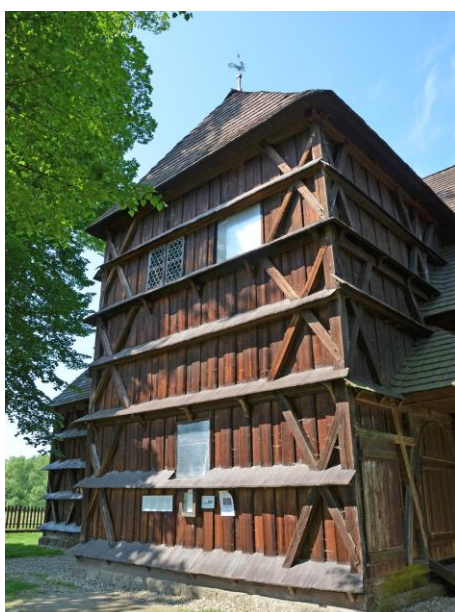
Obr. 28 Dočasné prekrytie okien plastovými výplňami počas reštaurovania okien
