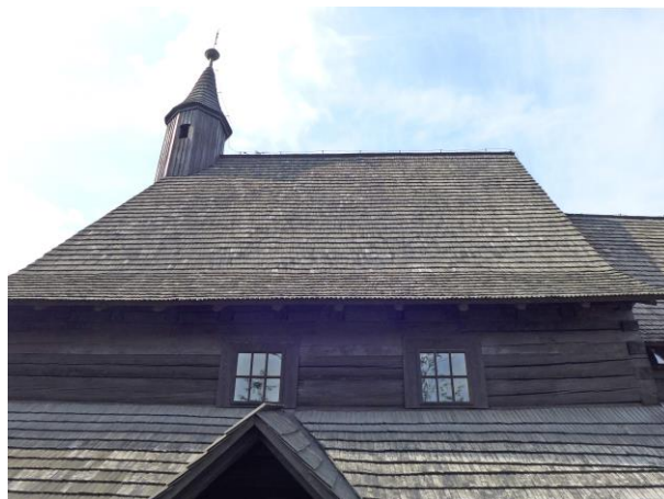
Obr. 74 Severná strana kostola, šindle strešnej krytiny sú zošednuté vplyvom slnečného žiarenia
