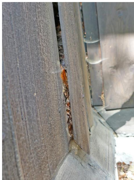
Obr. 63 Zavíhajúca južná strana kostola s uvoľneným dreveným doskovým obložením, kde je množstvo naviateho lístia
