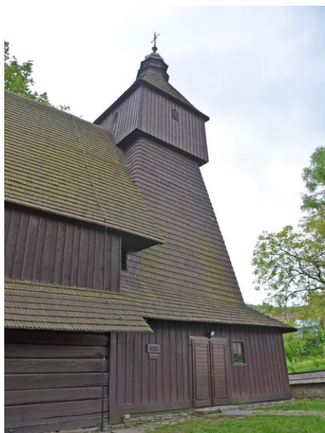
Obr. 17 Šindľová strecha obrastená nižšími rastlinami, severná strana kostola, máj 2016
