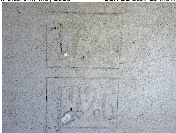
Obr. 32 Odkryté roky na murovanej menze po odstránení skrine spoza hlavného oltára
