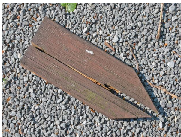
Obr. 27 Odpadnutý drevený šindel zo strechy kostola
