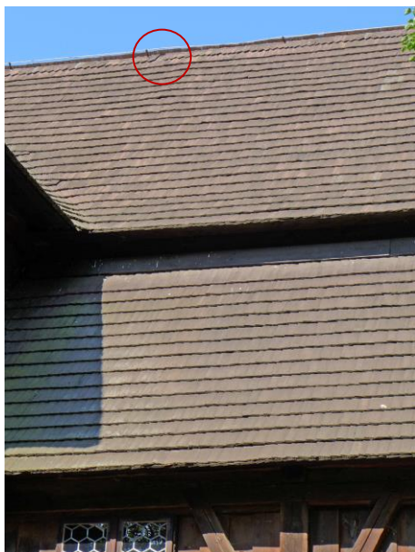
Obr. 26 Západná strana štítu strechy, miesto vypadnutého dreveného šindľa
