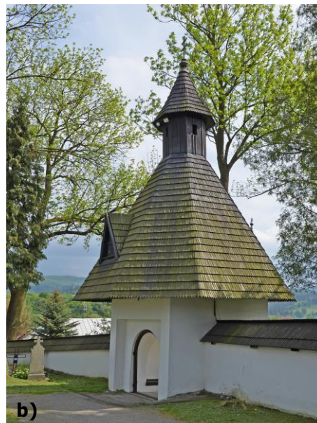
Obr. 74 Severná strana kostola, šindle strešnej krytiny sú zošednuté vplyvom slnečného žiarenia
