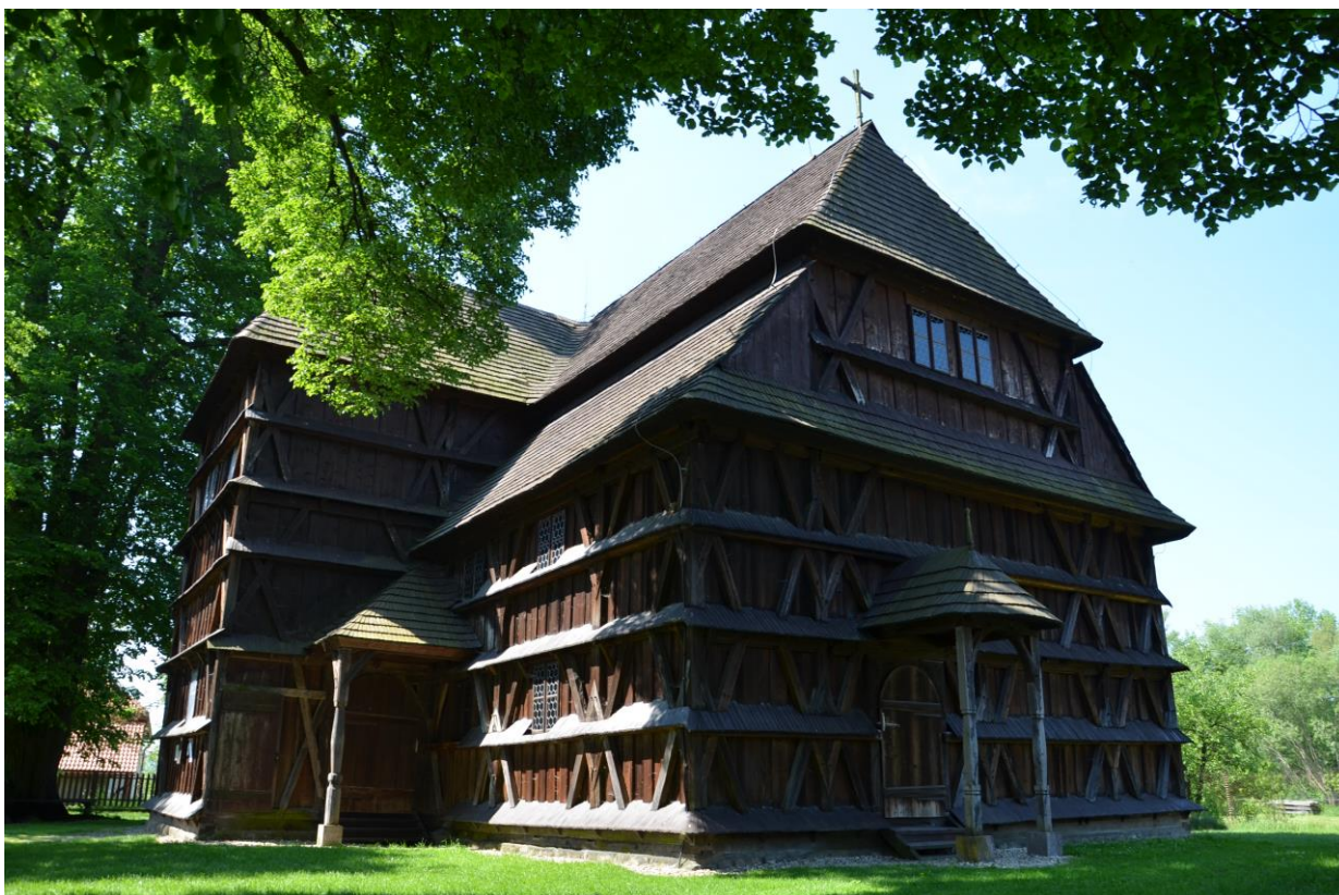
Obr. 25 Drevený artikulárny evanjelický kostol v Hronseku. Architektúra kostola sa vyznačuje jedinečnou tzv. hrazdenou konštrukciou
