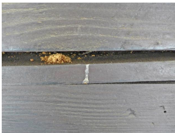
Obr. 76 Požerky po drevokaznom hmyze, severná strana kostola
