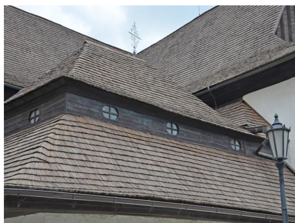
Obr. 38 Strešná krytina kostola – kompaktná a bez chýbajúcich šindľov
