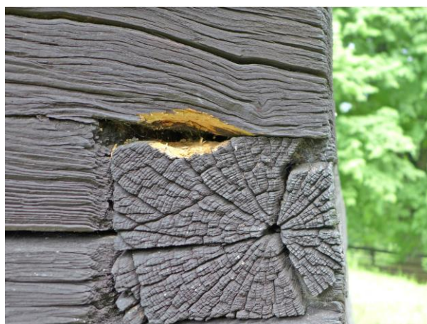
Obr. 69 Poškodenie drevenej hmoty d'at'ovitým vtáctvom hľadajúcim žijúci drevokazný hmyz, exteriér, severná strana chrámu
