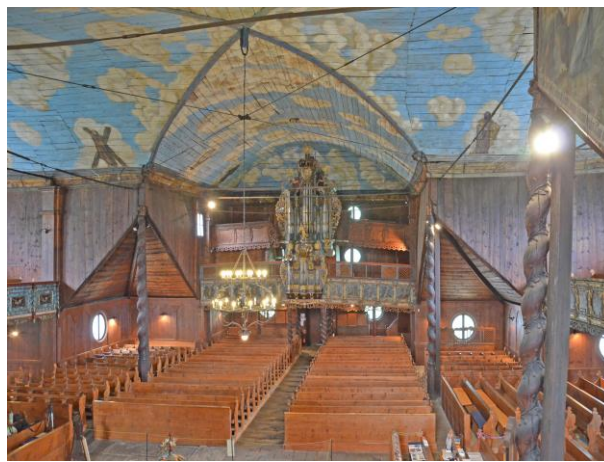
Obr. 40 Súvislý, kompaktný strop – opravená prečnievajúca doska, máj 2017
