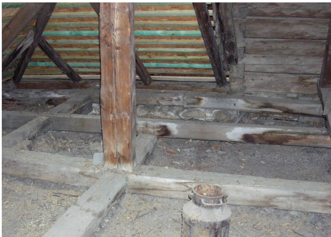
Obr. 4.7. Foto r. 2014. Dlhodobu neudržiavané podkrovné priestory v blízkosti južnej empy. Odporúča sa ošetrovanie drevených trávov.
