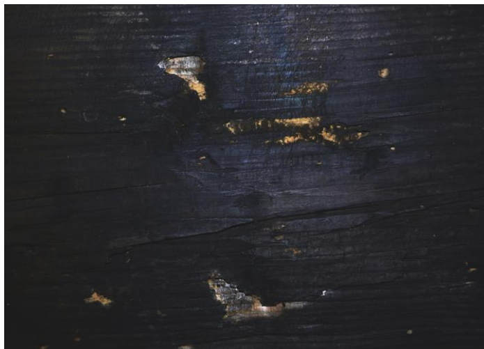
Obr. 5.6.-7. Detail dreveného obloženia, pozorované poškodenie drevnej hmoty s výskytom prachových frakcií vo výletových otvoroch.
