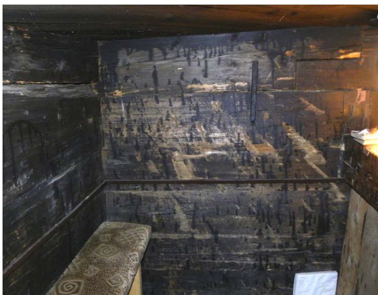
Obr. 5.5. Tmavé fláky na drevenom obložení empory so značným poškodením drewnej hmoty.
