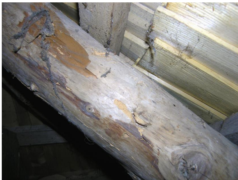
Obr. 1.4. Trám nad predsieňou napadnutý aktívnym drevokazným hmyzom.
