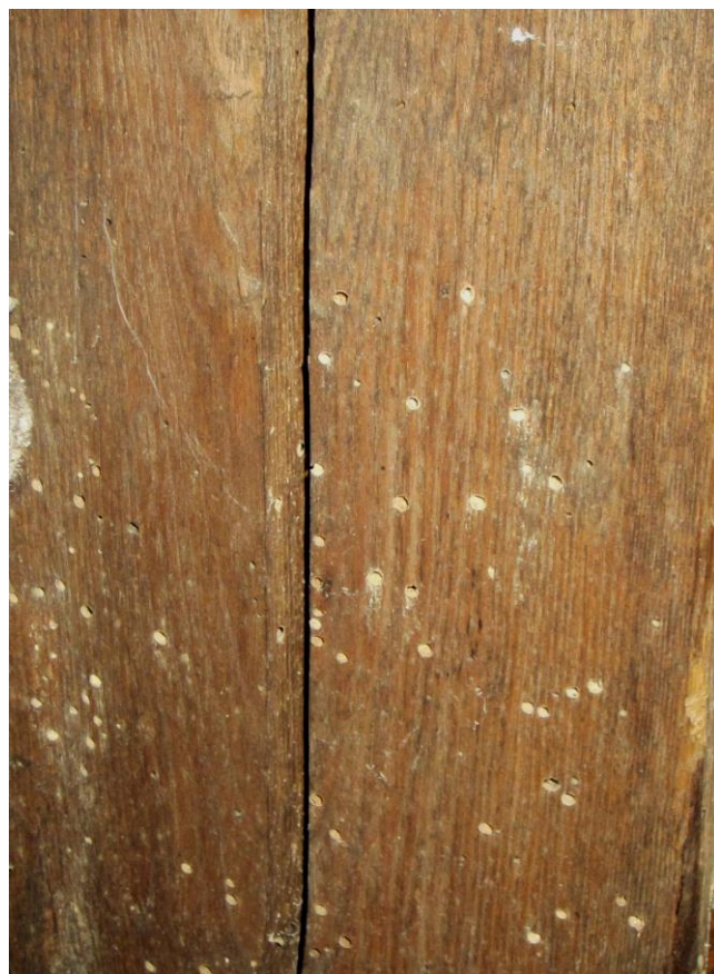
Obr. 7.8.-9. Zadná strana ikonostasu - čiastočné odstránenie navlhnutého kartónu spod pozinkovaného plechu. Rozsiahly výskyt otvorov po aktívnom drevokaznom hmyze (požerky).
