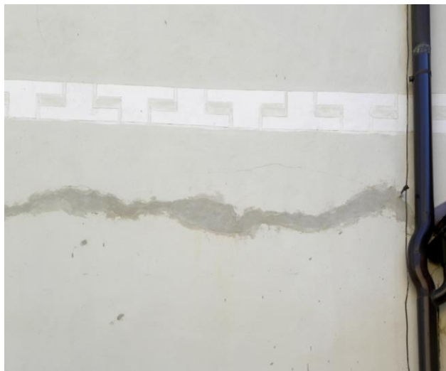
Obr. 4.2-3. Šetrne vyplnené trhliny v omietke na južnej stene západného ramena a na západnej stene severného ramena.
