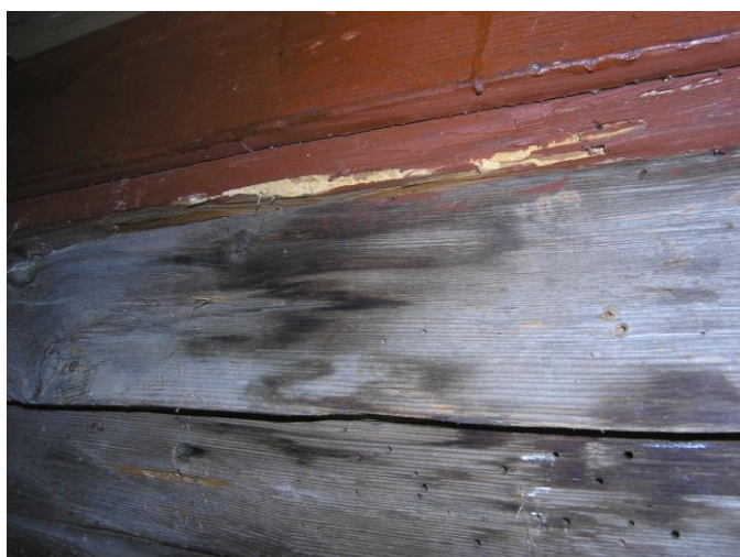
Obr. 1.5. Južná stena, rám okolo okna, oslabená drewná hmota.
