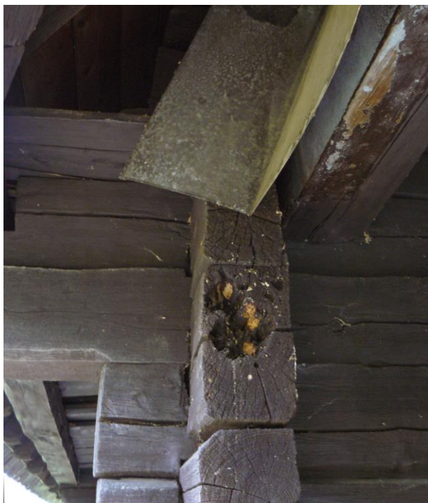
Obr. 7.4.-5. Trám na južnej strane objektu poškodený v dôsledku vody stekajúcej z rímasy. Porovnanie so stavom z apríla 2014, k výrazným zmenám nedošlo.
