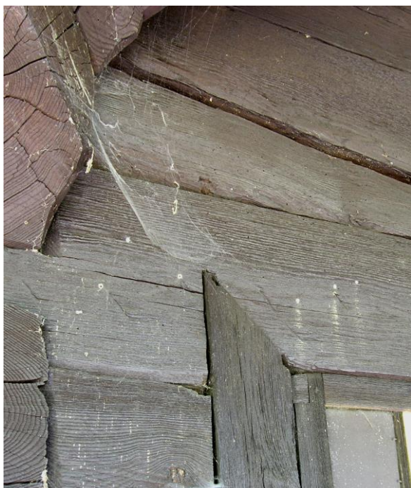
Obr. 7.2.-3. Výletové otvory drevokazného hmyzu v trámoch zrubu severnej steny (exteriér) aj s požerkami.
