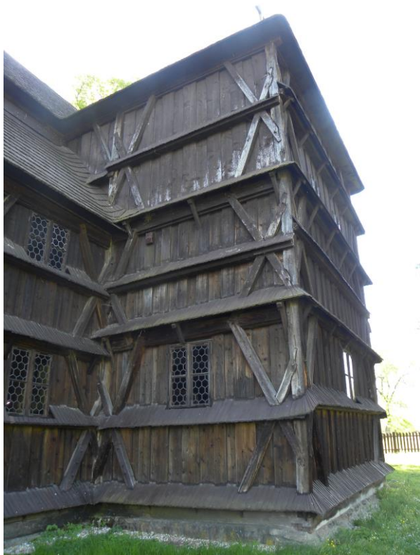
Obr. 3.2-3. Vľavo: Zošednuté trámy vplyvom poveternostných podmienok na južnej strane objektu. Vpravo: Detail na degradované prvky hrazdenej konštrukcie.
