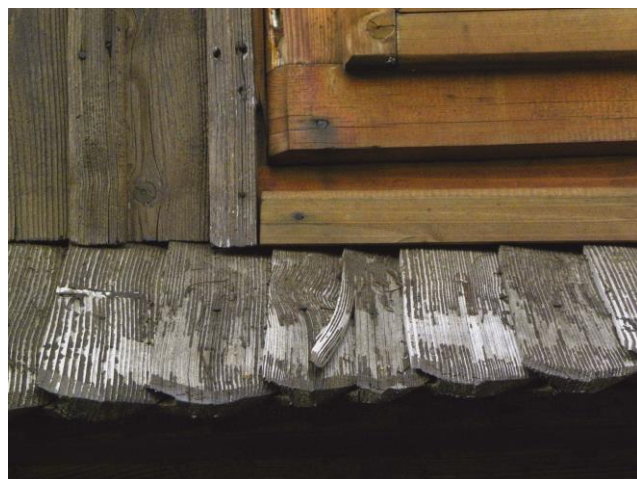
Obr. 1.2-3. Slnkom vyblednuté, ojedinele popraskané a rozštiepené strešné šindle.
