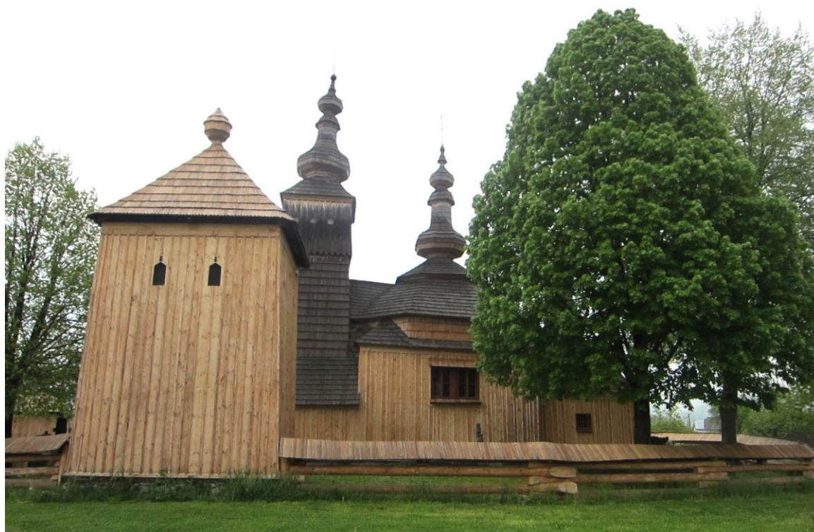
Obr. 5.2. Grécko-katolícky Kostol sv. Michala Archanjela v Ladomírovej, stav máj 2015, očistené oplatenie a opláštenie kostola a zvonice.
