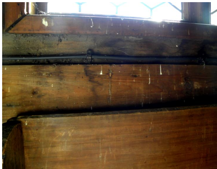
Obr. 3.5–6. Znečistenie exteriéru aj interiéru objektu trusom drobného vtáctva.
