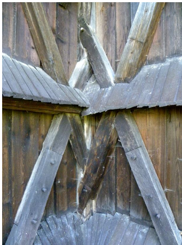
Obr. 3.2-3. Vľavo: Zošednuté trámy vplyvom poveternostných podmienok na južnej strane objektu. Vpravo: Detail na degradované prvky hrazdenej konštrukcie.
