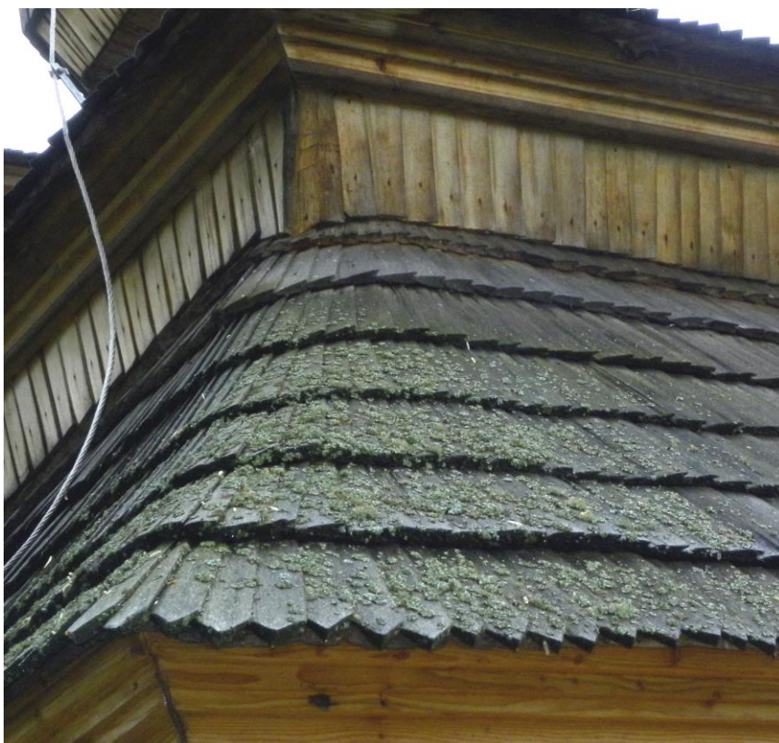
Obr. 5.3. Lokálne porasty na strešnej krytine nižšími rastlinami.
