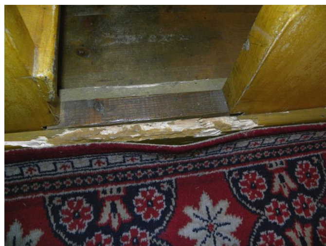
Obr. 1.4. Trám nad predsieňou napadnutý aktívnym drevokazným hmyzom.
