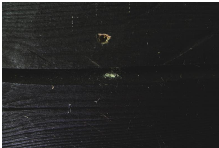
Obr. 7.2.-3. Výletové otvory drevokazného hmyzu v trámoch zrubu severnej steny (exteriér) aj s požerkami.
