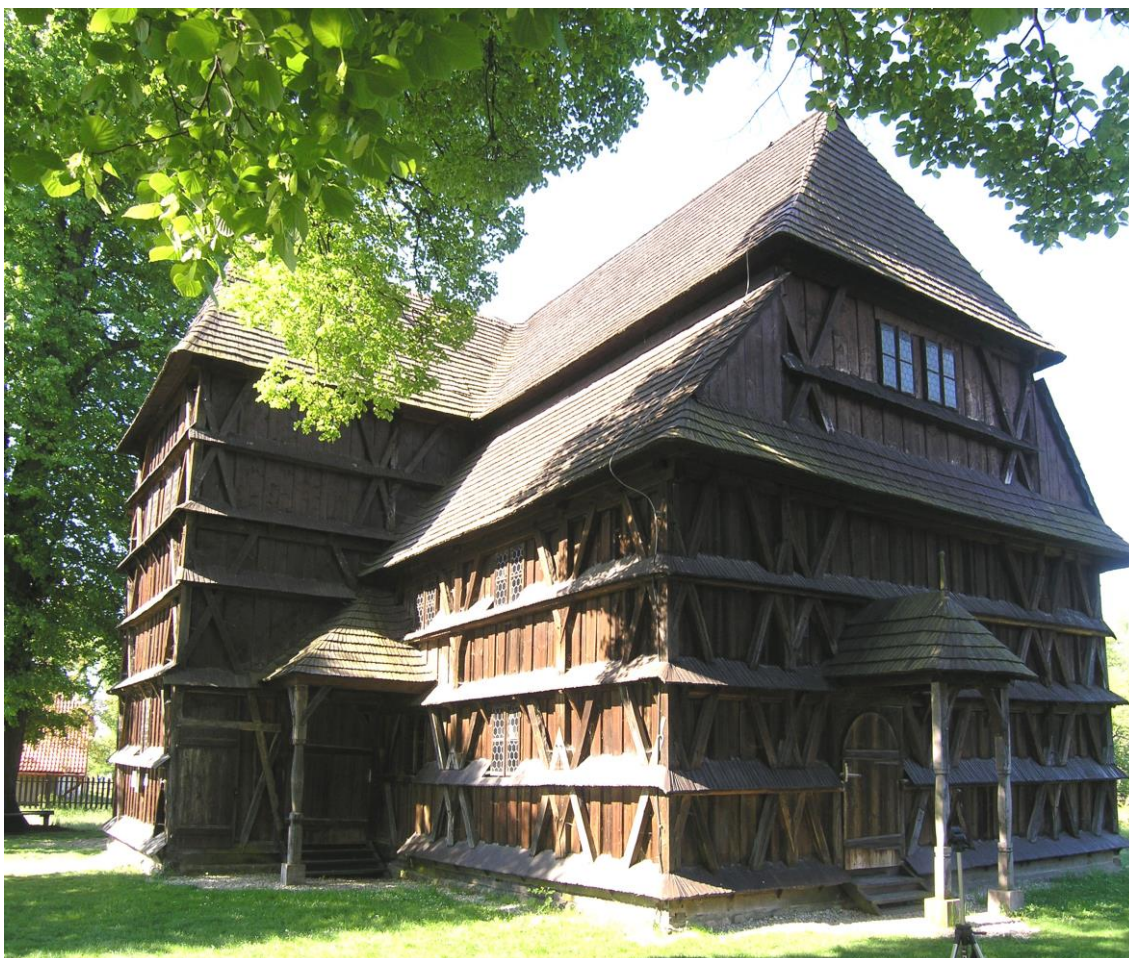
Obr. 3.1. Drevený artikulárny evanjelický kostol v Hronseku. Architektúra kostola sa vyznačuje jedinečnou tzv. hrazdenou konštrukciou.
