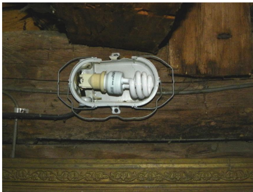
Obr. 7.7. Chýbajúci kryt osvetlenia v interéri kostola.
