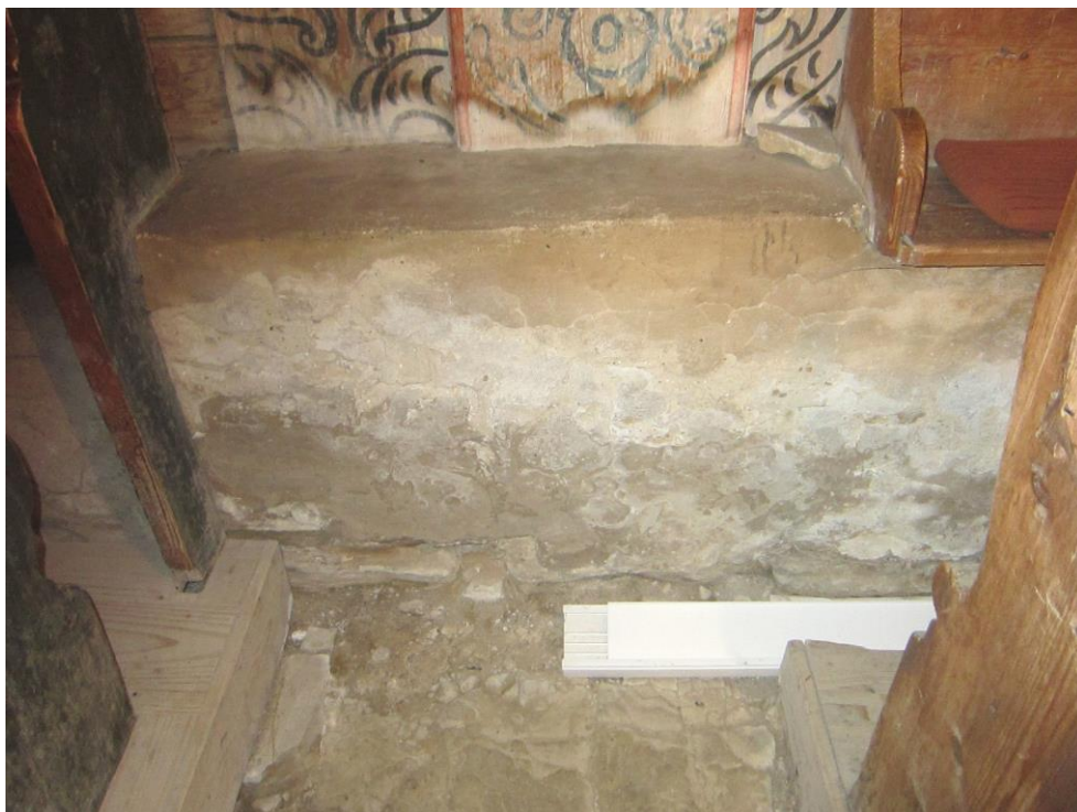
Obr. 6.6. Biele fľaky na omietke sokla na južnej strane nasvedčujúce na zasolenie (zaváňanie).
