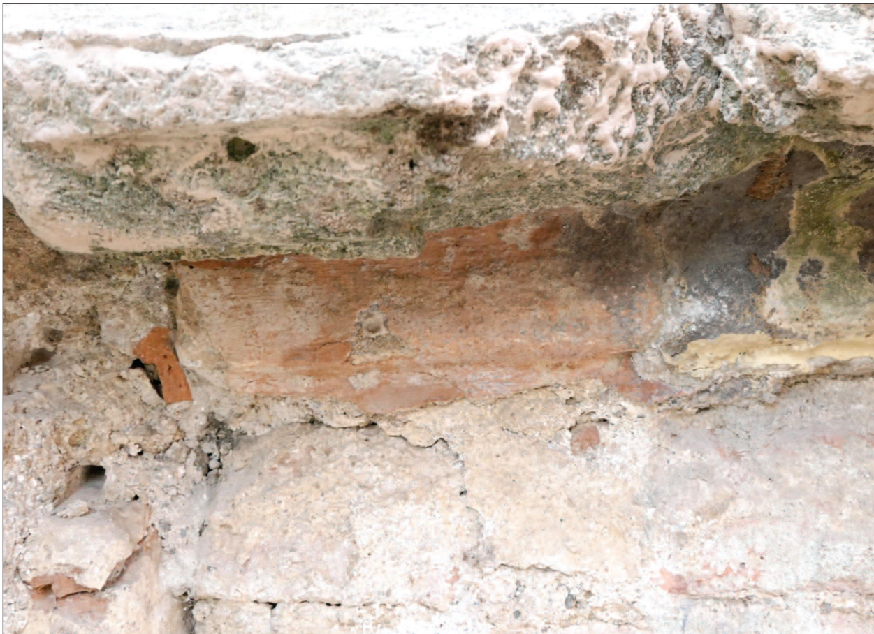
Obr. 5. Severná fasáda severnej veže, spodná strieška východného oporného piliera so zvyškom červeného náteru v podhlade.
