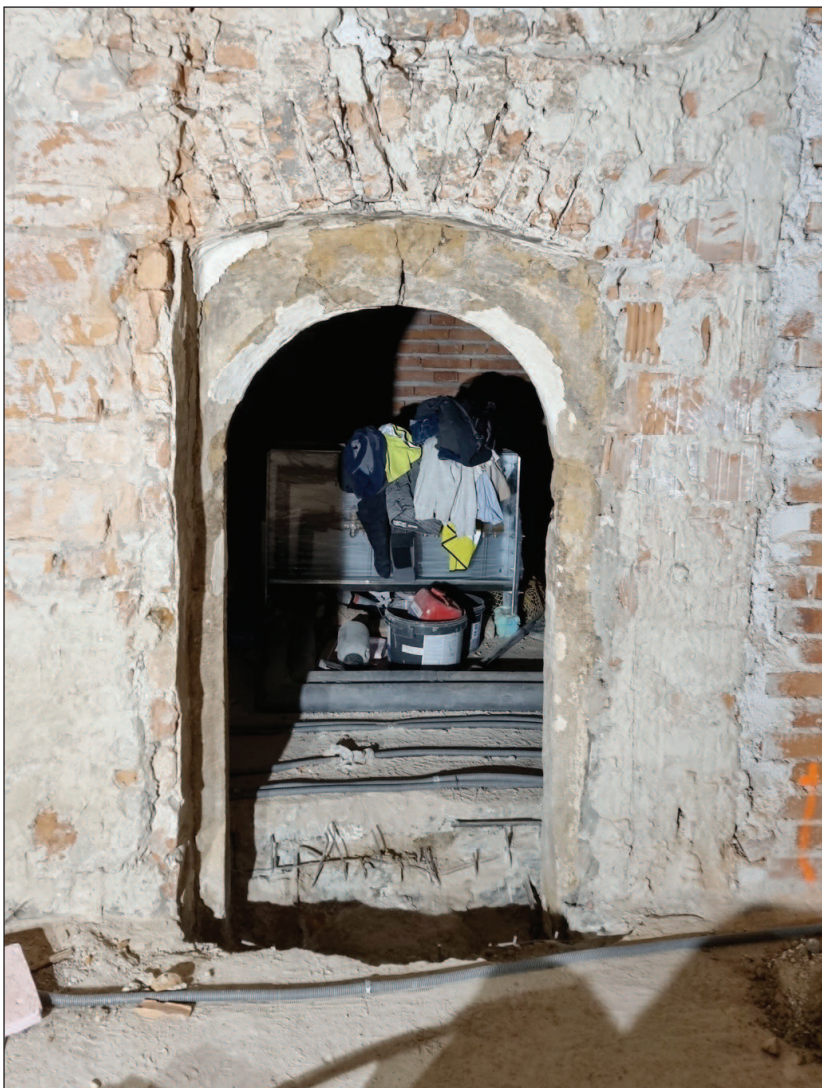
Obr. 11. Stredoveký kamenný portál vo východnej stene vstupnej siene v 2.NP, sekundárne vložený do pôvodného otvoru z 2.stredovekej etapy, foto: J. Žuffová.
