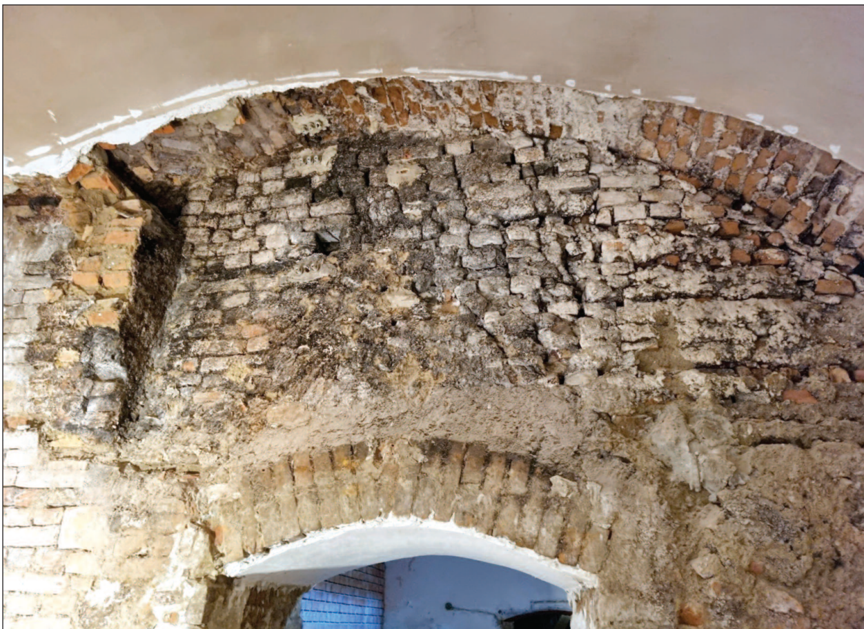
Obr. 5. Nepravidelný povrch západnej steny pivnice najstaršej stavby typický pre základové konštrukcie. Základ Prachárne siahla až po úroveň dnešného terénu, foto: J. Žuffová.
