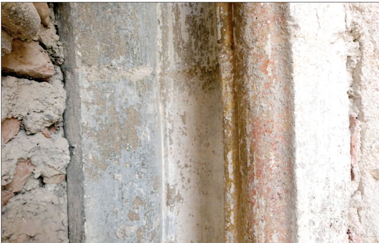
Obr. 3. Detail odkrytej časti gotického portálu s pôvodnou červenou, žltou a sivomodrou polychrómiou.
