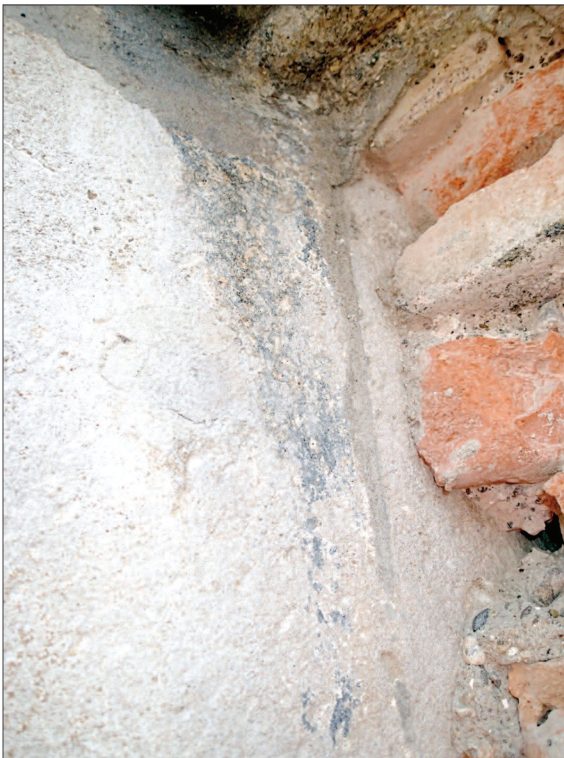
Obr. 7. Fragmenty sivej farebnosti na bočnej stene chrliča.
