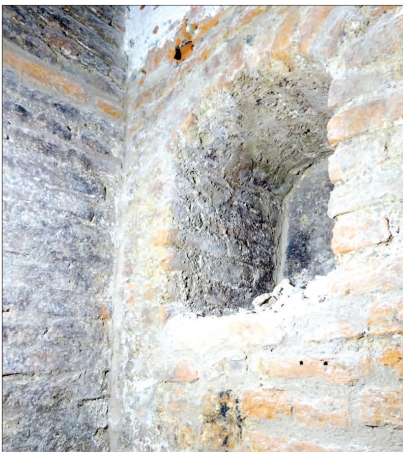
Obr. 14. Odkladacia nika v západnej stene pivnice vysunutej pod Radlinského ul., z 2.stredovekej etapy Prachárne, foto: M. Kazimír.
