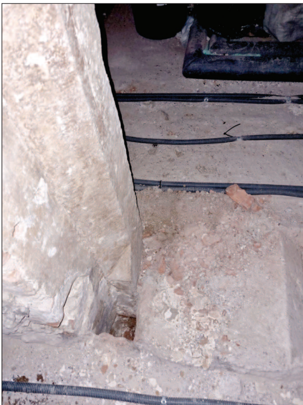
Obr. 12. Detail stojky stredovekého portálu sekundárne vloženého do pôvodného otvoru z 2.stredovekej etapy s odkrytým trojuholníkovým nosom, ktorým prechádza široko okosená brana do sokla, foto: J. Žuffová.
