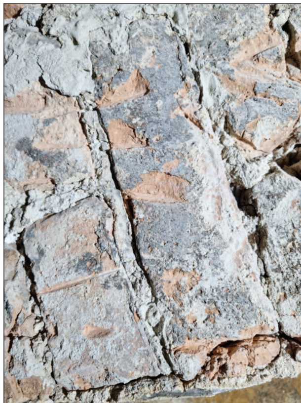
Obr. 13. Detail segmentového, škárovaním upraveného čela oblúka pôvodného otvoru z 2.stredovekej etapy v 2.NP, do ktorého neskôr vložili kamenný portál, foto: J. Žuffová.
