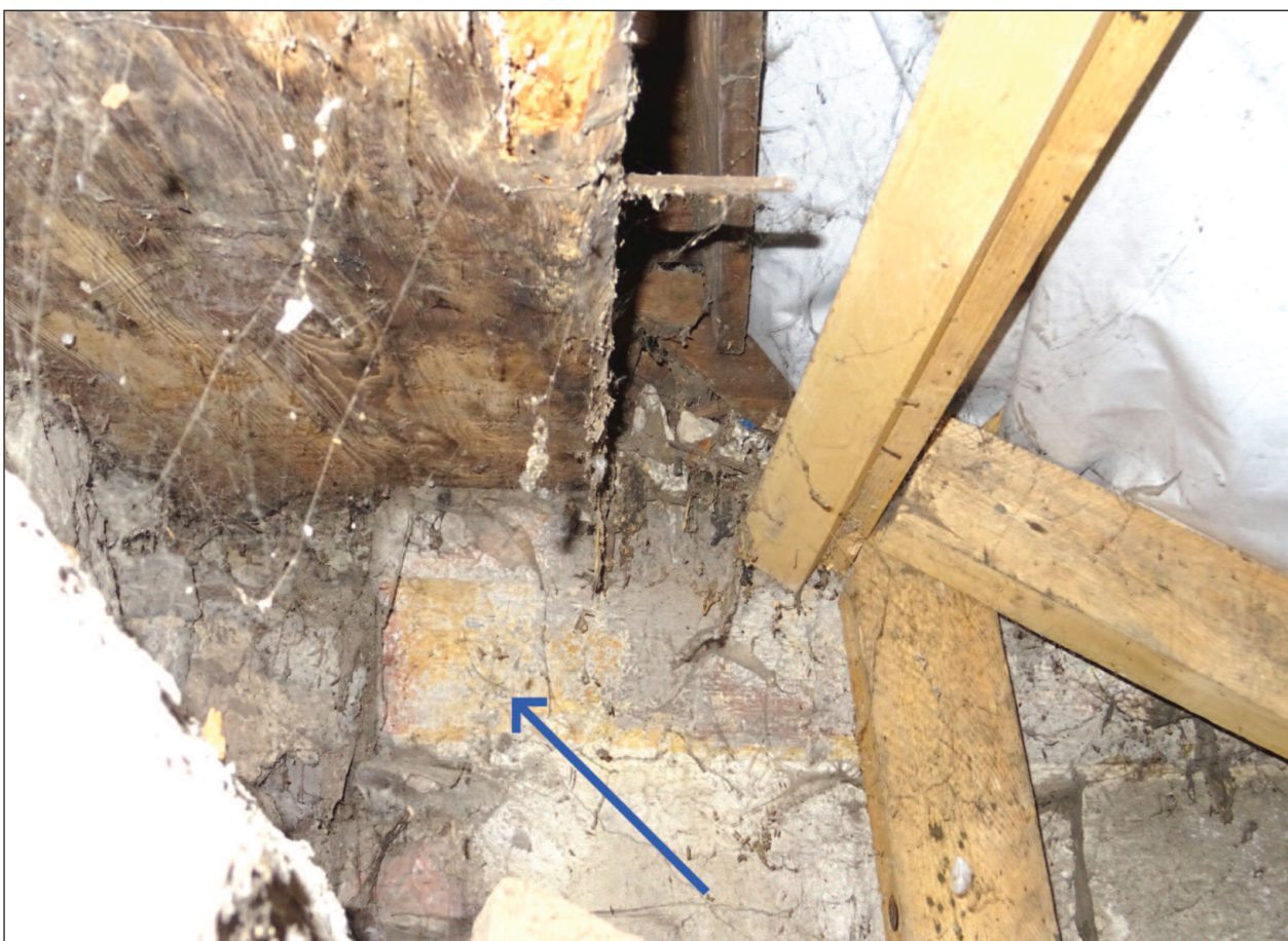
Obr. 9. Zvolen, farský Kostol sv. Alžbety, úsek polychrómovanej gotickej korunnej rímsy na južnej fasáde svätyne, vtiahnutý do podkrovia po prístavbe Kaplnky Sedembolestnej Panny Márie zo 17.stor.
