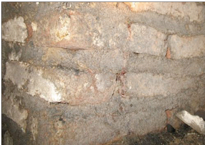
Obr. 15. Tzv. podrezávané škárovanie z 1. stredovekej etapy Prachárne, foto: J. Žuffová.
