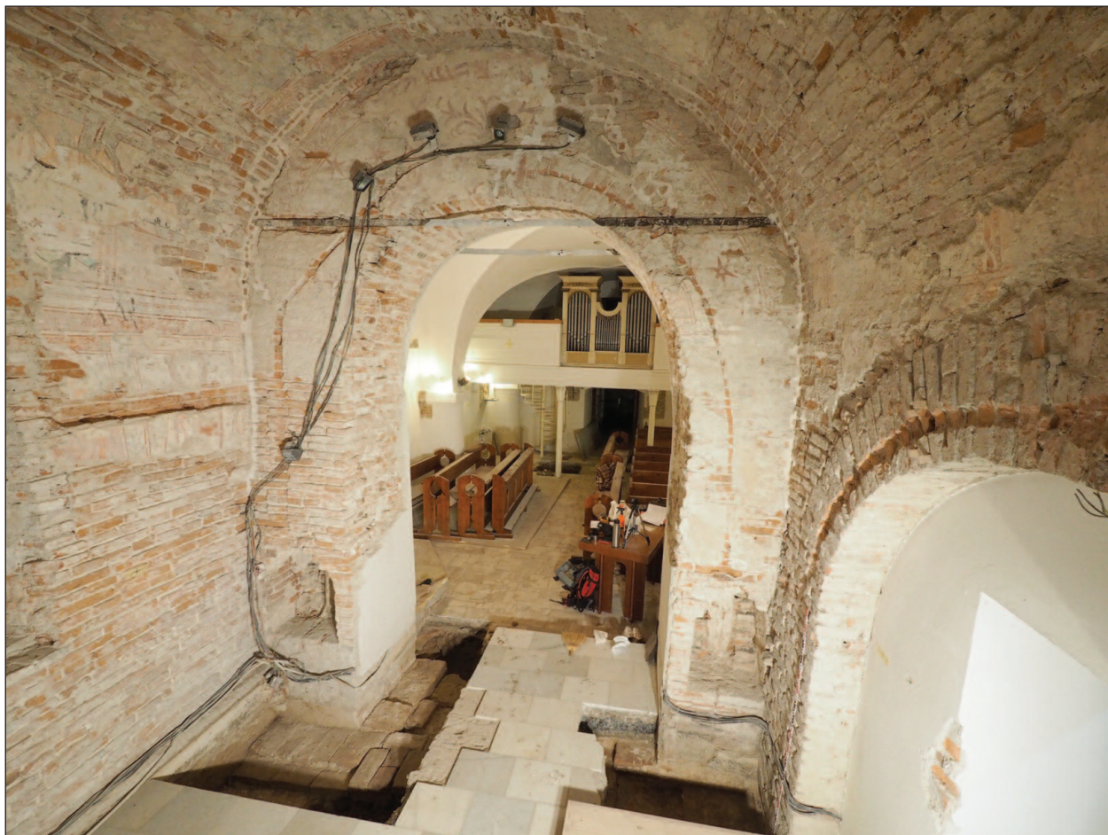
Obr. 11. Pohľad z presbytéria na múr chórovej prepážky s odkrytými bifóriami, foto: M. Bóna, 2020.
