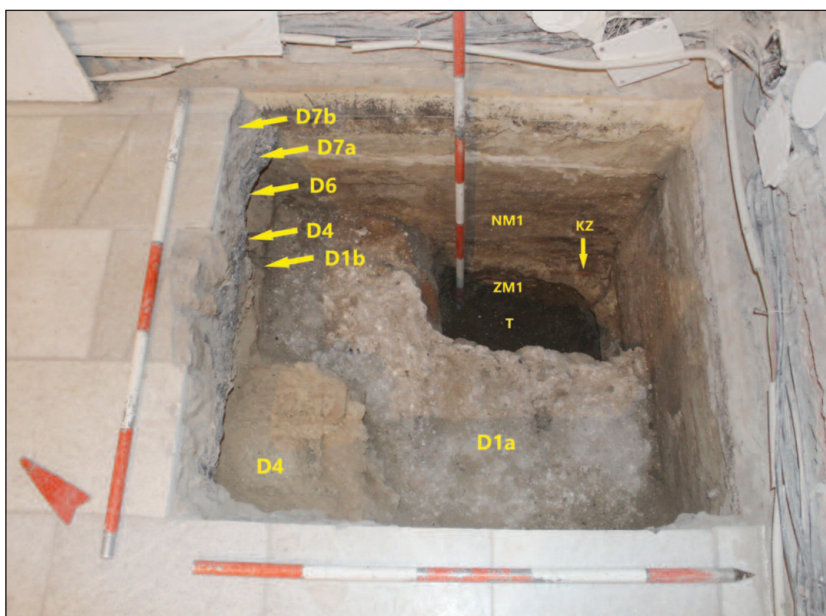
Obr. 16. Archeologická sonda 3/2020, západný pohľad. Legenda: D1a – primárna románska podlaha, D1b – mladšia románska podlaha, D4 – renesančno-baroková podlaha, D6 – neoslohová podlaha, D7a, D7b – novodobé dlažby, T – terén, ZM1 – románsky základ východnej steny, KZ – koruna základu východnej steny, NM1 – nadzemné murivo východnej steny, foto: I. Horváth, 2020.
