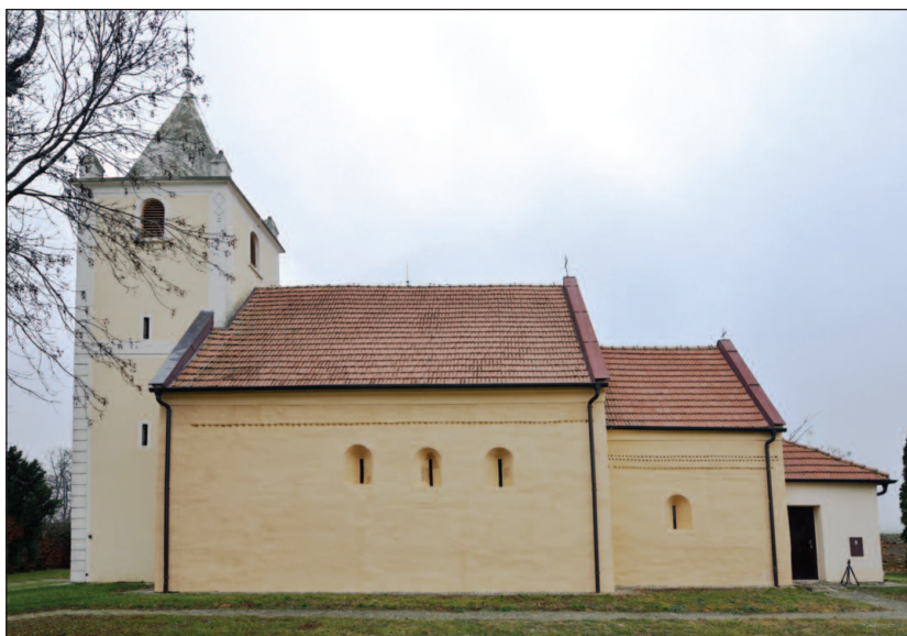
Obr. 18. Južná fasáda kostola po reštaurovaní, foto: P. Záhora, 2020.
