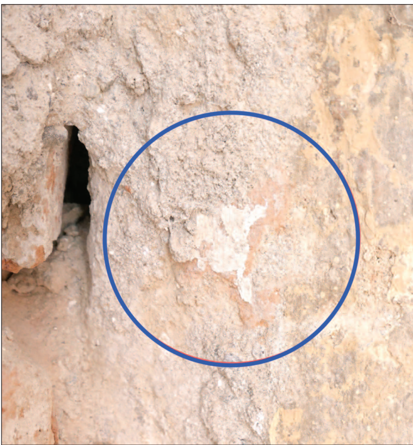
Obr. 6. Severná fasáda severnej veže, okenný otvor v 2.NP; fragment červeného náteru na východnej špalete vonkajšej niky gotického okna.
