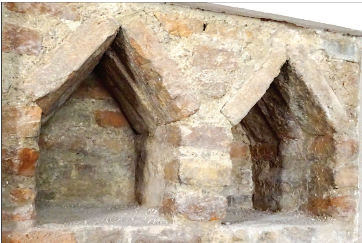
Obr. 4. Dvojica odkladacích ník s uzáverom v tvare striešky po obnove prezentovaných v tzv. analytickej sonde, foto: M. Kazimír.
