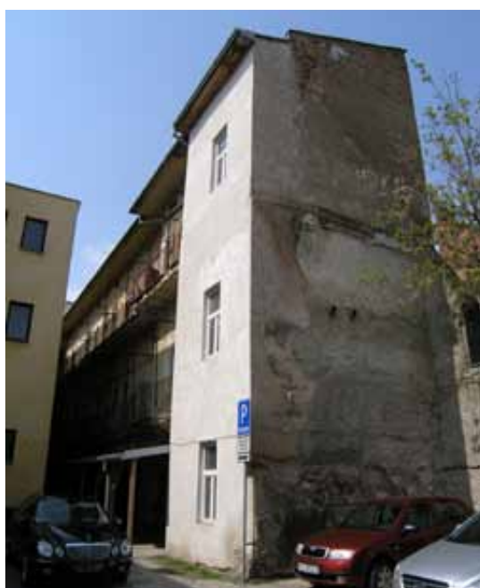
Dvorové krídlo objektu ukončené hmotou schodiska (pohľad z východu)
