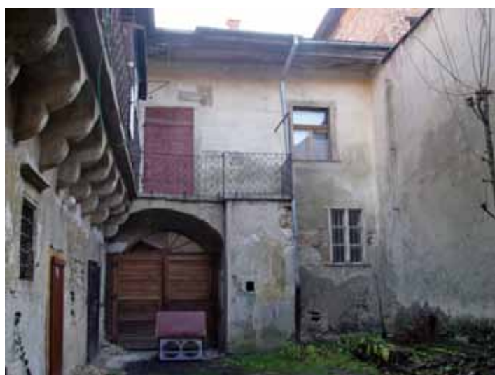
Dvor, pohľad na predný trakt, prejazd orientovaný do námestia (foto: M. Janovská)
