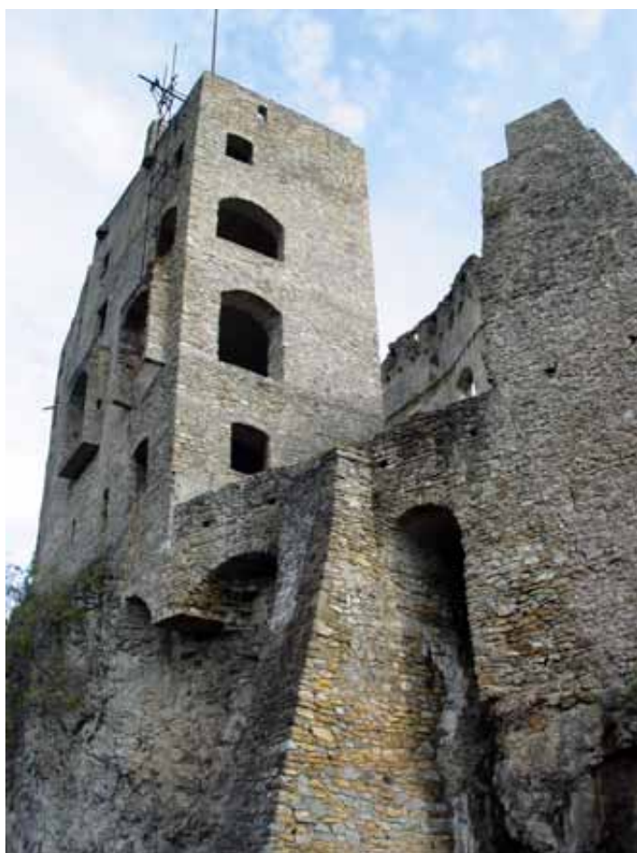
Rekonštruovaná hmota severného paláca s arkiermi a opornými piliermi (chýbajúci ľavý), vyrastajúcimi z druhého predhradia (foto: M. Janovská)
