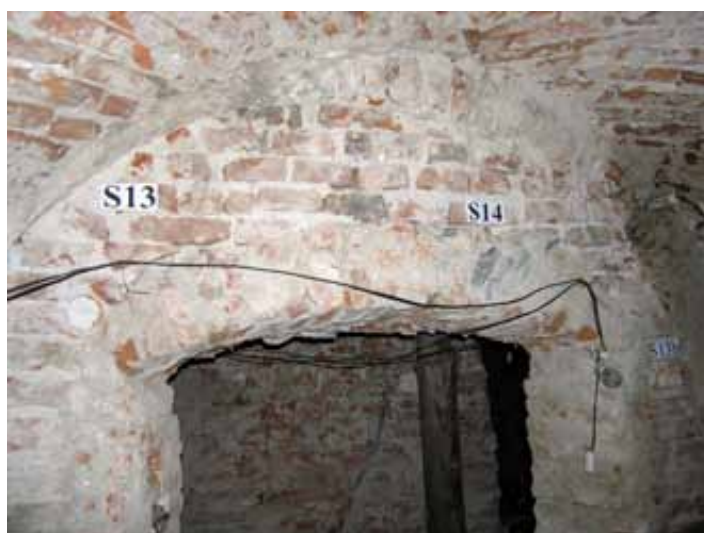
Nález rozložitého polkruhovo zaklenutého oblúka (renesančná etapa), v ktorého zámurovke bol niekedy koncom 19. storočia vytvorený dverný otvor so segmentovým záklenkom – južná stena p. č. 2.07
