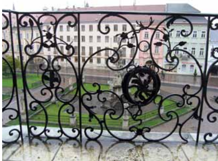
Detail kovanej mreže balkóna hlavnej fasády
