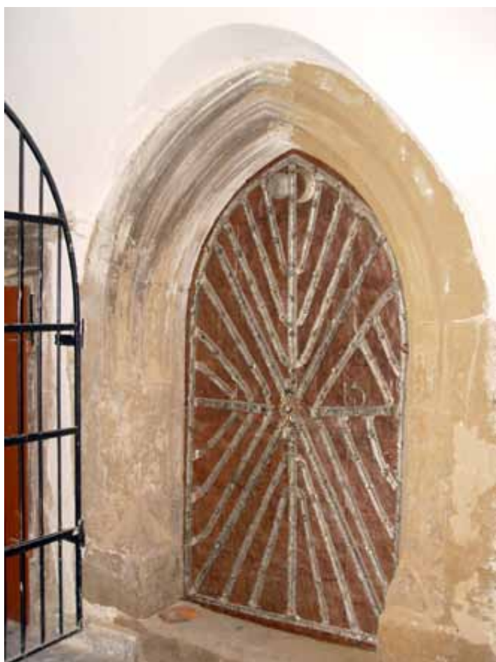
Pôvodný portál s kovanými plátovanými dverami v prízemí predného traktu – prejazd (foto: M. Janovská)
