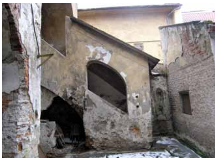
Pôvodne renesančné exteriérové schodisko primkávajúce sa k parcelnému múru.
