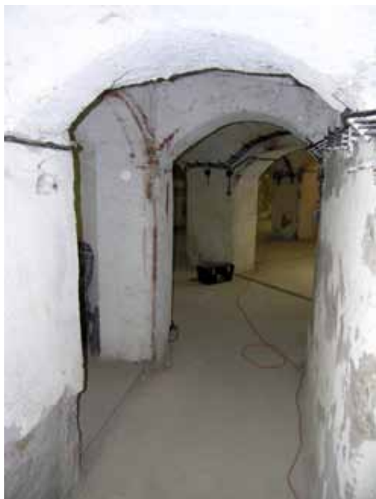
Suterény v spojnici medzi severným a západným krídlom objektu
