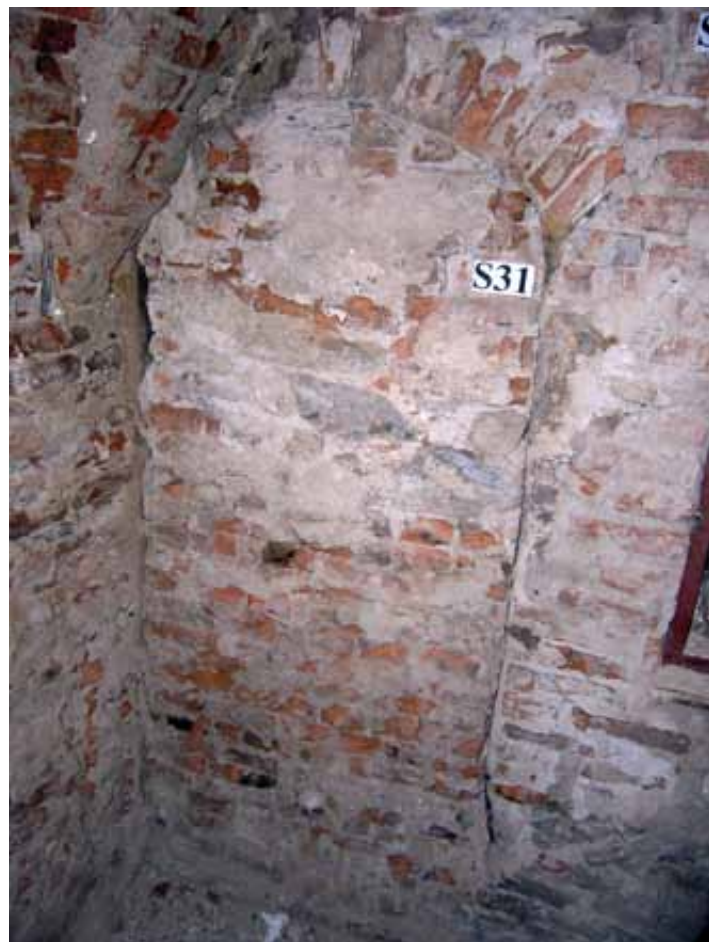
Druhotne zamurovaný neskorostredoveký dverný otvor na južnej stene p. č. 2.09.
