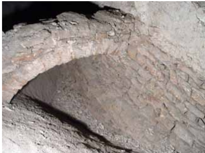
Tehlové klenbové pásy v podstreší, ktoré pôvodne niesli kamenné medzistrešné žľaby staršieho neskorogotického zastrešenia halového kostola (foto: M. Janovská)
