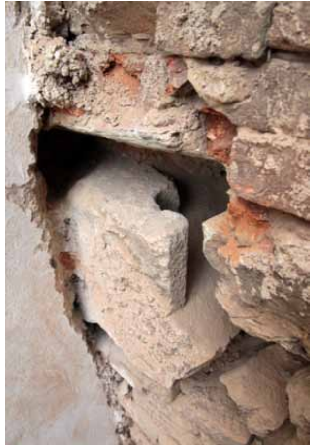
Druhotne umiestnený fragment gotického rámu okna s časťou napojenia na profil parapetnej rímsy
