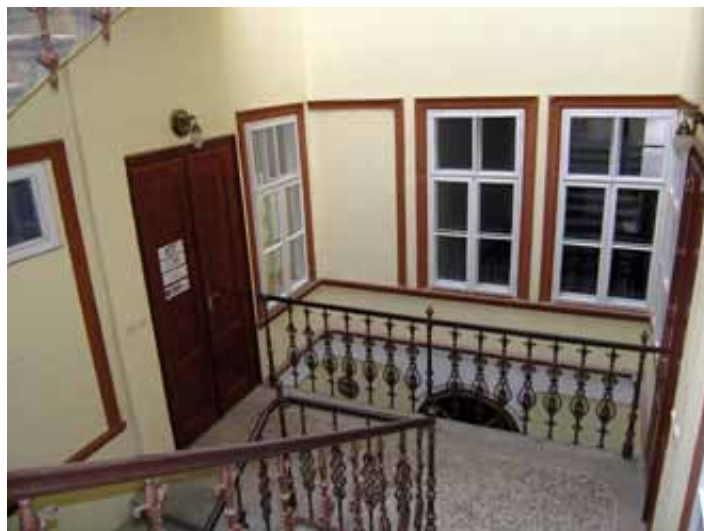
Centrálne schodisko objektu s podestami a s okennými otvormi privádzajúcimi svetlo do interiérov hlavnej časti objektu
