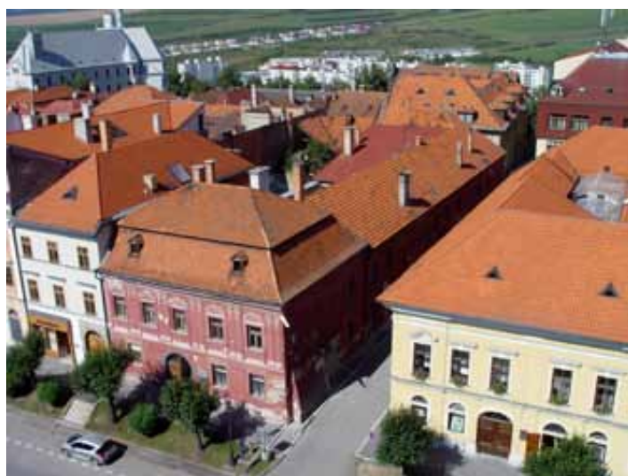
Celkový pohľad na objekt (foto: M. Janovská)
