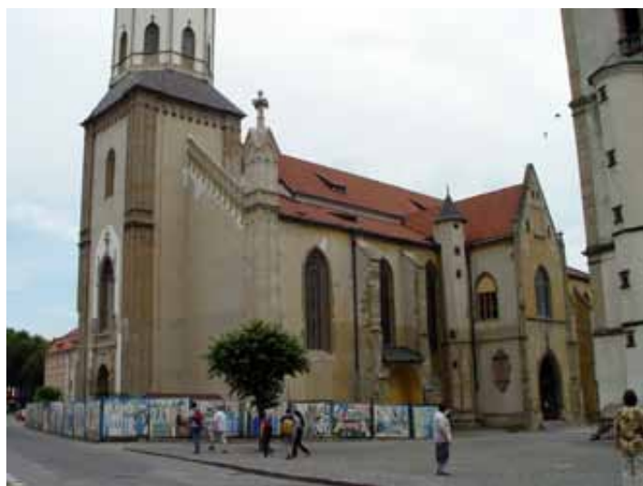
Juhozápadná časť kostola s prístavanou krstnou kaplnkou a predsieňou južného vstupu s Korvínovským oratóriom na 1. poschodí a prístupovým kruhovým schodiskom v rohu (foto: M. Janovská)
