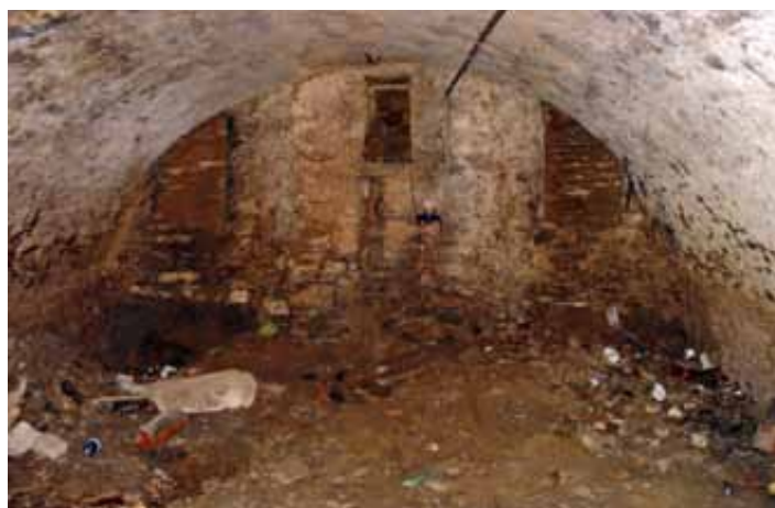
Sekundárne zaklenutý suterén, v pohľade pôvodná obvodová stena so zamurovaným výstupom do námestia/podlubia v strede a s dvojicou vetrákov po stranách (foto: M. Janovská)
