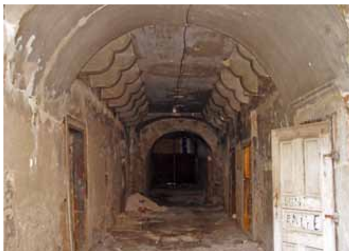
Pohľad do prejazdu v zadnej časti, vpredu pôvodne otvorená pavlač na kamenných konzolách po oboch stranách, ktorá sprístupňovala miestnosti na 2. NP, neskôr v úrovni pavlače realizované zastropenie, v zadnej časti prejazd do Kláštorskej ulice (foto: M. Janovská)
