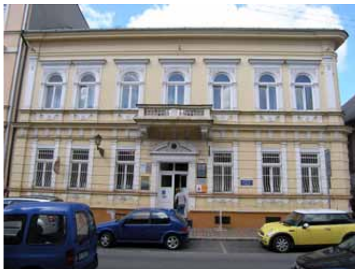
Pohľad na hlavnú fasádu objektu – východné krídlo
