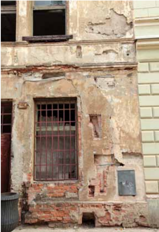
Celková situácia s odkrytými časťami gotického kamenného rámu vstupného portálu zo strany ulice, osekanou gotickou parapetnou rímsou a zvyškami renesančnej úpravy uličného priečelia
