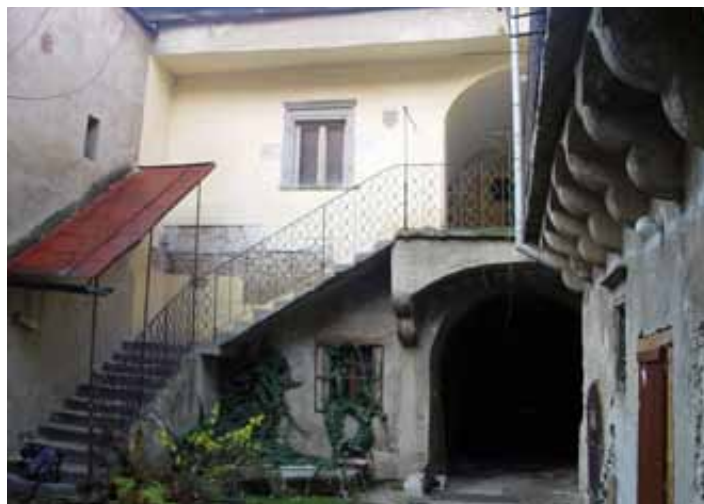
Dvor, pohľad na zadný trakt, prejazd orientovaný do Kláštorskej ulice (foto: M. Janovská)
