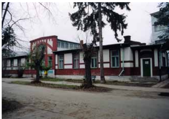
Objekt č. 39, dielne pre chovancov (foto: Archív PÚ SR)
