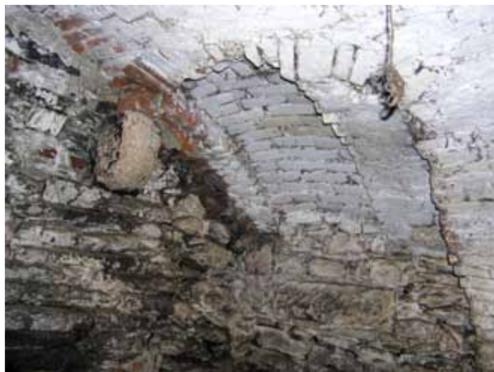
Kamenná konzola (15. storočie) pôvodného trámového zastropenia na východnej stene suterénu č. 1.11 hlavnej časti objektu
