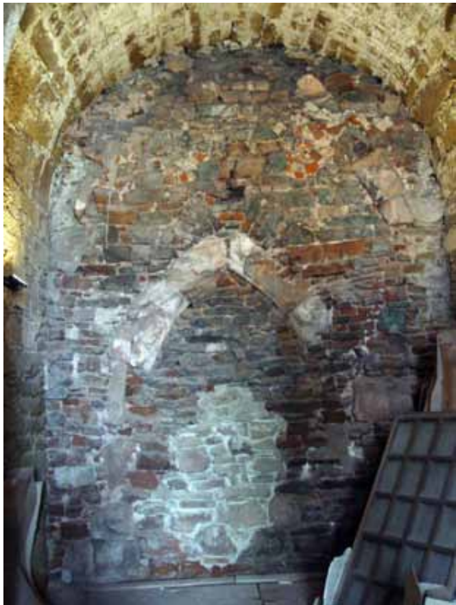
Pohľad na západnú stenu hlavnej lode z podvežia so zamurovaným gotickým vstupom do kostola a v pravom rohu s fragmentmi staršieho zaklenutia podvežia (foto: M. Janovská)
