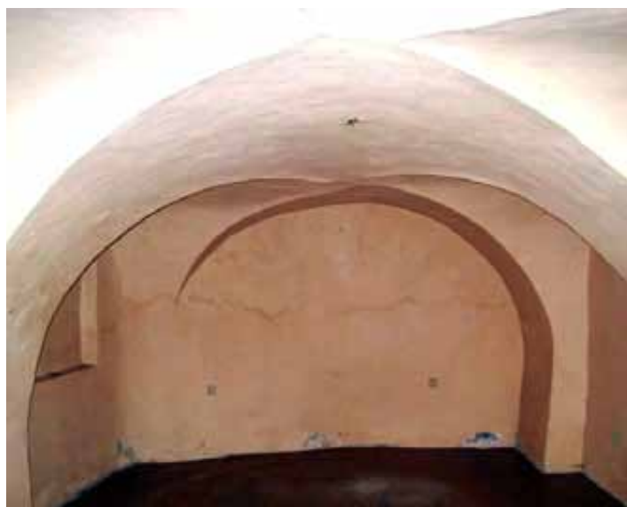
Východná časť severovýchodnej miestnosti 1.01 (foto: I. Hovorič)
