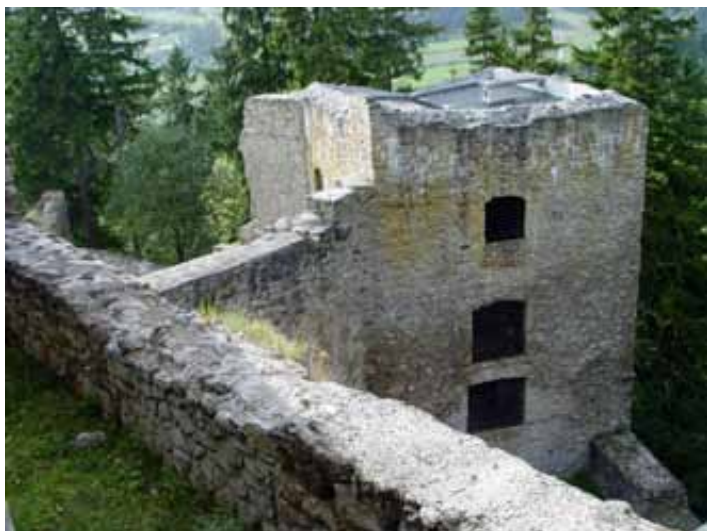
Huňadyho veža (pôvodne vstupná brána) po obnove so zavlhnutým murivom cez koruny murív (foto: M. Janovská)
