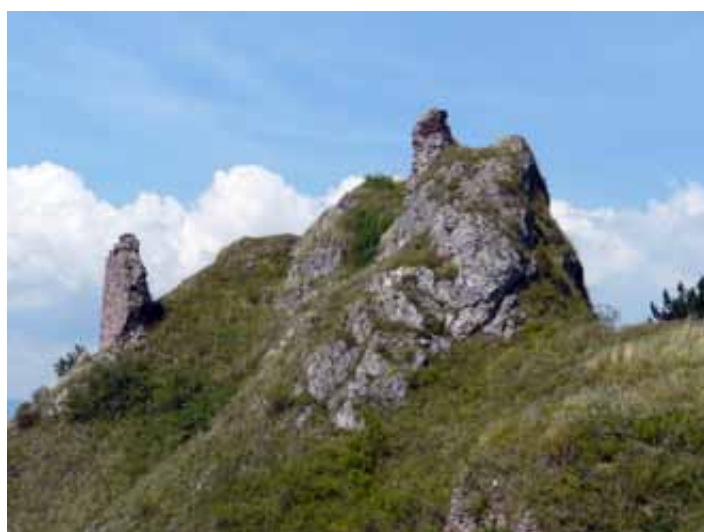
Západná časť hradného jadra s torzom najvyššie položennej valcovej veže a zvyškom nárožia palácovej zástavby (foto: M. Matejka, 2010)
