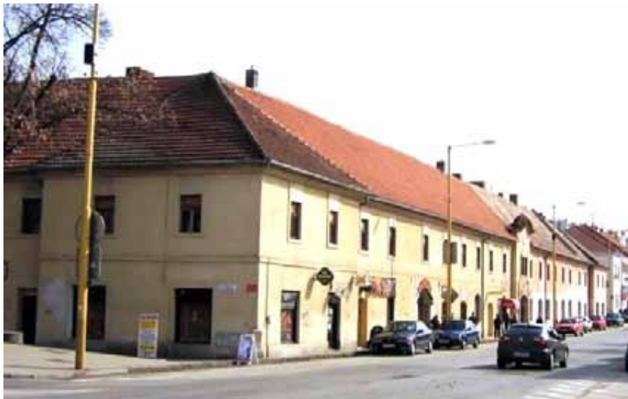
Celkový pohľad na hlavnú západnú uličnú fasádu a situovanie manufaktúry na nároží Bernolákovej ulice a Námestia sv. Martina
