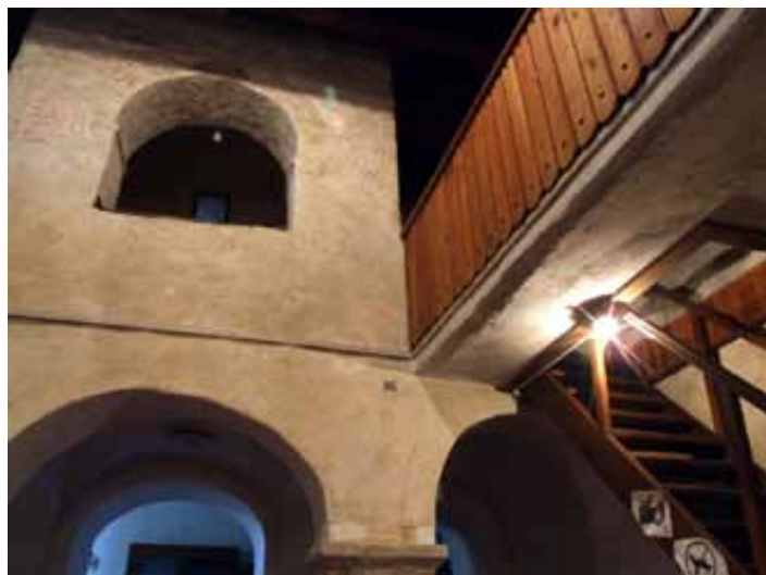
Empora s povrchovo vedenými sieťami
