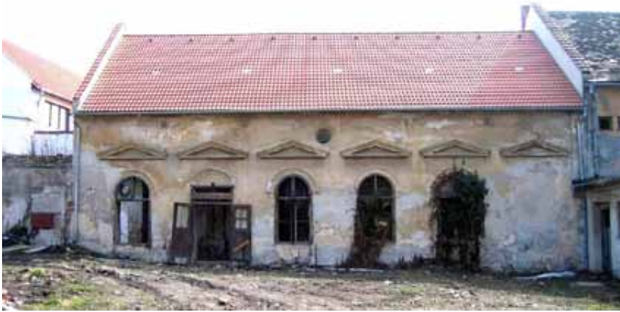
Časť južného dvorového krídla so sálou s novou krytinou
