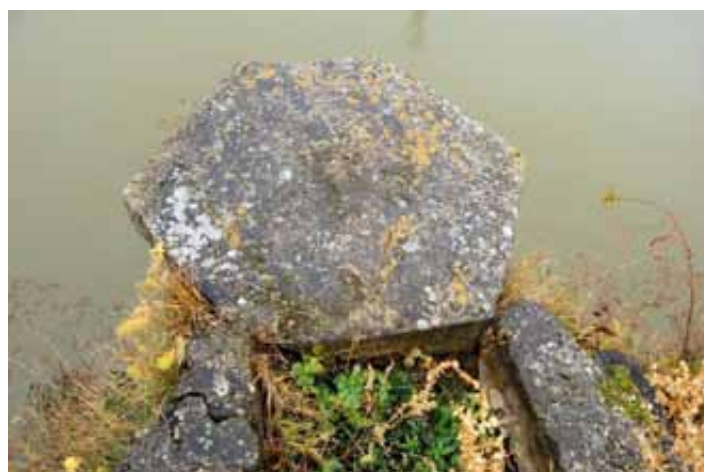
Kamenný základ bastiónovej vežičky
