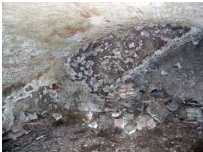
Konštrukčný oblúk stredovekého opevnenia v suterénoch pod barokovým jednotraktovým objektom (východná stena p. č. 0.10)
