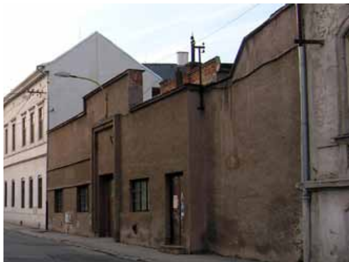
Pohľad na južnú uličnú fasádu skúmaného objektu
