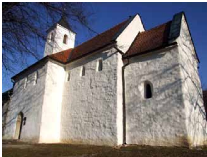
Celkový pohľad z juhovýchodu, stav po obnove fasád v rokoch 2000 – 2001
