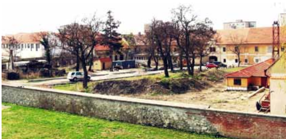
Celkový pohľad na dvor, južnú a východnú dvorovú fasádu s múrom na hranici parcely nad zvyškami murív bývalého východného krídla manufaktúry
