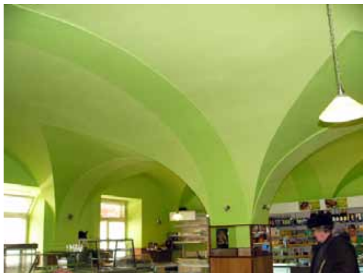
Renesančná klenba 1. nadzemného podlažia s centrálnym pilierom z druhej polovice 17. storočia (foto: K. Zvedelová)
