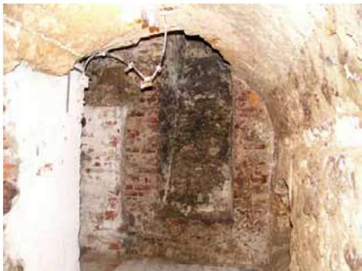
Východný priestor 1. podzemného podlažia (foto: K. Zvedelová)
