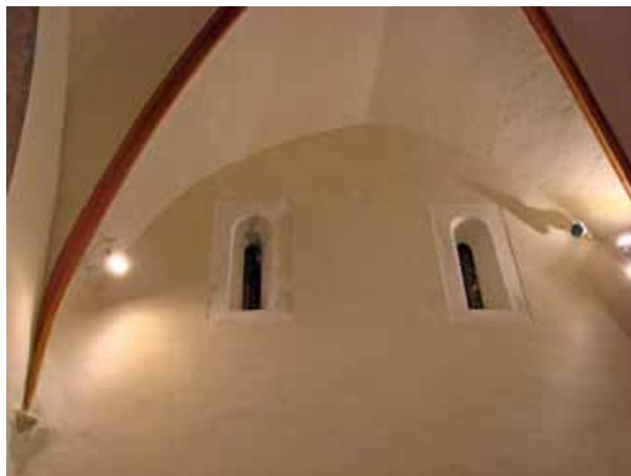
Južný múr lode kostola, prezentované románske okná formou analytických sond (foto: E. Sabadošová)
