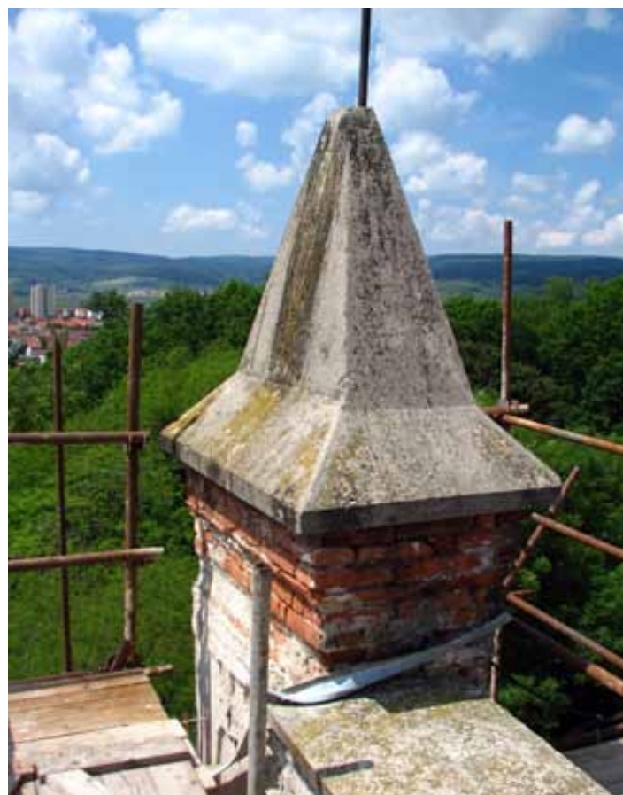
Detail komínovej hlavice č. 4 na streche západného krídla
