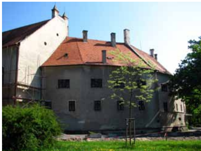
Celkový pohľad na komínové telesá
