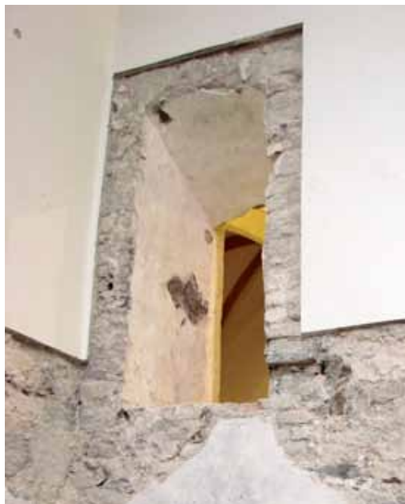
Vstup na emporu Kaplnky sv. Bartolomeja po odstránení zámurovky (foto: E. Sabadošová)
