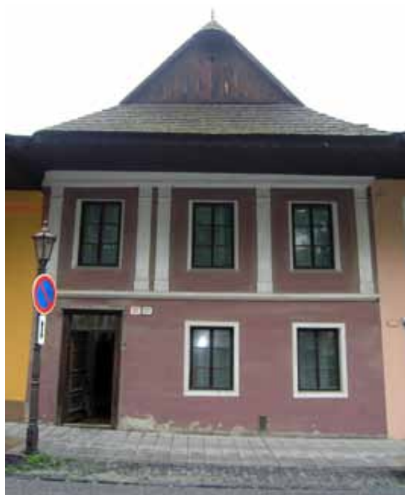
Čelná východná fasáda objektu
