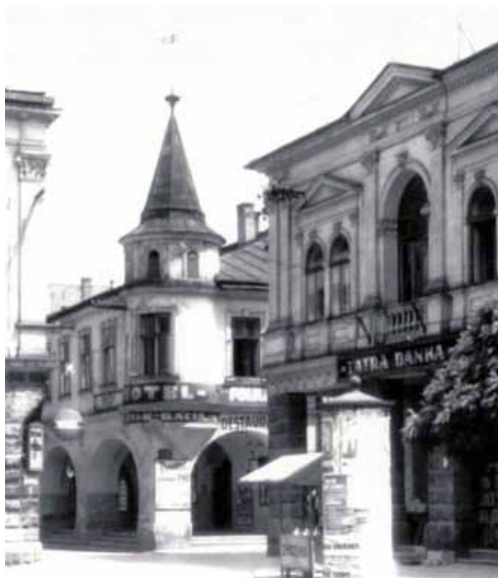
Reprodukcia dobovej fotografie okolo r. 1935 (objekt má ešte štukovú výzdobu na fasádach)
