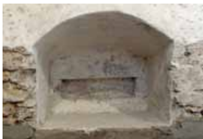
Západné okno Kaplnky sv. Bartolomeja po odstránení zámurovky (foto: E. Sabadošová)
