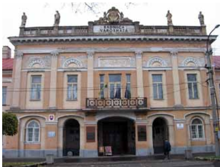
Ústredný rizalit uličnej fasády
