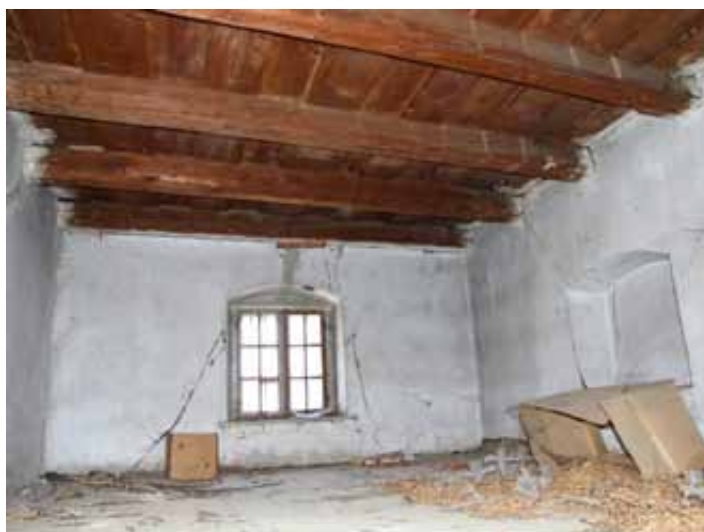
Objekt č. 2, horná komora s dreveným trámovým stropom
