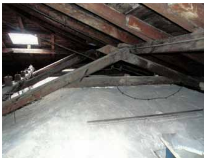
Krov – detail konštrukcie nosného systému zrkadlovej klenby
