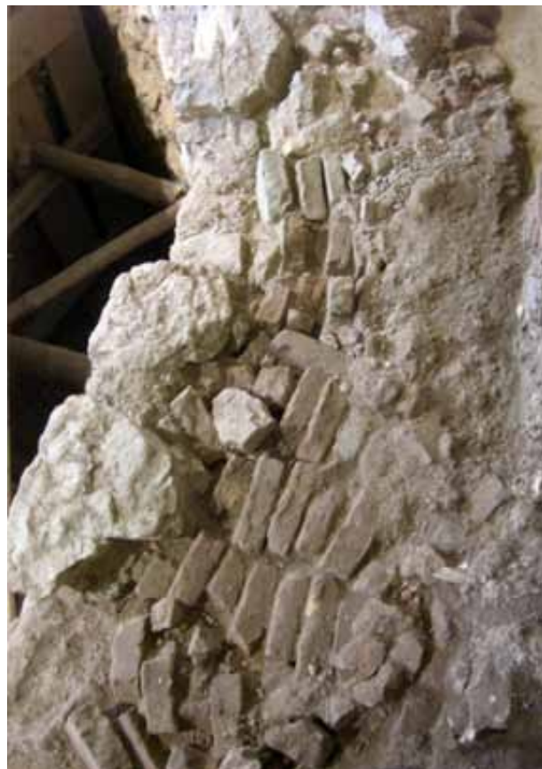
Pohľad zhora na rozobratú korunu obvodovej steny (foto: J. Žuffová)
