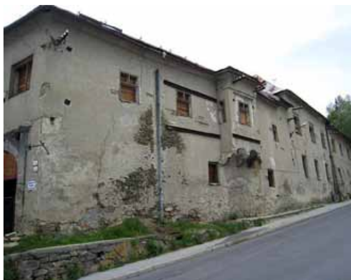
Juhovýchodná fasáda, celkový pohľad
