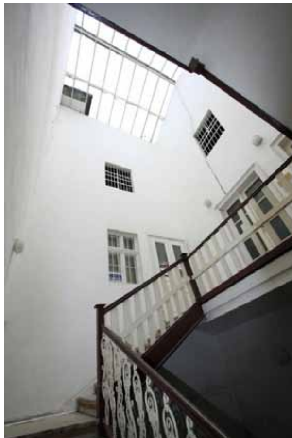
Centrálny schodiskový priestor so svetlíkom a časťou historického zábradlia
