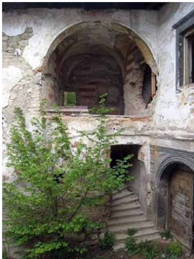
Lodžia so schodiskom v prednom JZ krídle
