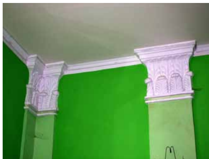
Detail pilastra s akantovými hlavicami salóna (p. č. 102)
