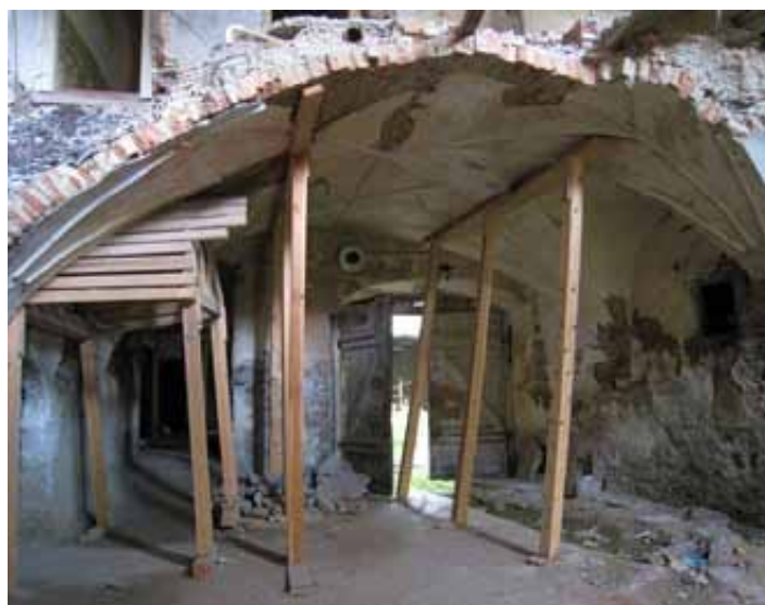
Priestor č. 111, severovýchodná časť siene s klenbou
