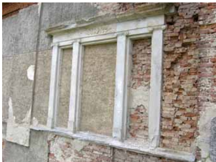
Kamenné ostenie trojdielneho združeného okna hlavnej fasády
