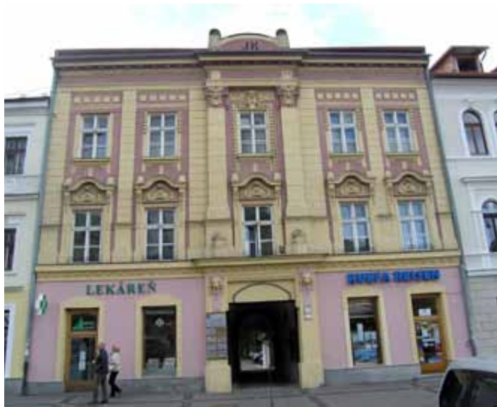
Hlavná severná fasáda objektu
