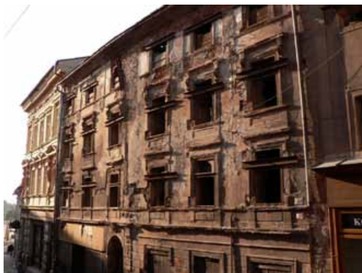
Severná uličná fasáda
