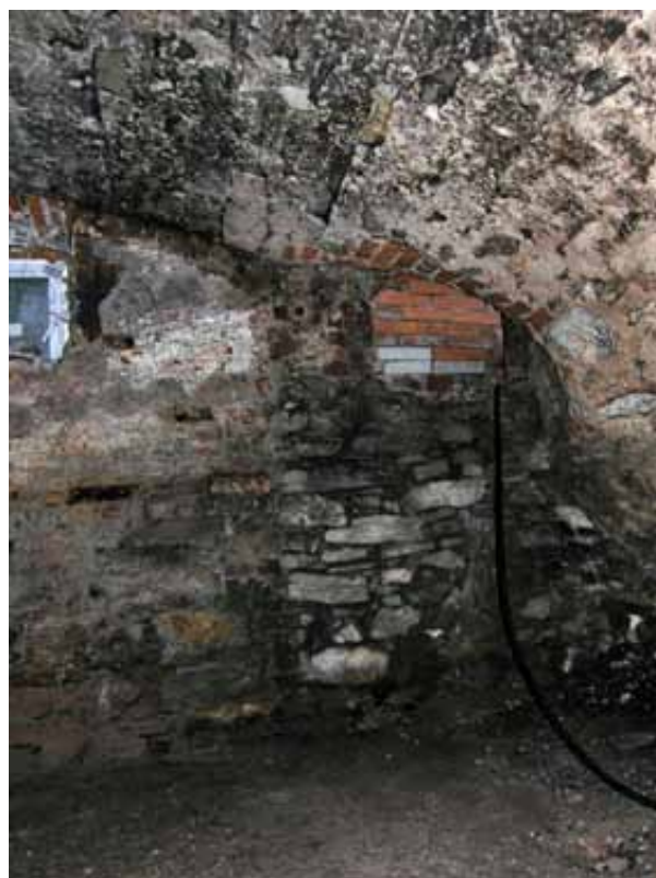
Detail ostenia vstupu s nábehom segmentového záklenku a vpravo s druhotne zamurovaným renesančným okenným otvorom
