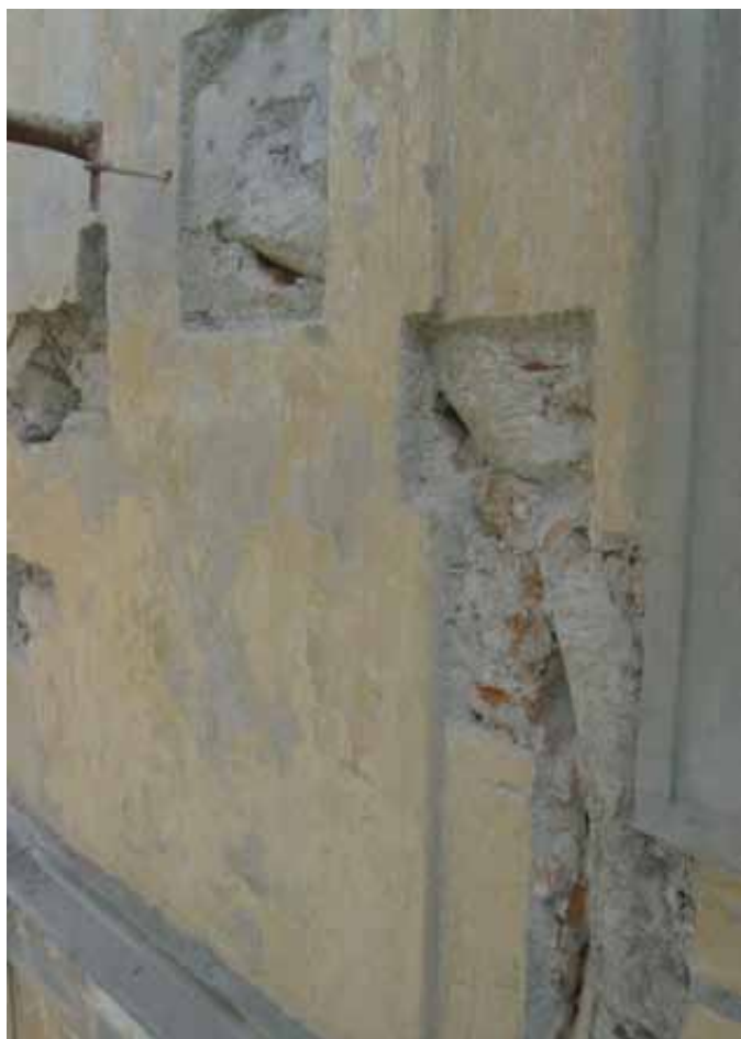
Rozeta bývalej kaplnky odkrytá v západnej fasáde
