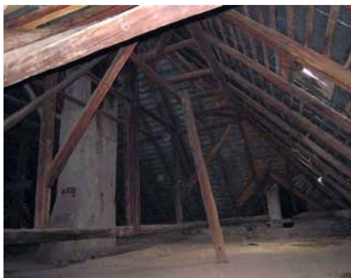
Krov nad stredným krídlom
