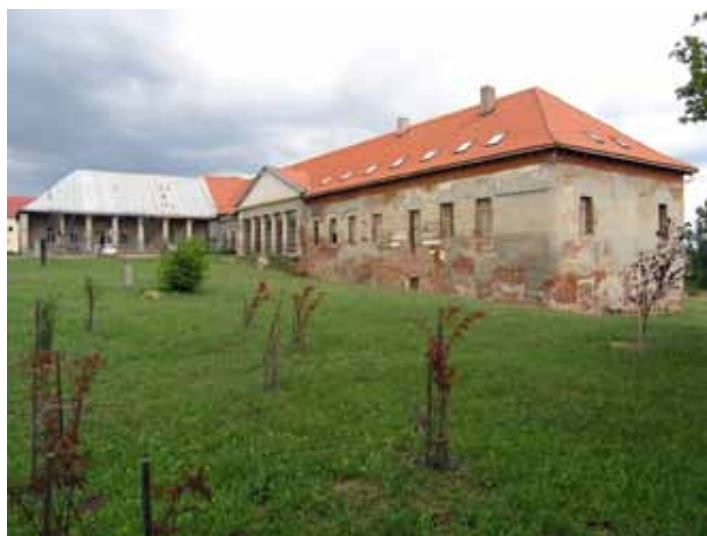
Celkový pohľad na kaštieľ od juhozápadu
