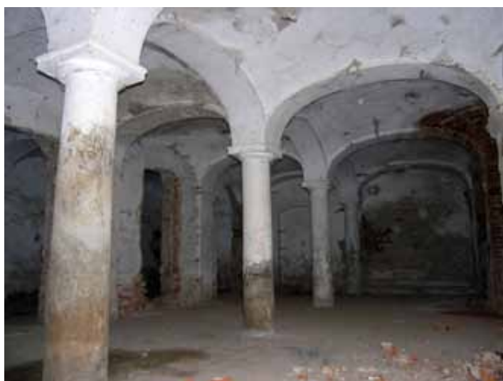
Zaklenutie vstupnej sály (p. č. 01) dosadajúce na toskánske stĺpy
