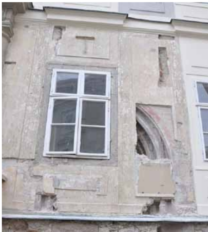
Pohľad na odkrytý severný portál
