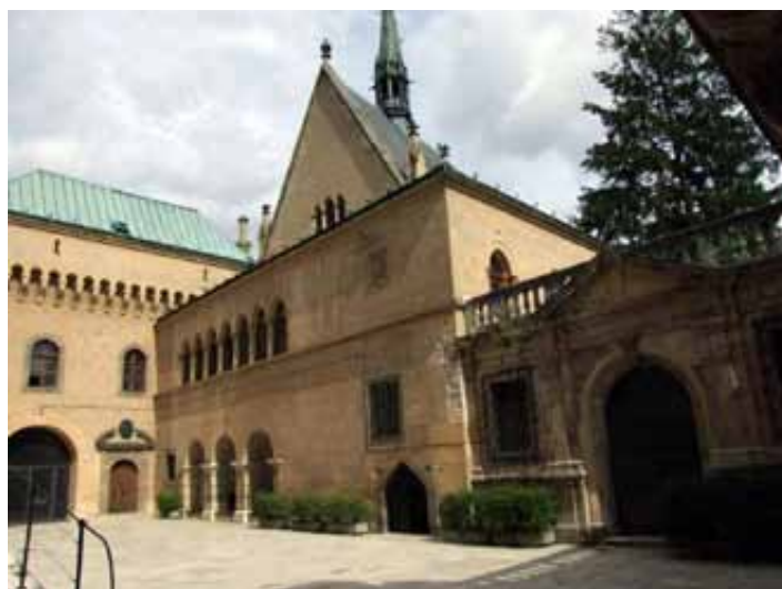
Druhé nádvorie, severozápadná fasáda kaplnky
