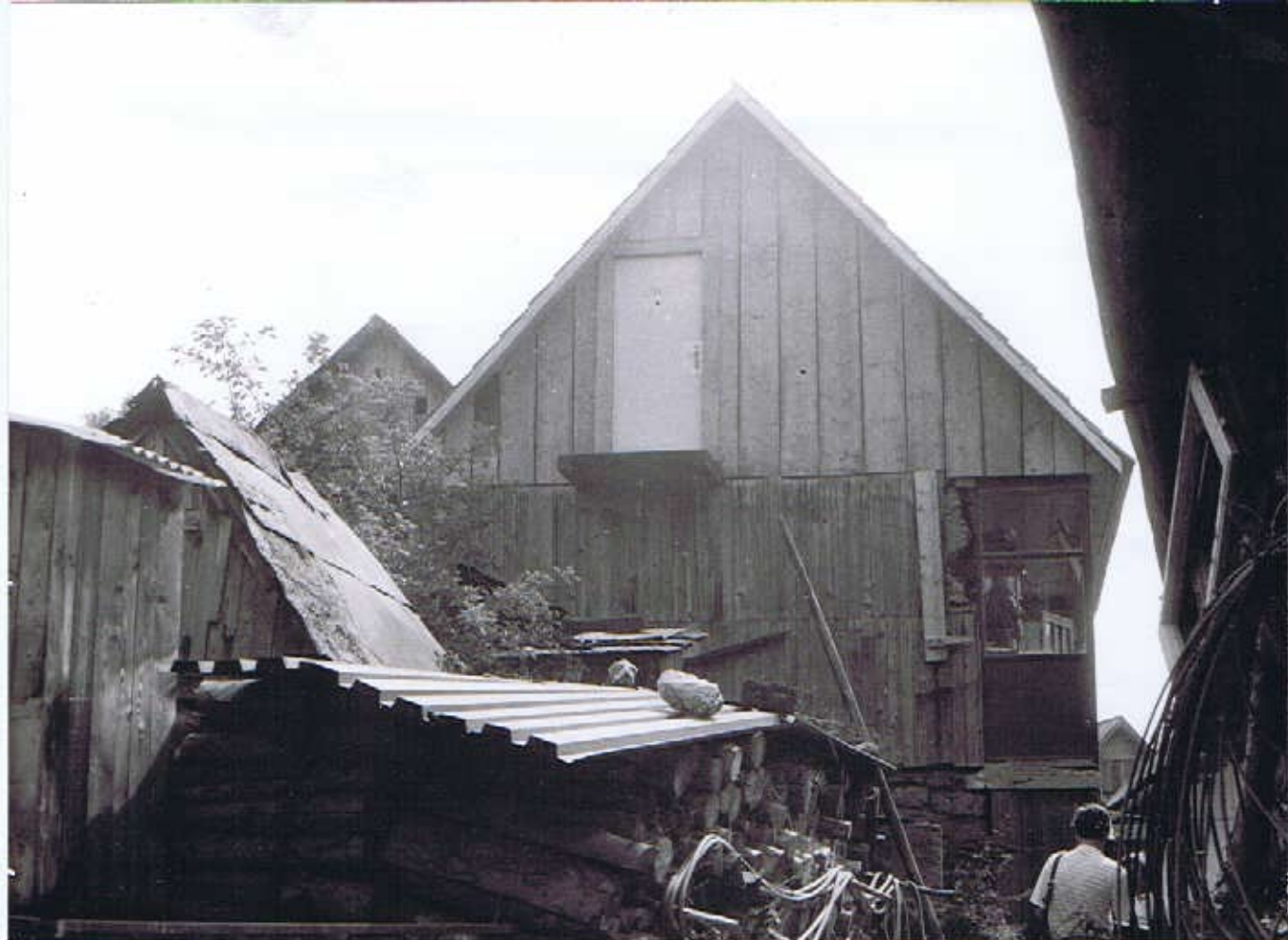
30. zadná časť štítu domu č. 39
