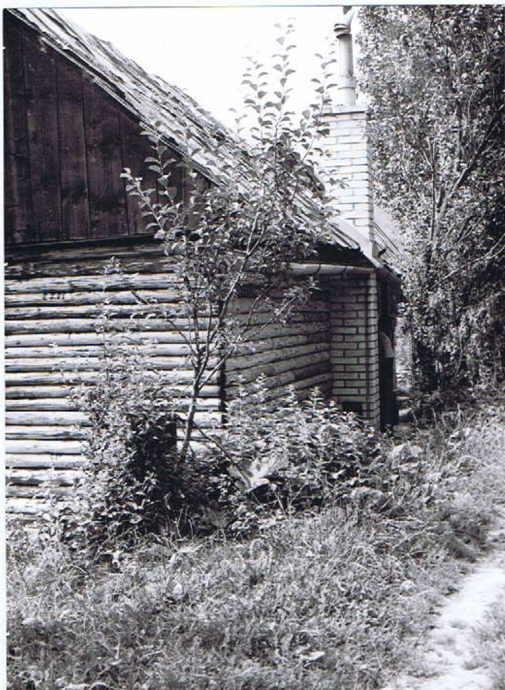
44. objekt č.46 - chata - nelegálna rušivá prestavba
