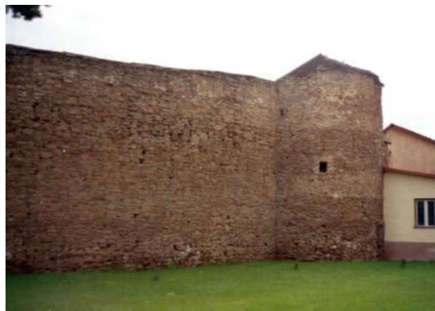
322. Mestská hradba s baštou na nádvorí kláštora
