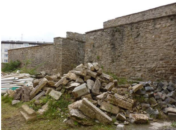
311. Hradby pri radnici – interiér Glos 2010
