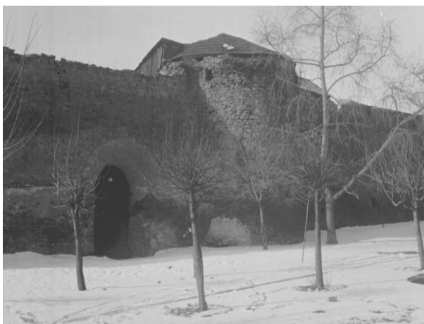
325. Hradby v areále kláštora
