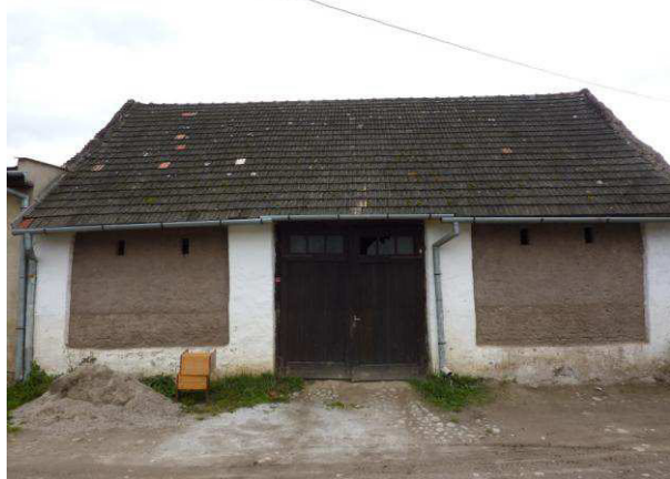
245. Murovaná stodola domu MN 41 Glos 2010
