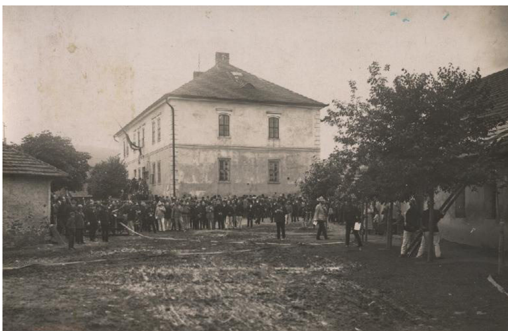
209. Požiar na Baštovej ulici
