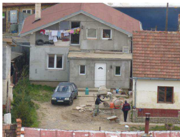
296. T. Vansovej – pohľad z veže - detail
