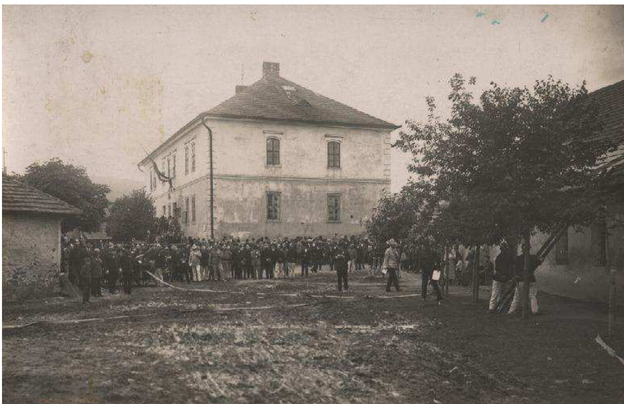
32. Severný pohľad na radnicu (požiar príľahlej budovy)
