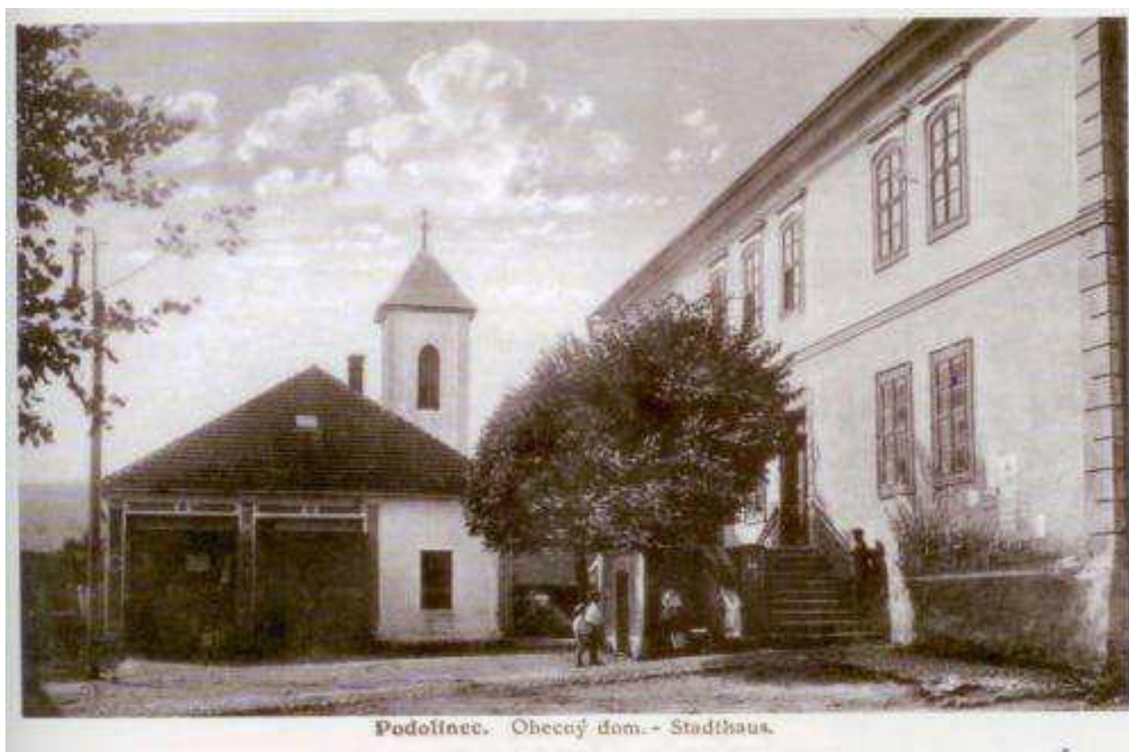
36b. Pohľad na požiarnu zbrojnicu a radnicu
