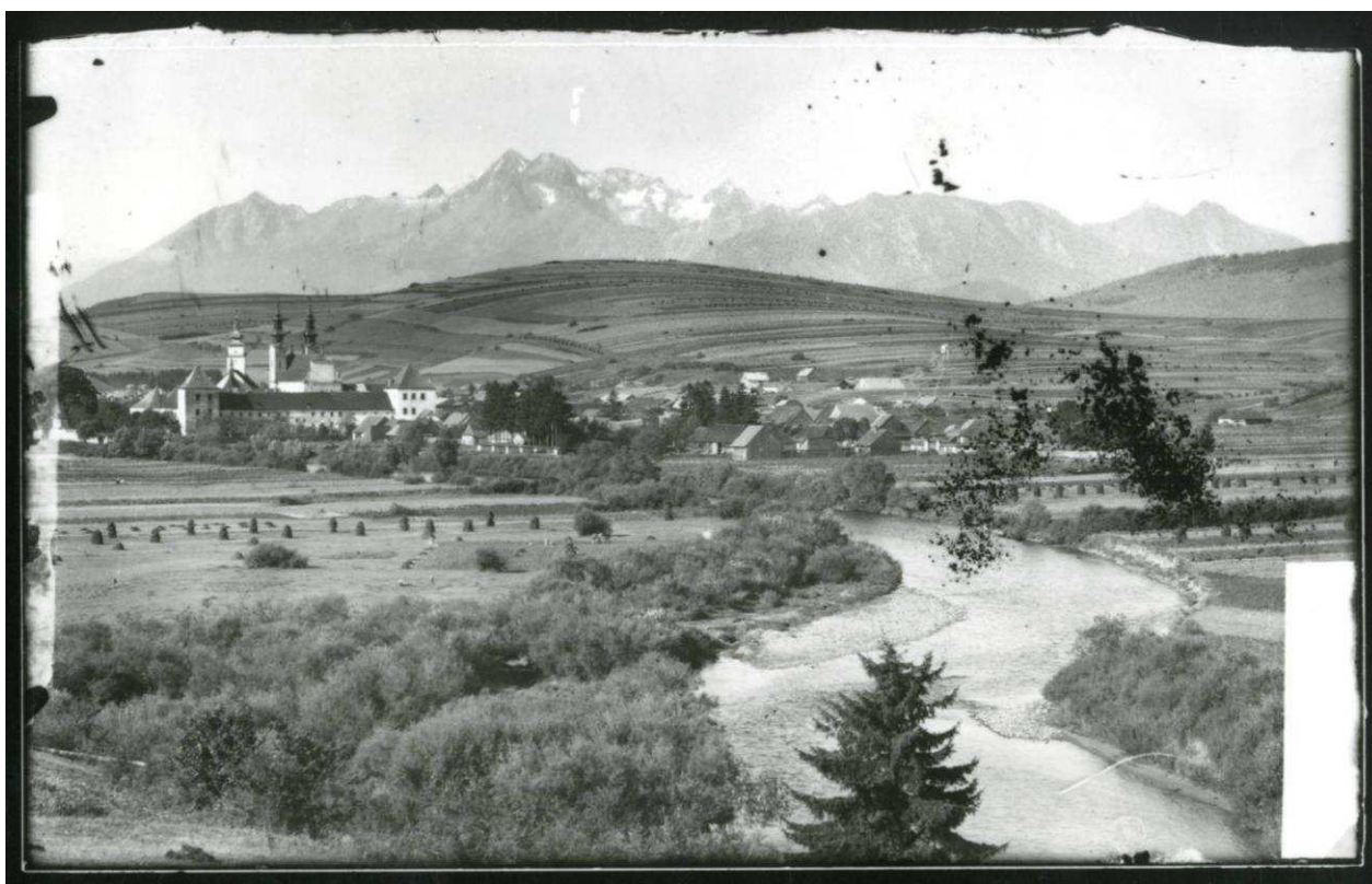
14. Pohľad na Podolíneec z východu
