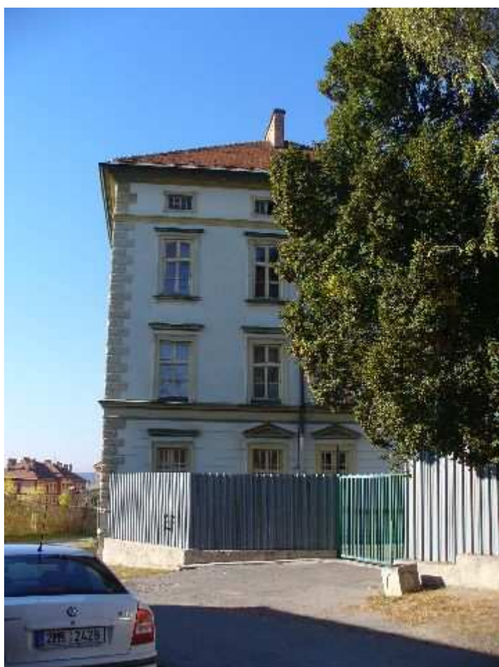
Kukučínova južné ukončenie ulice
