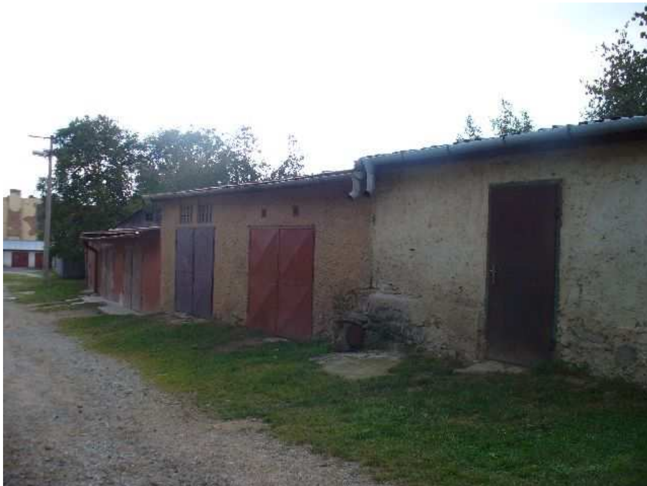
Kukučínova garáže v SZ ukončení pohľad od S
