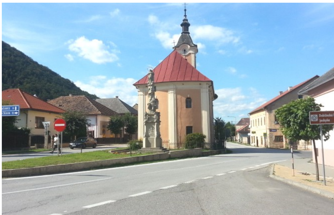
2. Hmota a veža rím. kat. kostola (parc. č. 433/2)
