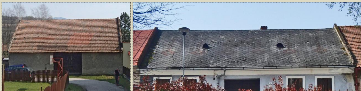
lokálne obmieňaná razená škridla s plytkým dvojžliabkovým profilom na tradičnej stodole a eternitová diagonálne kladená krytina s už ťažko čitateľným tradičným kladačským vzorom
