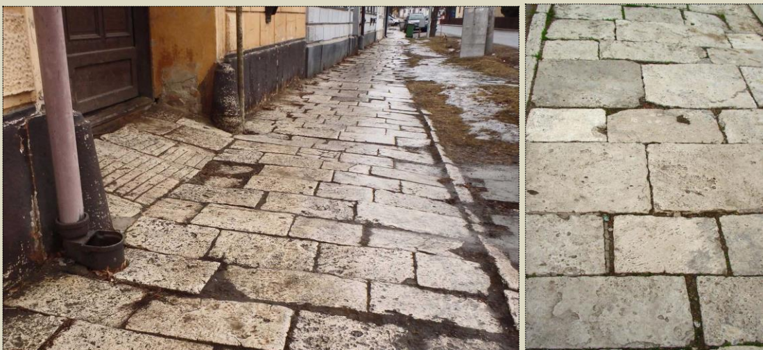
tradičná travertínová dlažba chodníkov z masívnych pravidelných platní
