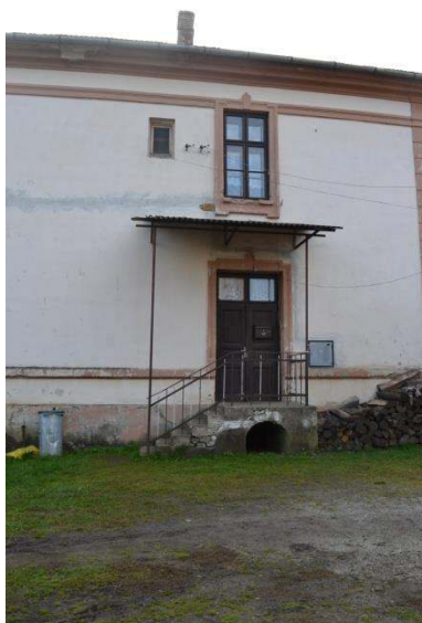
detail vstupu do objektu
