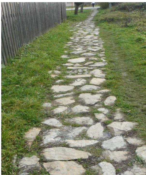
Povrchová úprava komunikácie - chodník
