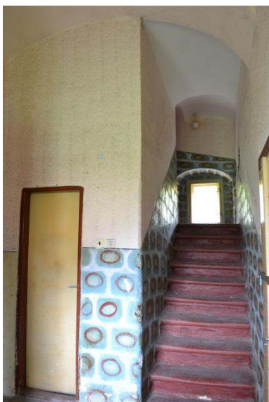
interiér, schodisko na 2 NP
