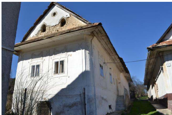
remeselnícky dom č. 14, pohľad na hlavnú fasádu
