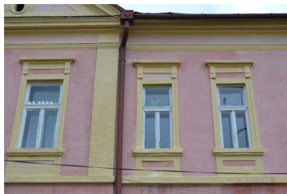
detail štukovej výzdoby okien
