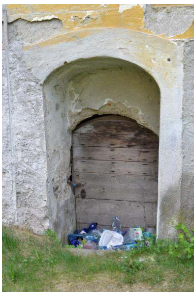
Detail vstupu do suterénu
