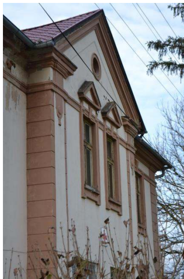
detail výzdoby fasády
