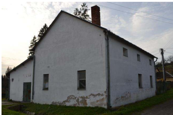
bývalá synagógy, pohľad severovýchodný
