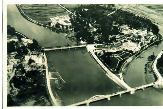
letecký pohľad na mosty a kúpeľný ostrov 1.pol.20.st.
