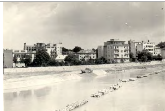
Úprava brehov Váhu zač. 60-tych rokov 20.stor.
