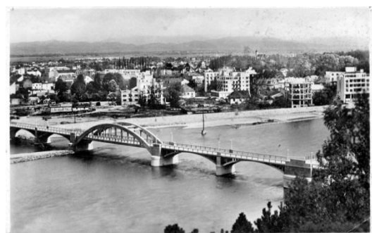
Pohľad na mesto r. 1936
