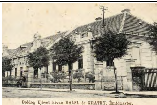
Roh Teplickej a Kollárovej 1.pol.20.st.
