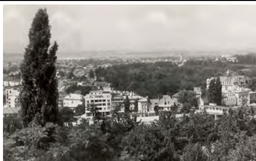
Pohľad z Červenej veže 2.pol.20.st.
