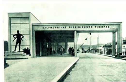
Kolonádový most s Barlolamačom
