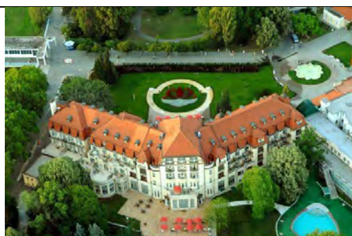
Thermia - letecký pohľad 2.pol.20.st
