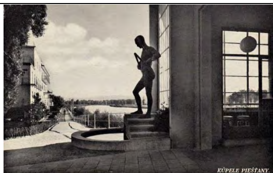
Kolonádový most - barlolamač a pitný pavilón
