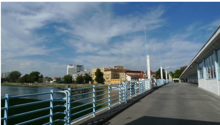
Kolonádový most - KM1 - pohľad z mosta na hodnotný historický urbanistický priestor nábřežia Váhu
