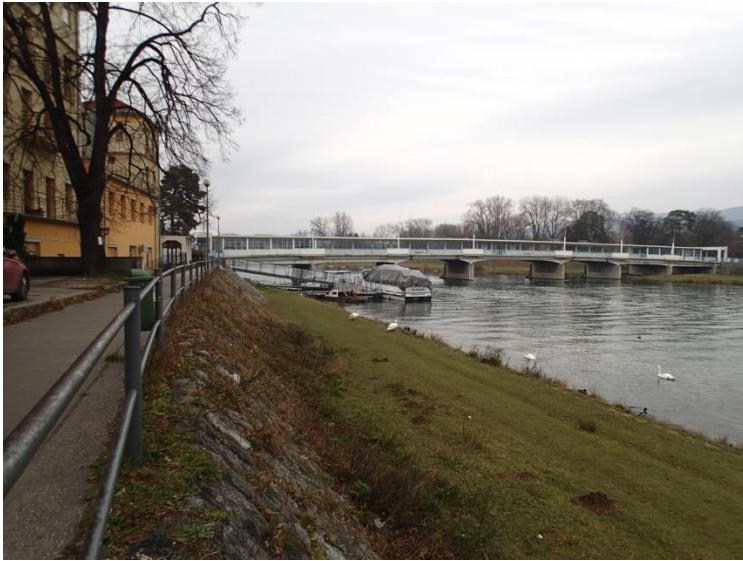
Nábřežie I.Krasku – NK4- pohľad na nábřežie a Kolonádový most
