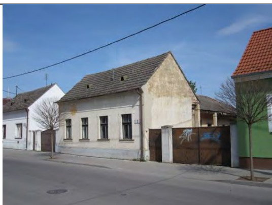
19 Hollého 15 strecha a dvor.krídlo odstránené
