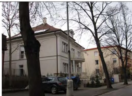
09 Pod Párovkami_ vily č.5 a 7 pohľad
