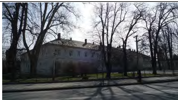
05 Sládkovičova_južná časť ulice
