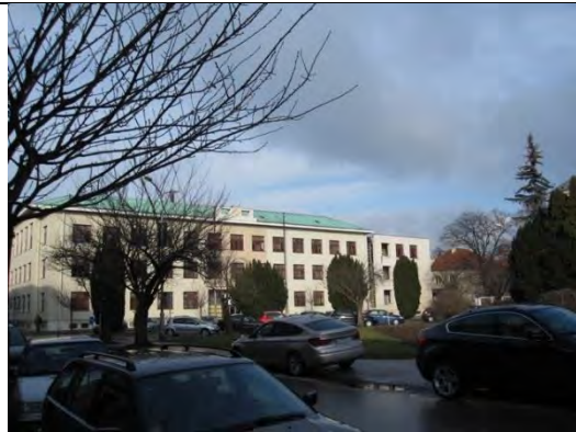
01 Námestie SNP pohľad z Kukučínovej ulice
