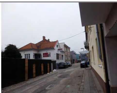
02 Moyzesova 3,5 a rozostavaná stavba
