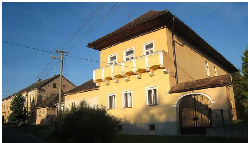
29c Sústreďenie palácových architektúr v ulici po ľavej strane Ľupčianky. Súčasný stav (august 2015). Foto: M.Kvasnicová.
