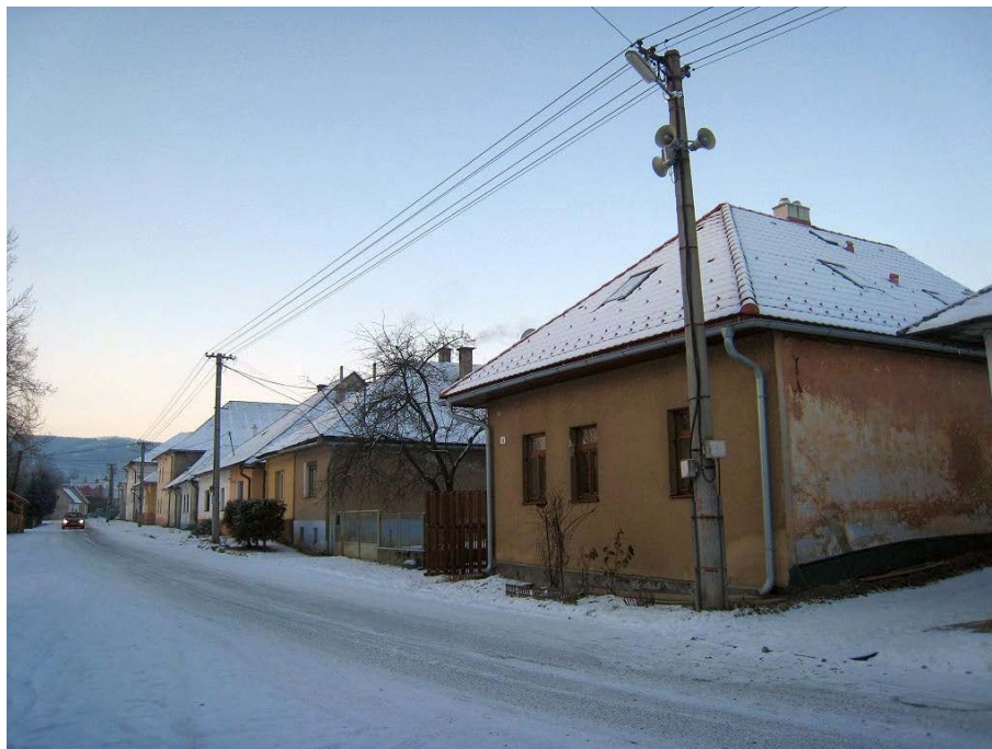
4. Významný pohľad na radovú uličnú zástavbu v dolnej (severnej) časti pamiatkovej zóny.
