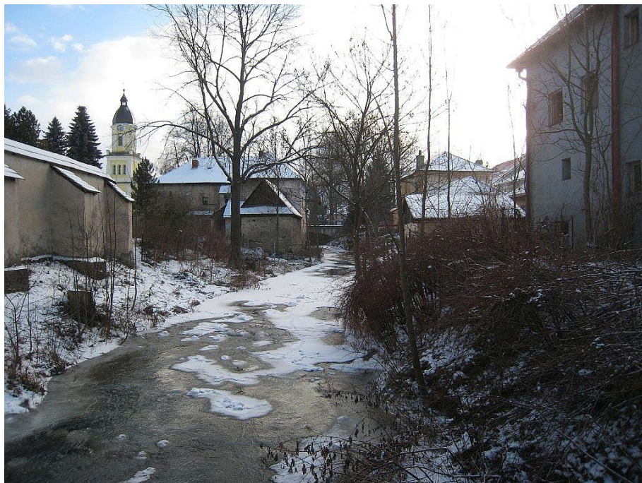
18. Významný pohľad z pešej lávky pod farským kostolom na koryto Ľupčianky s výškovou dominantou veže evanjelického kostola a hmotovou dominantou býv. mestského hostinca.
