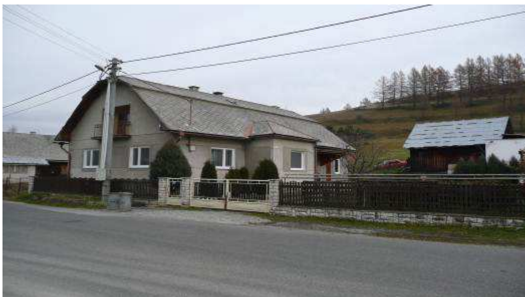
Dom 84. č.29, z 2.pol.20.stor., situovaný na južnej strane radovej zástavby.
