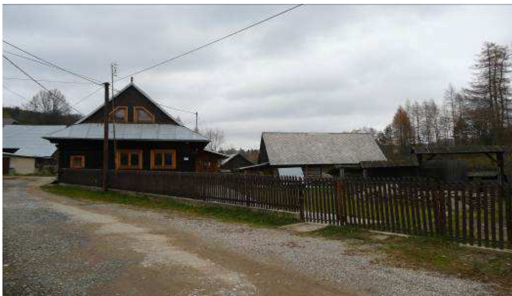
111. Roľnícky dvor č.6, zrubový dom a hosp.objekty v dvore stodola s maštalou a brána s plotom, na juhozápadnej strane ohraničených korytom potoka.
