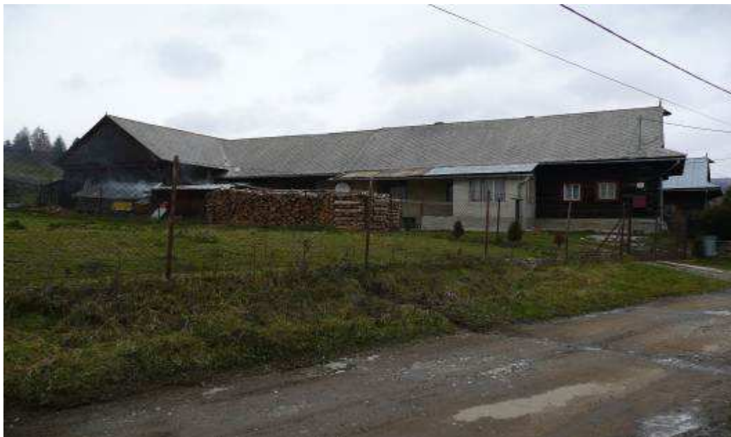
119. Dvor roľnícky č.11, zástavba v tvare L, dom z 1/2 drevený, zubový, zo severnej strany murovaný.
