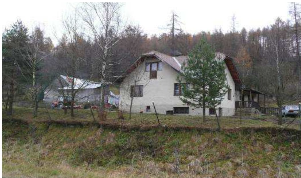
123. Murovaný dom č.16, situovaný nad hlavnou cestou, mimo pamiatkového územia, pôvodne tvoriac skupinovú zástavbu drevených, zrubových domov a prislúchajúcich hosp. stavieb.
