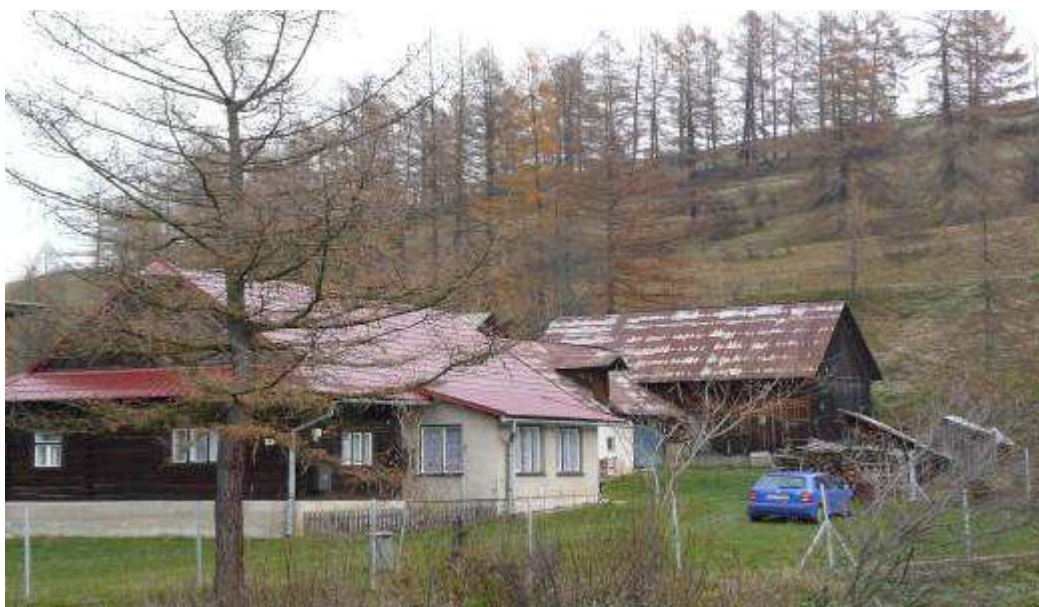
72. Roľnícky dvor č.36, situovaný na južnej strane od stredú obce – drevený dom s nevhodným murovaným zádverím, v hĺbke dvora s maštalou a naprieč parcely so stavbou stodoly. Na juhozápadnej strane skupinový porast smrekovca.
