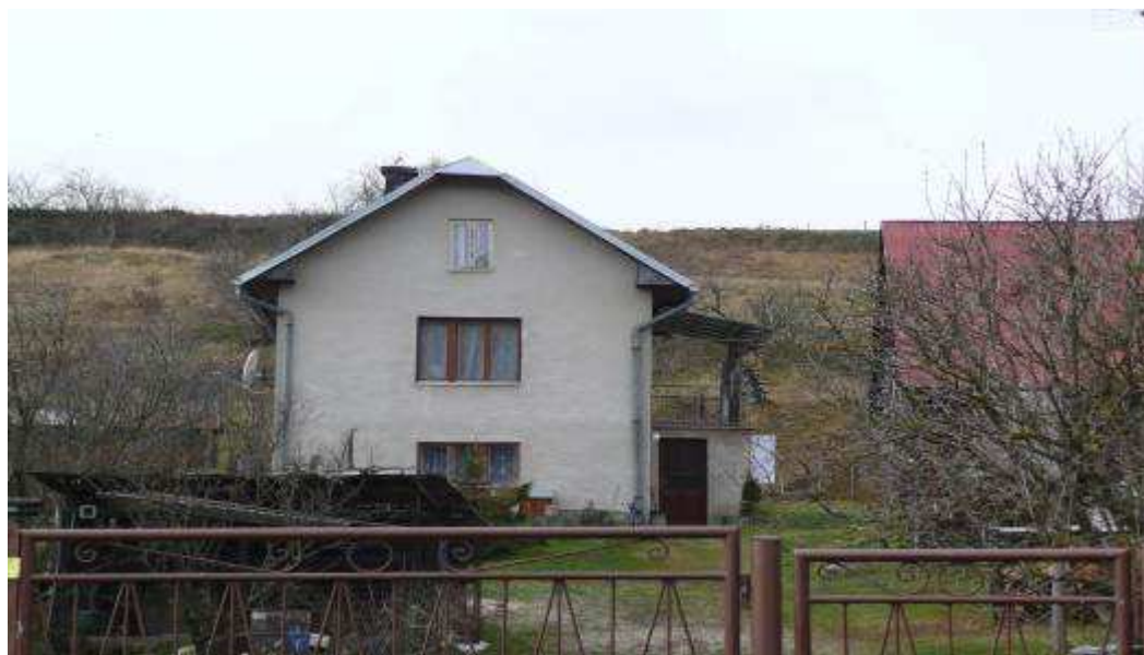
57. Novostavba domu, situovaná na severnom okraji parcely v dvore domu č.84.
