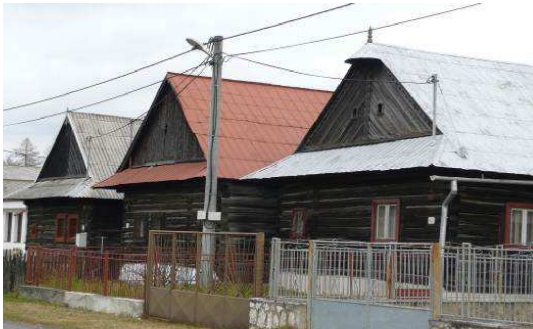
76. Štítové strany drevených zrubových domov č.33-31, orientovaných k ulici s nevhodnými plotmi.
