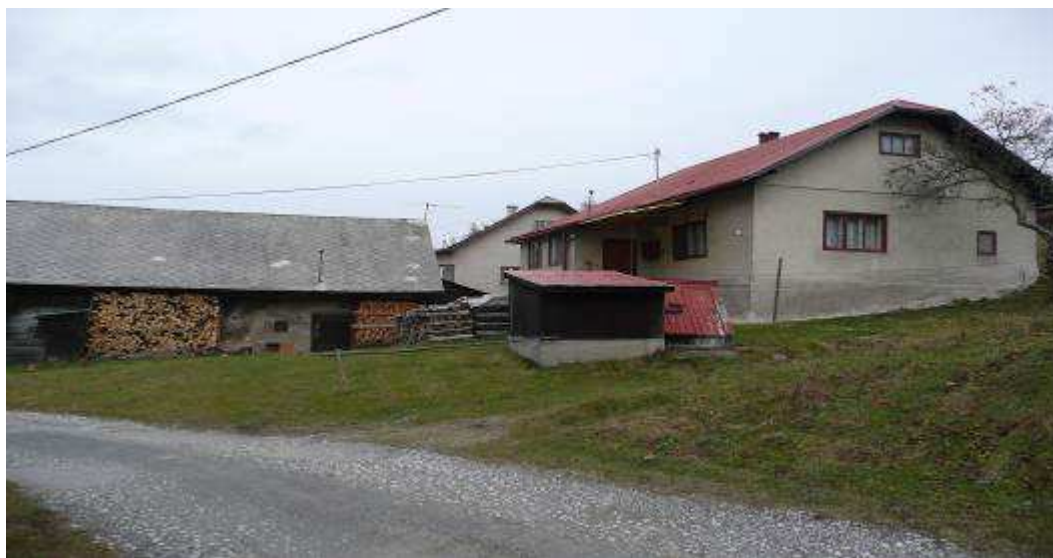
100. Dom č.23, z 1.pol.20.stor., s hosp. stavbami – stodolou, maštaľou a studňou.
