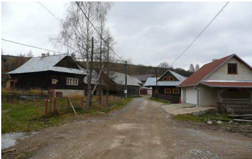
110. Obojstranná zástavba krátkej ulice domov č.5 a 6, na východnej strane zástavby obce.
