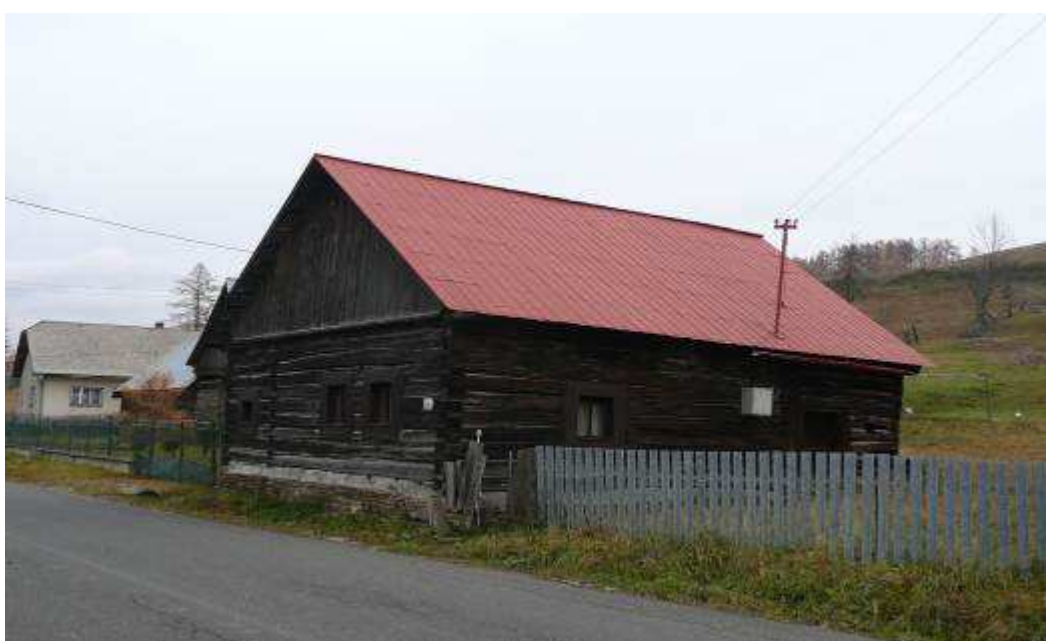
87. Drevený, zrubový dom č.26, na južnej strane oproti starej škole.
