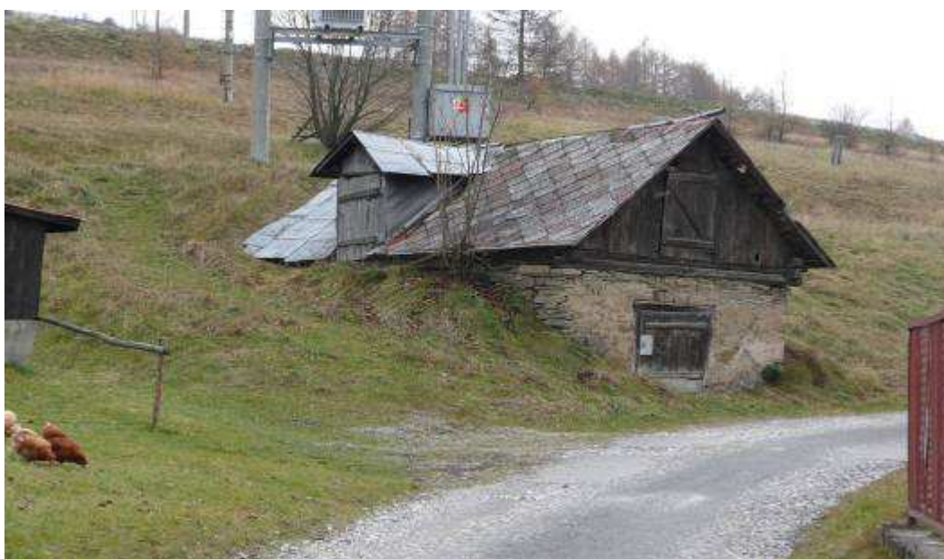
99. Murovaná, kamenná pivnica, oproti domu č.2, prináležiaca k domu č.23.
