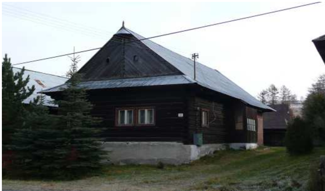
37. Dom č.50, uličný pohľad, v hĺbke dvora hospodárske objekty.
