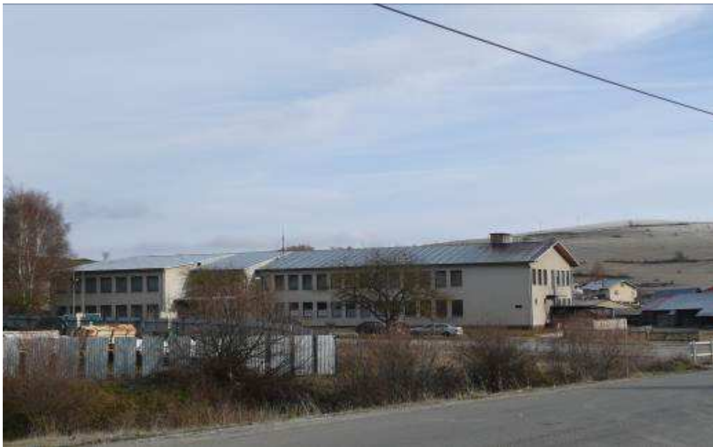
20. Areál roľníckeho družstva /RD/, situovaného na severozápadnom okraji obce, pri odbočke cesty na obec Torysky. V zábere administratívna budova. RD situované mimo pamiatkového územia.
