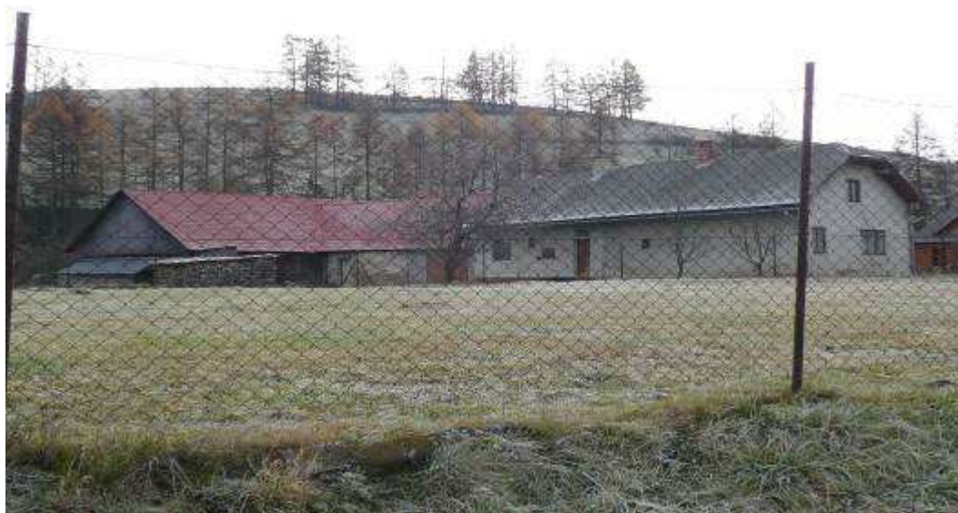
33. Roľnícky dvor č.53, z 1.pol.20.stor., dom a hosp. stavba maštale so stodolou.
