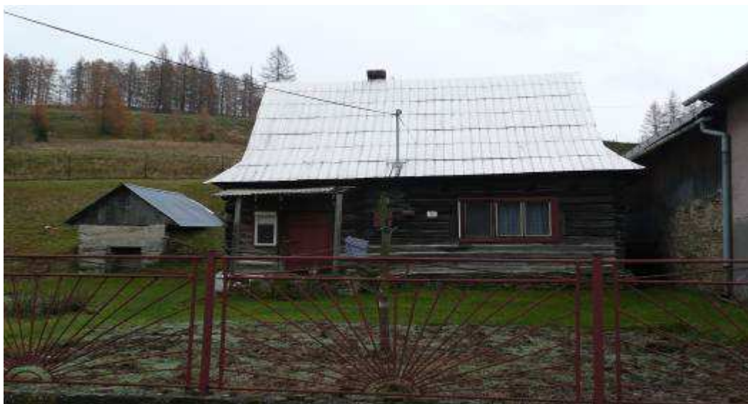
103. Drevený, zrubový dom č.20, situovaný v hĺbke parcely dvora, na východnej strane v svahu s pivnicou.
