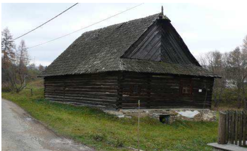
114. Drevený, zrubový dom č.10, situovaný na východnom okraji radovej zástavby.
