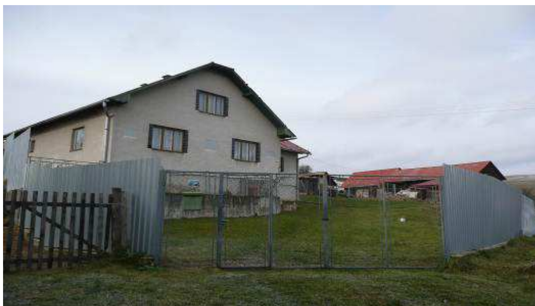
48. Dom č.79 z 2.pol.20.stor., situovaný v hĺbke parcely, na severnom okraji zástavby obce, na východnej strane rozsiahleho dvora s hosp. objektmi.
