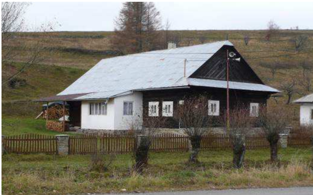
Dom 82. č.94 z 2.pol.20.stor., situovaný v skupine domov na severnej okraji od stredu obce, v priestore za potokom.
