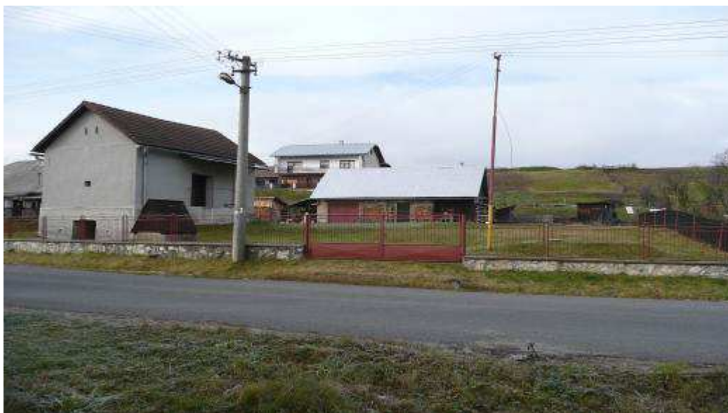
42. Priestor rezervnej plochy po odstránenom dome ľudovom, keď ostali len stavby : murovanej sýpky s pivnicou a hosp. objektu stodoly /maštal' prestavaná na garáž/. Parcela situovaná oproti domu č.50.
