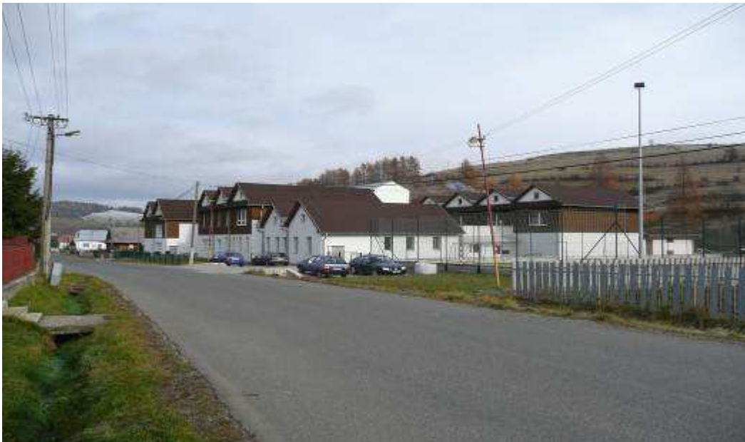
44. Novostavba Základnej školy /ZŠ/, situovaná na južnom okraji stredú obce. Rozsiahly komplex strediskovej školy bol postavený na mieste po čiastočne odstránenej zástavbe zrubový roľníckych dvorov.
