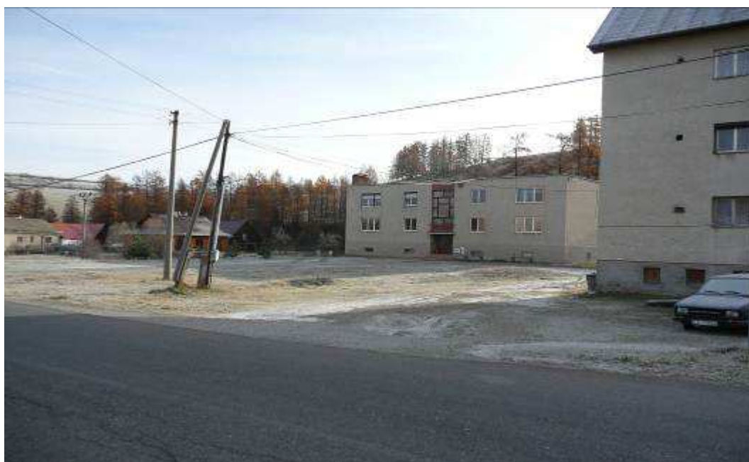
18. Dvojpodlažný bytový dom č.55, pôsobiaci svojou hmotou a situovaním na voľnom priestranstve na juhozápadnom okraji obce rušivo.
