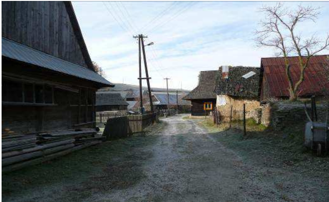
10. Krátka ulicovka na východnom okraji obce, na severnej strane objekty roľníckeho dvora č.59 – dvojpivnica, sýpka a dom.
