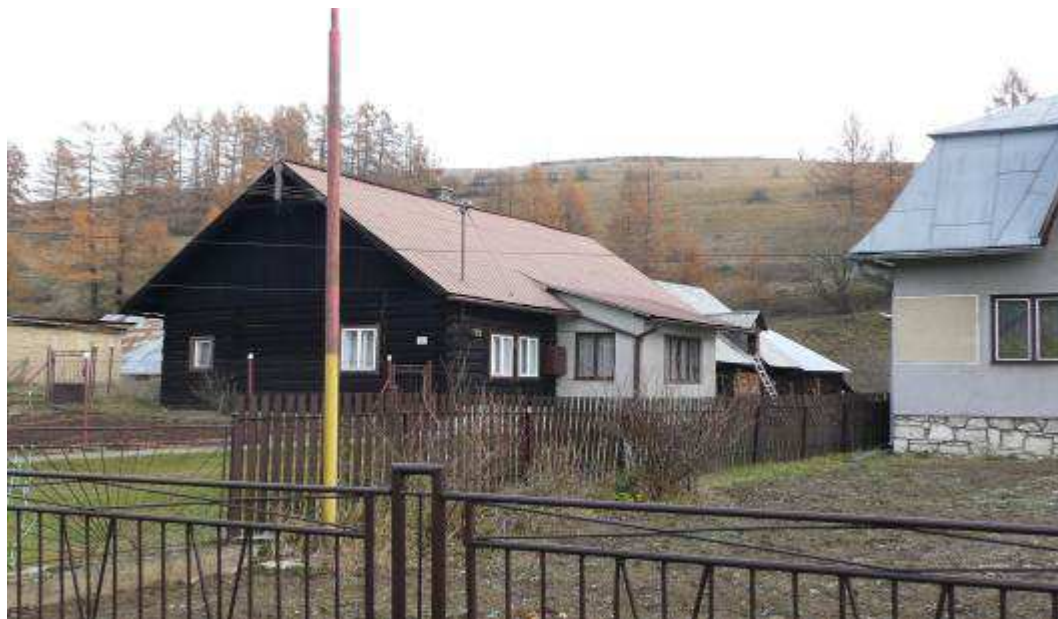
55. Drevený, zrubový dom č.41, situovaný na južnej strane zástavby obce, v hĺbke parcely dvora s hosp. stavbami v hĺbke dvora – maštal' a stodola.
