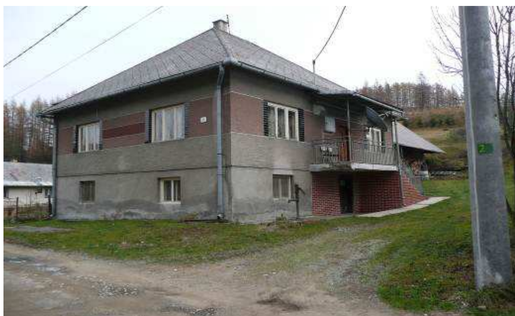
102. Dom č.21 z 2.pol .20.stor. a hosp stavby v hĺbke parcely, smerujúce pod svah telesa hlavnej cesty.
