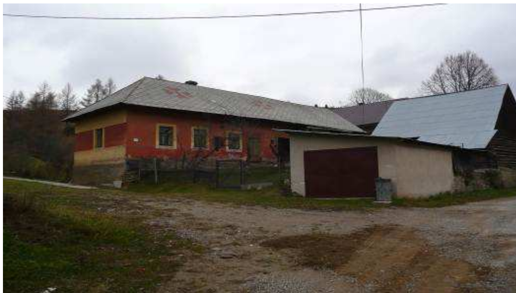
112. Murovaný dom č.8, z konca 19.stor., s nevhodnou stavbou garáže v mieste vstupu do dvora.
