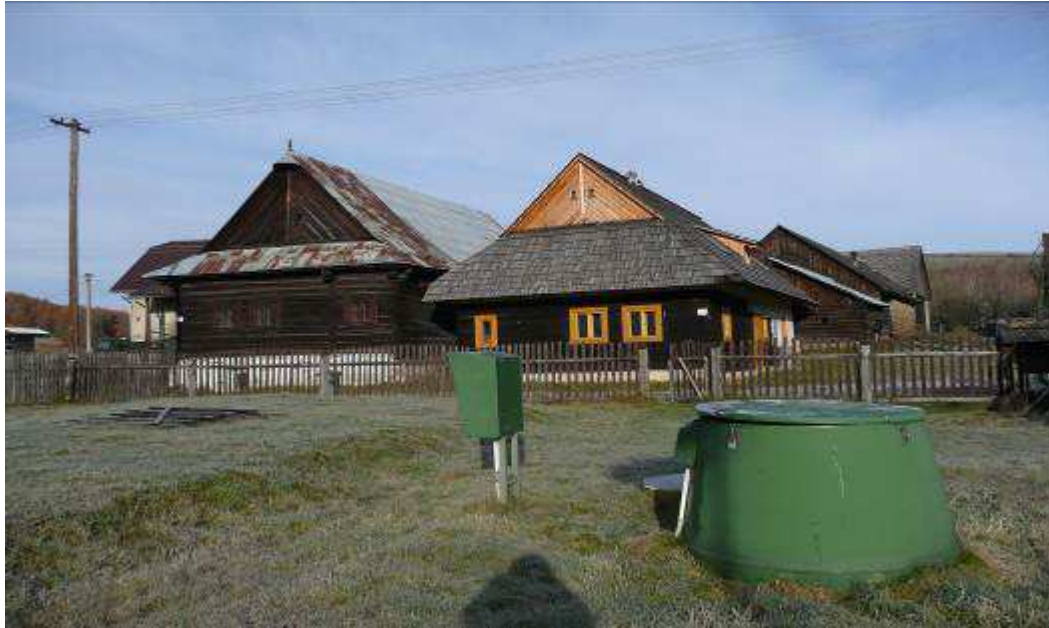
7. Dvojica zrubových domov č.59 a 60, štítový, južný pohľad v krátkej, ulicovej zástavbe, v popredí na voľnom priestore situovaná čistička odpadových vôd.
