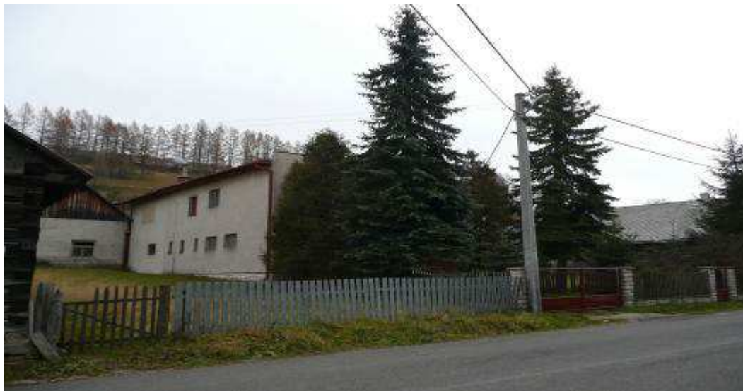
88. Dom č.27 s nevhodnou úpravou zelene.
