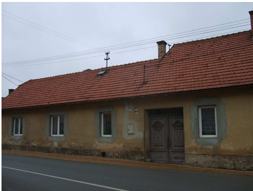
1.DF 16/Ľubica/Ul. gen. Svobodu č. 152/32/Dom meštiansky/október2009/brána/objekt
