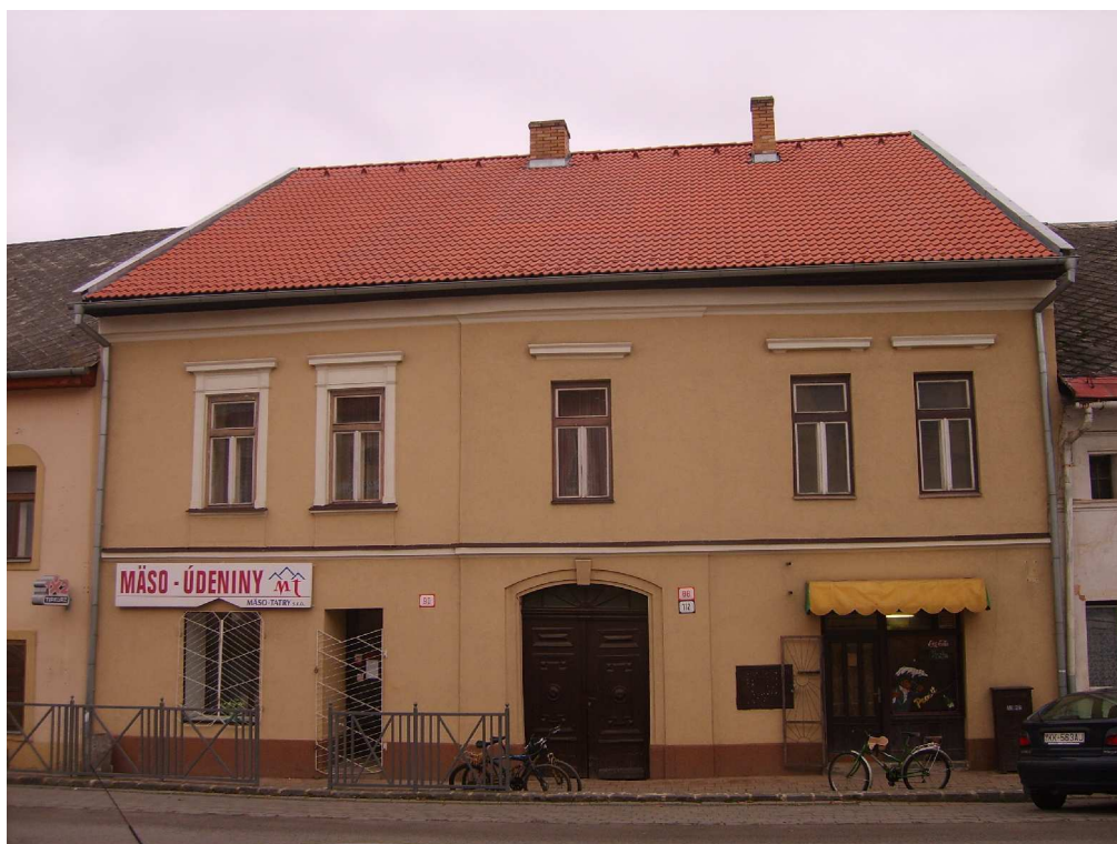
1.DF 16/Ľubica/Ul. gen. Svobodu č. 112/88/Dom meštiansky/október2009/brána/objekt
