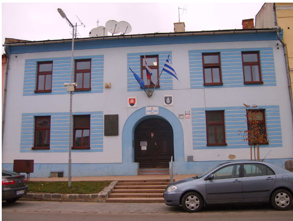
1.DF 16/Ľubica/Ul. gen. Svobodu č. 248/127/Dom meštiansky/október2009/brána/objekt
