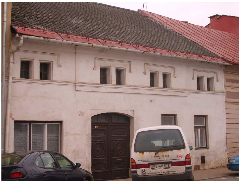
1.DF 16/Ľubica/Ul. gen. Svobodu č. 113/86/Dom meštiansky/október2009/brána/objekt
