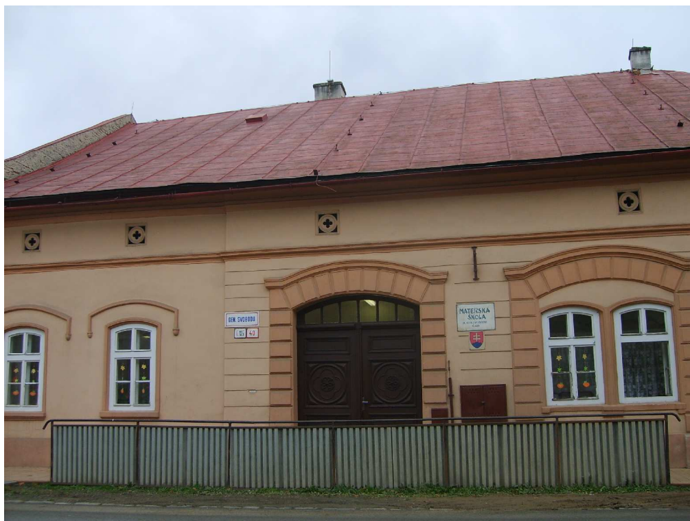
1.DF 16/Ľubica/Ul. gen. Svobodu č. 135/40/Dom meštiansky/október2009/brána/objekt
