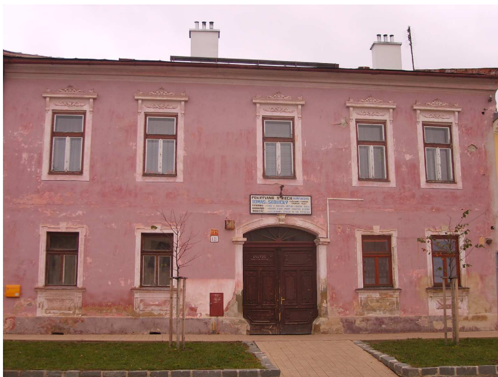
1.DF 16/Ľubica/Ul. gen. Svobodu č. 251/133/Dom meštiansky/október2009/brána/objekt
