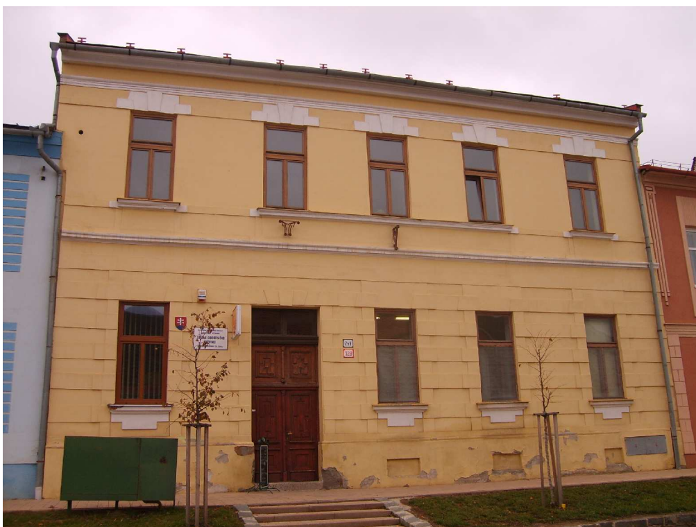
1.DF 16/Ľubica/Ul. gen. Svobodu č. 249/129/Dom meštiansky/október2009/brána/objekt
