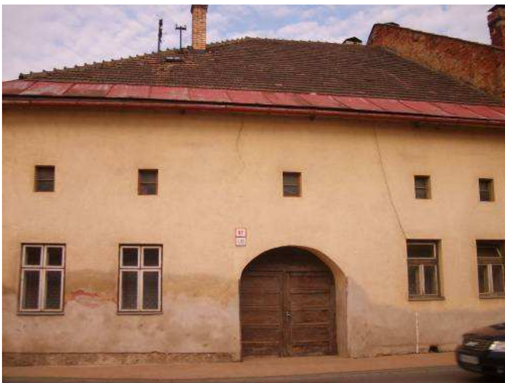
126. Ul. gen. Svobodu č. 190/87, parc. č. 583/1 (vľavo) a č. 191/87, parc. č. 583/2 (vpravo) – objekt s pamiatkovými hodnotami
