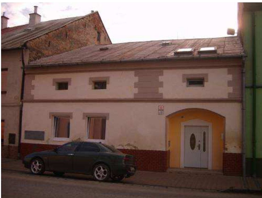
88. Ul. gen. Svobodu č. 129/52, parc. č. 444 – objekt rešpektujúci pamiatkové hodnoty územia (nevhodné zmenšenie vstupného otvoru je cudzorodé a rušivé)
