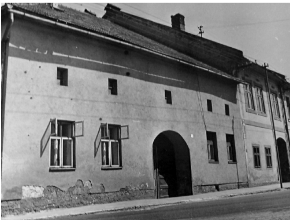
127. Ul. gen. Svobodu č. 190/87, parc. č. 583/1(vľavo) a č. 191/87, parc. č. a 583/2 (vpravo) – objekt v roku 1976 pred rozdelením na dva objekty (zdroj: Archív Pamiatkového úradu SR, Motaj, č. negatívu 75681)
