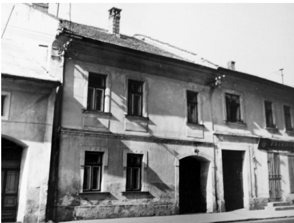
101. Ul. gen. Svobodu č. 121/68, parc. č. 425 (vľavo) – objekt v roku 1976 (zdroj: Archív Pamiatkového úradu SR, Motaj, č. negatívu 75644)
