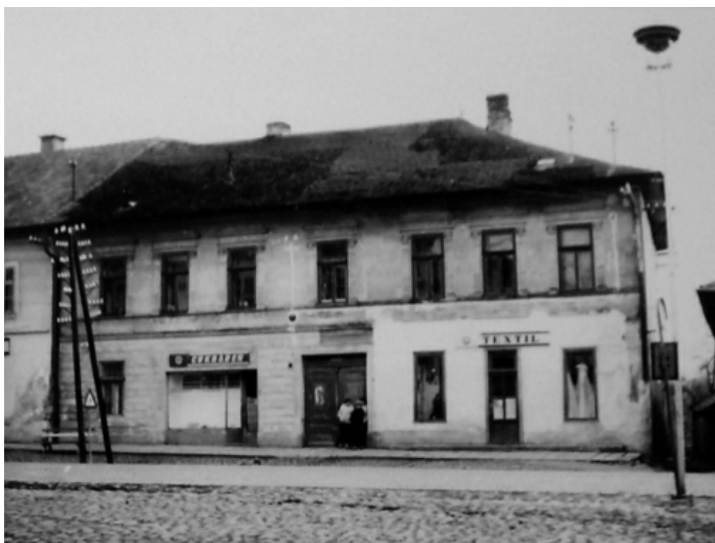
109. Ul. gen. Svobodu staré súp. č. 117 – objekt v roku 1976 (zdroj: Archív Pamiatkového úradu SR, Motaj, č. negatívu 75641)
