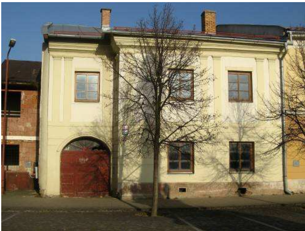
158. Ul. gen. Svobodu č. 243/117, parc. č. 55/1 – objekt vytypovaný na vyhlásenie za NKP
