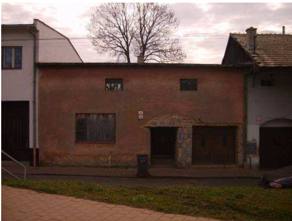
69. Ul. gen. Svobodu č. 155/26, parc. č. 828 – objekt rešpektujúci pamiatkové hodnoty územia (žiaduca je zmena tvaru strechy na sedlovú s hrebeňom rovnobežne s uličnou čiarou)
