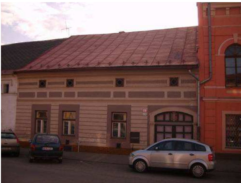
114. Ul. gen. Svobodu č. 114/84, parc. č. 415 – objekt vytypovaný na vyhlásenie za NKP
