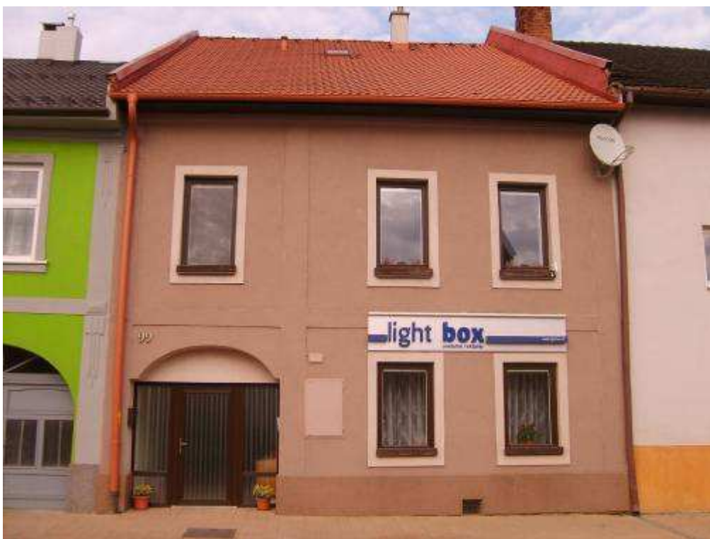
137. Ul. gen. Svobodu č. 197/99, parc. č. 577 – objekt s pamiatkovými hodnotami (zamurovanie vrchnej časti vstupného otvoru je nevhodné a rušivé)
