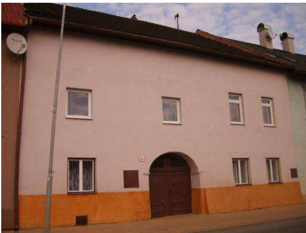
139. Ul. gen. Svobodu č. 198/101, parc. č. 576 – objekt vytypovaný na vyhlásenie za NKP
