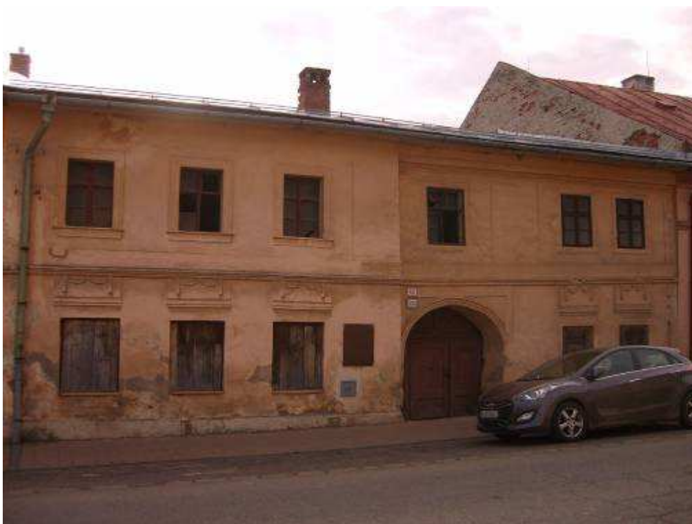
79. Ul. gen. Svobodu č. 134/42, parc. č. 459 – objekt vytypovaný na vyhlásenie za NKP
