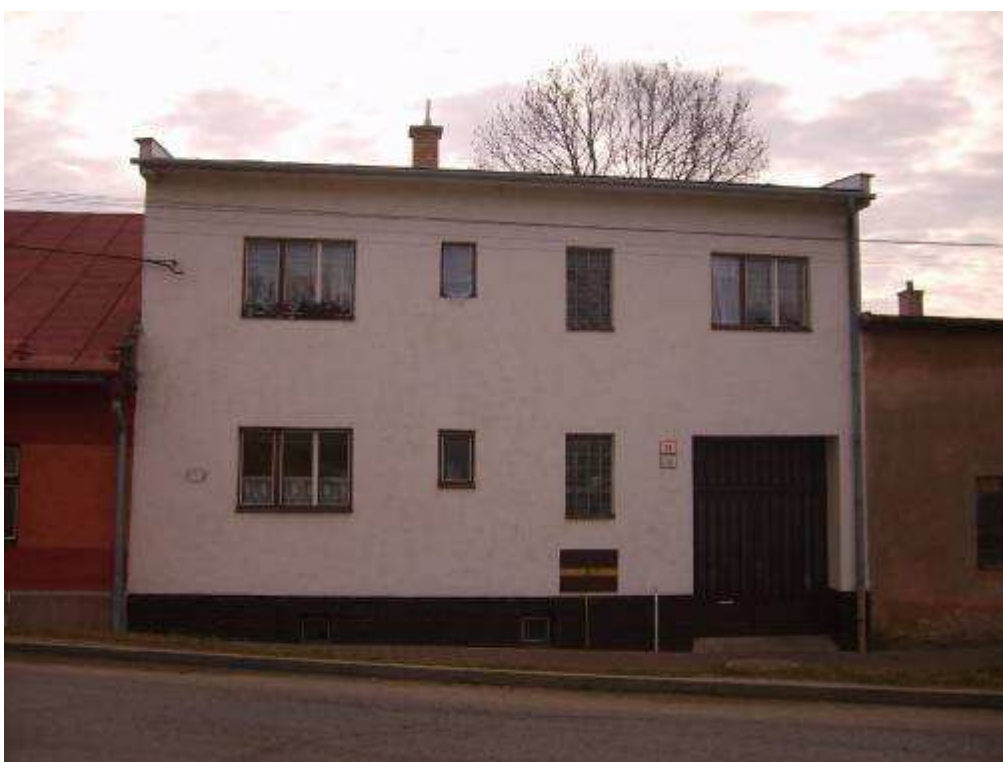
70. Ul. gen. Svobodu č. 154/28, parc. č. 829/1 – objekt nerešpektujúci pamiatkové hodnoty územia
