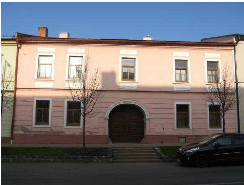
168. Ul. gen. Svobodu č. 247/125, parc. č. 47 – objekt vytypovaný na vyhlásenie za NKP
