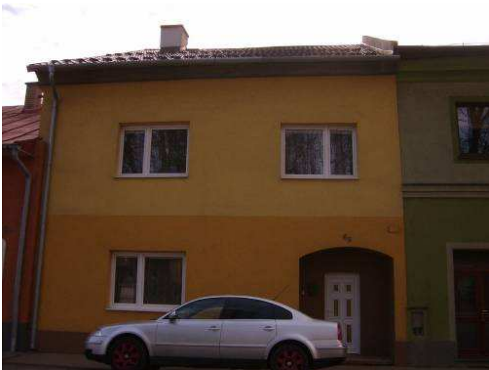
100. Ul. gen. Svobodu č. 121/68, parc. č. 425 – objekt rešpektujúci pamiatkové hodnoty územia (nevhodné zmenšenie vstupného otvoru je cudzorodé a rušivé)
