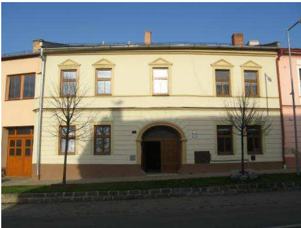
166. Ul. gen. Svobodu č. 246/123, parc. č. 50/1 – objekt vytypovaný na vyhlásenie za NKP
