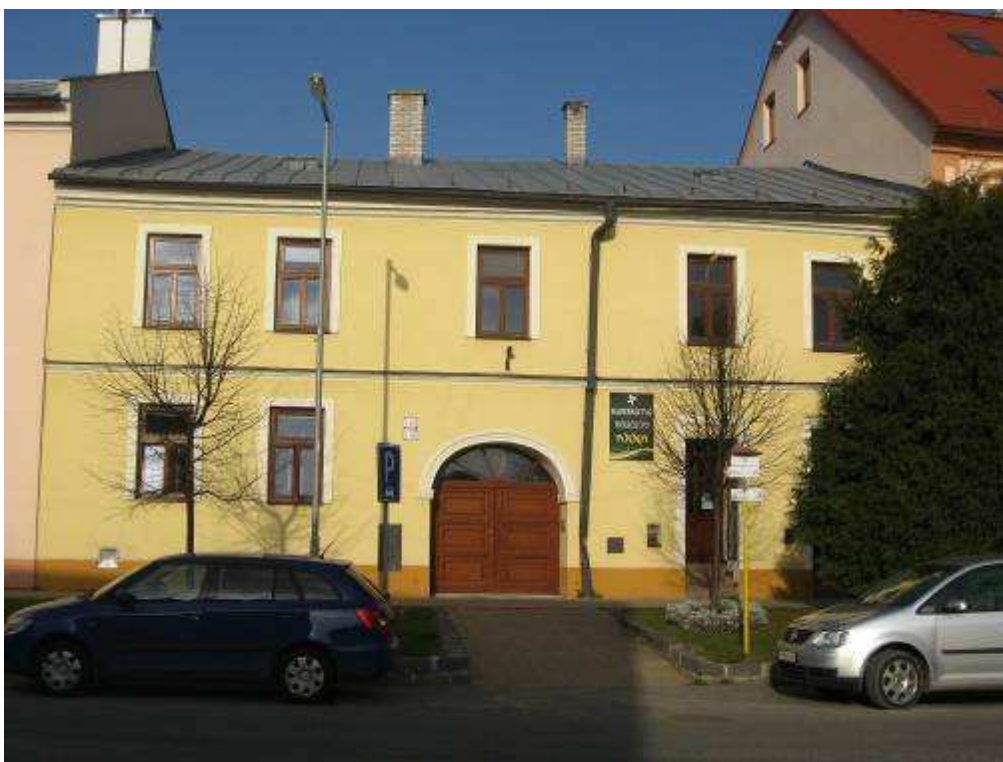
178. Ul. gen. Svobodu č. 252/135, parc. č. 42 – objekt vytypovaný na vyhlásenie za NKP
