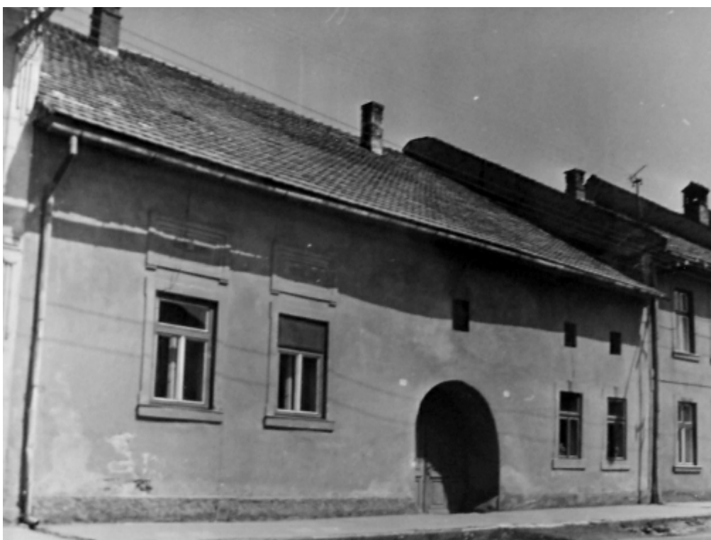
134. Ul. gen. Svobodu č. 194/93 a č. 195/95, parc. č. 580 a 579 – objekt v roku 1976 pred rozdelením (zdroj: Archív Pamiatkového úradu SR, Motaj, č. negatívu 75683)
