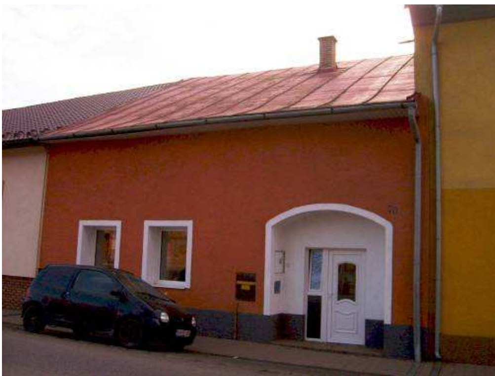
102. Ul. gen. Svobodu č. 120/70, parc. č. 424 – objekt rešpektujúci pamiatkové hodnoty územia (nevhodné zmenšenie vstupného otvoru je cudzorodé a rušivé)
