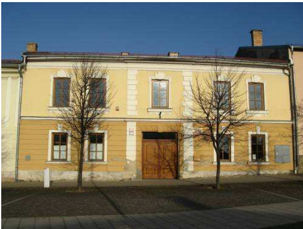
162. Ul. gen. Svobodu č. 244/119, parc. č. 54 – objekt vytypovaný na vyhlásenie za NKP
