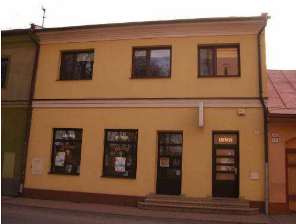
96. Ul. gen. Svobodu č. 123/64, parc. č. 427 – objekt rešpektujúci pamiatkové hodnoty územia
