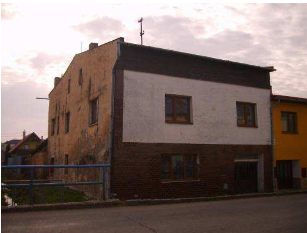
83. Ul. gen. Svobodu č. 132/46, parc. č. 455 – objekt nerešpektujúci pamiatkové hodnoty územia
