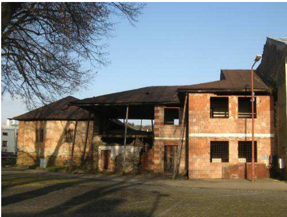
154. Ul. gen. Svobodu č. 252/115, parc. č. 56 – východná časť objektu vo výstavbe
