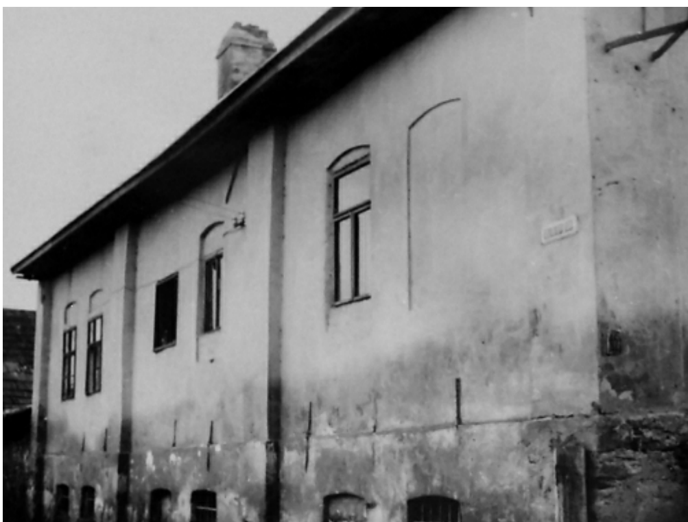
157. Ul. gen. Svobodu č. 252/115, parc. č. 56 – západná časť objektu v roku 1962 (zdroj: Archív Pamiatkového úradu SR, Borodáč, č. negatívu 34832)
