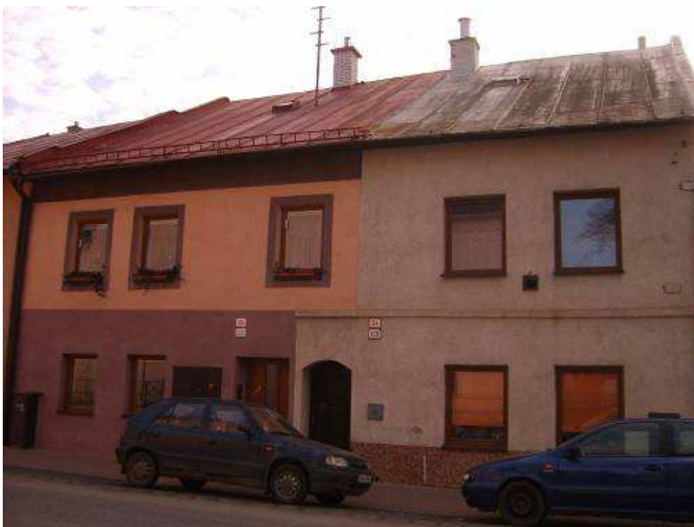
90. Ul. gen. Svobodu č. 127/56, parc. č. 435 (vľavo) a č. 128/54, parc. č. 440 (vpravo) – objekt rešpektujúci pamiatkové hodnoty územia
