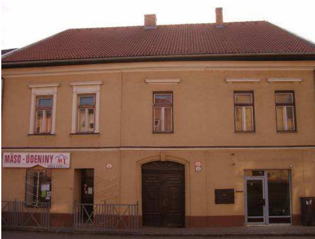
118. Ul. gen. Svobodu č. 112/88 a 90, parc. č. 412 – objekt s pamiatkovými hodnotami
