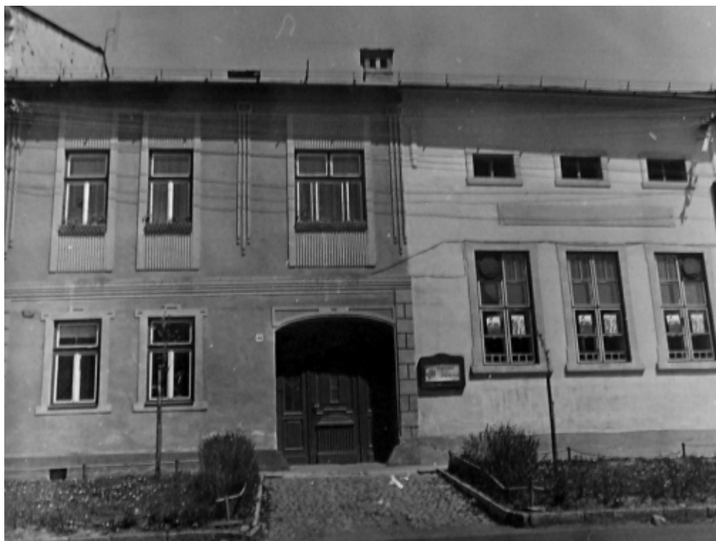
175. Ul. gen. Svobodu č. 250/131, parc. č. 44/1 (vľavo) a č. 251/133 (západná časť objektu), parc. č. 43 (vpravo) – objekty v roku 1976 (zdroj: Archív Pamiatkového úradu SR, Motaj, č. negatívu 75671)
