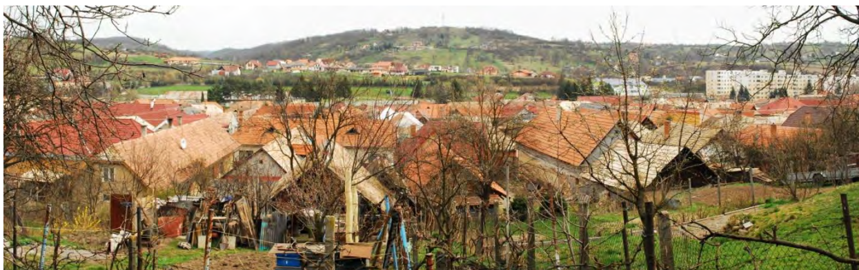
Obr. č. 56. Zachované charakteristické tvary striech Horná ulica (sedlové strechy - s valbou a - štvrt'valbou)
