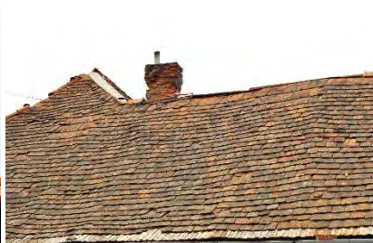
Obr. č. 59., č. 60., č. 61. Druhy strešných keramických krytín
