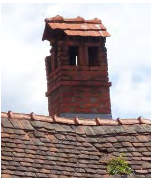
Obr. č. 68., č. 69., č. 70. Charakteristické komíny so škárovaním tehlového muriva a omietaním komínového telesa
