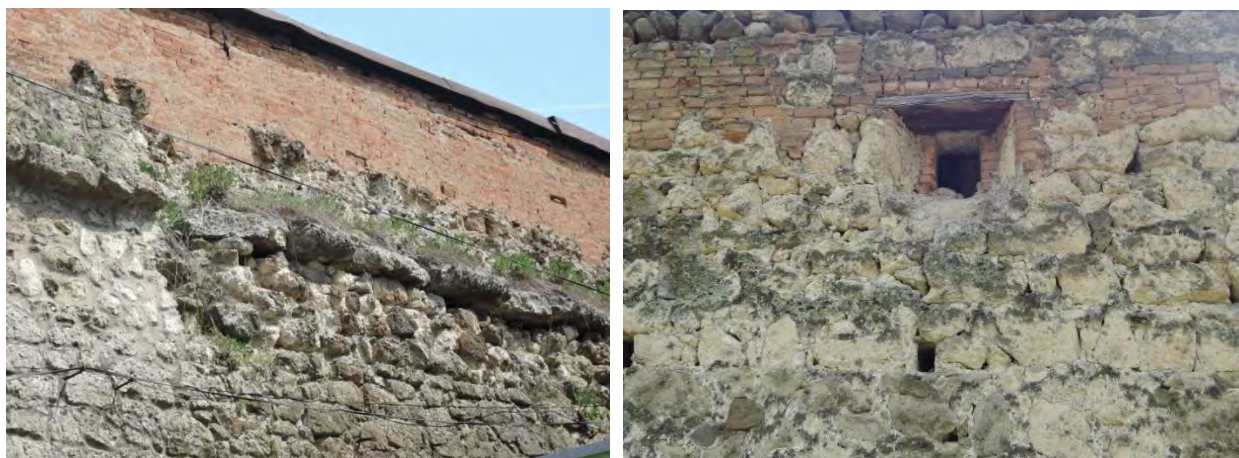
Obr. č. 87., 89. Južná kurtina opevnenia v úseku medzi Dolnou bránou a Tureckou baštou – detail rímasy a Západná kurtina, za objektom na Sládkovičovej ulici č. 11 – detail strieľne
