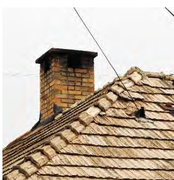
Obr. č. 68., č. 69., č. 70. Charakteristické komíny so škárovaním tehlového muriva a omietaním komínového telesa
