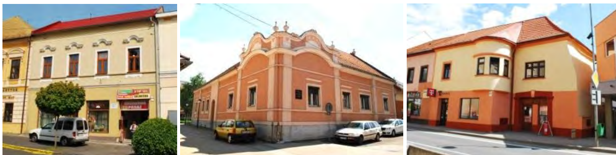
Obr. č. 98., 99., 100. Pohľad na južnú fasádu meštianskeho domu č. 7 Svätotrojičné nám., pohľad na nárožie meštianskeho domu č. 12 Kuzmányho ulica, západná fasáda meštianskeho domu č. 1 s arkierom na ulici ČSA.
