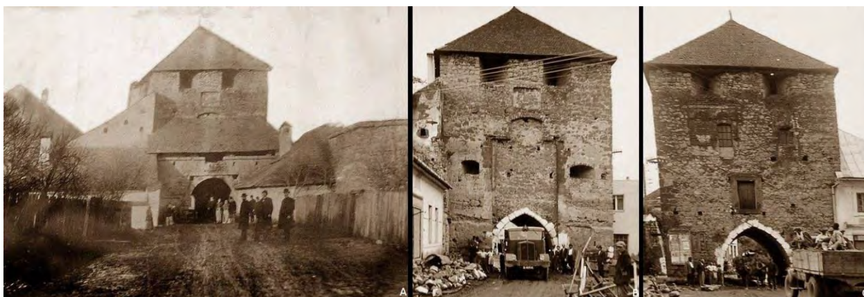
Obr. č. 83. Dolná brána – A) vonkajšia fasáda so sekundárne zastrešeným predbráním zaniknutým po roku 1938; B) vonkajšia fasáda po odstránení predbránia ( r. 1938-1942); C) vnútorná fasáda brány ( r. 1938-1942).
