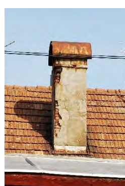
Obr. č. 68., č. 69., č. 70. Charakteristické komíny so škárovaním tehlového muriva a omietaním komínového telesa
