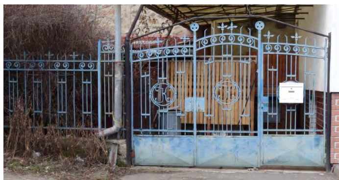
Obr. č. 147., 148., 149. Príklad kovových brán a oplotenia na ulici ČSA, Gliarska a Kuznányho ulica
