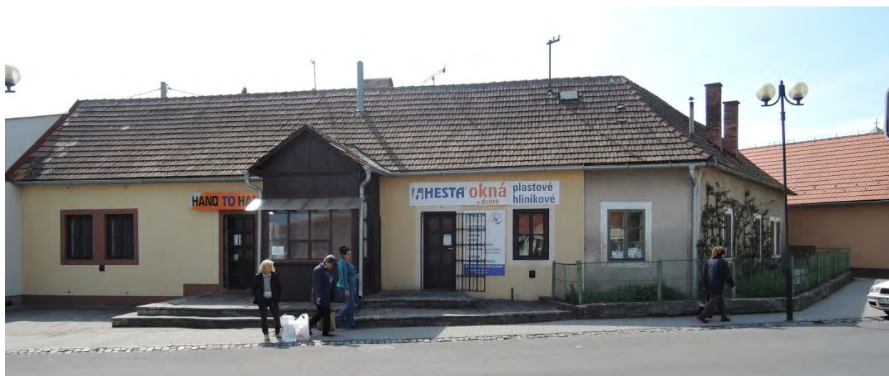
Obr. č. 86. Severozápadný bastión, tzv. Vodná bašta, prestavaná na obytný objekt z 19. storočia, stav pred asanáciou r. 2016
