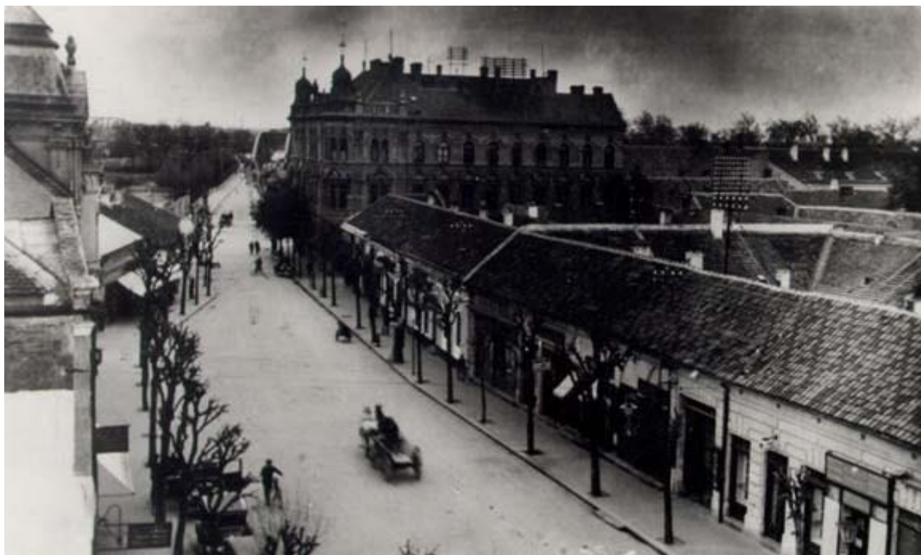
100. Pohľad na asanovanú časť (v pravo) dnešnej Lehárovej ulice. Archív KPÚ Nitra.
