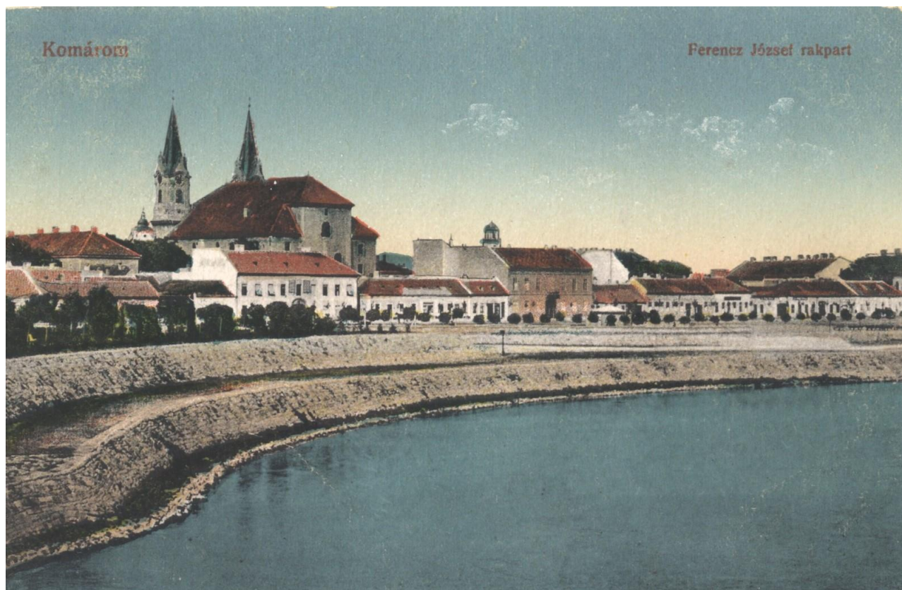
81. Pohľad z malého mosta na Darányiho park na Dunajskom nábreží. Archív KPÚ Nitra.
