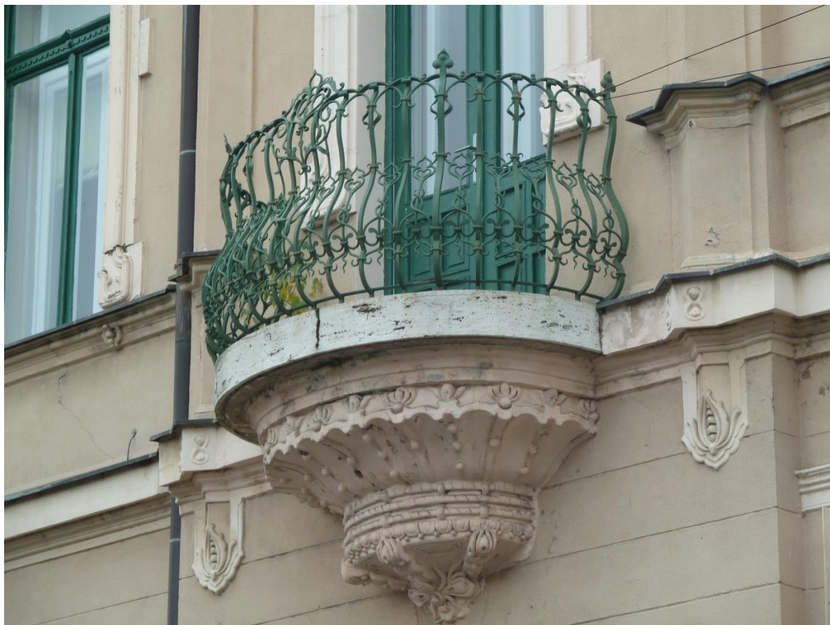
17. Balkón s kovovým zábradlím na budove na Tržničnom námestí č. 3 (1912). Archív KPÚ Nitra.
