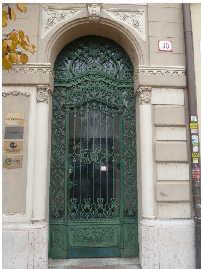
18. Kovaná dverná výplň na budove na Tržničnom námestí č. 3 (1912). Archív KPÚ Nitra.
