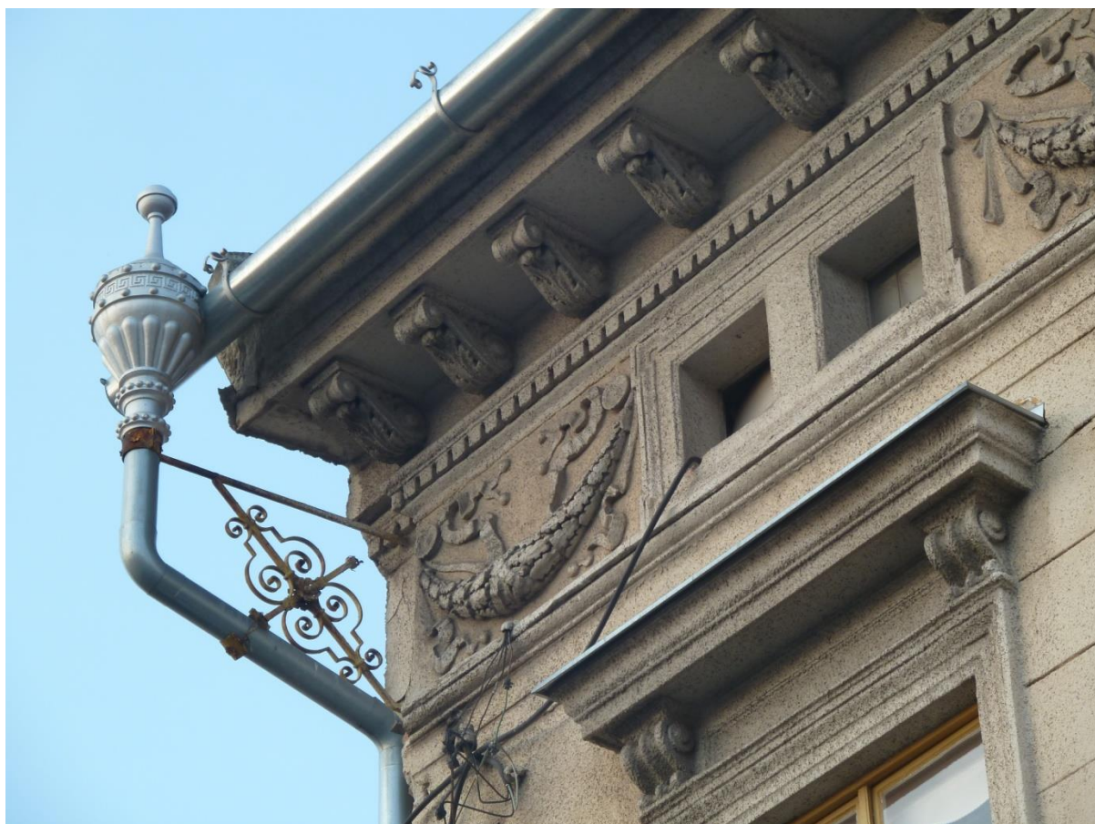
20. Kovový okap na budove bývalej banky na Jókaiho ulici č. 24 (p.č. 20/1). Archív KPÚ Nitra.
