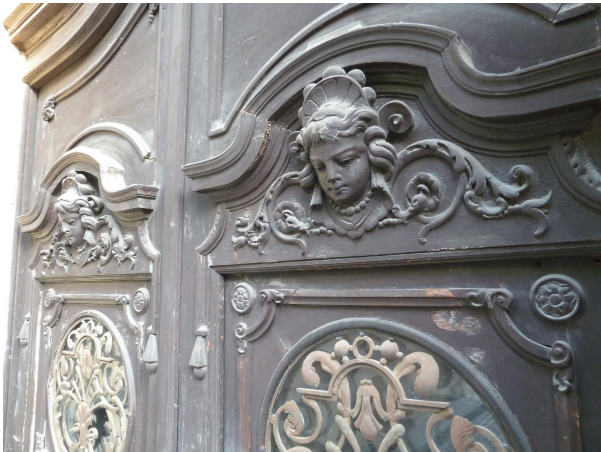
25. Detail vstupnej brány nájomného domu na Ulici pohraničná č. 3 (p.č. 565/1). Archív KPÚ Nitra.
