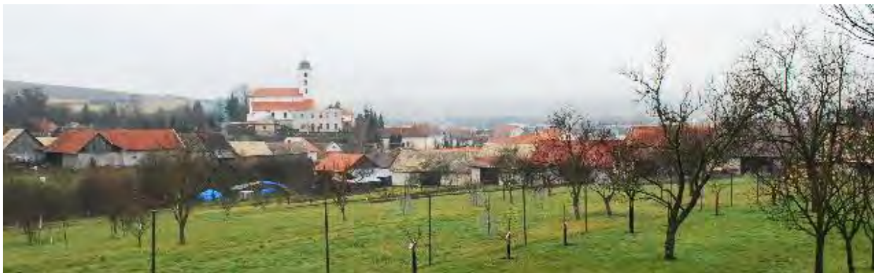
Obr. č. 31 Pohľad smerom južným na zástavbu domov v pozadí r. k. kostol sv. Michala archanjela (z dôvodu zastrešenia pôsobí katolícka škola v areáli r. k. kostola rušivo)
