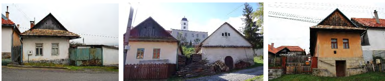
Obr. č. 58, 59, 60 Zástavba ľudových domov na ulici E. M. Šoltésovej a Slávikovej
