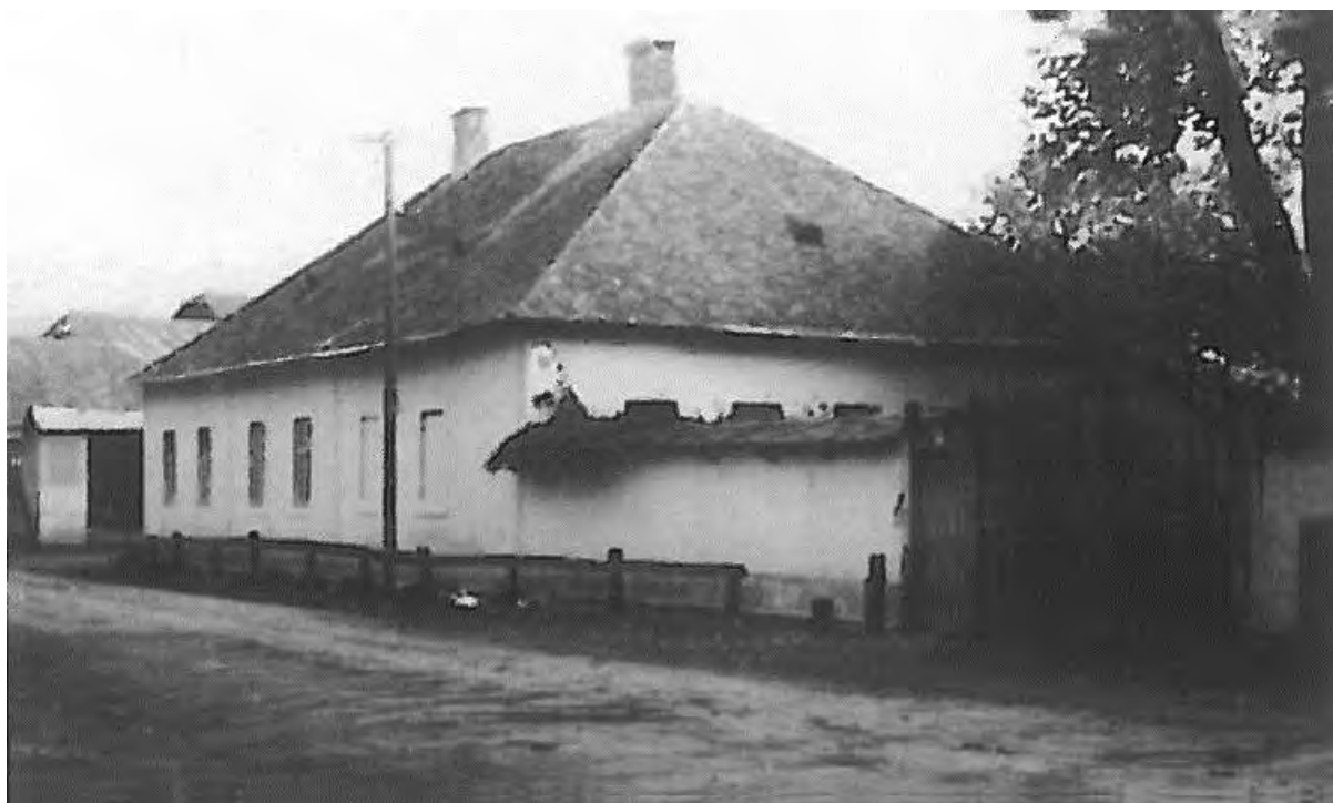
Obr. č. 28 Budova tretej evanjelickej školy na Slávikovej ul., škola zriadená koncom 19. storočia
