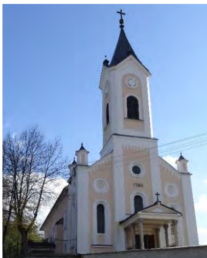
Obr. č. 54 Pohľad južný
