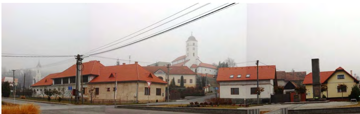
3. pohľad juhovýchodným smerom na zástavbu Námestia SNP v popredí pamätník a objekt bývalých stajní, v pozadí ev. a. v. kostol, r. k. fara a na návrší dominantu r. k. kostola sv. Michala archanjela
