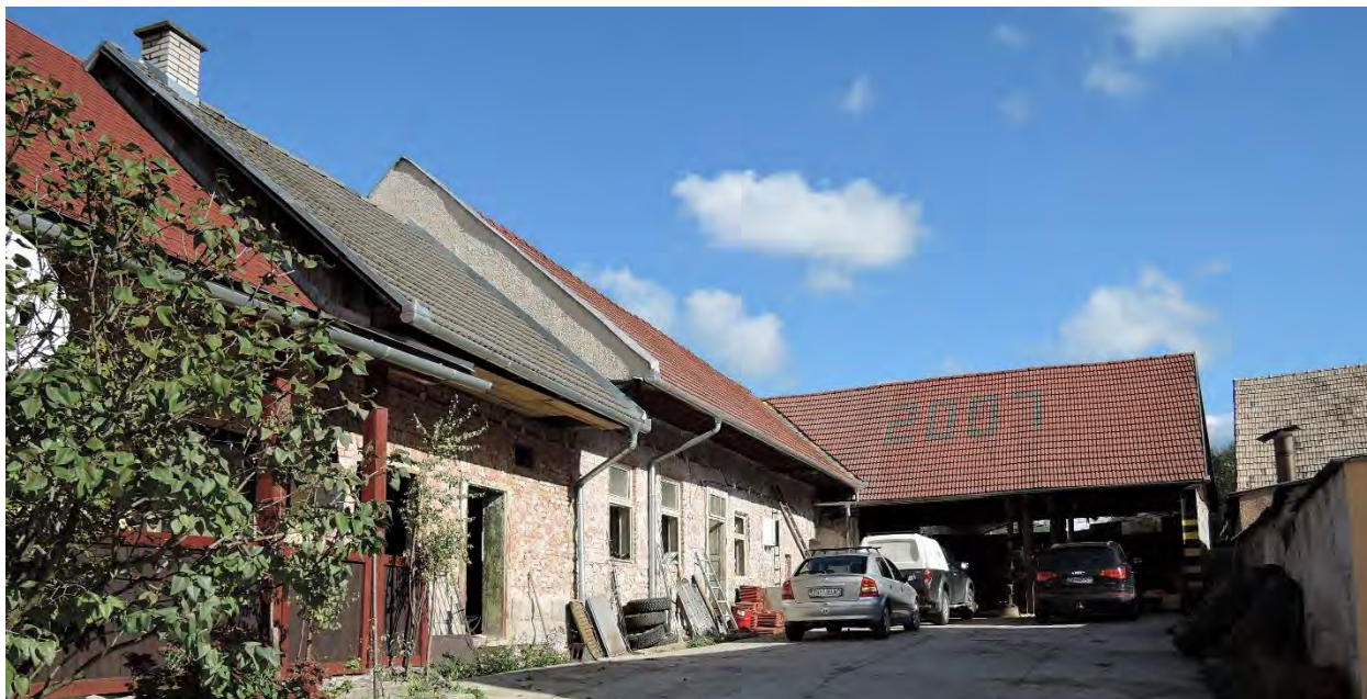
Obr. č. 30 Pohľad na radovú zástavbu severnej strany ul. E.M. Šoltésovej
