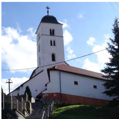
Obr. č. 51 Pohľad severozápadný
