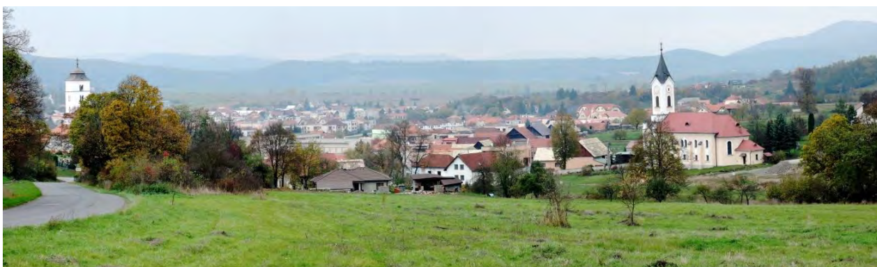
III. pohľad z vyvýšenej polohy lúky - nad areálom r. k. cintorína severným smerom na r. k. kostol sv. Michala archanjela, ev. a. v. kostol a severovýchodnú časť pamiatkového územia
