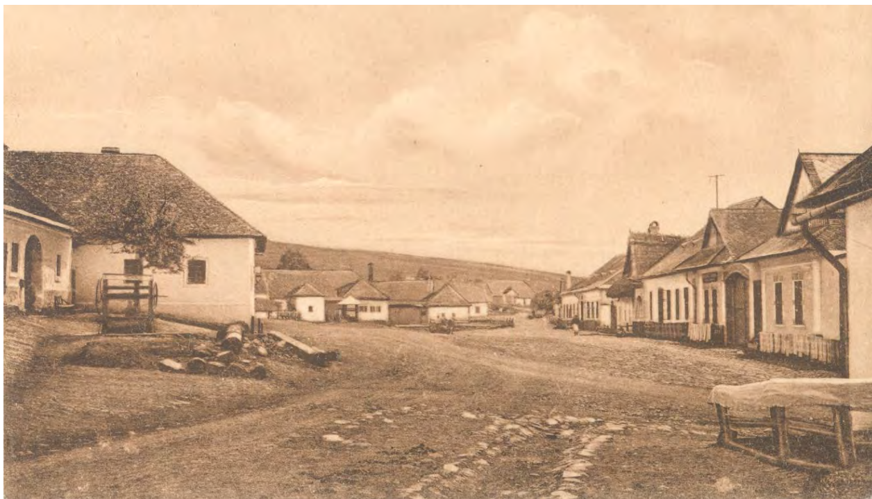
Obr. č. 16 Pohľad južným smerom na hlavné námestie - rínok
