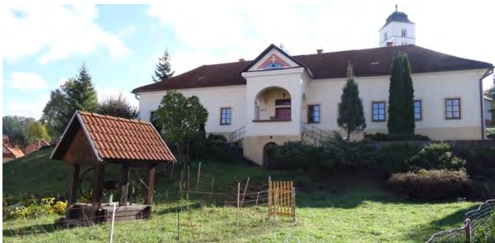
Obr. č. 53 Pohľad na severozápadnú fasádu objektu r. k. fary so zachovanou studňou v záhrade
