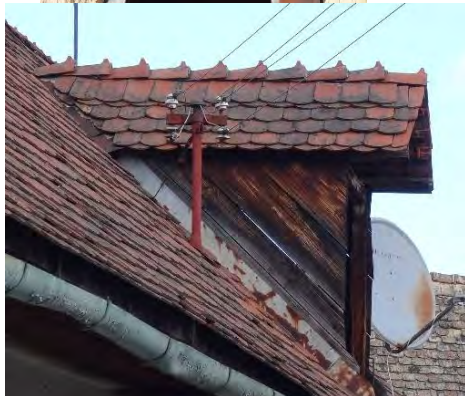
Obr. č. 38, 39, 40 Strešný vikier tzv. hospodársky vikier so sedlovou stieškou, rôzne druhy keramickej krytiny
