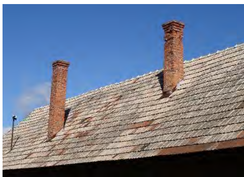
Obr. č. 44, 45 Charakteristické komíny s jednoduchým ukončením komínovej hlavice
