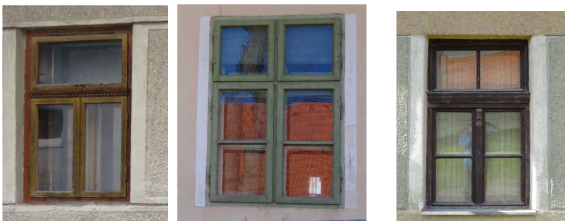
Obr. č. 75, 76, 77 Pôvodné členenie drevených výplní okien
