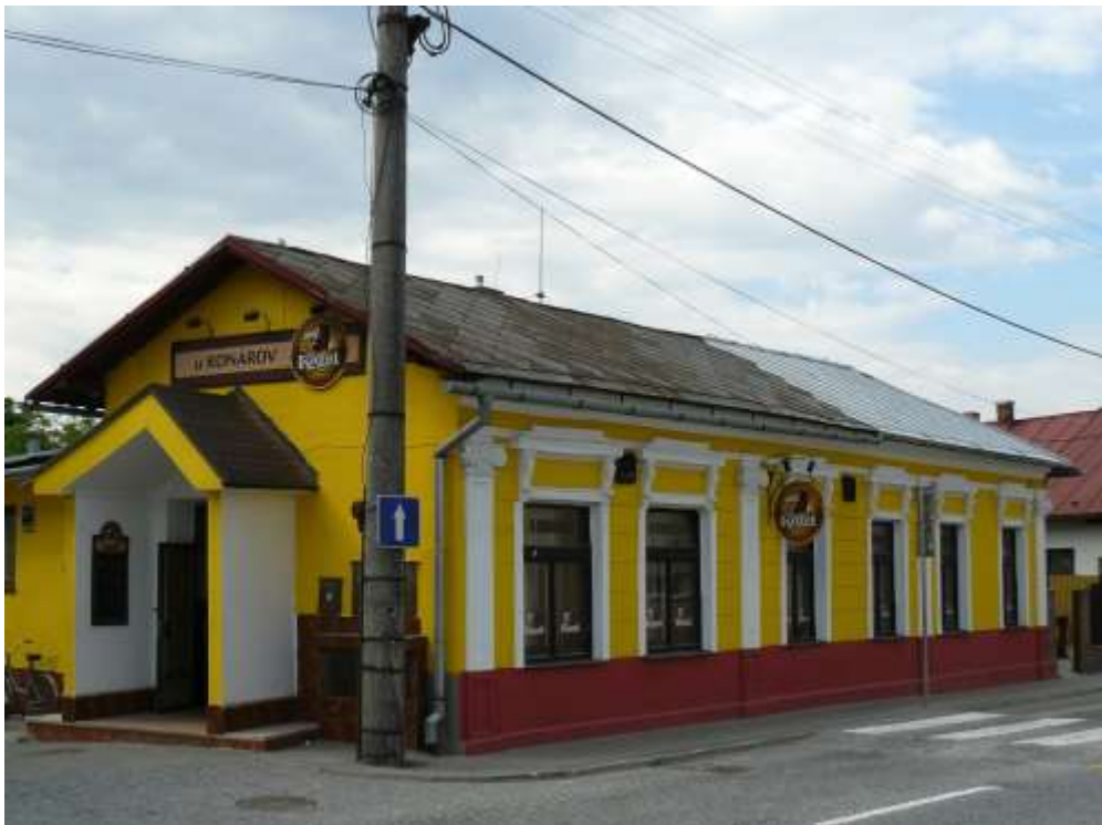
Ul. 1. mája, súpisné číslo 89, parcelné číslo KN 865/1 - predmetom ochrany je: H – hmota uličného krídla, F – fasáda so štukovou výzdobou, U – štuková výzdoba fasády, S – tvar
