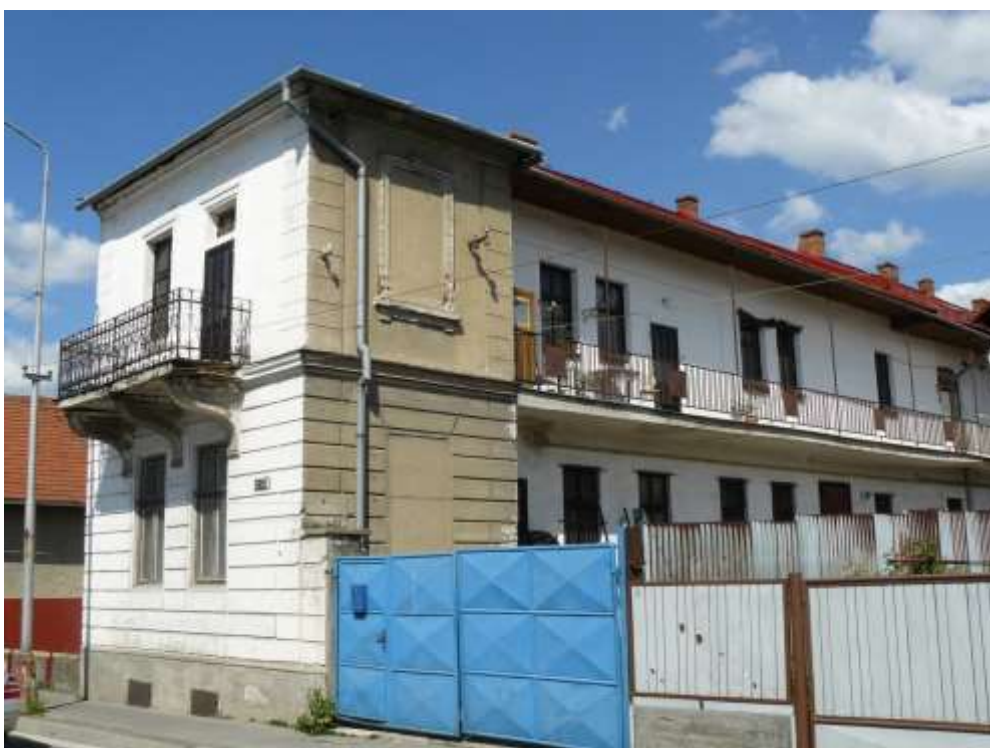
Ul. Lombardiniho, súpisné číslo 385, parcelné číslo KN 22 - predmetom ochrany je: H – hmota uličného krídla, F – fasáda so štukovou výzdobou, P – riešenie parteru obchodných prevádzok, U – štuková výzdoba fasády, S – tvar
