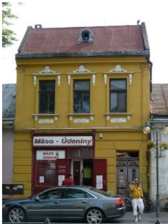
Ul. Sidónie Sakalovej, súpisné číslo 146, parcelné číslo KN 1137 - predmetom ochrany je: H – hmota uličného krídla, F – fasáda so štukovou výzdobou, P – riešenie parteru obchodných prevádzok, U – štuková výzdoba fasády, S – tvar
