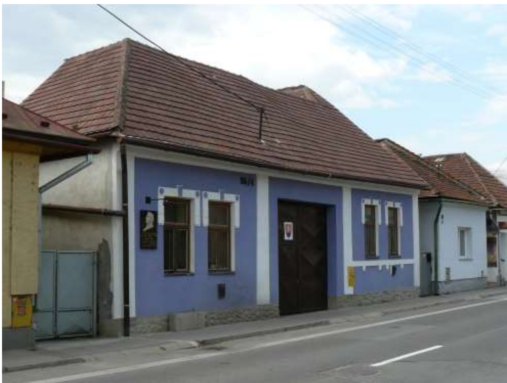
Ul. 1. mája, súpisné číslo 35, parcelné číslo KN 854/1 - predmetom ochrany je: H – hmota uličného krídla, F – fasáda so štukovou výzdobou, U – štuková výzdoba fasády, S – tvar
