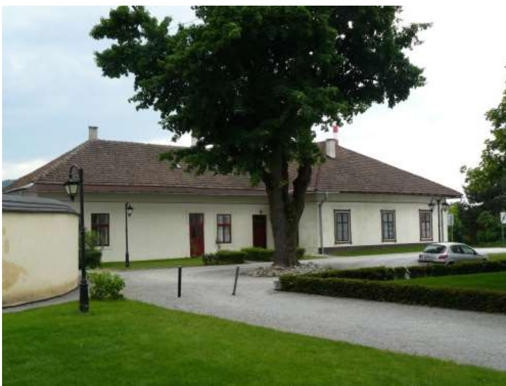
Ul. Zámocká, popisné číslo 3, parcelné číslo KN 905/2 - predmetom ochrany je: H – hmota uličného krídla, F – fasáda so štukovou výzdobou, U – štuková výzdoba fasády, S – tvar a forma zastrešenia
