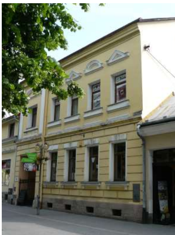
Ul. Sidónie Sakalovej, súpisné číslo 142, parcelné číslo KN 1148 - predmetom ochrany je: H – hmota uličného krídla, F – fasáda so štukovou výzdobou, P – riešenie parteru obchodných prevádzok, U – štuková výzdoba fasády, S – tvar
