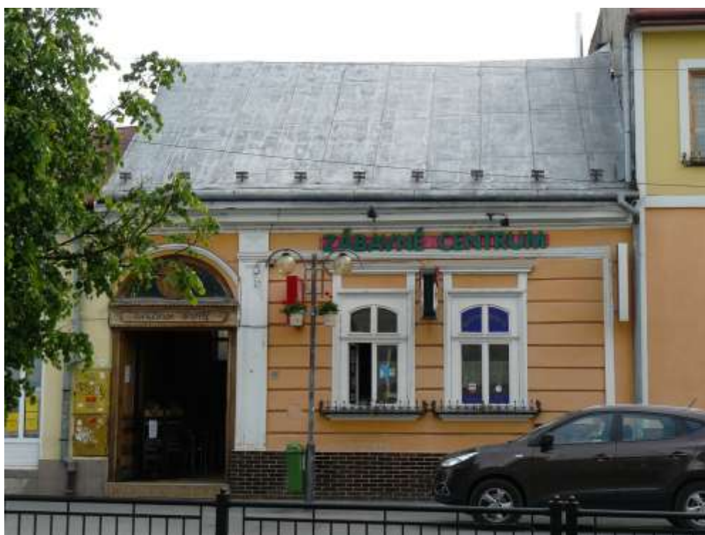
Ul. Sidónie Sakalovej, súpisné číslo 156, parcelné číslo KN 1120 - predmetom ochrany je: H – hmota uličného krídla, F – fasáda so štukovou výzdobou, U – štuková výzdoba fasády, S – tvar
