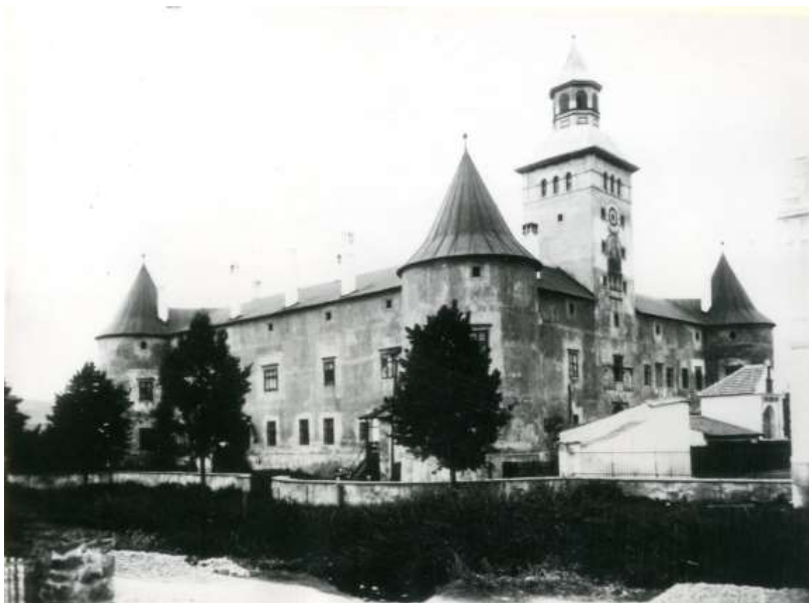
204. Bytčiansky zámok, č.neg.44411,hrad,severné krídlo, stav po vybúraní prízemných okien pre byty, rok 6. 1964, autor Just
