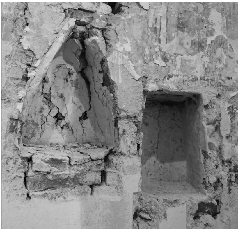
Obr. 12. Apsida, severná stena, pohľad na dvojicu mladších pastofórií. Trojuholníkovým uzáverom je ukončené neskororománske (ranogotické?) pastofórium, ktoré bolo doplnené, resp. nabrazené gotickou obdĺžnikovou nikou s neskororenesančnou úpravou zmenšením.
