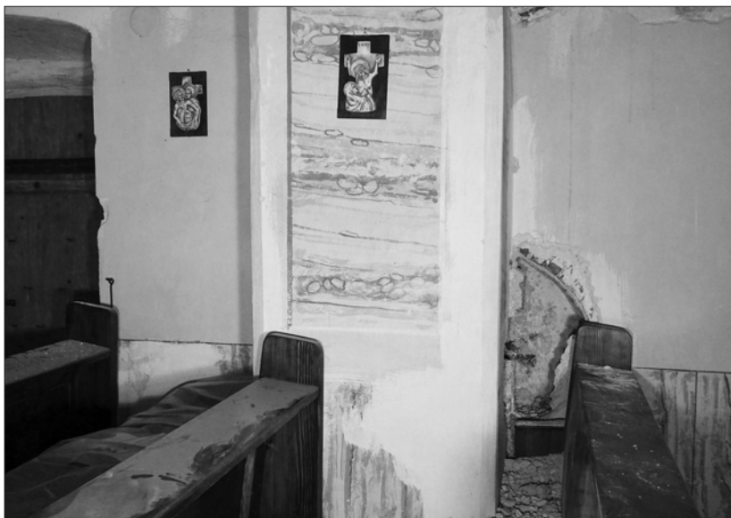
Obr. 8. Loď, južná stena so sedíliou západne od portálu, pohľad na čiastočne odkrytú západnú románsku sedíliu, ktorá bola zrušená po vložení neskororenesančného prístenného piliera.
