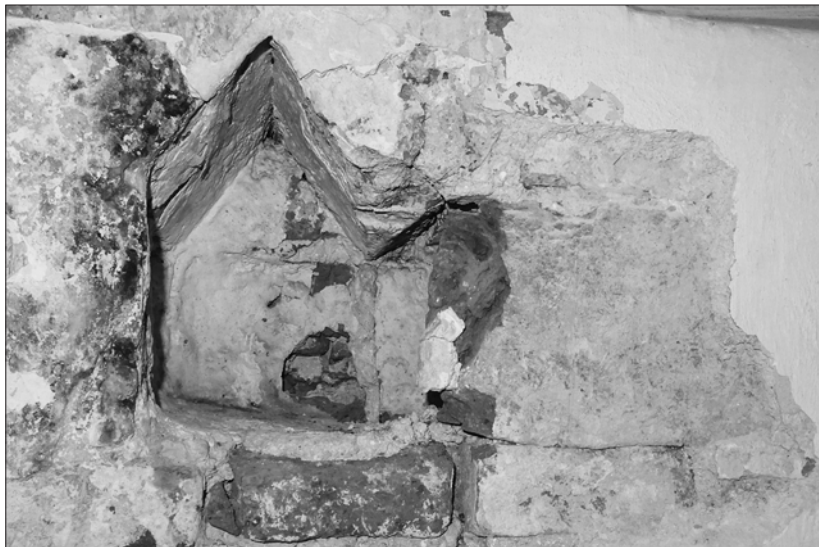
Obr. 10. Apsida, južná stena, primárna nika s bočným skrytým odkladacím priestorom vytvoreným v brúbke steny.
