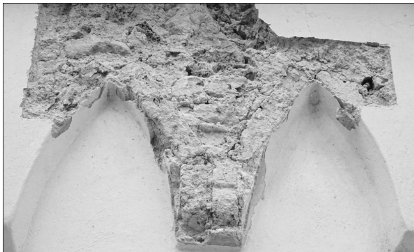
Obr. 3. Podstrešný vlys apsidy, nález pôvodného konštrukčného a tvarového riešenia.
