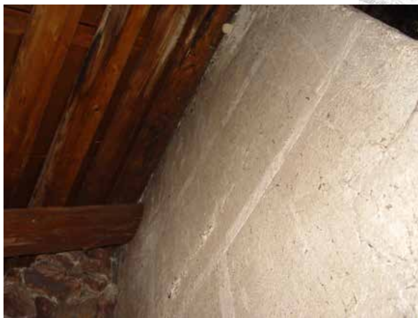
14. Iluzívne kvádrovanie v omietke pôvodne exteriérovej fasády veže po jej znovupostavení pred polovicou 18. storočia. Foto: M. Janovská, 2014.
