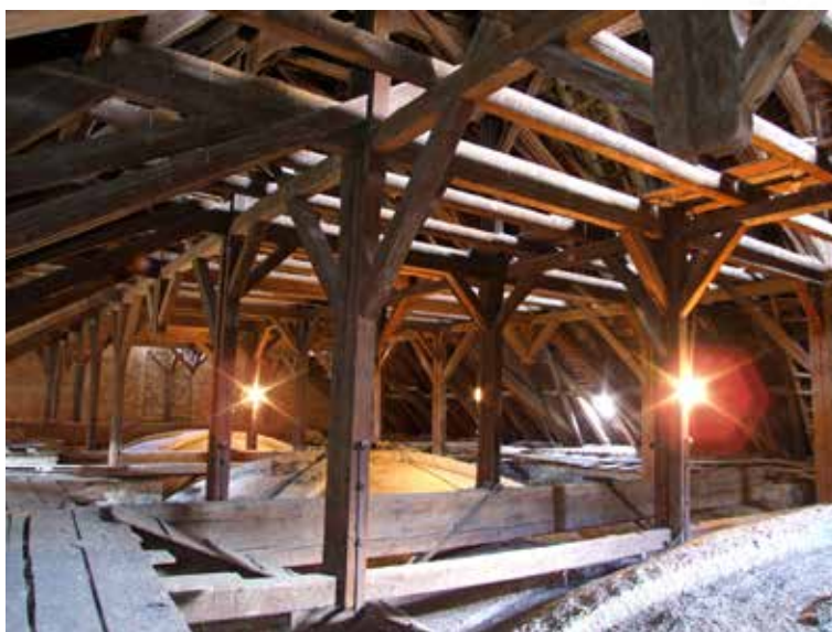
28. Rožňava, ev. a. v. kostol. Pohľad do krovu s ležatými a stojatými stolicami. Foto: Ľ. Suchý, 2016.
