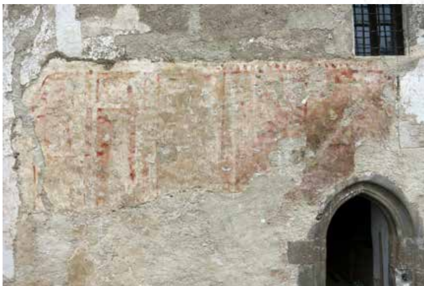
10. Západná časť výmalieb južnej fasády.
