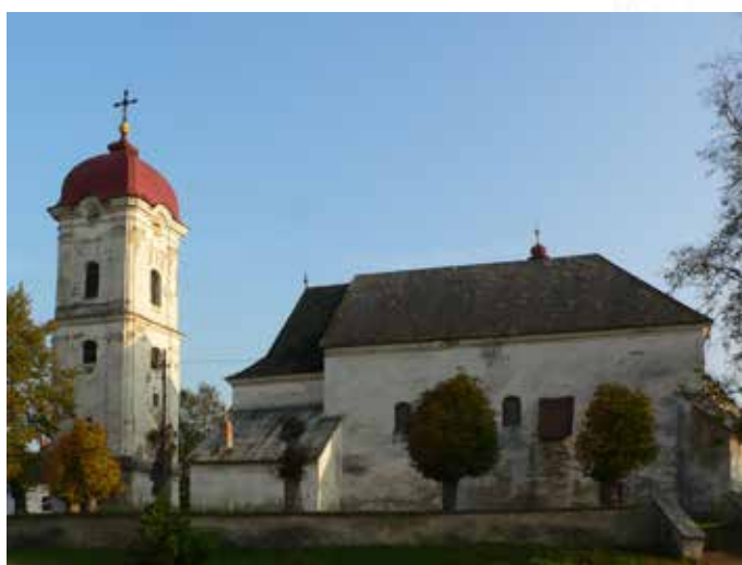
8. Severná fasáda kostola. Foto: M. Tihányiová, 2005.
