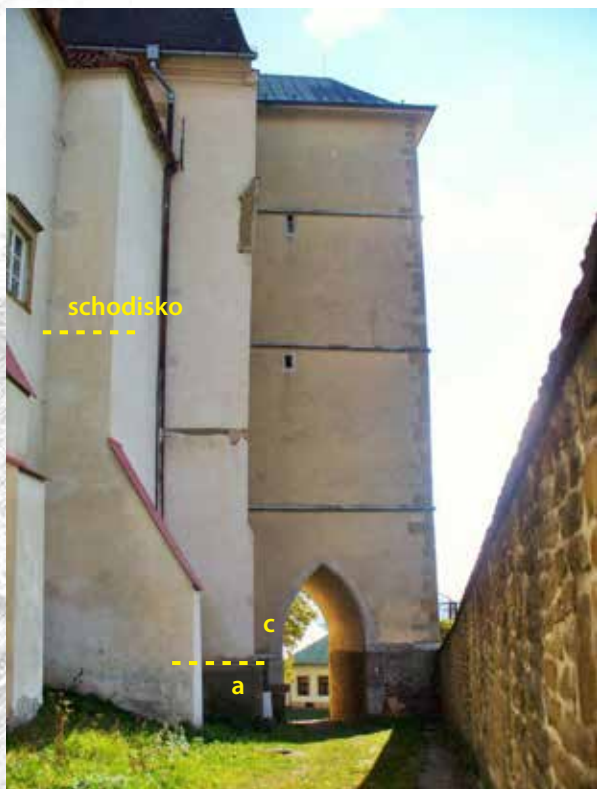
11 a) – b) Priebeh soklovej rímsoy: a) pokračujúcej z južného ambitu, b) na juhozápadnom opornom pilieri, c) prerušenej prístavbou západnej veže kostola. Foto: N. Urbanová, 2015.
