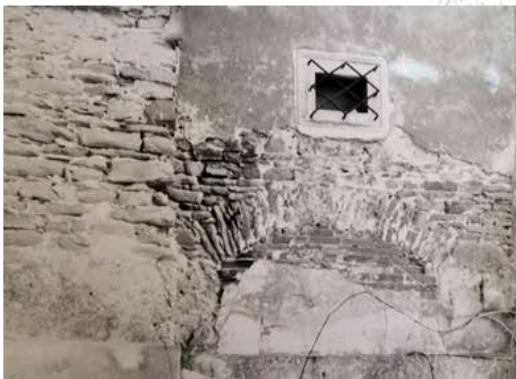
12 Kamenný odľahčovací oblúk nad zamurovanou bránou, spomínanou v súvislosti so zaklenutím poschodia v západnom ambite v roku 1695. Zdroj: URBANOVÁ 1982, ref. 14.
