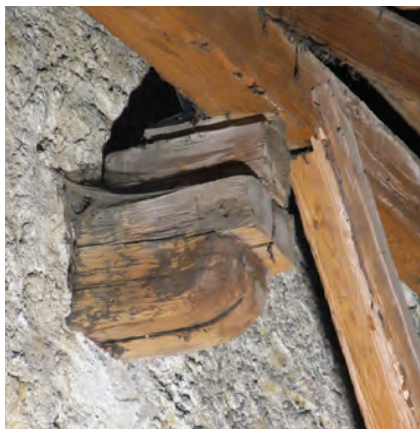
^ Štítik, evanjelický kostol a. v. – stredoveká drevená konzola pôvodnej hrebeňovej väznice pultového krovu nad severnou loďou. Foto: Ľ. Suchý, 2018.
