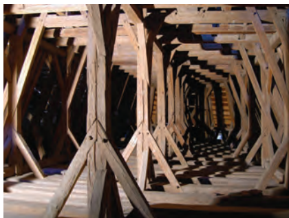
Spišská Kapitula, Kaplnka Zápoľských – hambáľkový krov nad loďou viazaný centrálnym rámom pod hrebeňom strechy a postrannými rámovými stolicami (1490/91d). Foto: I. Janovský, 2007.
