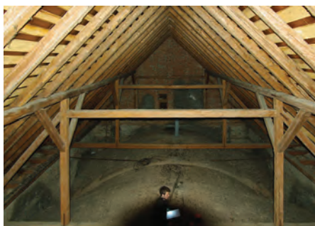
Breza, rímskokatolícky Kostol Panny Márie Snežnej – väznicový krov s postrannými stolicami a dvojitým vešadlom, krov bez hambáľkov ešte s krátčatami (1906 – 1908), rezy plnou a prázdnu priečnou väzbou. Foto: P. Krušínský, 2009, kresba: K. Ďurian, 2009.
