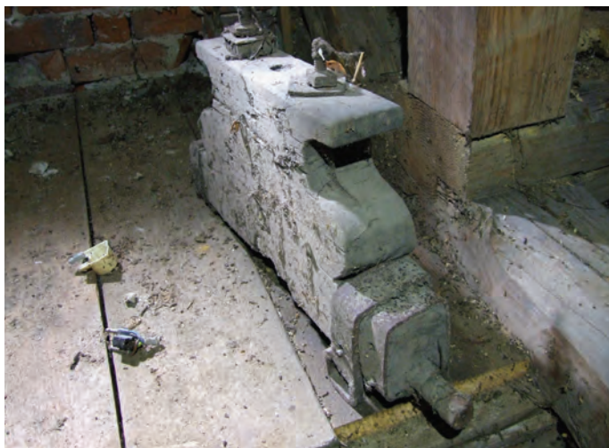
< Rokycany, rímskokatolícky Kostol sv. Kataríny – staršia drevená zvonová hlava so strmeňmi a okovaním, dnes voľne položená v podstreší lode (18. – 19. storočie). Foto: Ľ. Suchý, 2013.
