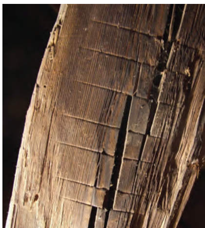
^ Abramová, rímskoka- tolický Kostol sv. Koz- mu a Damiána – krov nad loďou (1471d), tesárska značka na vzpere 7. priečnej väz- by v podobe plytkých priamych zárezov. Foto: Ľ. Suchý, 2008.
