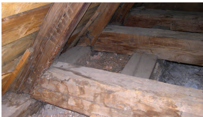
Bijacovce, Kostol Všetkých svätých – krov nad loďou (1. po- lovica 14. storočia), tesárska značka v podobe úzkych čiarových vrypov na hrane väzného trámu a krokve (8. väzba). Foto: Ľ. Suchý, 2006. >
