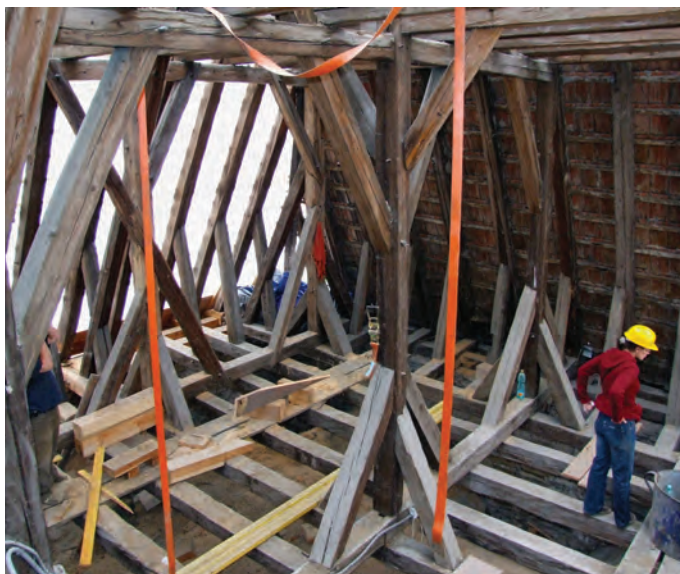
Okoličné, kláštorň Kostol sv. Petra z Alkantary – hambáľkový krov nad loďou viazaný centrálnym rámom pod hrebeňom strechy a postrannými rámovými stolicami (1489/90d). Foto: Ľ. Suchý, 2010.
