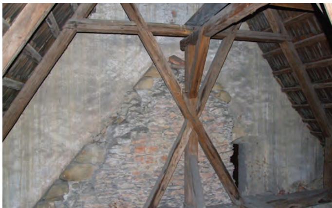
Svitavy (Česká republika), cintorínsky kostol sv. Jíjji, pôvodne stredoveký kláštorňý kostol premonštrátov – odtlačok tvaru pôvodnej stredovekej strechy v podstreší. < Foto: Ľ. Suchý, 2016.
