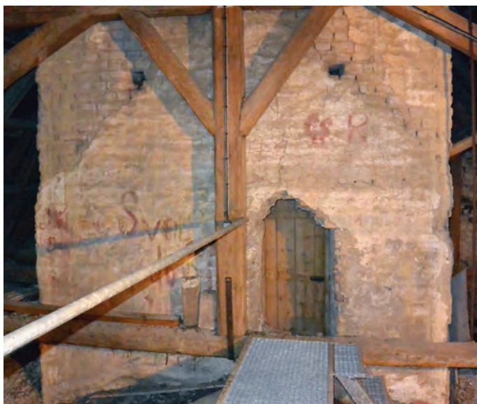
< Hrnčiarovce nad Parnou, rímskokatolícky Kostol sv. Martina – odtlačok strechy na veži z 1. polovice 13. storočia s kapsami po stredových väzniciach (?) pôvodného krovu. Foto: D. Zacharová, 2017.
