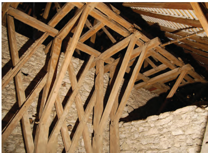
Spišská Kapitula, Katedrála sv. Martina – zachovaný fragment pôvodnej drevenej podpornej konštrukcie stredovekého krovu nad trojlodím zo záveru 60. rokov 15. storočia. Foto: < Ľ. Suchý, 2011.
