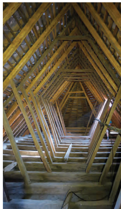
^ Beluj, rímskokatolícky Kostol sv. Vavrinca – historický krokrový hambáľkový krov bez pozdĺžneho viazania (2. polovica 17. storočia). Foto: L. Suchý, 2018.
