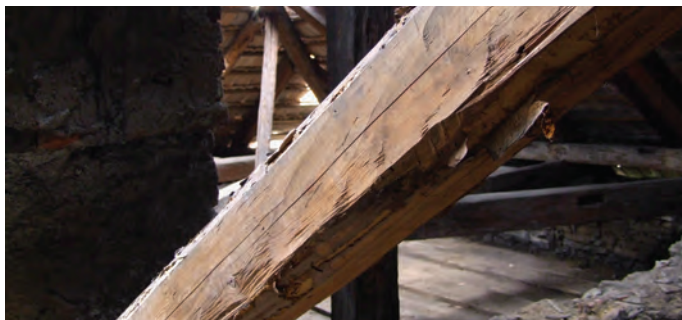
< Smižany, Smrekova 8 (bývala kúria Csákyovcov) – krov nad uličným krídlom, trasologické stopy po úprave vzpery sekerami (záštepky), 19. storočie. Foto: Ľ. Suchý, 2012.
