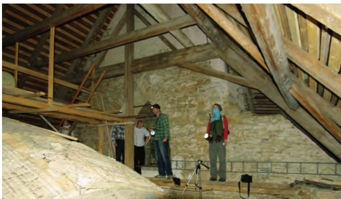
Malatiny, rímskokatolícky Kostol Všetkých svätých – krov s vyspelou formou ležatej stoly doplnenou jednoduchým vešadlom v hornej úrovni (1. plná priečna väzba pri veži). Foto: < P. Krušínský, 2009.
