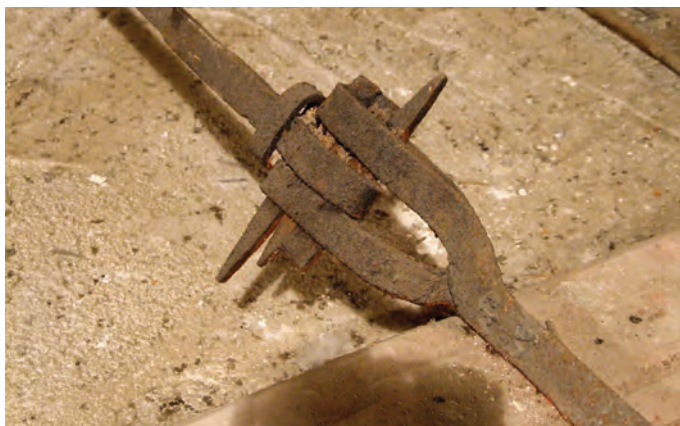
Markušovce, kaštieľ, podstrešie zaatikovej strechy – vidlicový spoj dvoch koncov (častí) železného pásového tiahla zabezpečený proti posunu kovanými klinmi (zavlačou) nad podlahou v podstreší (18. storočie). Foto: Ľ. Suchý, 2012. >
