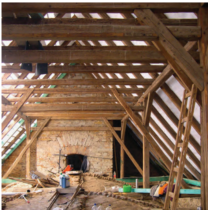
Radoma, rímsko-katolícky Kostol Ružencovej Panny Márie – hambáľkový krov s postrannými stojatými stolicami (19. storočie). Foto: Ľ. Suchý, 2005. >
