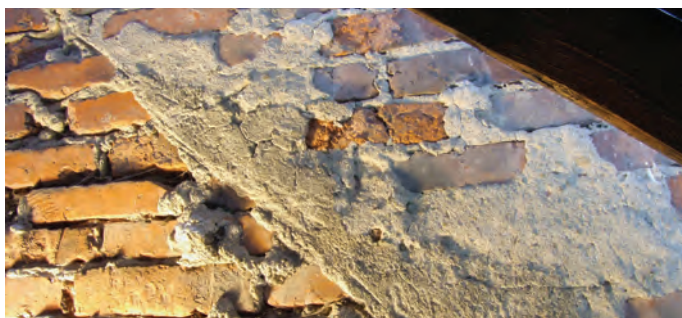
< Levoča, Nová ul. 20 (meštiansky dom, dvorové krídlo) – odtlačok tvaru strechy a staršej šindľovej krytiny v podstreší na štítovom múre (18. – 19. storočie). Foto: Ľ. Suchý, 2016.
