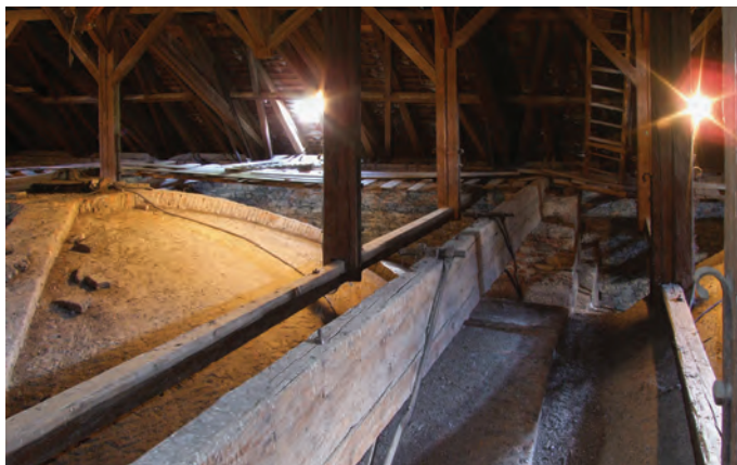
^ Rožňava, evanjelický kostol a. v. – v úrovni väzných trávov pri štíte samostatný systém priečneho stuženia obvodových murív kostola kombinovaným zazubeným dvojitém vodorovným trámom (nosníkom) a symetrickým železným stužením postrannými šikmými tiahkami z kovanej pásoviny s vidlicovým ukončením so zarážkou. Foto: Ľ. Suchý, 2016.
