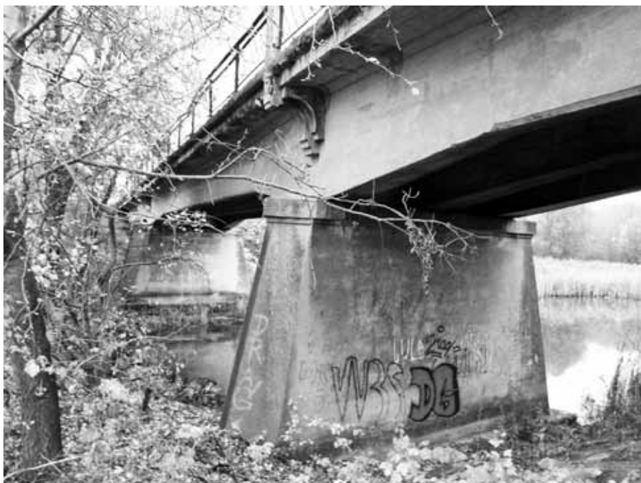
Torzo železobetónového secesného mosta z roku 1910
