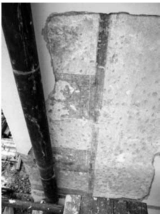
Nález staršej omietkovej vrstvy počas obnovy fasády
