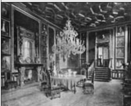
Kaštieľ v Parchovanoch, salón na prízemí (1887)
