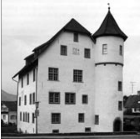
Götzis, Jonasov zámok, po rekonštrukcii
