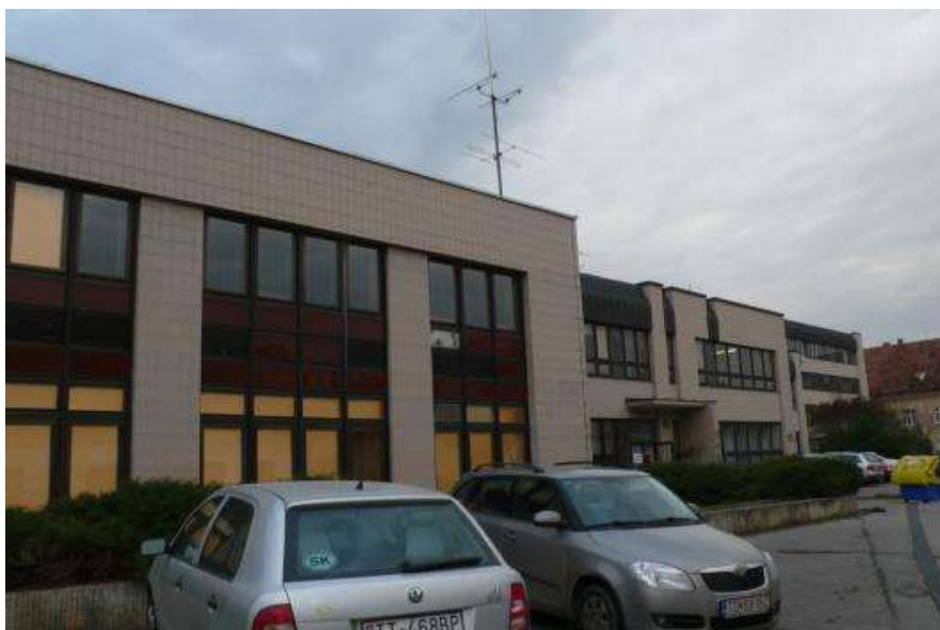
Halenárska ulica – objekt STU
