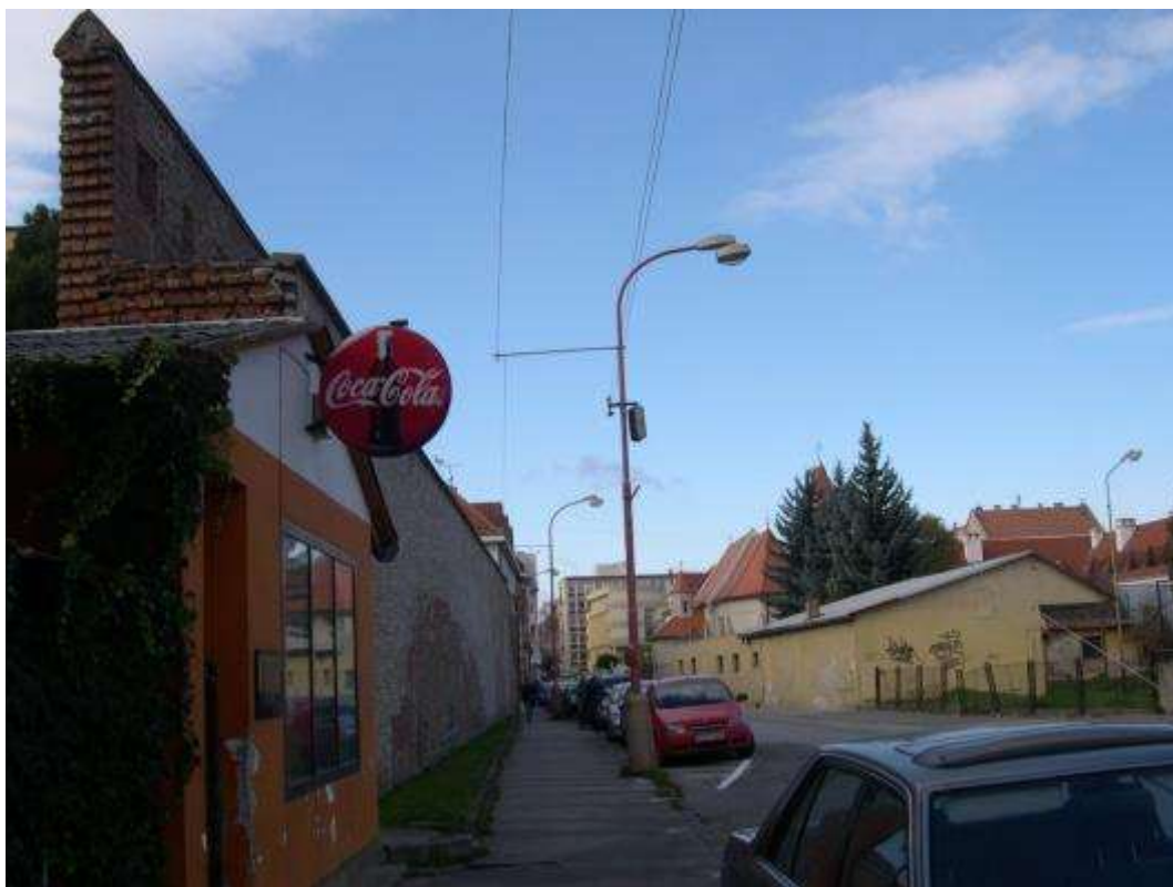
Dolné bašty - časť mestského opevnenia
