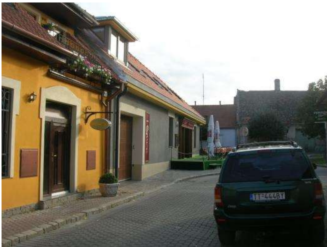
Invalidská ulica 4 – nárožný objekt
