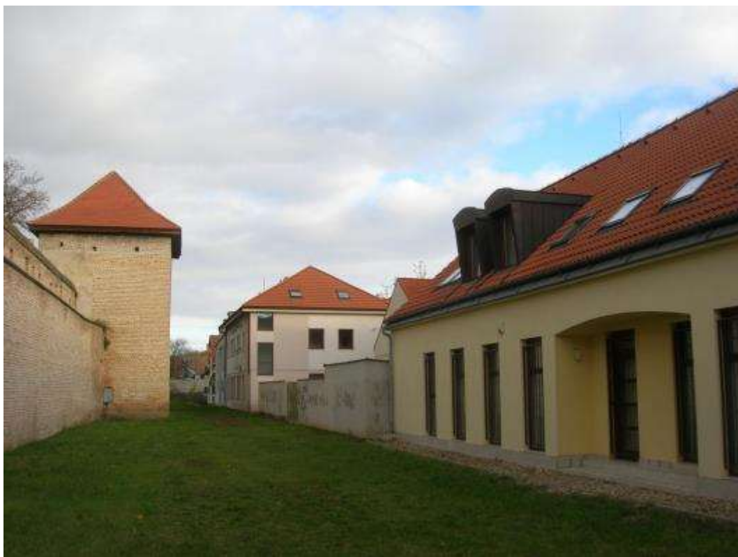
Františkánska ulica - pohľad severným smerom príhradobnou uličkou na baštu a mestské opevnenie
