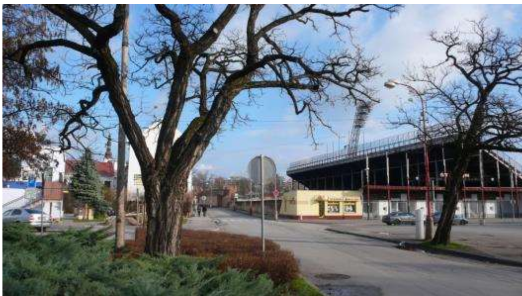
Dolné bašty - pohľad z Paulínskej
