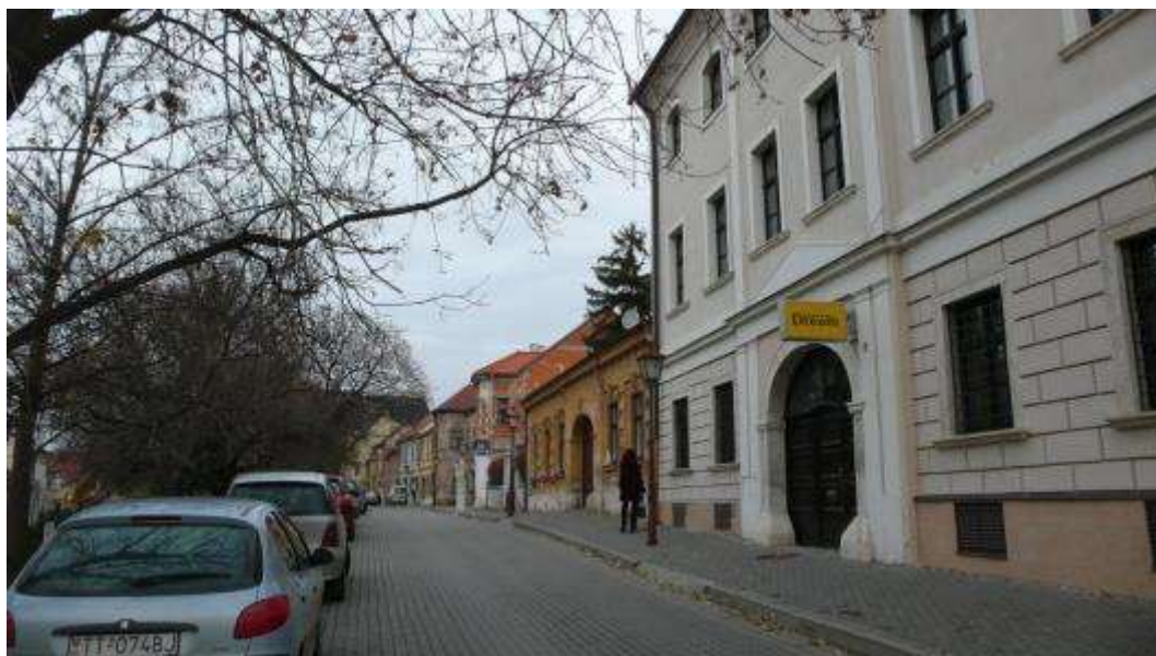
Kapitulská ulica - pohľad z juhu
