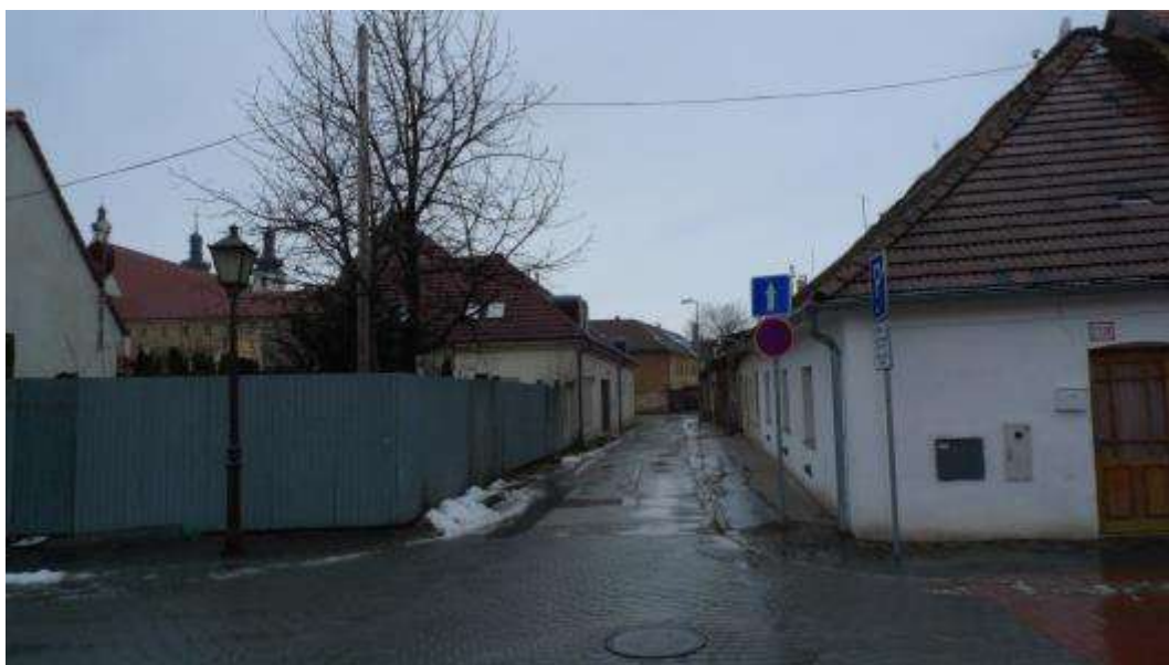
Horné bašty – pohľad západným smerom
