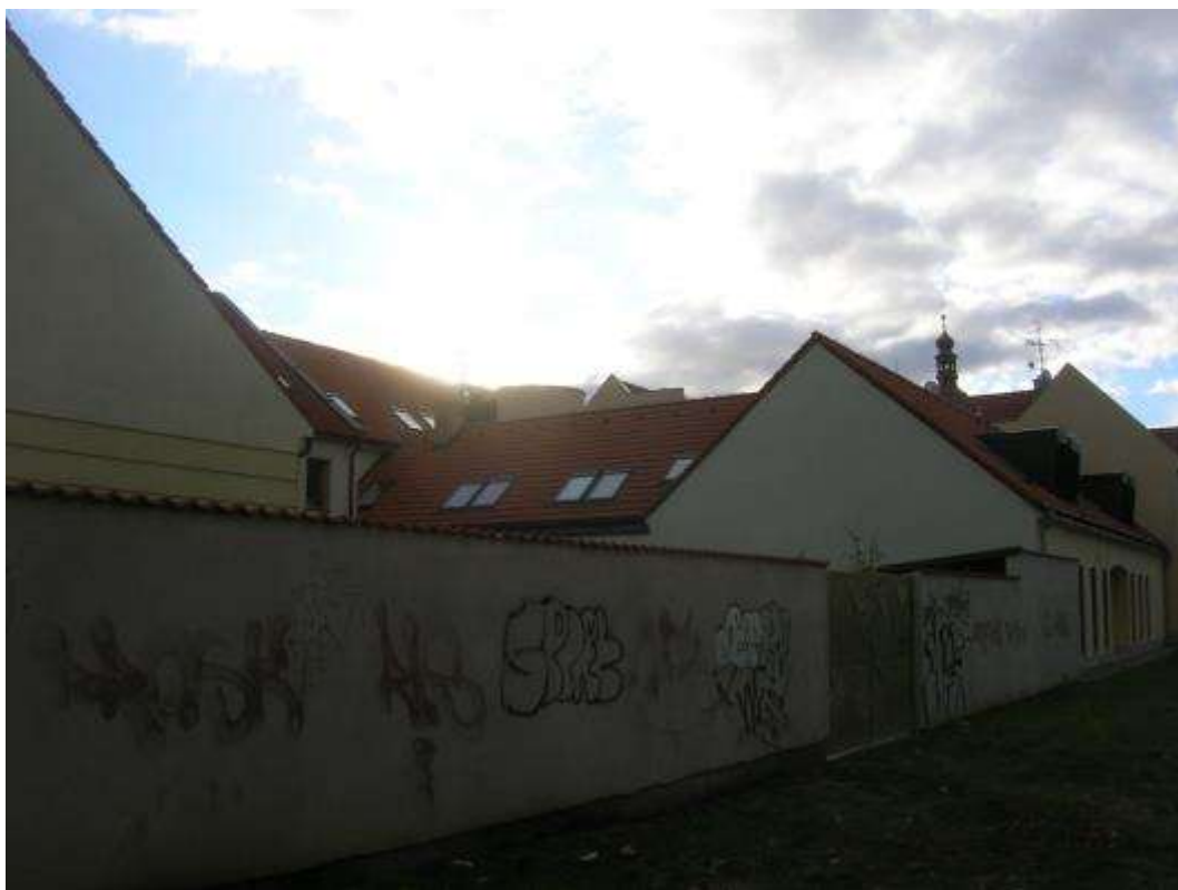
Františkánska ulica - južným smerom príhradobnou uličkou cez zadné krídla
