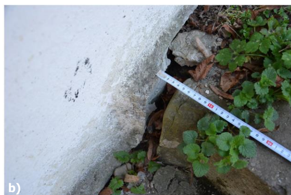
Obr. 62 Vstupné schodisko do kostola a) detail praskliny medzi schodiskovými stupňami; b) prasklina medzi schodiskovým ramenom a bočnou stenou, foto: L. Dubinyová.
