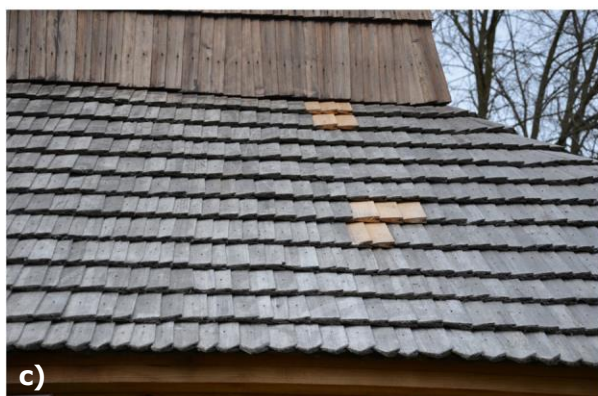
Obr. 50 a) – d) Stav strešnej drevenej krytiny a dreveného obloženia, foto: L. Dubinyová.
