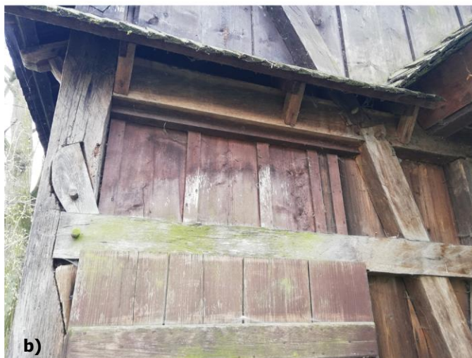
Obr. 29 a) – b) Zošednutie drevnej hmoty pôsobením vlhkosti, foto: R. Tóth.
