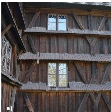
Obr. 25 Drevené strešné šindľe a) ojedinele uvoľnené; b) miestami popraskané a vypadané, foto: L. Dubinyová.
