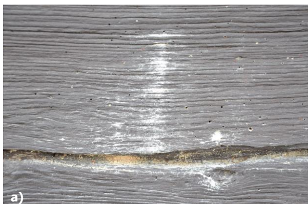
Obr. 77 a – d) Stopy po drevokaznom hmyze (výletové otvory s prachovými frakciami) na drevenom obložení chrámu, foto: L. Dubinyová.
