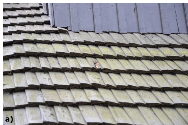
Obr. 80 Strešná krytina a) mechanicky poškodený šindel; b) popraskané šindle spodného radu, foto: L. Dubinyová.
