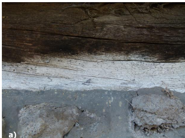
Obr. 30 a) – b) Presiakanie vlhkosti z kamenného podkladu, foto: R. Tóth
