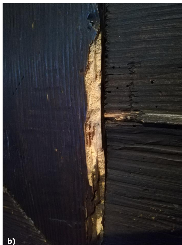
Obr. 53 a) – b) Poškodená degradovaná drevná hmota drevenej konštrukcie, foto: R. Tóth.
