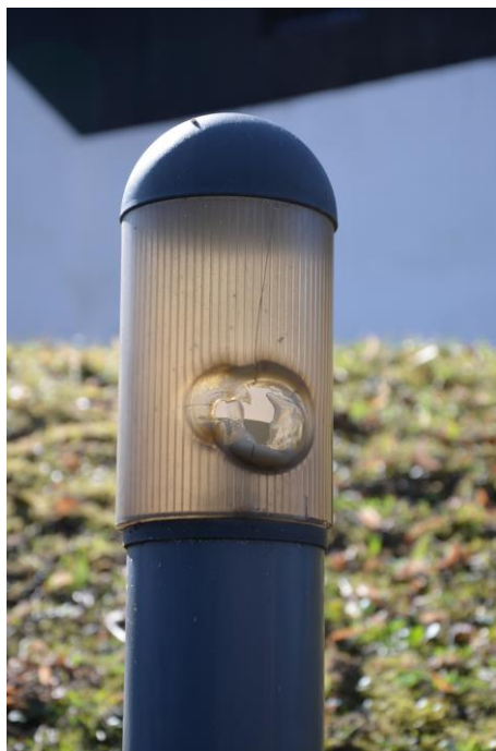
Obr. 63 Poškodené tienidlo lampy lemujúcej schody do kostola, foto: L. Dubinyová.
