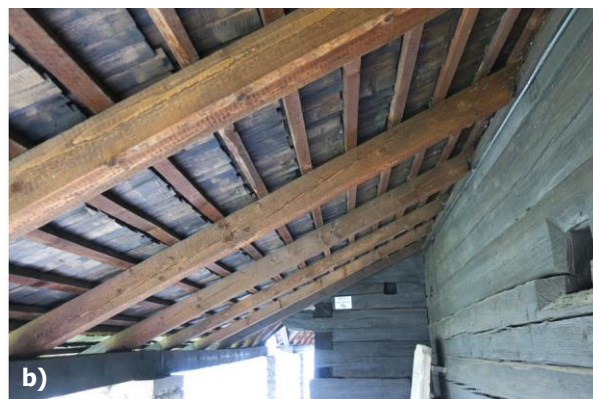
Obr. 90 a) Stopy po drevokaznom hmyze; b) spodná časť ostrešia chrániaceho zrubovú konštrukciu, foto: L. Dubinyová.
