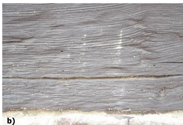
Obr. 77 a – d) Stopy po drevokaznom hmyze (výletové otvory s prachovými frakciami) na drevenom obložení chrámu, foto: L. Dubinyová.
