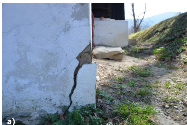
Obr. 61 a) – b) Prasklina v omietke na juhovýchodnom rohu, foto: L. Dubinyová
