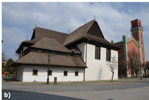
Obr. 39 Strešná krytina kostola – kompaktná a bez chýbajúcich šindľov a) pohľad na juhozápadnú stranu a b) pohľad na východnú stranu kostola, foto: L. Dubinyová.
