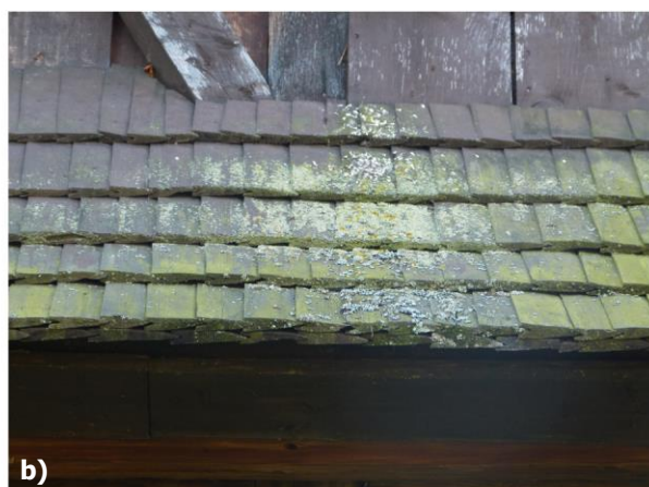
Obr. 23 a) – b) Drevená šindľová strecha je miestami obrastená nižšími rastlinami, foto: R. Tóth.
