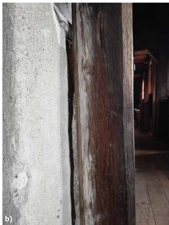
Obr. 32 a) – b) Stopy po presakujúcej vlhkosti na podporných trámových stĺpoch za kamennou menzou hlavného oltára, foto: R. Tóth.
