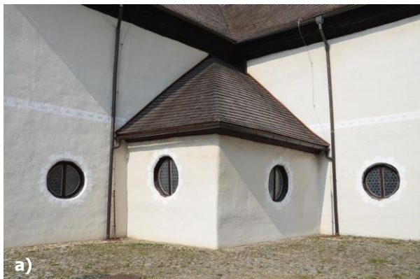
Obr. 39 Strešná krytina kostola – kompaktná a bez chýbajúcich šindľov a) pohľad na juhozápadnú stranu a b) pohľad na východnú stranu kostola, foto: L. Dubinyová.
