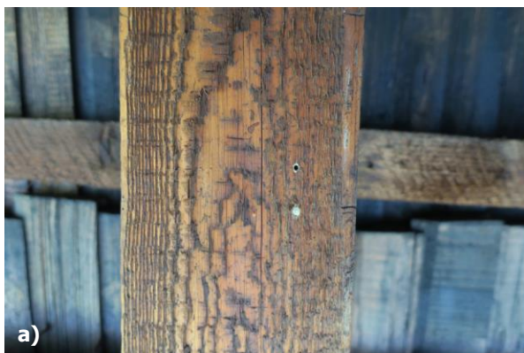
Obr. 90 a) Stopy po drevokaznom hmyze; b) spodná časť ostrešia chrániaceho zrubovú konštrukciu, foto: L. Dubinyová.
