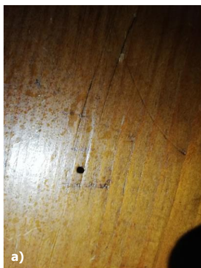
Obr. 93 a – b) Detaily výletových otvorov po drevokaznom hmyze, foto: R. Tóth.
