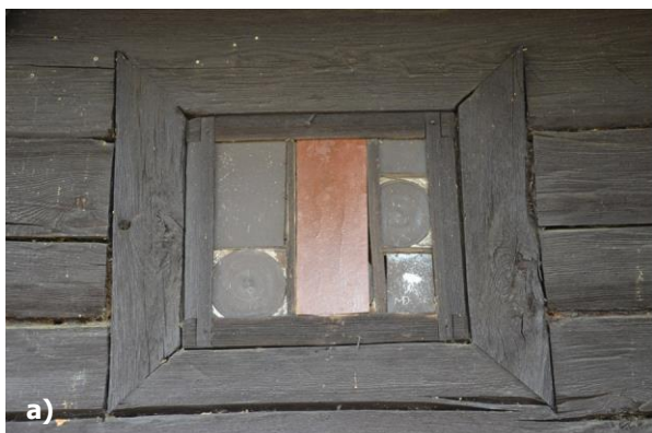
Obr. 78 Exteriér a) chýbajúca okenná výplň nahradená doskou; b) chýbajúce drevené obloženie nad oknom na severnej strane, foto: L. Dubinyová.
