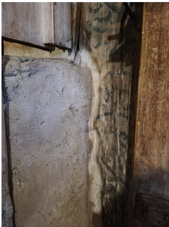
Obr. 69 Navlhávanie doskového obloženia od muriva, foto: R. Tóth.
