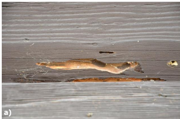
Obr. 13 a) Doskové, exteriérové obloženie kostola – stopy po drevokaznom hmyze, foto: L. Dubinyová; b) hmyz ležúci z diery v drevenom doskovom obložení, foto: R. Tóth.
