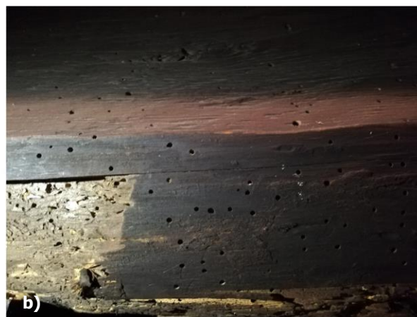
Obr. 53 a) – b) Poškodená degradovaná drevná hmota drevenej konštrukcie, foto: R. Tóth.
