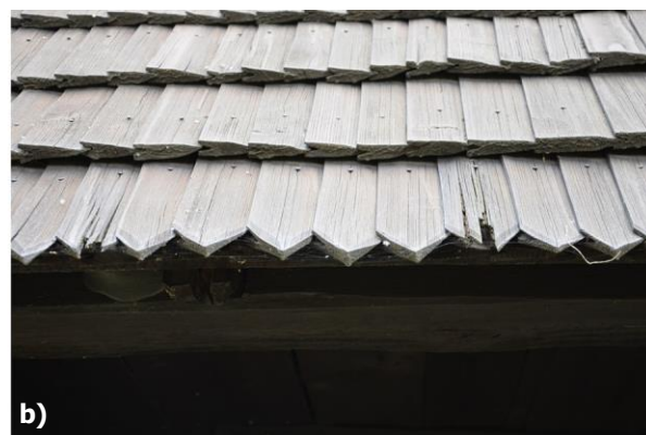
Obr. 80 Strešná krytina a) mechanicky poškodený šindel; b) popraskané šindle spodného radu, foto: L. Dubinyová.
