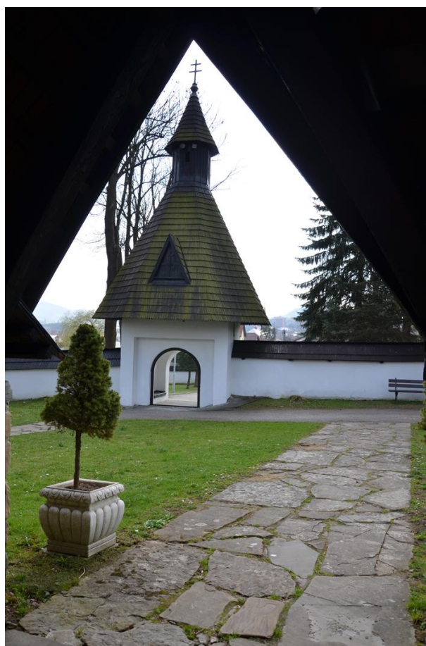
Obr. 89 Drevená šindľová strecha murovanej vstupnej brány obrastená nižšími rastlinami, foto: L. Dubinyová.
