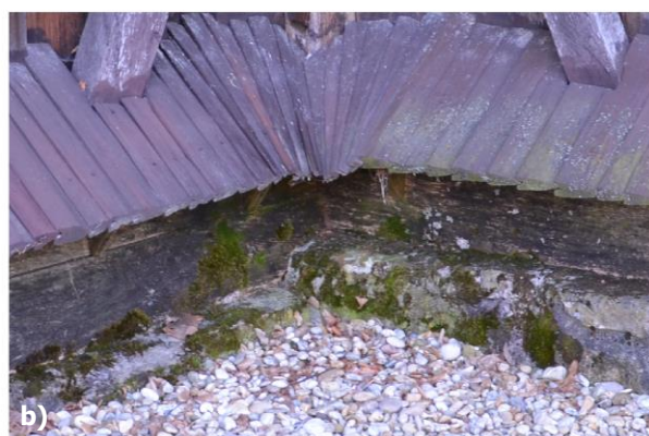
Obr. 24 Zavlhnutý roh na juhovýchodnej strane kostola – náväznosť kamenného sokla na drevenú konštrukciu a) stav v roku 2018, foto: L. Dubinyová; b) stav v roku 2019, foto: L. Dubinyová.
