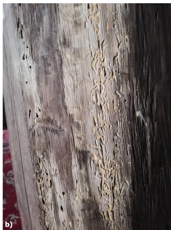
Obr. 33 a) Stopy po pôsobení drevokazného hmyzu na podpornom trámovom stĺpe napravo od hlavného oltára, foto: R. Tóth; b) Stopy po pôsobení drevokazného hmyzu na stĺpoch pri vstupe do kostola, foto: R. Tóth.
