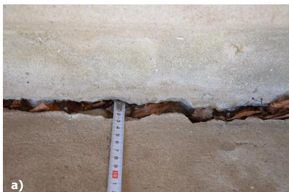
Obr. 62 Vstupné schodisko do kostola a) detail praskliny medzi schodiskovými stupňami; b) prasklina medzi schodiskovým ramenom a bočnou stenou, foto: L. Dubinyová.
