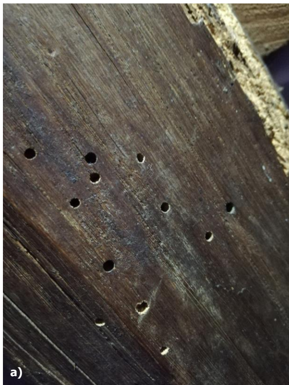
Obr. 34 a) – b) Stopy po pôsobení drevokazného hmyzu na stípoch pri vstupe do kostola, foto: R. Tóth.
