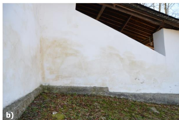
Obr. 59 a – b) Vlhkostné fľaky prenikajúce cez náter omietky ľavého múra (pohľad zo severozápadnej strany) a na vonkajšej strane schodiska, foto: L. Dubinyová.
