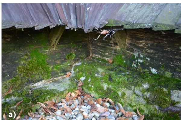
Obr. 24 Zavlhnutý roh na juhovýchodnej strane kostola – náväznosť kamenného sokla na drevenú konštrukciu a) stav v roku 2018, foto: L. Dubinyová; b) stav v roku 2019, foto: L. Dubinyová.
