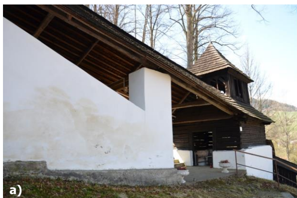
Obr. 59 a – b) Vlhkostné fľaky prenikajúce cez náter omietky ľavého múra (pohľad zo severozápadnej strany) a na vonkajšej strane schodiska, foto: L. Dubinyová.
