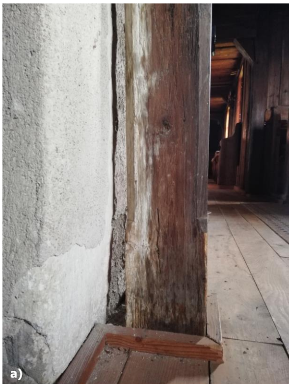
Obr. 32 a) – b) Stopy po presakujúcej vlhkosti na podporných trámových stĺpoch za kamennou menzou hlavného oltára, foto: R. Tóth.
