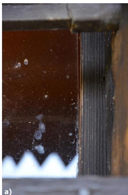
Obr. 79 a) Nedoliehajúca sklená výplň okna na južnej strane; b) degradácia dreva na zadnej strane ikonostasu, foto: L. Dubinyová.
