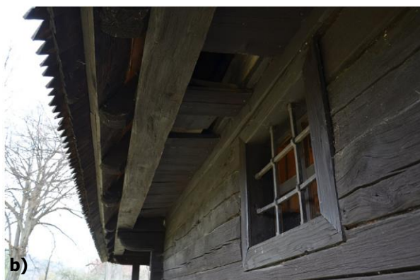
Obr. 78 Exteriér a) chýbajúca okenná výplň nahradená doskou; b) chýbajúce drevené obloženie nad oknom na severnej strane, foto: L. Dubinyová.
