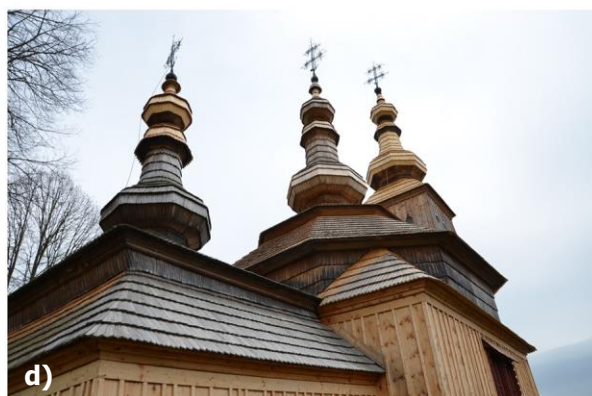
Obr. 50 a) – d) Stav strešnej drevenej krytiny a dreveného obloženia, foto: L. Dubinyová.
