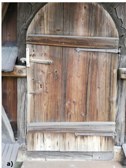
Obr. 29 a) – b) Zošednutie drevnej hmoty pôsobením vlhkosti, foto: R. Tóth.
