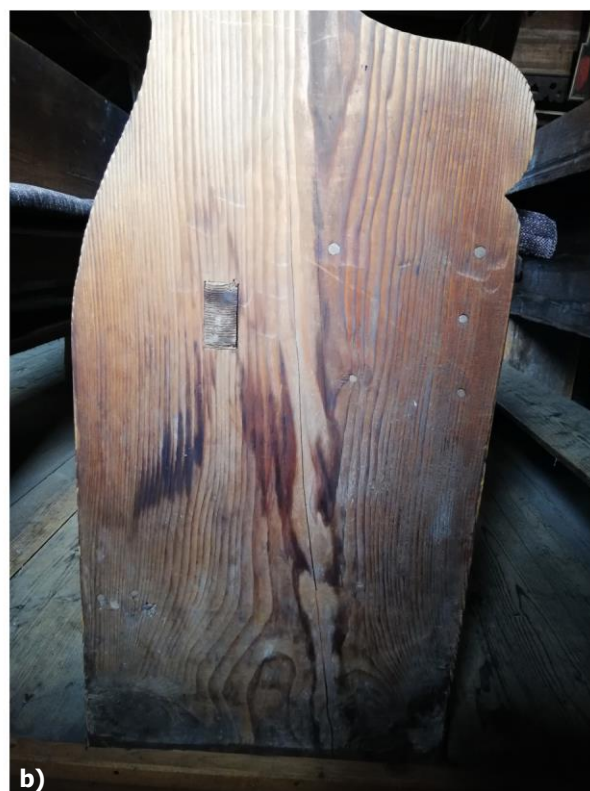
Obr. 35 a) – b) Vlhkostné pôsobenie na drevených laviciach, foto: R. Tóth.
