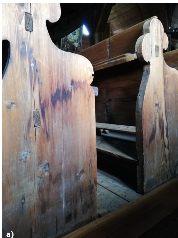
Obr. 35 a) – b) Vlhkostné pôsobenie na drevených laviciach, foto: R. Tóth.
