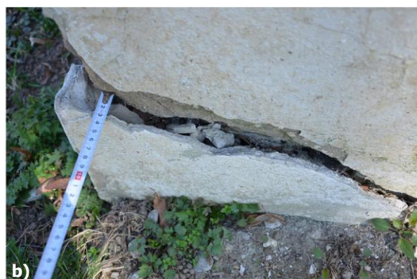
Obr. 61 a) – b) Prasklina v omietke na juhovýchodnom rohu, foto: L. Dubinyová
