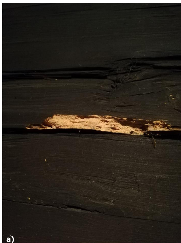
Obr. 53 a) – b) Poškodená degradovaná drevná hmota drevenej konštrukcie, foto: R. Tóth.
