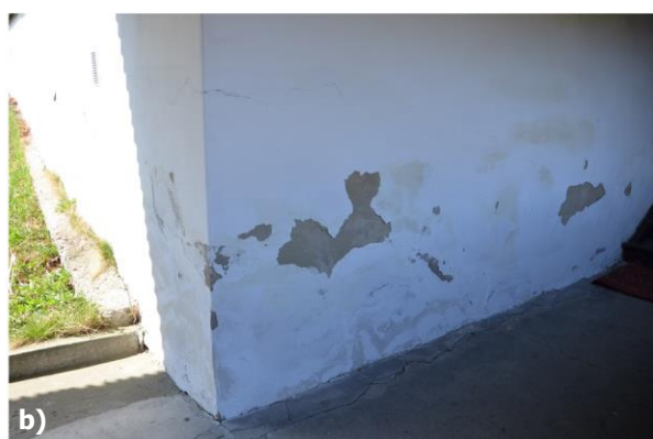
Obr. 60 Opadaná omietka a) na východnej strane kostola; b) na severnej strane kostola, foto: L. Dubinyová.
