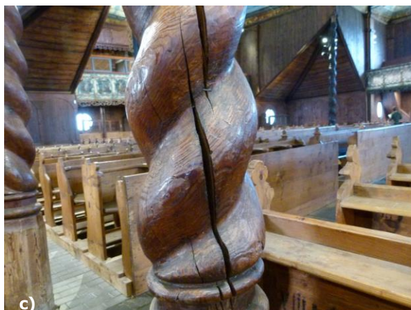
Obr. 45 a) – b) Tordované nosné stĺpy pod chórmí s vertikálnymi prasklinami po celom svojom obvode, foto: R. Tóth.
