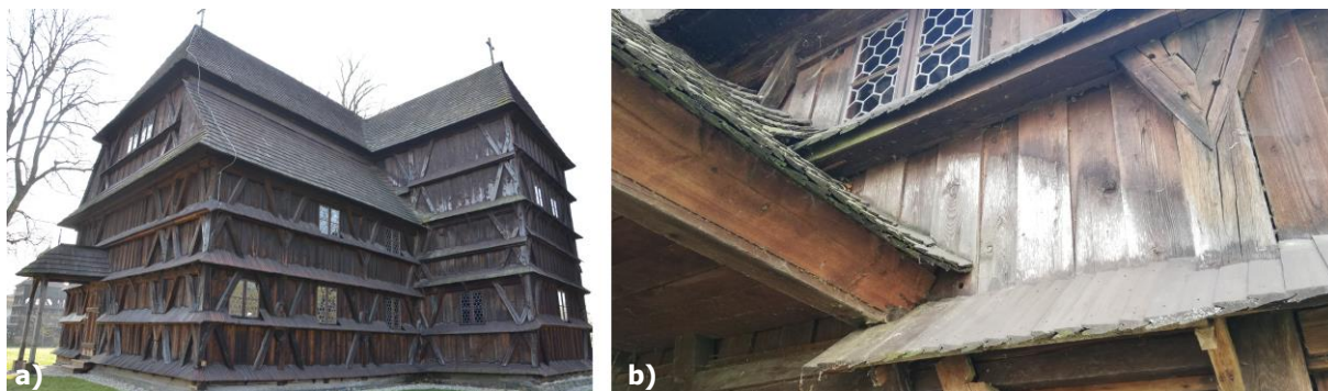
Obr. 22 a) Zošednutie šikmých trámov, foto: L. Dubinyová b) Zošednutie zvislých dosiek, foto: R. Tóth.
