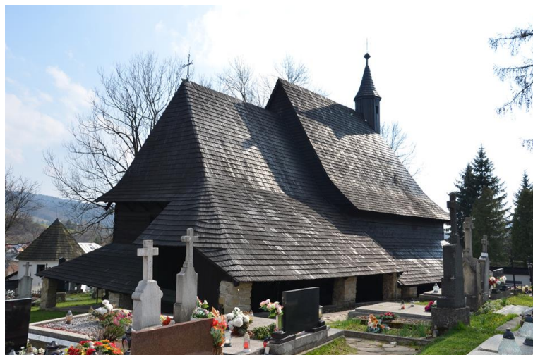
Obr. 88 Severná strana kostola, šindle strešnej krytiny sú zošednuté vplyvom slnečného žiarenia, foto: L. Dubinyová.
