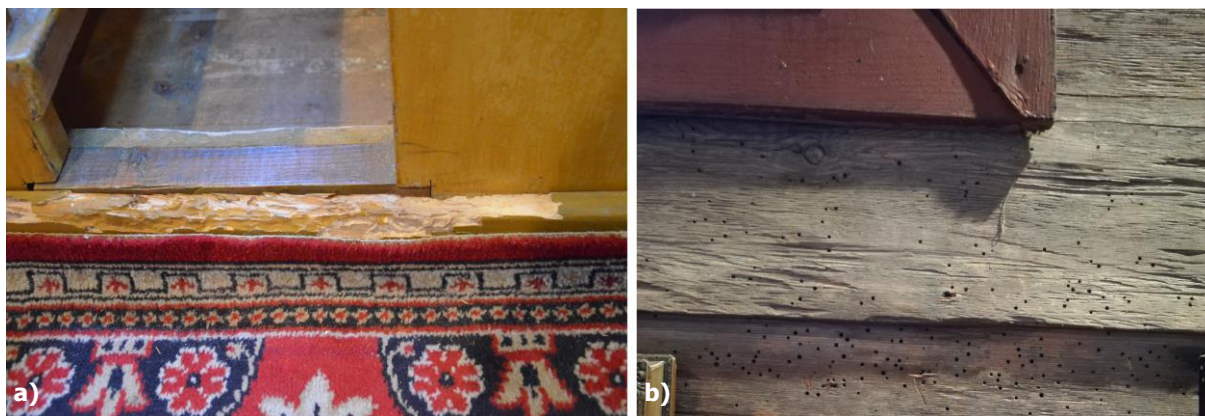
Obr. 6 a) Lišty lavíc – mechanicky poškodená drevná hmota, foto: L. Dubinyová; b) drevené obloženie interiéru pod pravým oknom (smerom k dverám chrámu) s výletovými otvormi po drevokaznom hmyze, foto: R. Tóth.
