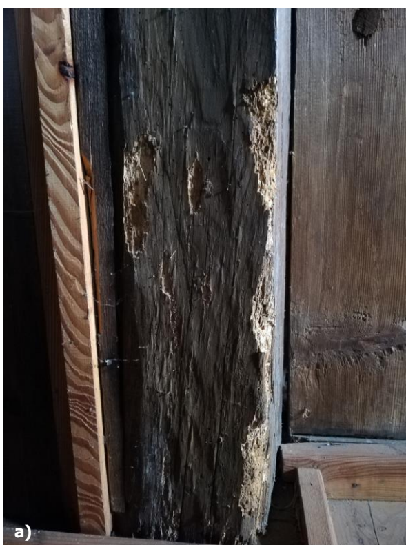
Obr. 33 a) Stopy po pôsobení drevokazného hmyzu na podpornom trámovom stĺpe napravo od hlavného oltára, foto: R. Tóth; b) Stopy po pôsobení drevokazného hmyzu na stĺpoch pri vstupe do kostola, foto: R. Tóth.
