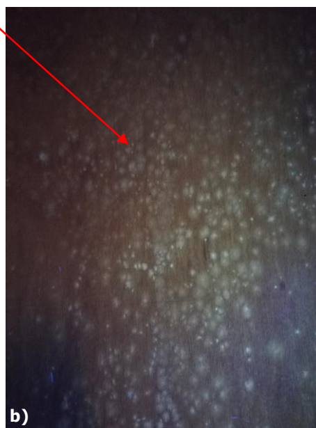
Obr. 17 Hlavný oltár napadnutý aktívnou plesňou, kontrola plesní UV lampou, a) predná strana krídla oltára, b) zadná strana krídla oltára foto: R. Tóth.
