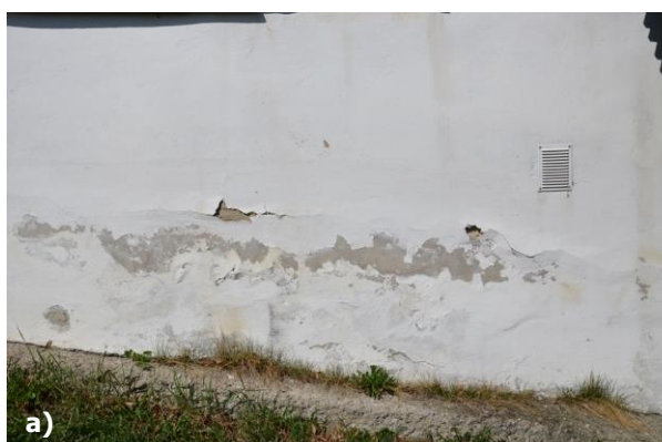
Obr. 60 Opadaná omietka a) na východnej strane kostola; b) na severnej strane kostola, foto: L. Dubinyová.
