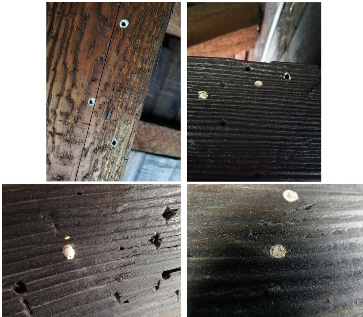
Obr. 96 Výletové otvory miestami prekryté bielym povlakom, foto: R. Tóth.
