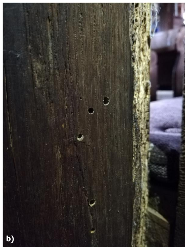
Obr. 34 a) – b) Stopy po pôsobení drevokazného hmyzu na stípoch pri vstupe do kostola, foto: R. Tóth.
