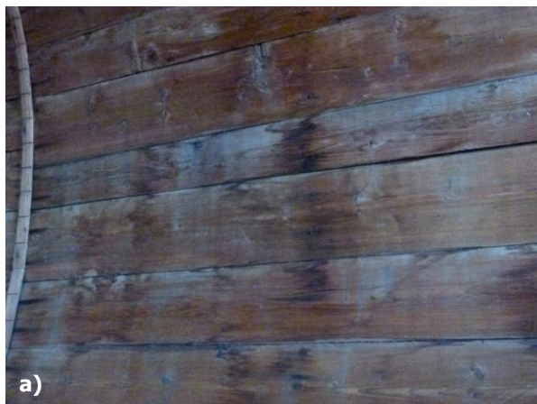
Obr. 36 a) – b) Vlhkostné pôsobenie na drevených klenbách, foto: R. Tóth.
