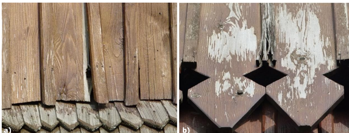
Obr. 4 a) Nedoliehajúce lišty vertikálneho doskového obloženia; b) rozpadnutá lišta ozdobného nákončia vertikálneho doskového obloženia, foto: R. Tóth.
