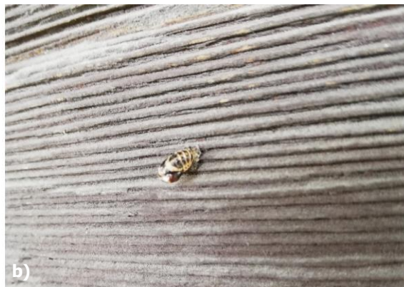
Obr. 13 a) Doskové, exteriérové obloženie kostola – stopy po drevokaznom hmyze, foto: L. Dubinyová; b) hmyz ležúci z diery v drevenom doskovom obložení, foto: R. Tóth.
