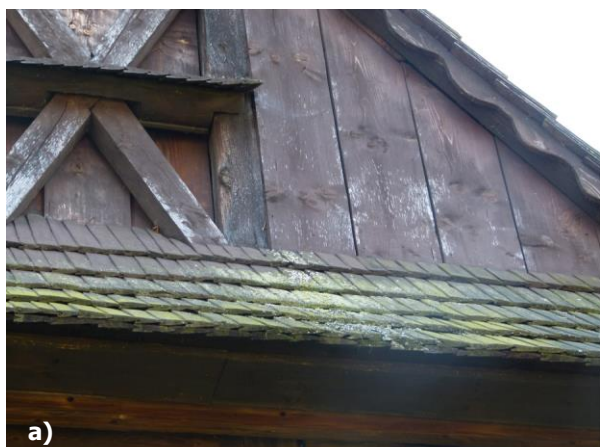
Obr. 23 a) – b) Drevená šindľová strecha je miestami obrastená nižšími rastlinami, foto: R. Tóth.
