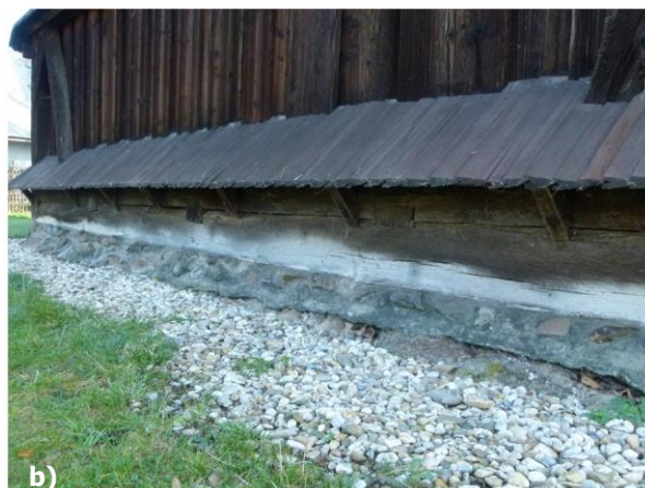
Obr. 30 a) – b) Presiakanie vlhkosti z kamenného podkladu, foto: R. Tóth
