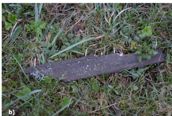
Obr. 25 Drevené strešné šindľe a) ojedinele uvoľnené; b) miestami popraskané a vypadané, foto: L. Dubinyová.
