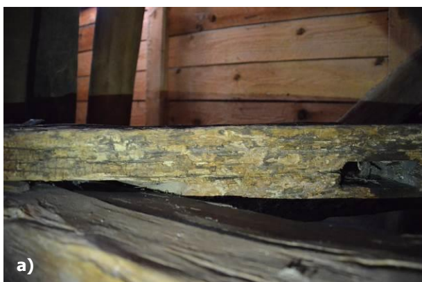
Obr. 76 a) Degradovaný trám v podveží; b) pravdepodobný výskyt plesní na pravej strane lavice a drevenom obložení v babinci, foto: L. Dubinyová.
