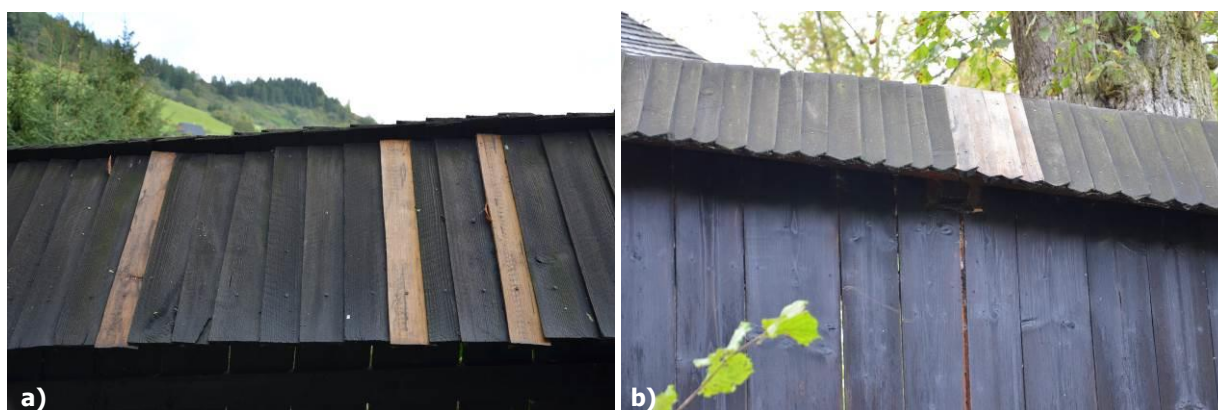
Obr. 63 Kostol je obohnaný múrom s drevenou šindľovou strieškou a – b) chýbajúce drevené šindle boli nahradené novými, foto: L. Dubinyová.
