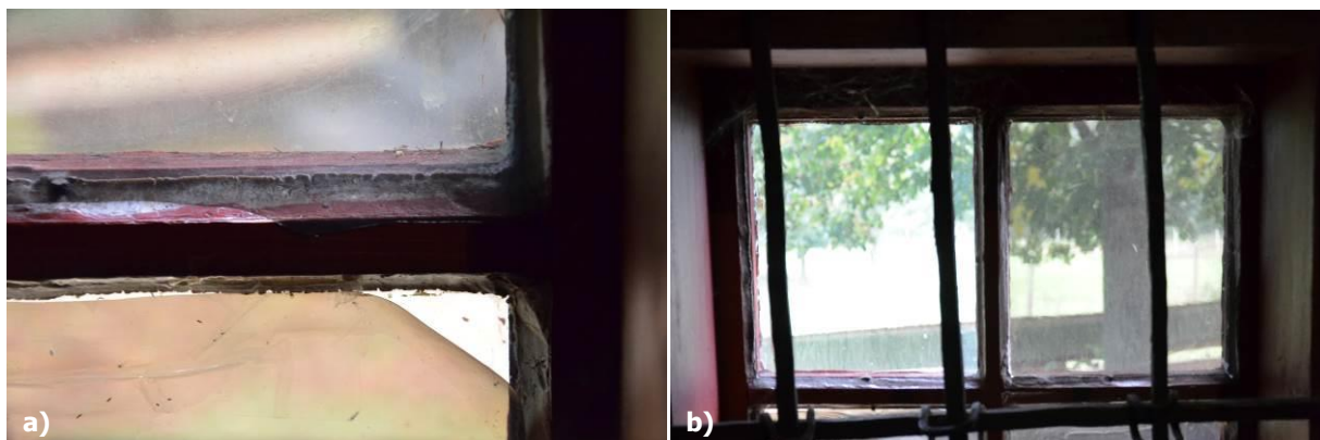
Obr. 51 Ochranná UV fólia a) odlepujúca sa od sklenenej výplne okna; b) chýbajúca UV fólia na ľavej okennej tabuli, foto: L. Dubinyová.
