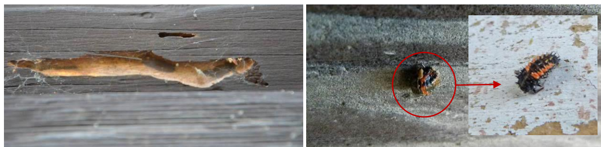
Obr. 15 a) Doskové, exteriérové obloženie kostola – stopy po drevokaznom hmyze, foto: L. Dubinyová; b) chrobák zavŕtavajúci sa do dreveného doskového obloženia, foto: R. Tóth.
