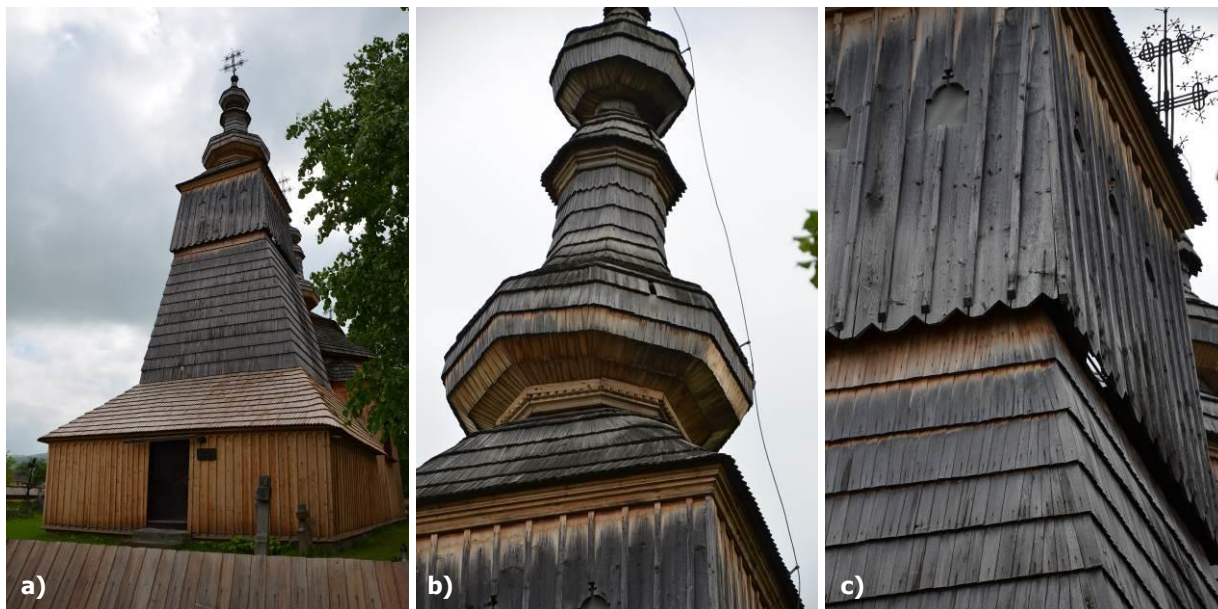
Obr. 45 a – c) Stav strešnej drevenej krytiny a dreveného obloženia, máj 2016, foto: L. Dubinyová.
