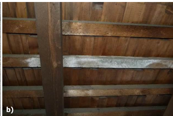
Obr. 84 a) Stopy po drevokaznom hmyze, foto: L. Dubinyová; b) spodná časť ostrešia chrániaceho zrubovú konštrukciu – trám pokrytý pravdepodobne bielou plesňou, foto: R. Tóth.
