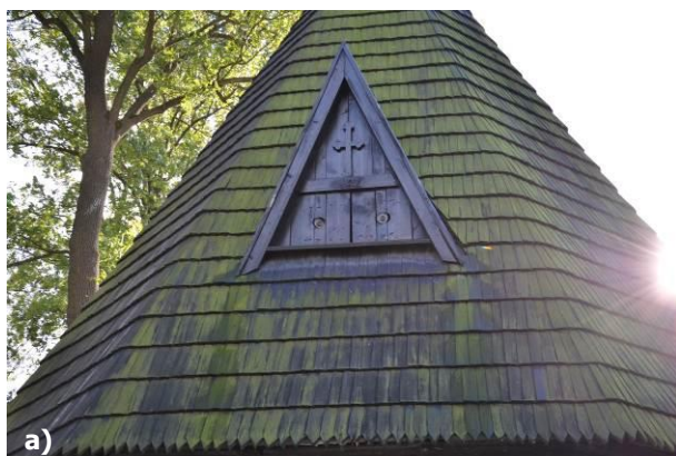
Obr. 83 Drevená šindľová strecha a) murovaná vstupná brána obrastená nižšími rastlinami; b) múru ohraničujúceho areál je pokrytá machom a nižšími rastlinami, foto: L. Dubinyová.
