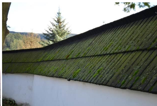
Obr. 83 Drevená šindľová strecha a) murovaná vstupná brána obrastená nižšími rastlinami; b) múru ohraničujúceho areál je pokrytá machom a nižšími rastlinami, foto: L. Dubinyová.
