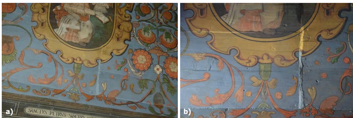
Obr. 89 a) Stropné doskové obloženie s maľovanou výzdobou, foto: R. Tóth, b) detail odskoku dreveného stropného doskového obloženia s maľovanou výzdobou, foto: L. Dubinyová.
