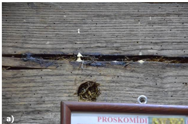
Obr. 75 Stopy po drevokaznom hmyze (výletové otvory s prachovými frakciami) na drevenom obložení chrámu v interiéri cerkvi a) drevené obloženie v presbytériu; b) drevené obloženie na zadnej stene ikonostasu, foto: L. Dubinyová.
