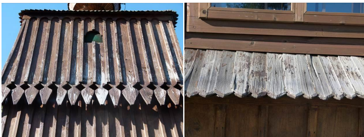
Obr. 4 a) Odlomené drevo z ozdobného nákončia vertikálneho doskového obloženia; b) vyblednuté a popraskané strešné šindle pod oknami, foto: R. Tóth.
