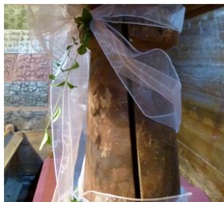
Obr. 17 a) Doskové obloženie v interiéri kostola – ojedinele výletové otvory po drevokaznom hmyze, foto: L. Dubinyová; b) prasknutý drevený nosný stĺp chóru, foto: R. Tóth.
