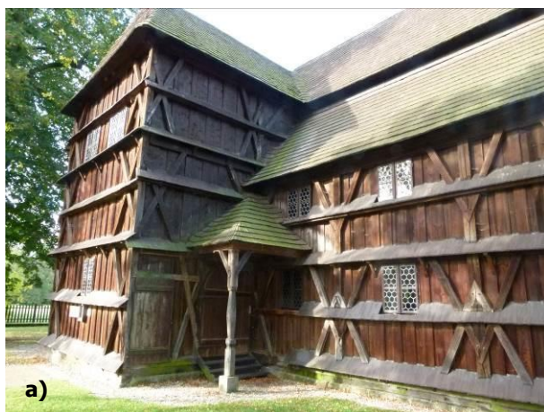
Obr. 26 a – b) Drevená šindľová strecha je miestami obrastená nižšími rastlinami, foto: R. Tóth.
