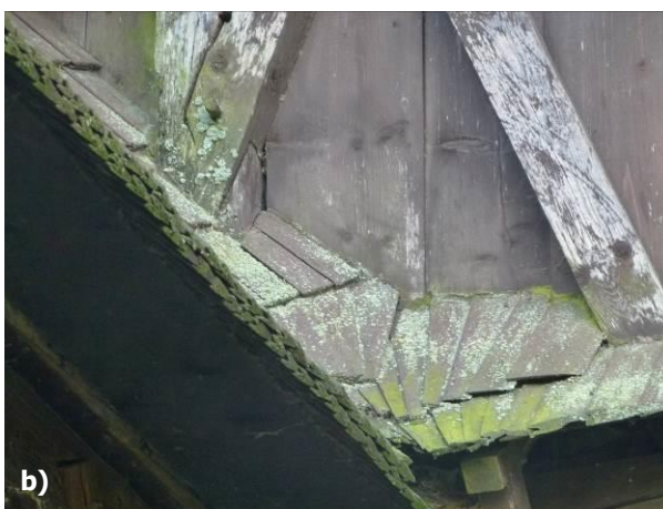
Obr. 26 a – b) Drevená šindľová strecha je miestami obrastená nižšími rastlinami, foto: R. Tóth.
