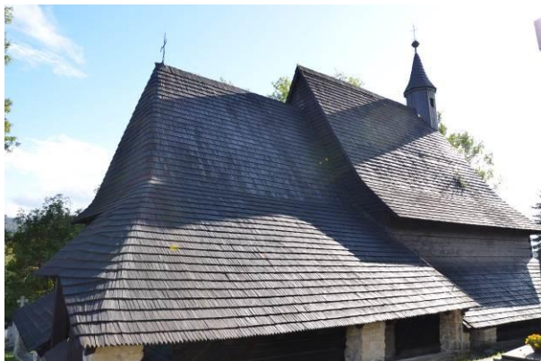
Obr. 82 Severná strana kostola, šindle strešnej krytiny sú zošednuté vplyvom slnečného žiarenia, foto: L. Dubinyová.
