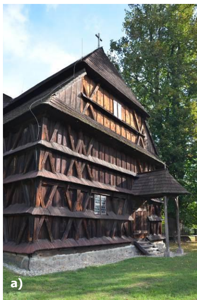
Obr. 25 a – b) Šikmé trámy a čiastočne aj zvislé dosky sú vizuálne zošednuté, foto: L. Dubinyová.
