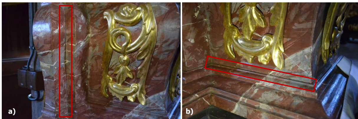
Obr. 32 a – b) Drobné praskliny na drieku stĺpa na hlavnom oltári, foto: L. Dubinyová.
