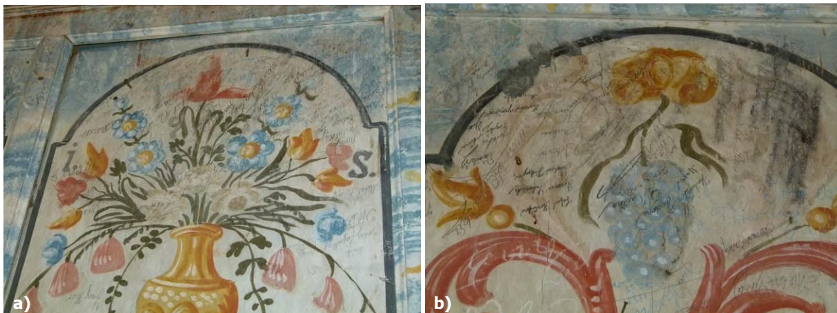
Obr. 70 a – b) Poškodenie drevenej kazetovej výzdoby chóru, foto: R. Tóth.
