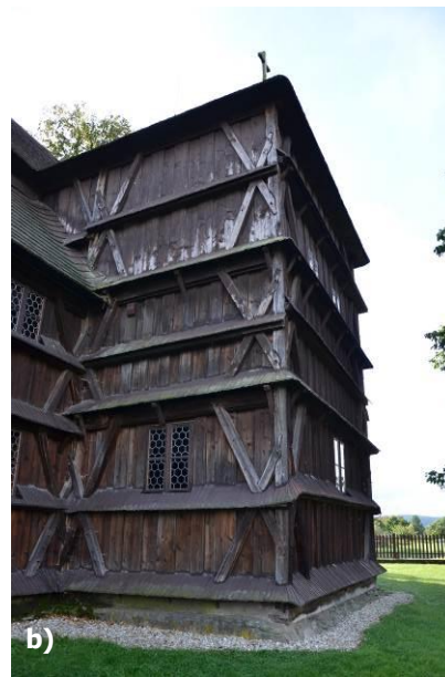
Obr. 25 a – b) Šikmé trámy a čiastočne aj zvislé dosky sú vizuálne zošednuté, foto: L. Dubinyová.
