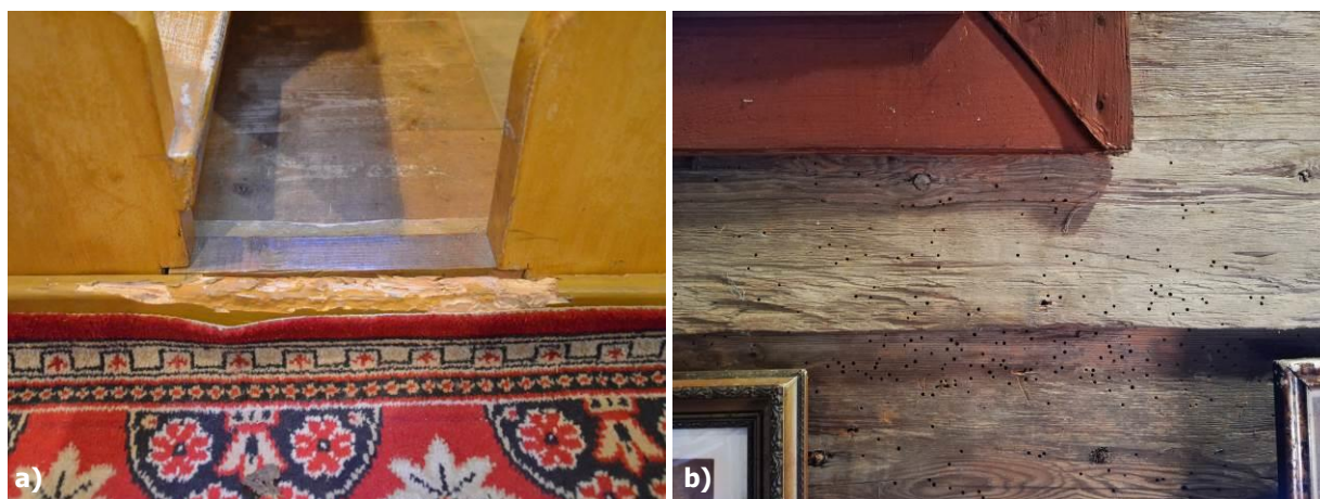
Obr. 6 a) Lišty lavíc – mechanicky poškodená drevná hmota, foto: L. Dubinyová; b) drevené obloženie interiéru pod pravým oknom (smerom k dverám chrámu) s výletovými otvormi po drevokaznom hmyze, foto: R. Tóth.
