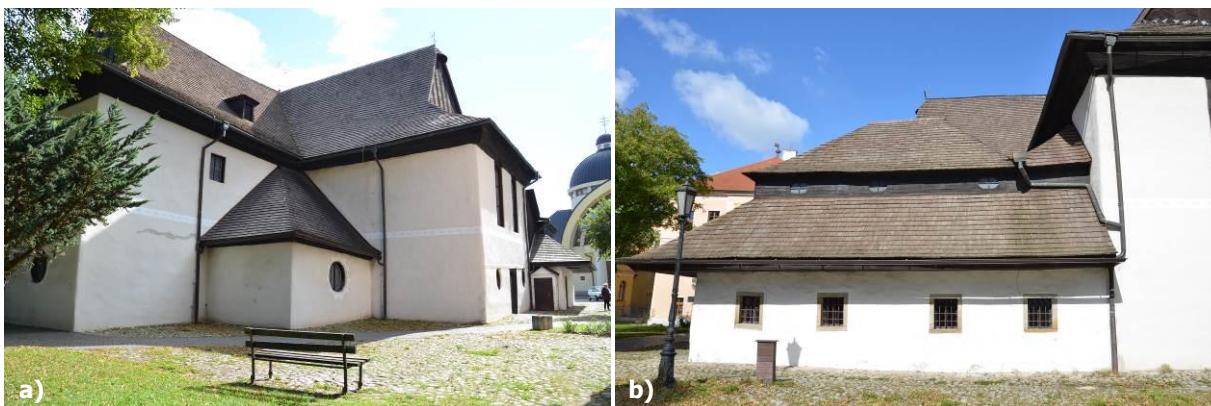
Obr. 35 Strešná krytina kostola – kompaktná a bez chýbajúcich šindľov a) pohľad na juhozápadnú stranu a b) pohľad na východnú stranu kostola, foto: L. Dubinyová.
