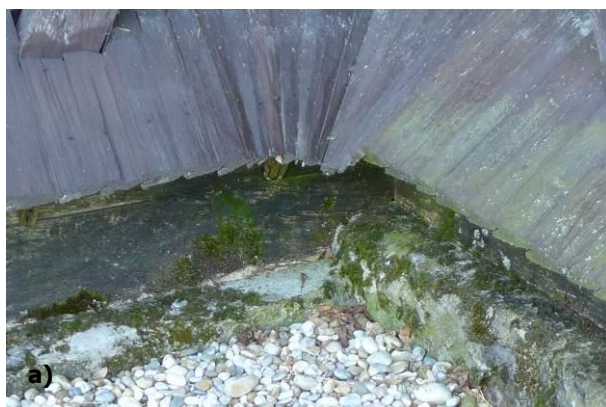
Obr. 27 Zavlhnutý roh na juhovýchodnej strane kostola – náväznosť kamenného sokla na drevenú konštrukciu a) stav v roku 2017, foto: E. Rudinská; b) stav v roku 2018, foto: L. Dubinyová.
