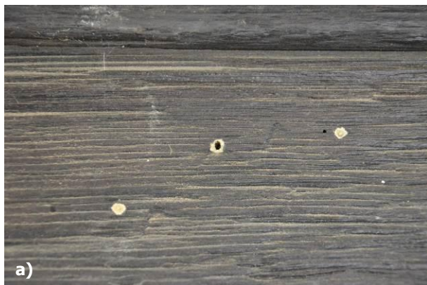
Obr. 84 a) Stopy po drevokaznom hmyze, foto: L. Dubinyová; b) spodná časť ostrešia chrániaceho zrubovú konštrukciu – trám pokrytý pravdepodobne bielou plesňou, foto: R. Tóth.
