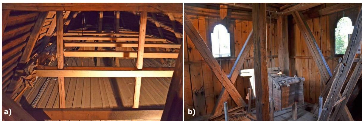
Obr. 22 a) Podkrovie lodi kostola; b) interiér drevenej veže – zvonice, foto: L. Dubinyová.
