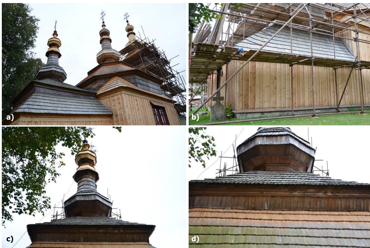
Obr. 46 a – d) Údržba šindľovej strechy, september 2018, foto: L. Dubinyová.
