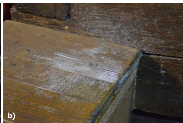
Obr. 76 a) Degradovaný trám v podveží; b) pravdepodobný výskyt plesní na pravej strane lavice a drevenom obložení v babinci, foto: L. Dubinyová.
