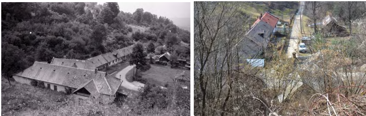
Robotníckej kolónie okolo portálu šachty Štefánikova
