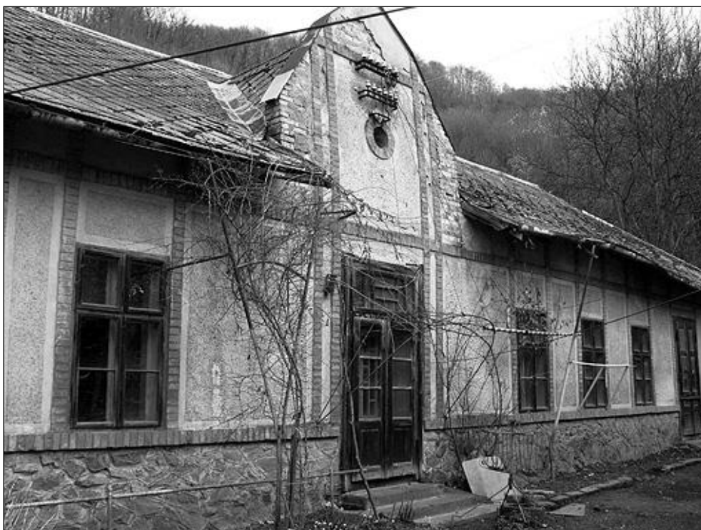
Prevádzková budova v areáli štôlne Štefánik, priečelie budovy- západná fasáda v r.2006, Šulcová 2011
