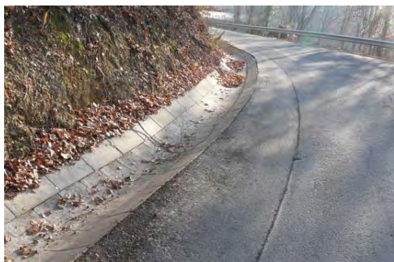
Odvodňovacie žľaby a rigoly
