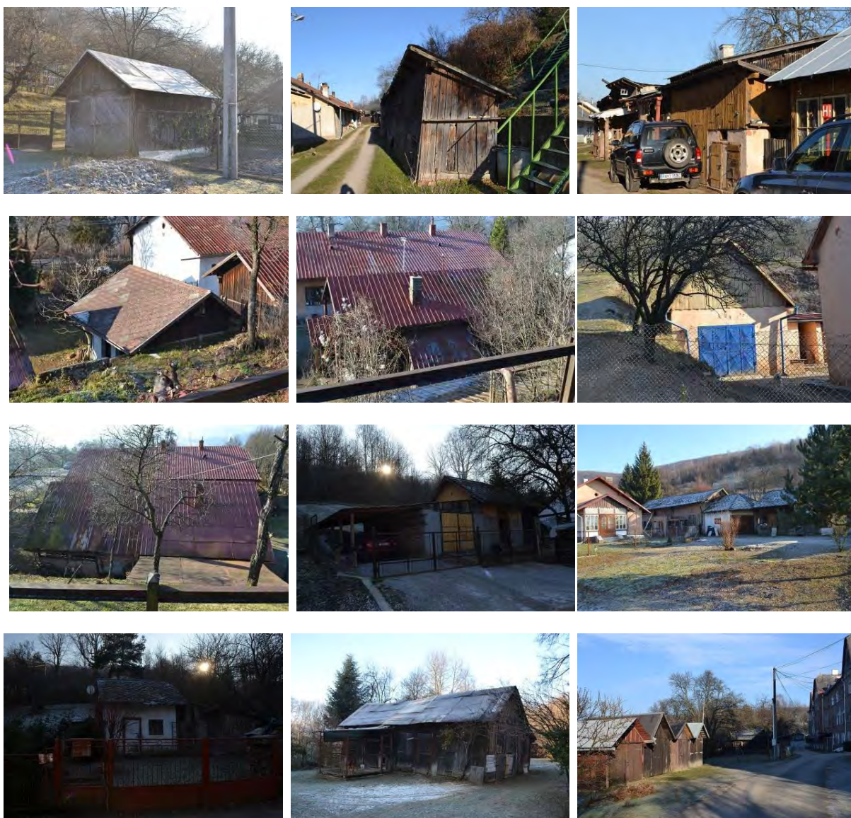
Príklady hospodárskych budov v robotníckych kolóniách k. ú. Sirk
