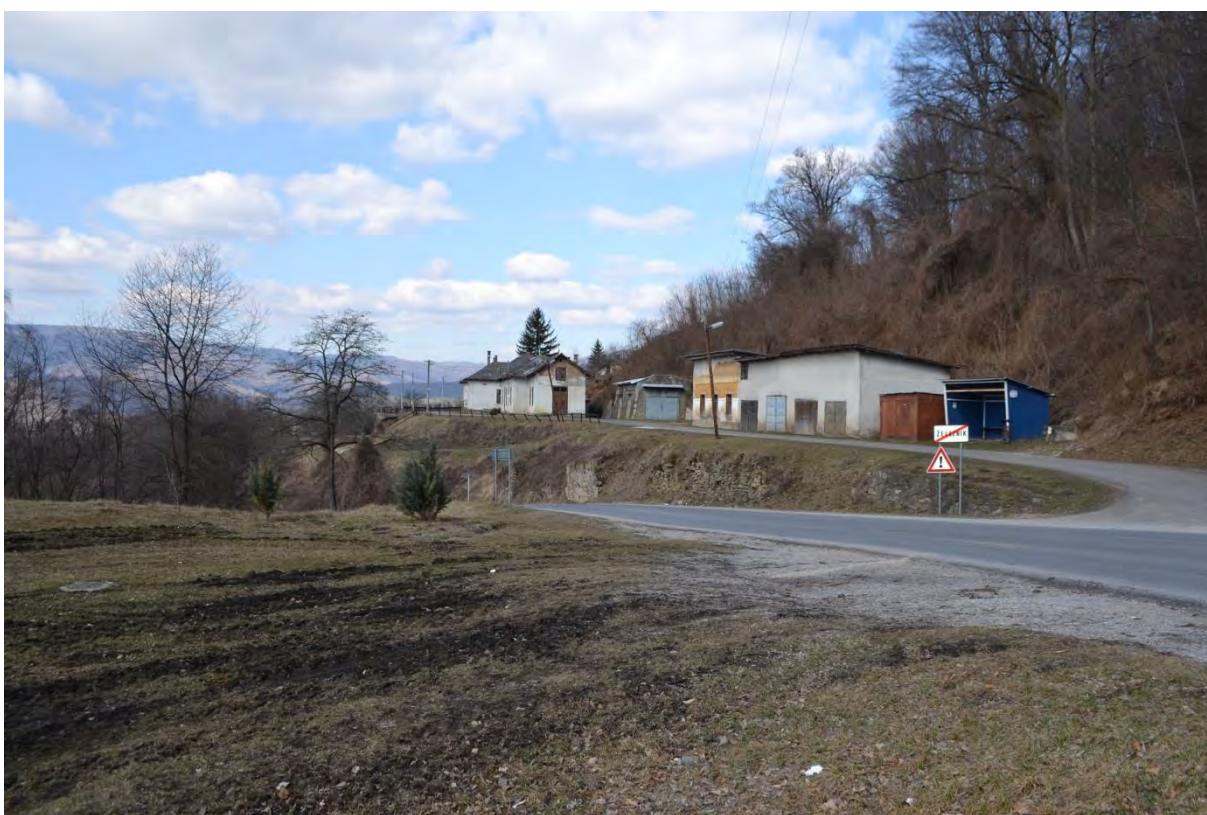
B. pohľad severným smerom na súbor NKP okolo dedičnej štôlne Ladislav a na miestnu komunikáciu ku hornej a dolnej kolónii Ladislav – južný okraj pamiatkového územia (komunikácia)
