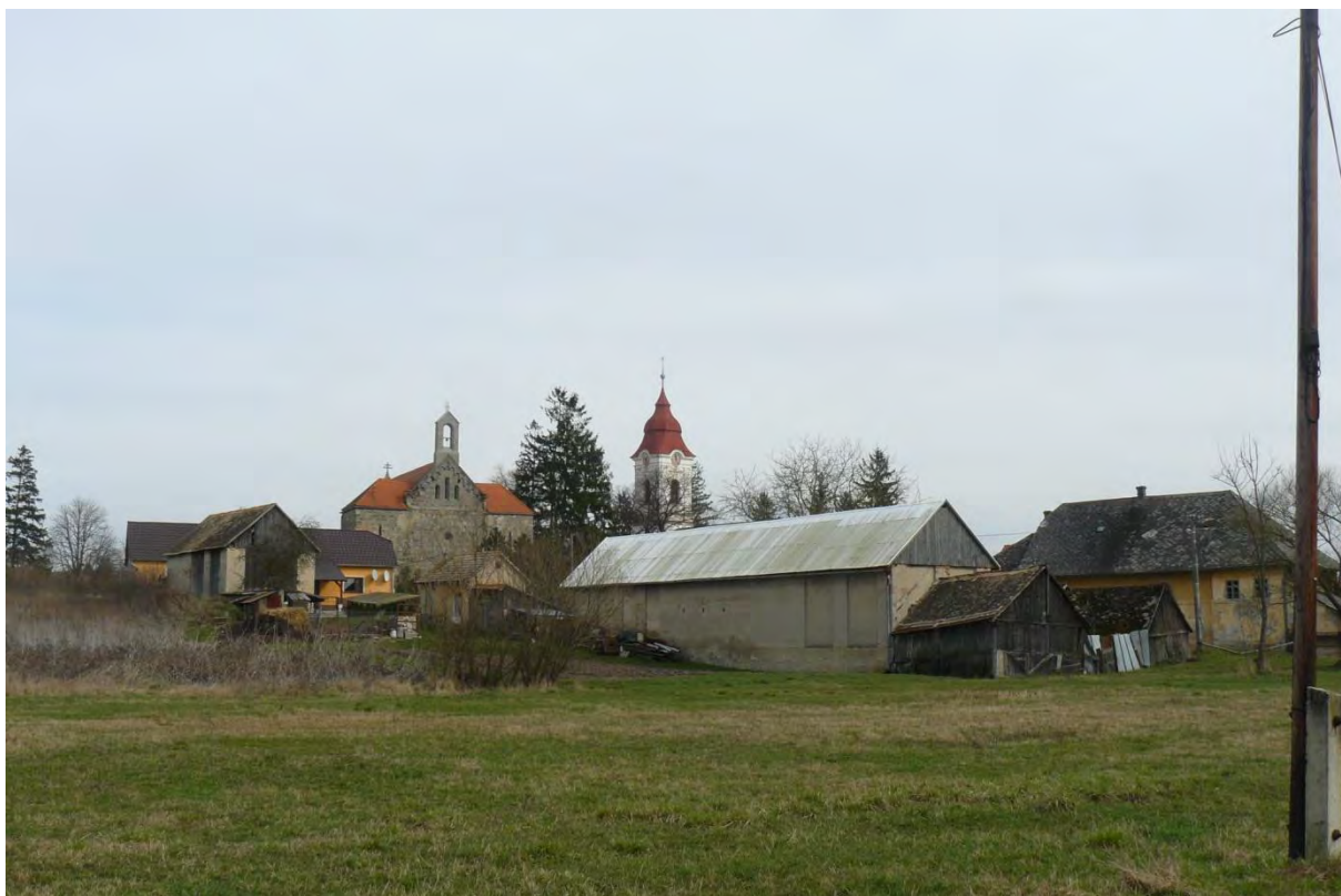
A. pohľad juhovýchodným smerom na objekty r. k. kostola sv. Jána Krstiteľa, reformovaného kostola a mlyna v západnom okraji pamiatkového územia
