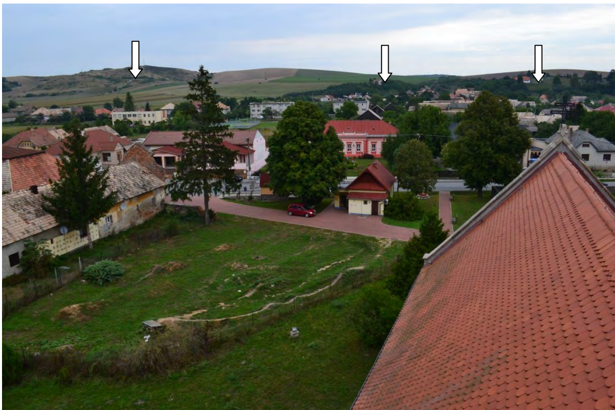
b. pohľad severovýchodným smerom (vyznačenie pozície fotenia pohľadov č. V, IV, III - z ľava doprava)
