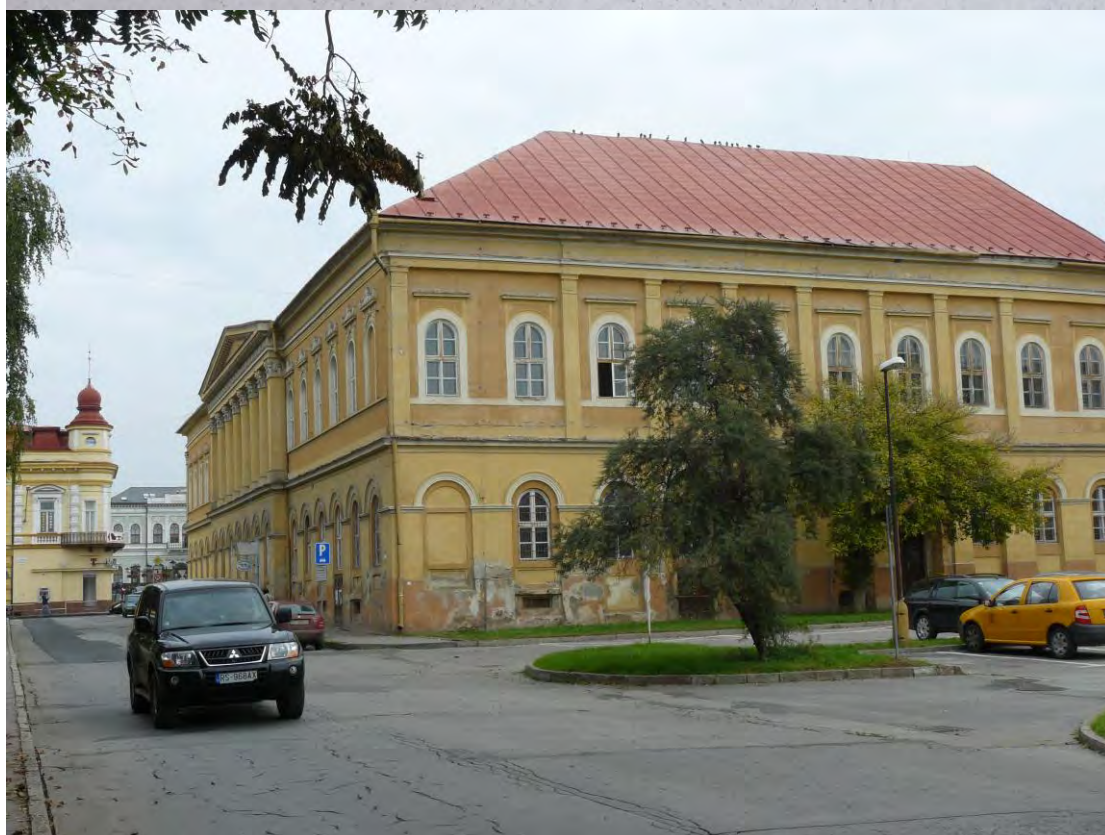
Na pravej strane budova „Reduty“, teraz „Stredná odborná škola obchodu a služieb“
