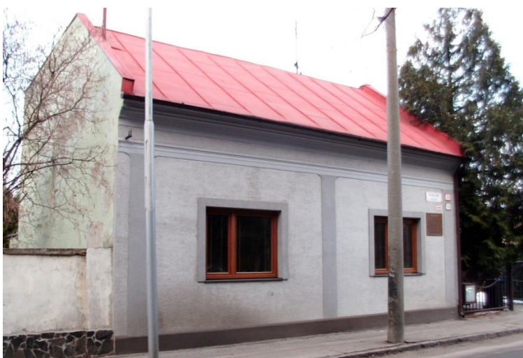
pohľad na štítovú stenu a uličnú fasádu
