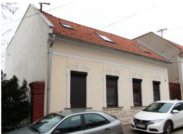
pohľad na štítovú stenu a uličnú fasádu
