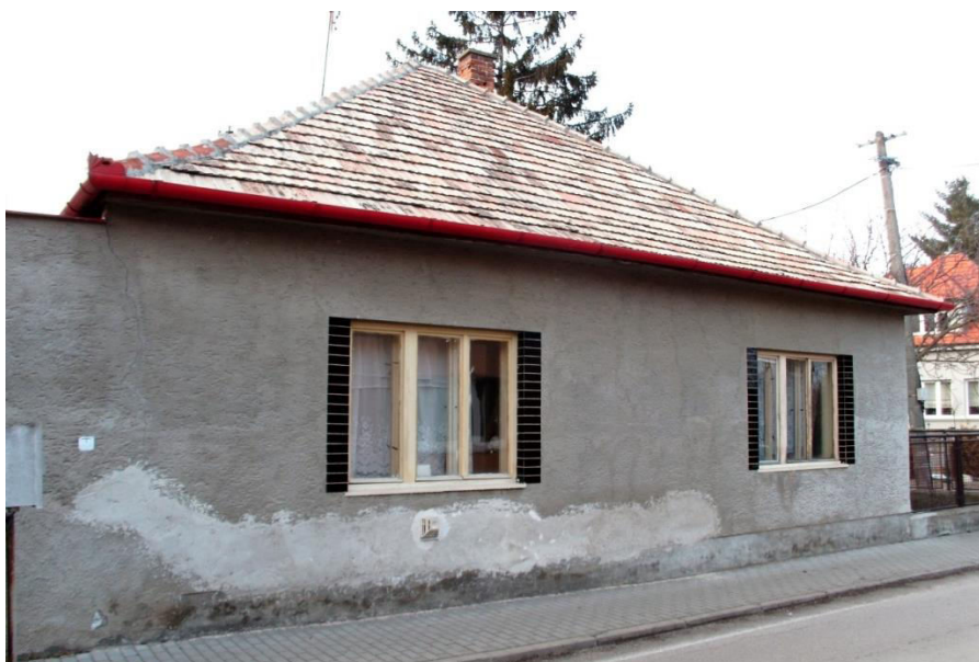
pohľad na uličnú fasádu z Jaskyňovej ulice
