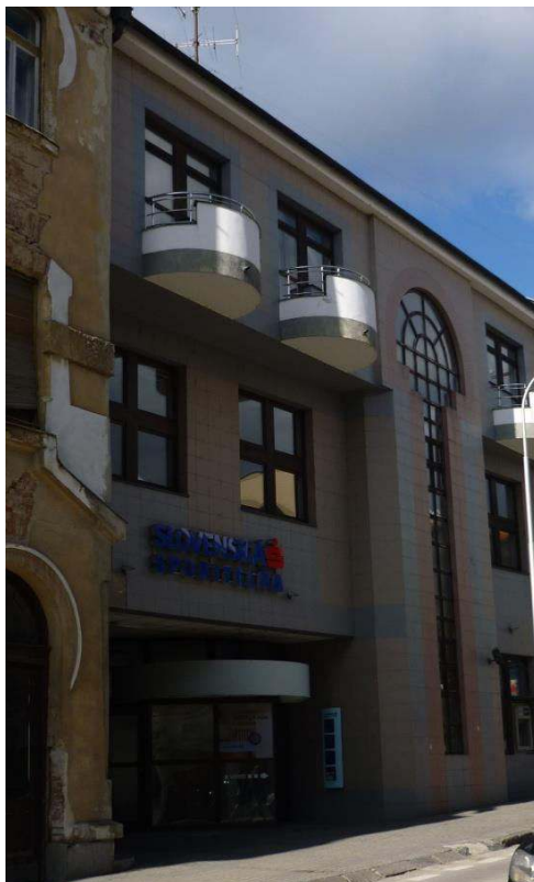
pohľad na priečelie budovy
