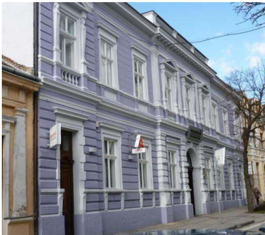
pohľad na nárožie budovy
