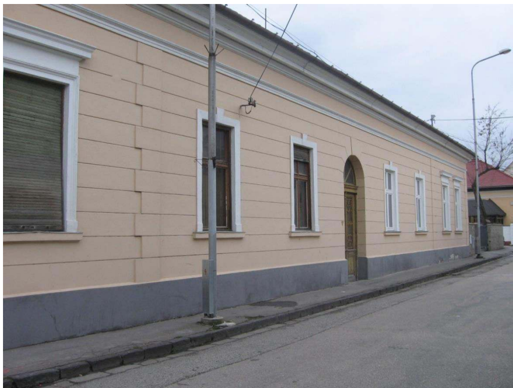
pohľad na priečelie budovy
