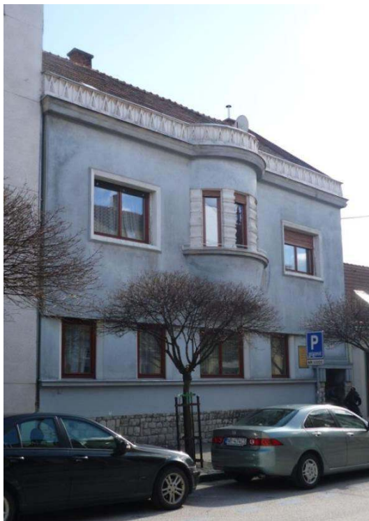
pohľad na priečelie budovy
