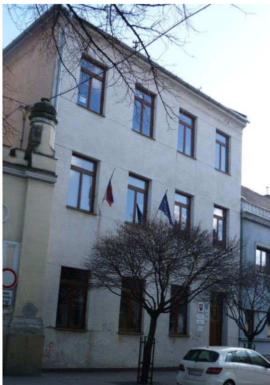
pohľad na priečelie budovy
