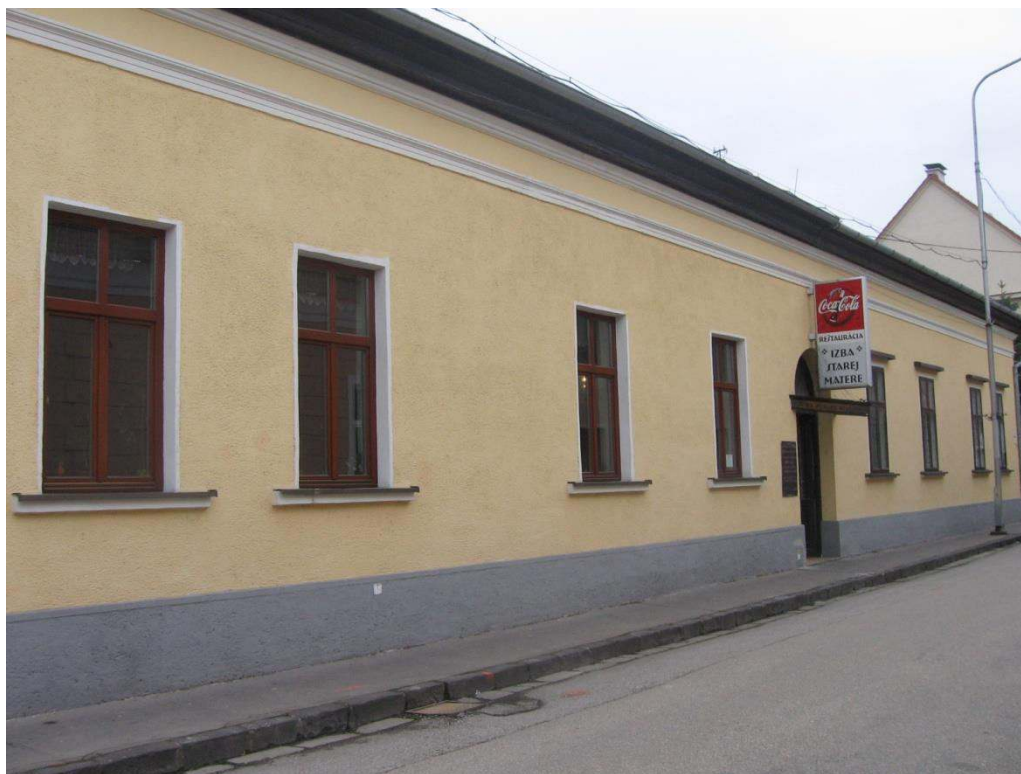
pohľad na priečelie budovy
