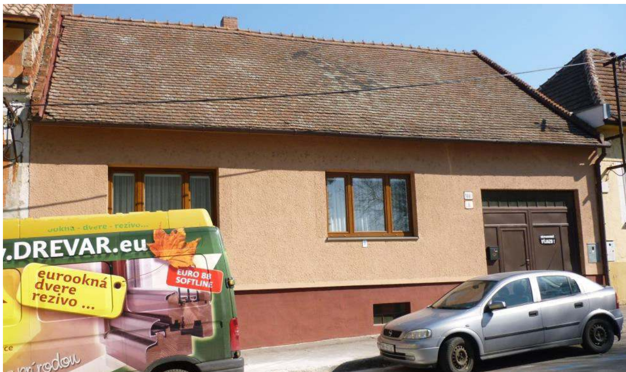
pohľad na priečelie budovy
