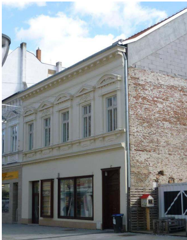
pohľad na priečelie budovy
