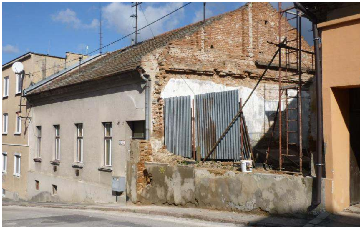
pohľad na priečelie budovy
