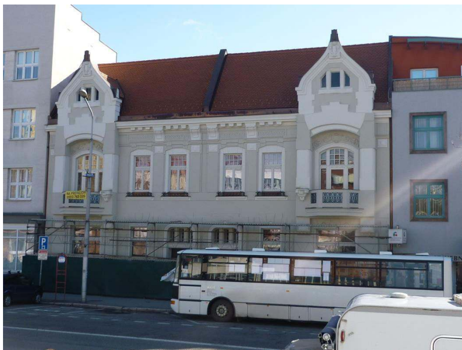
pohľad na priečelie budovy
