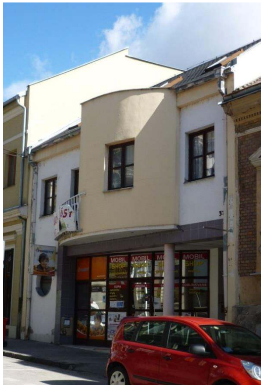
pohľad na priečelie budovy
