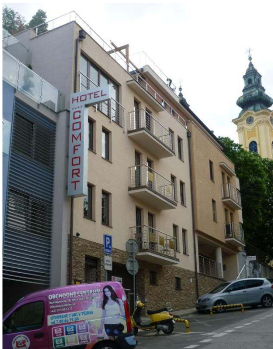
pohľad na priečelie budovy
