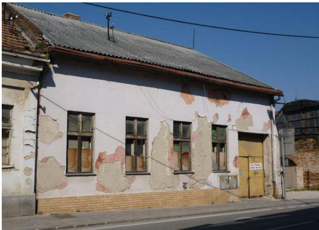
pohľad na priečelie budovy
