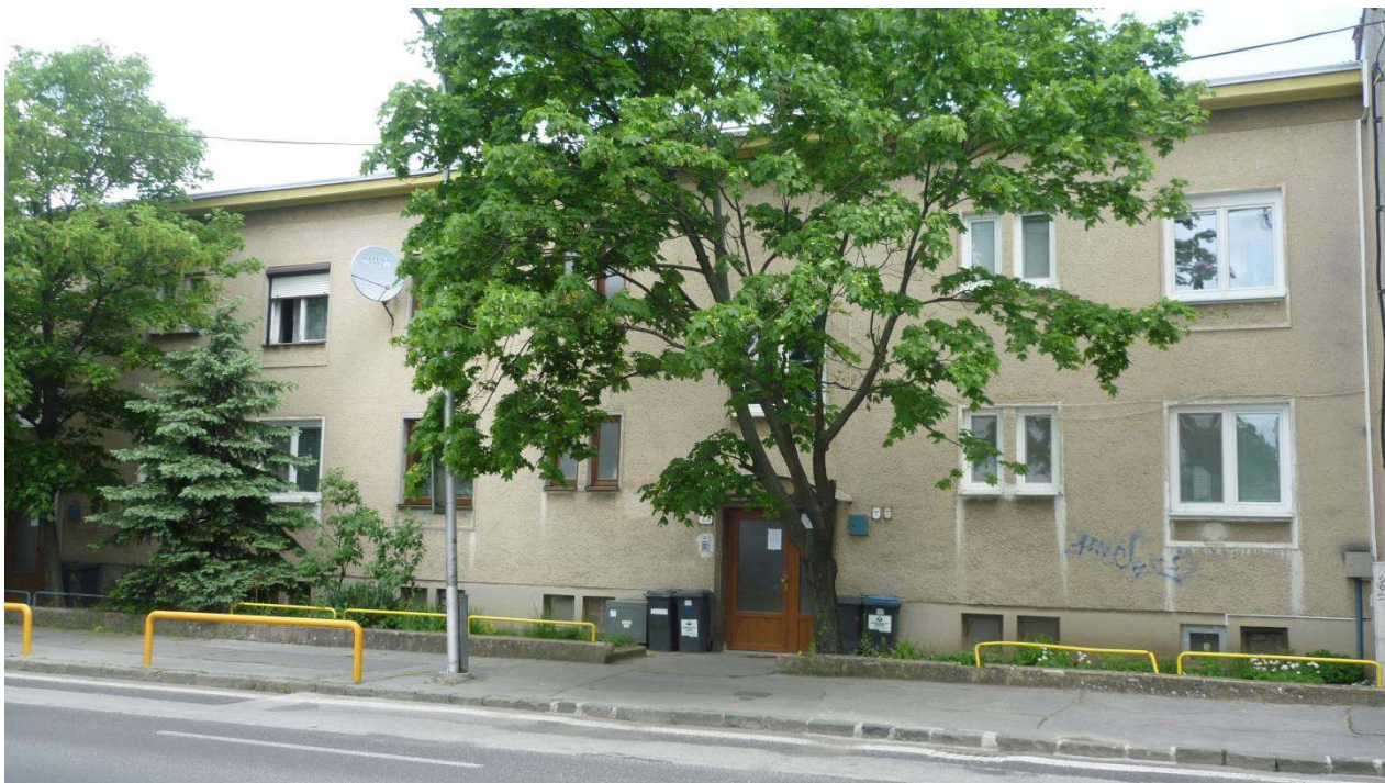
pohľad na priečelie budovy
