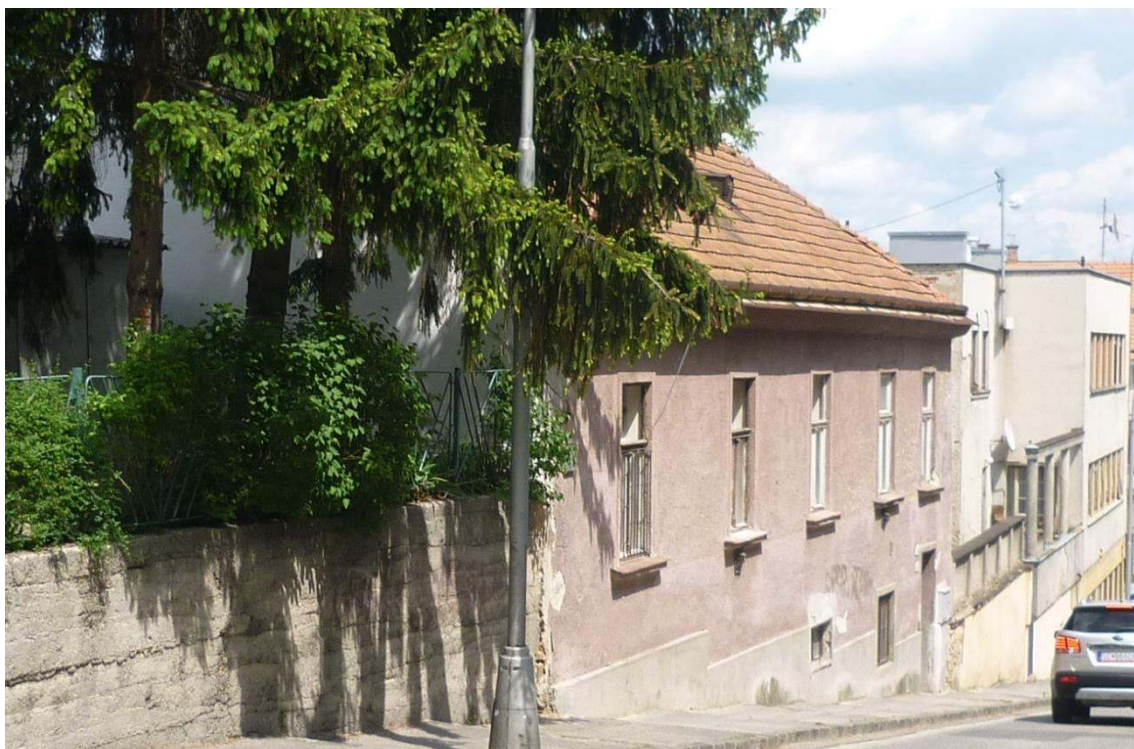
pohľad na priečelie budovy
