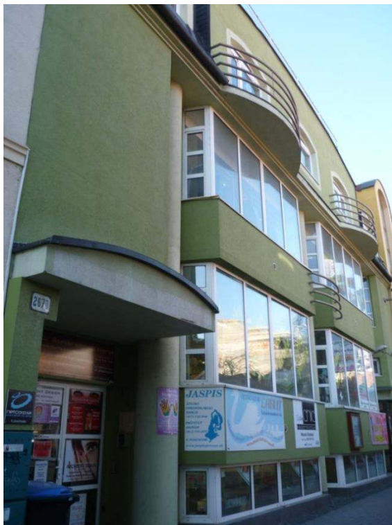
pohľad na priečelie budovy
