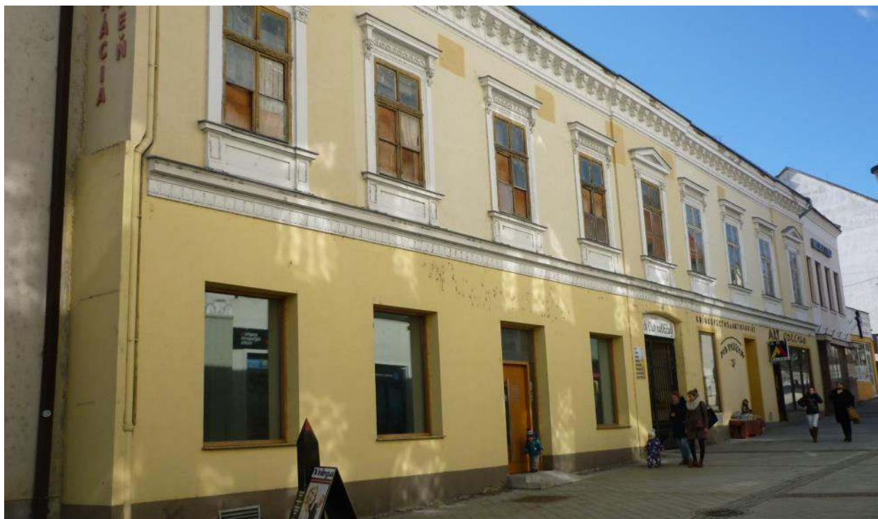
pohľad na priečelie budovy
