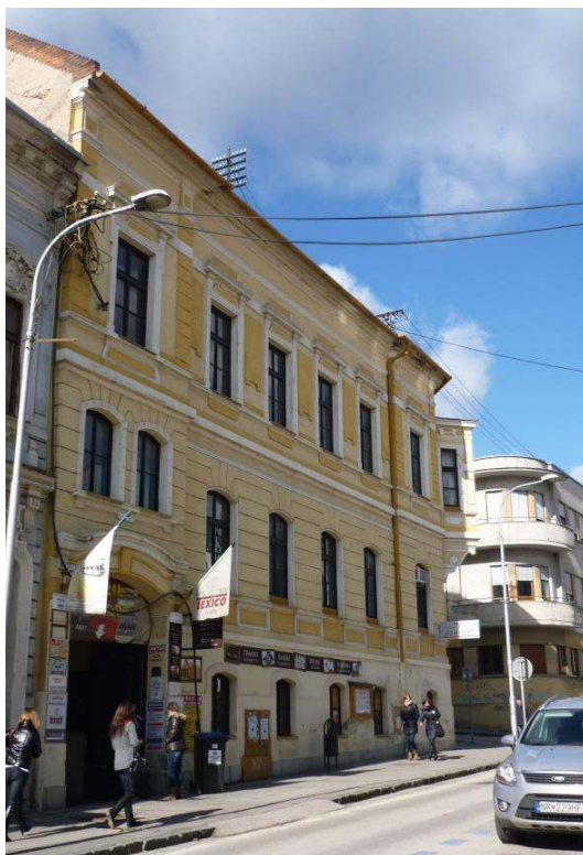
pohľad na uličnú fasádu
