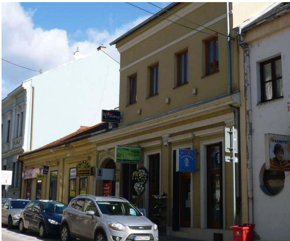
pohľad na priečelie budovy
