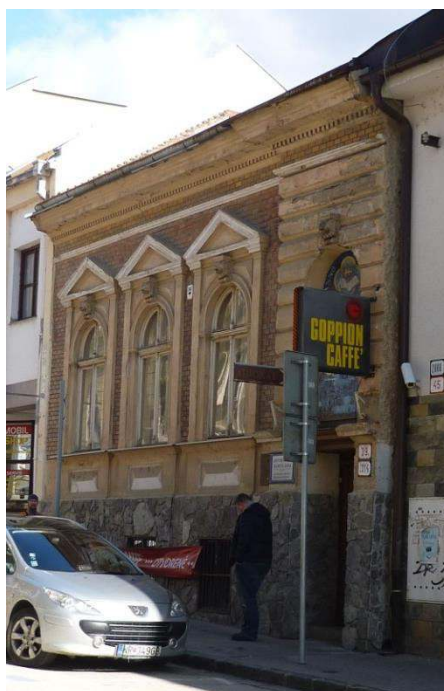
pohľad na uličnú fasádu
