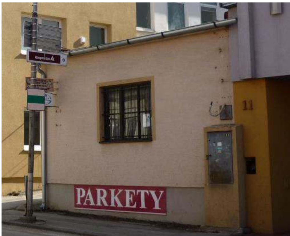
pohľad na priečelie budovy
