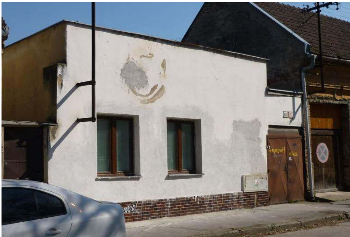
pohľad na priečelie budovy
