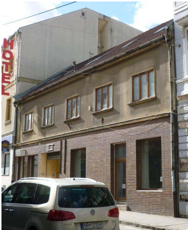
pohľad na priečelie budovy
