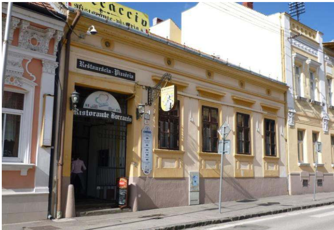
pohľad na priečelie budovy
