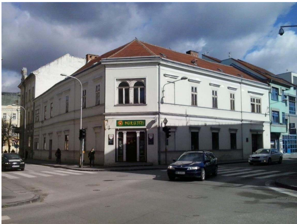
pohľad na nárožie budovy
