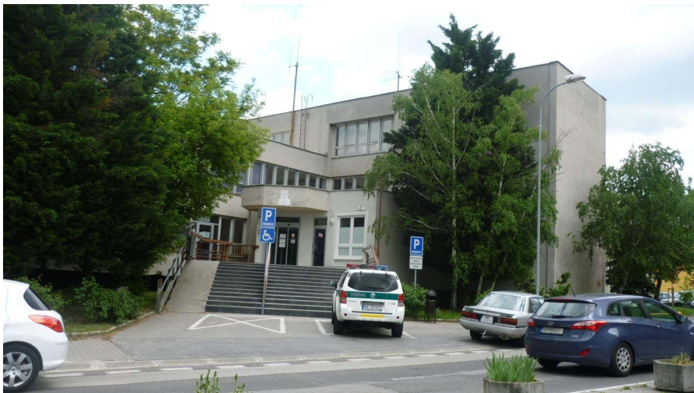
pohľad na priečelie budovy
