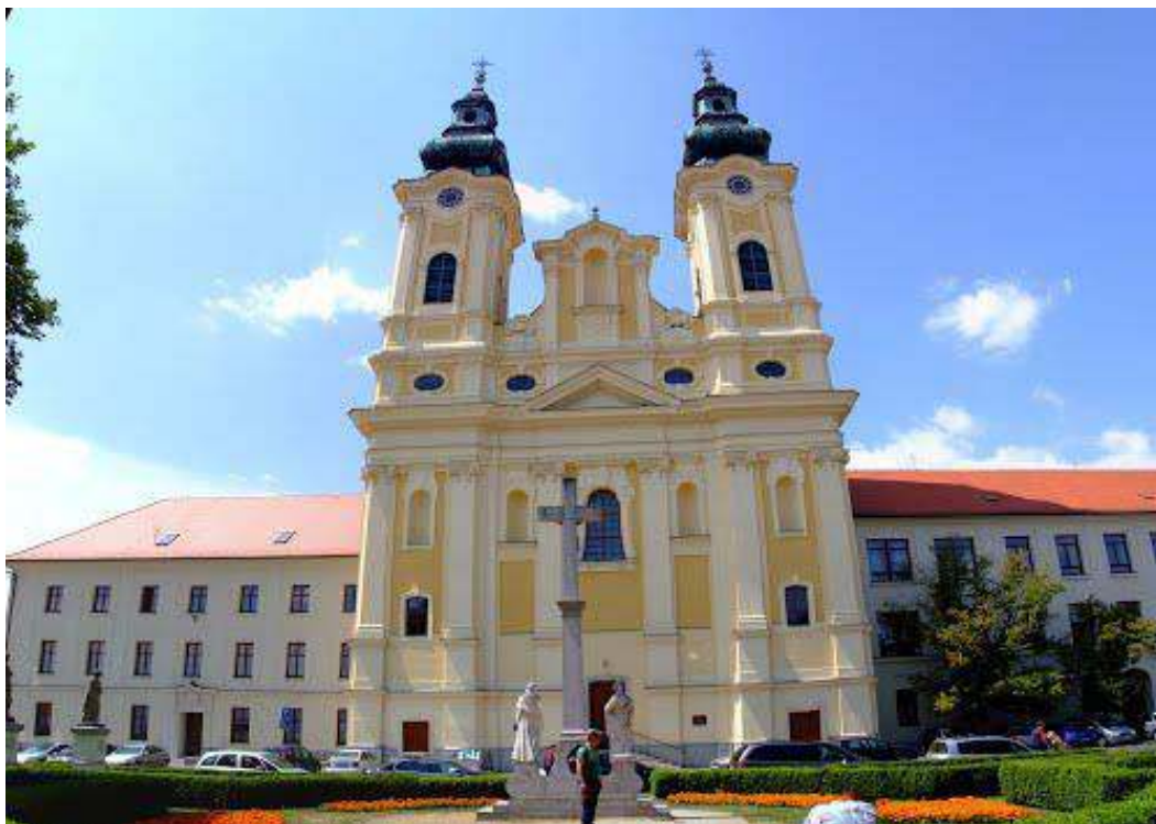
pohľad na uličnú fasádu
