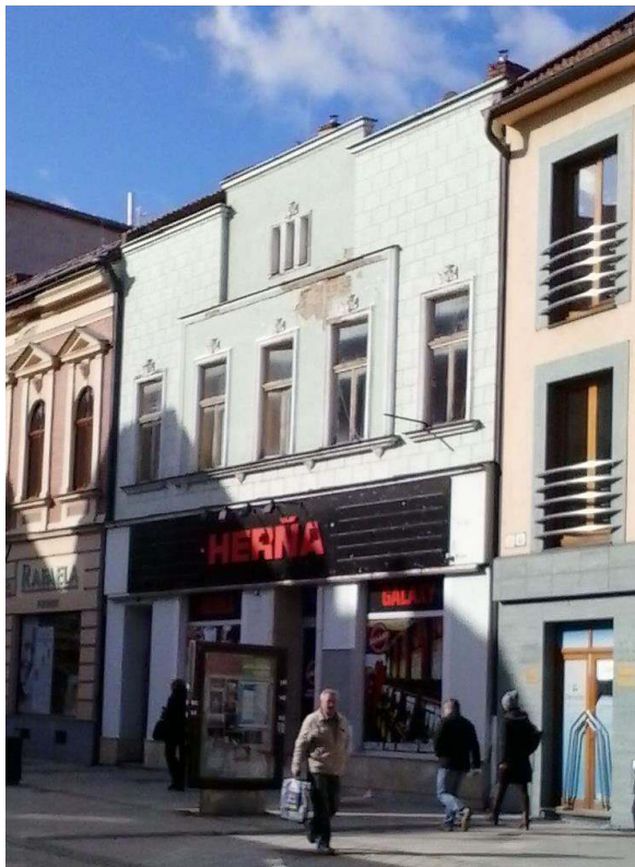
pohľad na priečelie budovy
