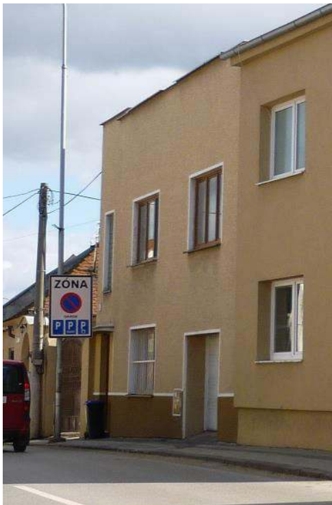
pohľad na priečelie budovy
