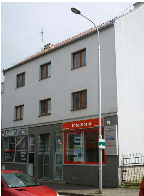
pohľad na priečelie budovy
