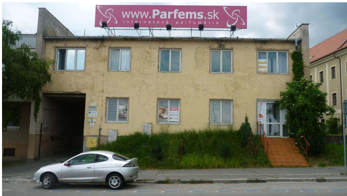
pohľad na priečelie budovy
