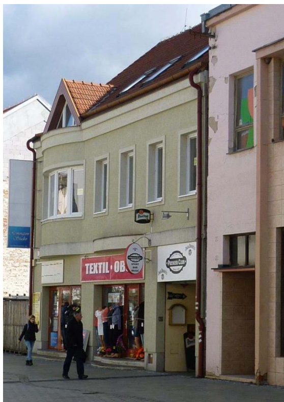
pohľad na priečelie budovy
