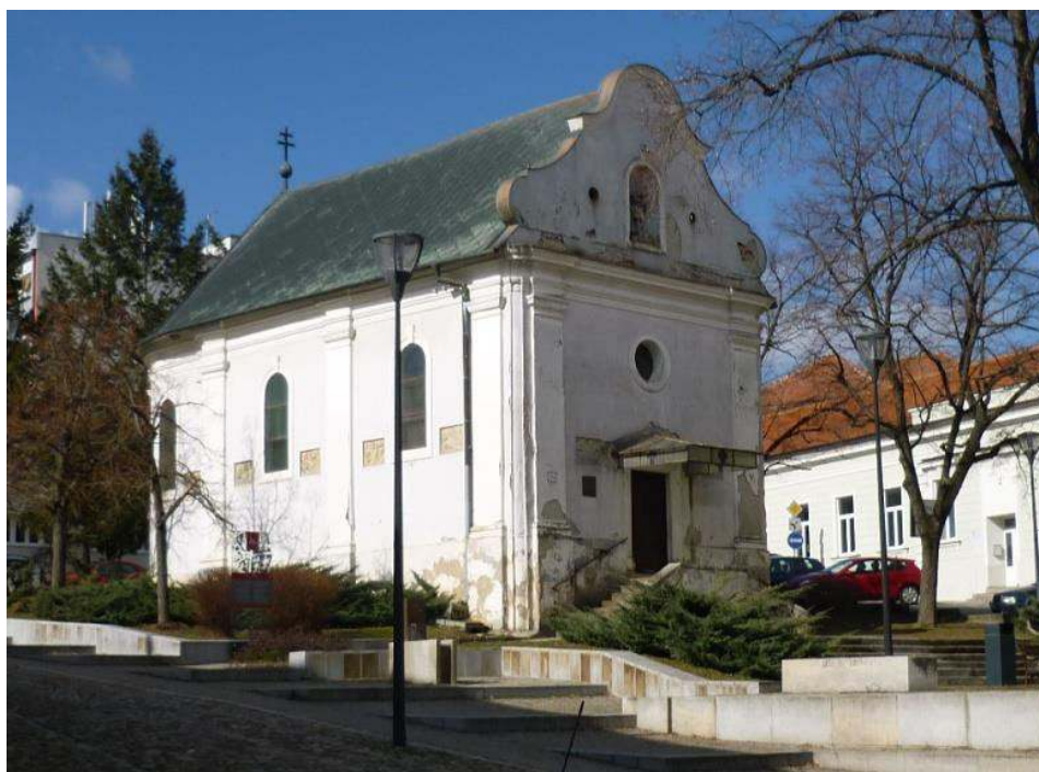
pohľad na nárožie budovy
