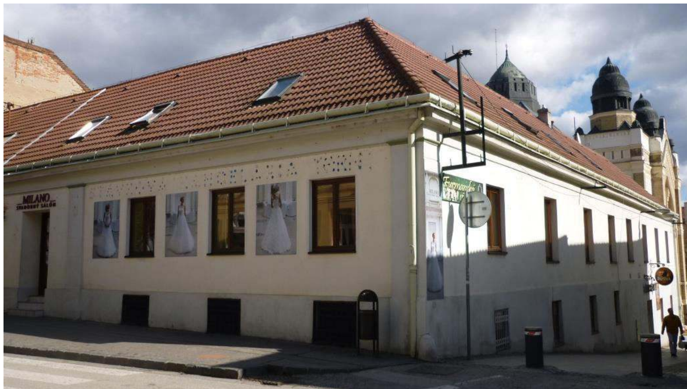
pohľad na nárožie budovy
