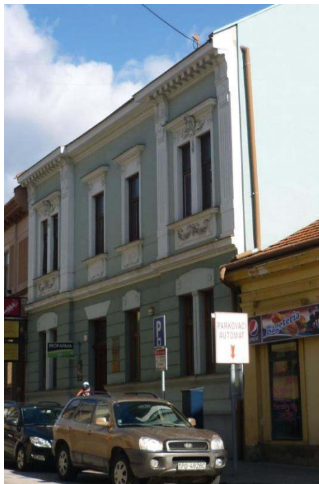
pohľad na uličnú fasádu
