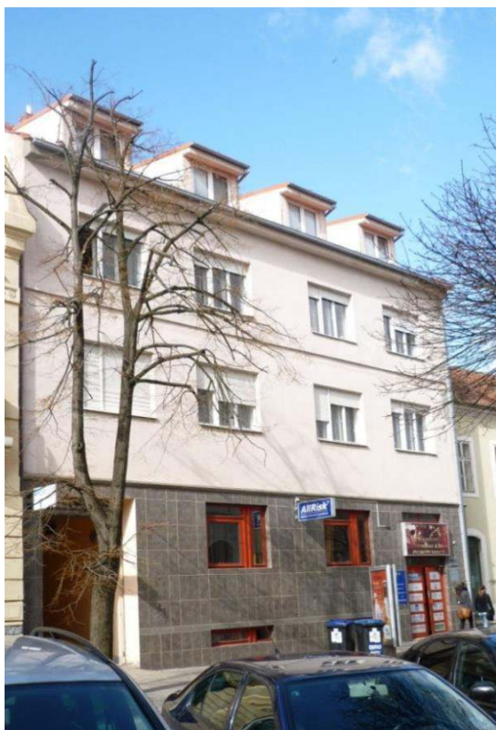
pohľad na priečelie budovy
