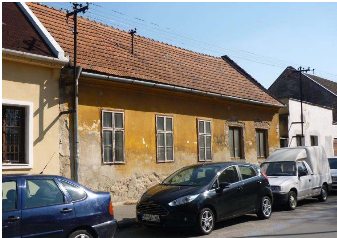
pohľad na priečelie budovy
