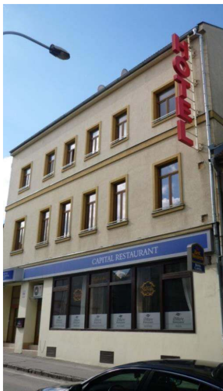
pohľad na priečelie budovy
