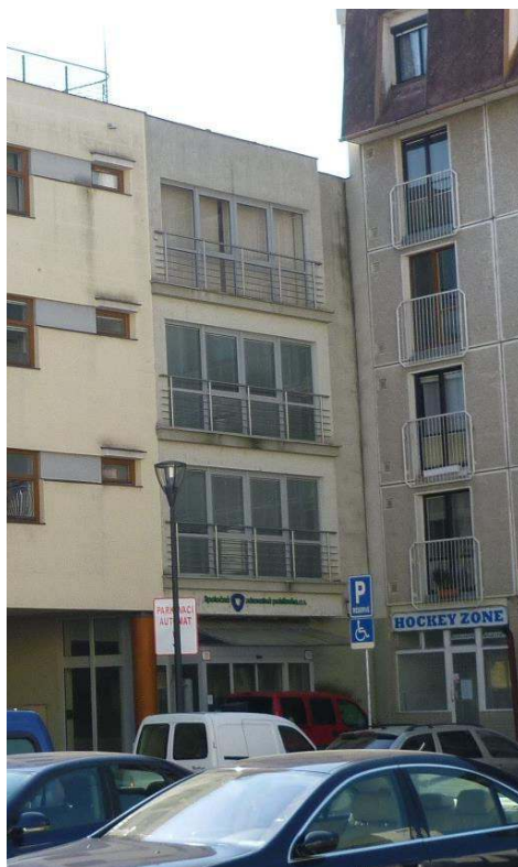
pohľad na priečelie budovy
