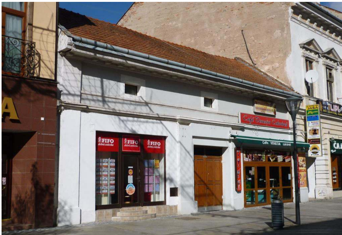
pohľad na priečelie budovy
