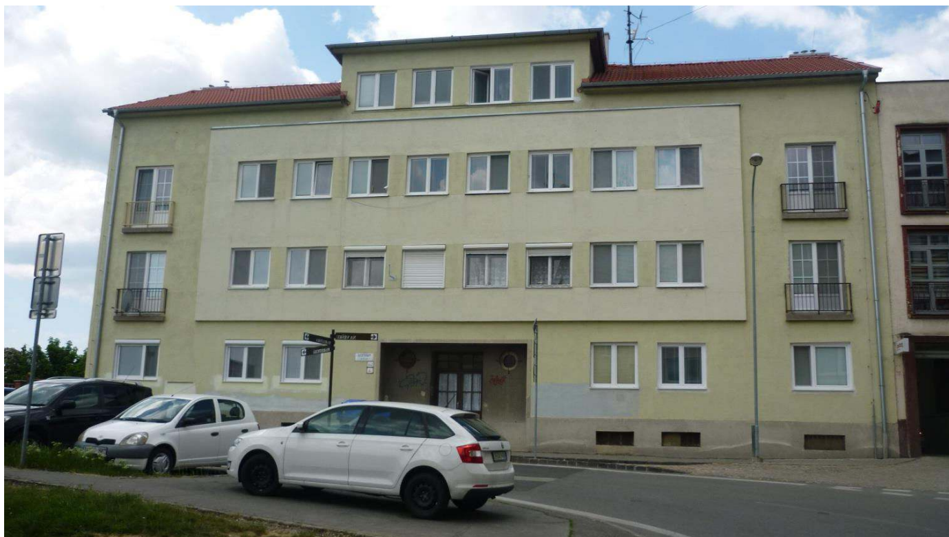
pohľad na priečelie budovy
