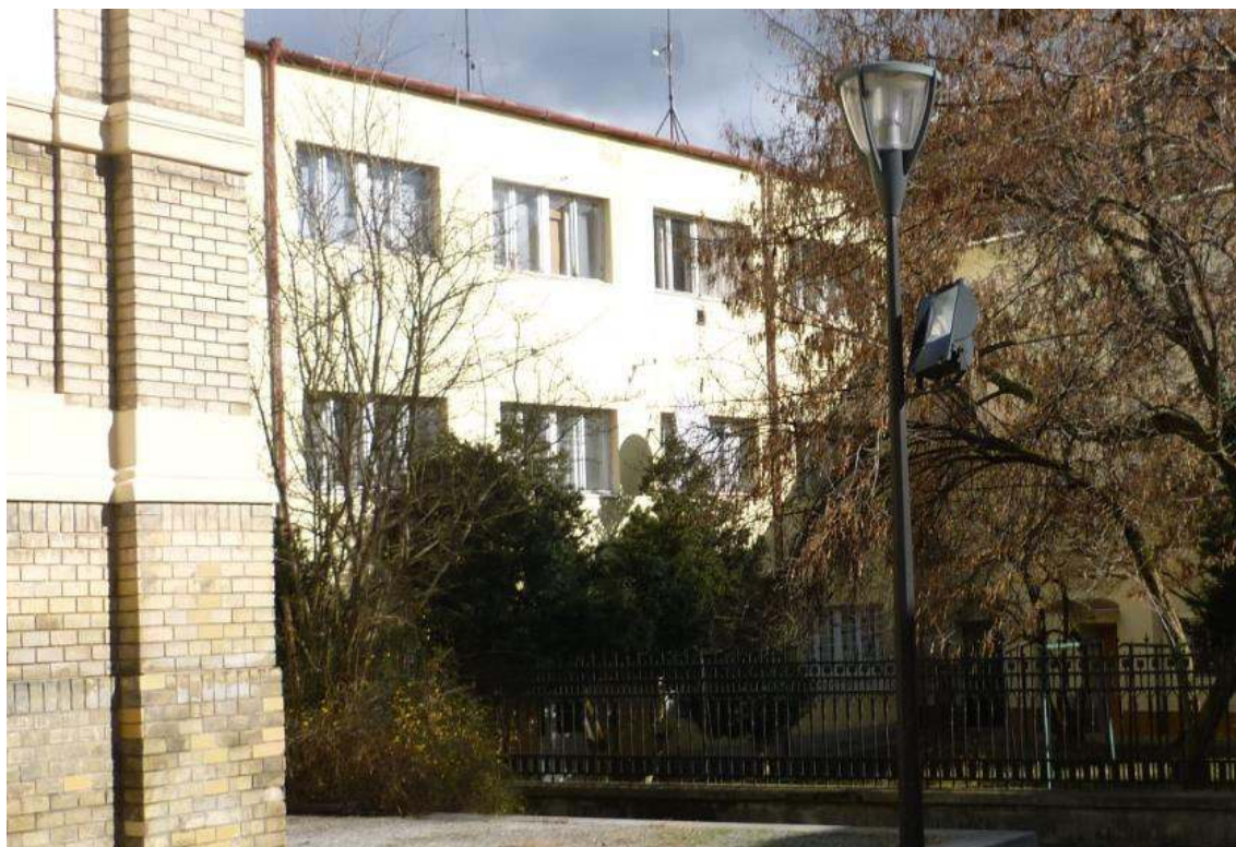
pohľad na nárožie budovy
