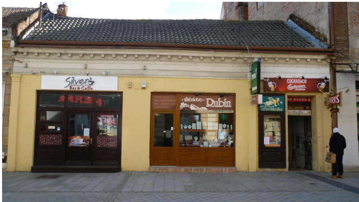
pohľad na priečelie budovy
