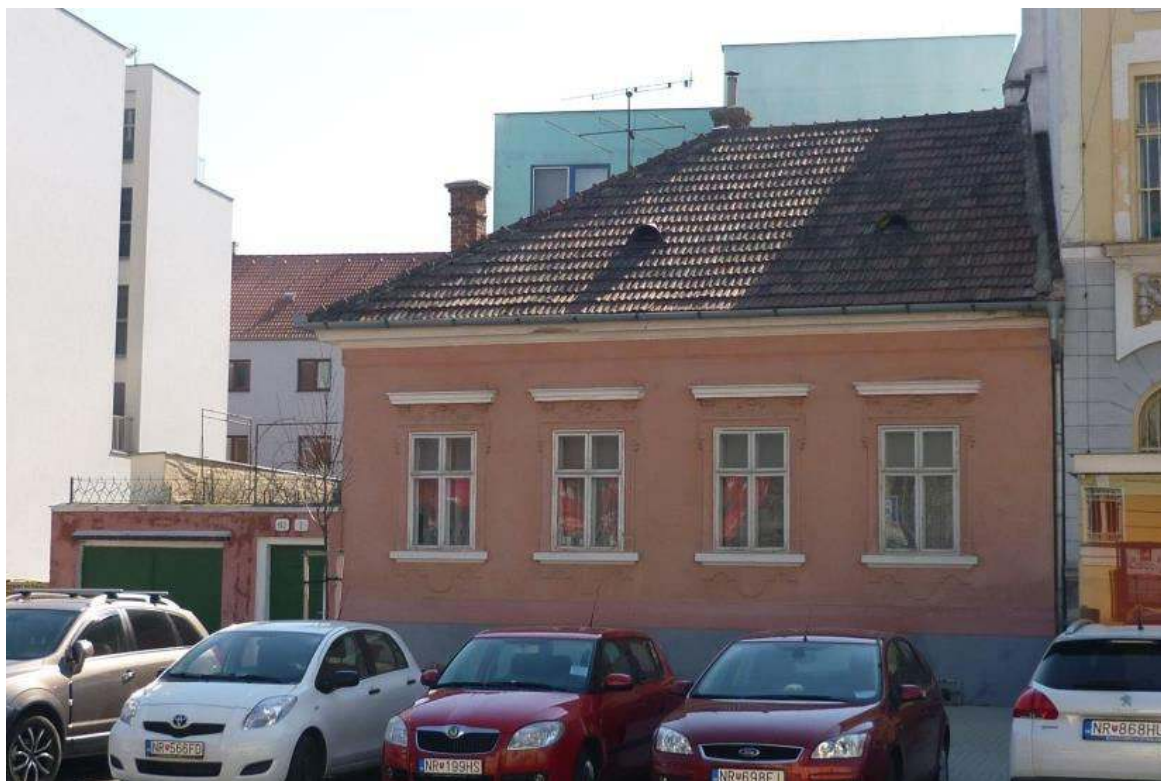
pohľad na priečelie budovy
