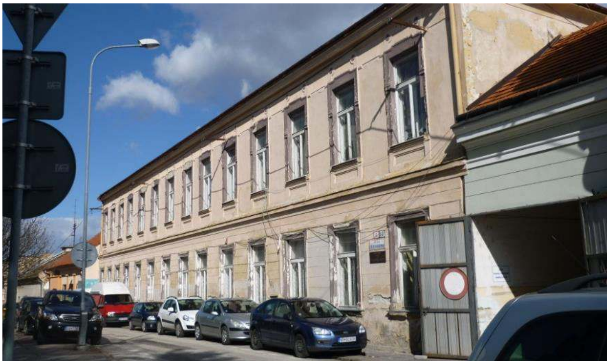
pohľad na priečelie budovy
