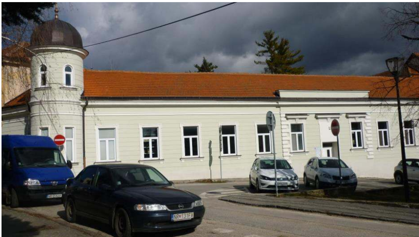
pohľad na priečelie budovy
