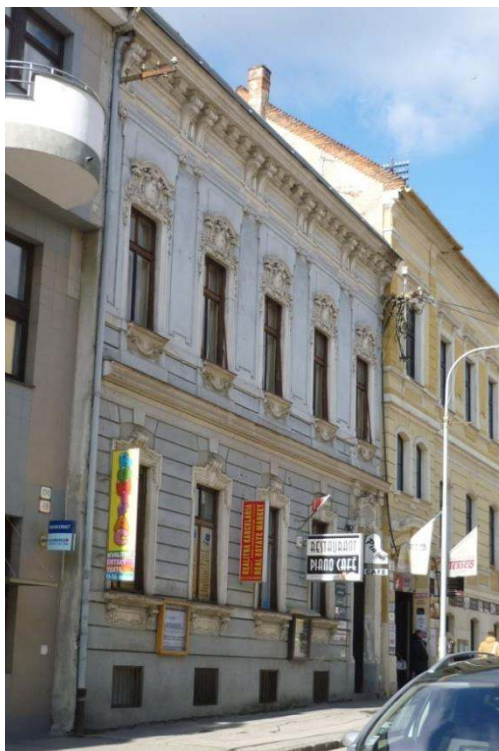
pohľad na uličnú fasádu
