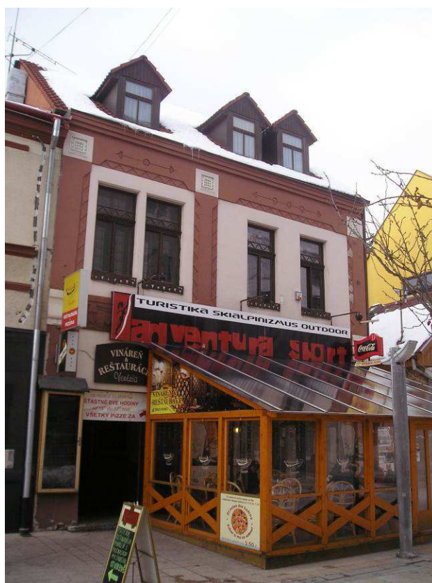
Č. 18. Foto na nevhodne riešené presvetlenie priestorov podkrovia väčším počtom neproporčných vikierov na budove Ul. 29.augusta č. 11, východná fasáda
