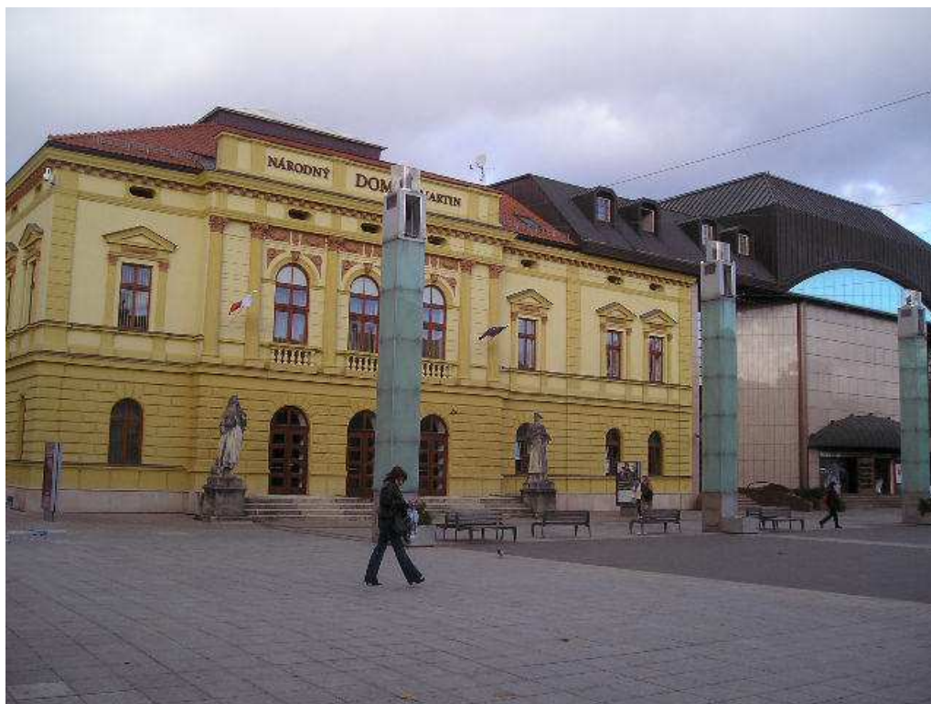
Foto č.19: Pohľad na Národný dom na nároží ul. Kmeťovej a Divadelnej od JV
