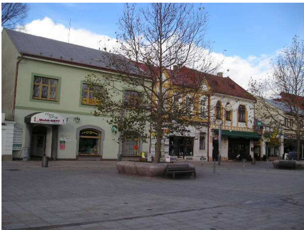
Č. 3. Foto na hodnotnú hmotovú skladbu zástavby Ul. 29.augusta č.2 až 4 s typicky prejazdovými meštianskymi domami dvojpodlažnými so sedlovým zastrešením paralelným s komunikačnou osou
