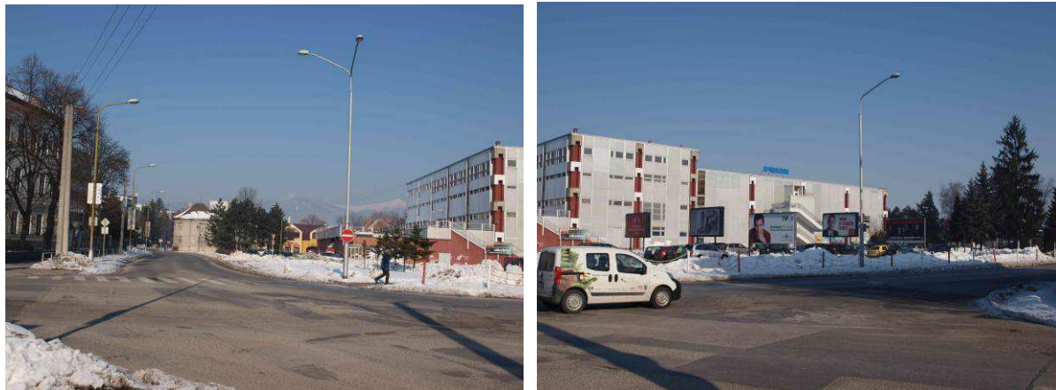
Č. 12. Foto na zaniknutú zástavbu námestia (západná strana) okolo kostola v popredí Obchodným domom PRIOR, v rámci návrhu reanimácie námestia je v tomto rezervnom priestore navrhnutá bloková zástavba 3. až 4. podlažná
