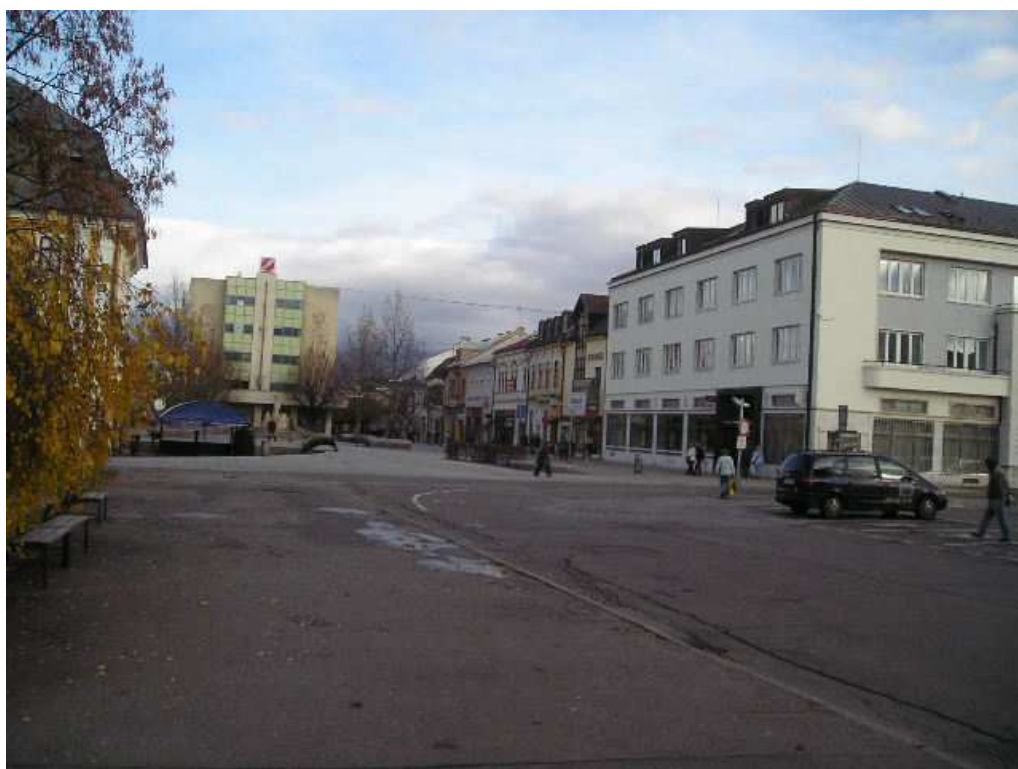
Foto č.12: Pohľad na VÚB a.s., na nároží ul. Štefánikovej a Sokolíčkovej od JZ
