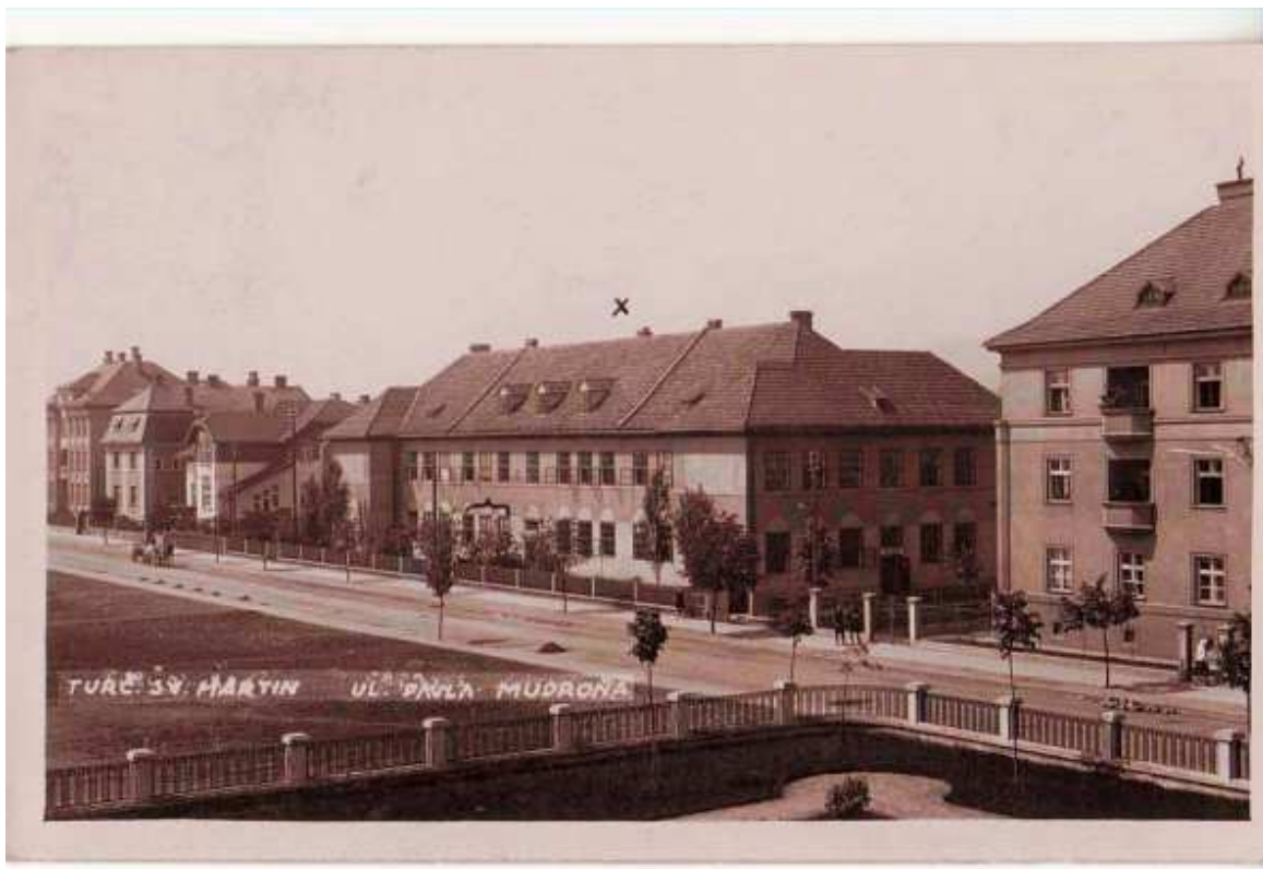
64. Pohľad na severnú časť Ul. Mudroňovej v popredí s objektom Provizórneho gymnázia (Základnej umeleckej školy) s pôvodnou výzdobou fasád, foto zo 40.rokov 20.storočia, archív KPÚ Žilina pracovisko Martin
