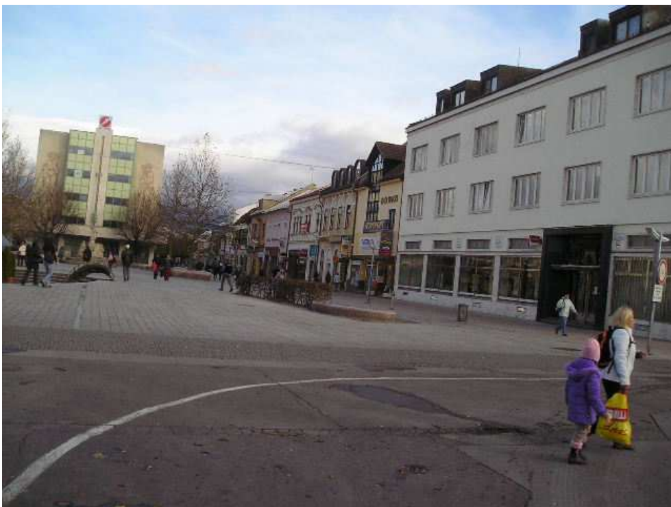
Č. 1. Foto na hodnotnú hmotovú skladbu zástavby Ul. M. R. Štefánika č.6 až 14 s typicky prejazdovými meštianskymi domami dvojpodlažnými so sedlovým zastrešením paralelným s komunikačnou osou
