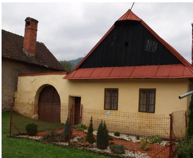
Dom ľudový na ul. Riadok č. 119 vytypovaný na zápis do ÚZPF. Pred objektom realizovaná nevhodná úprava predzáhradky
