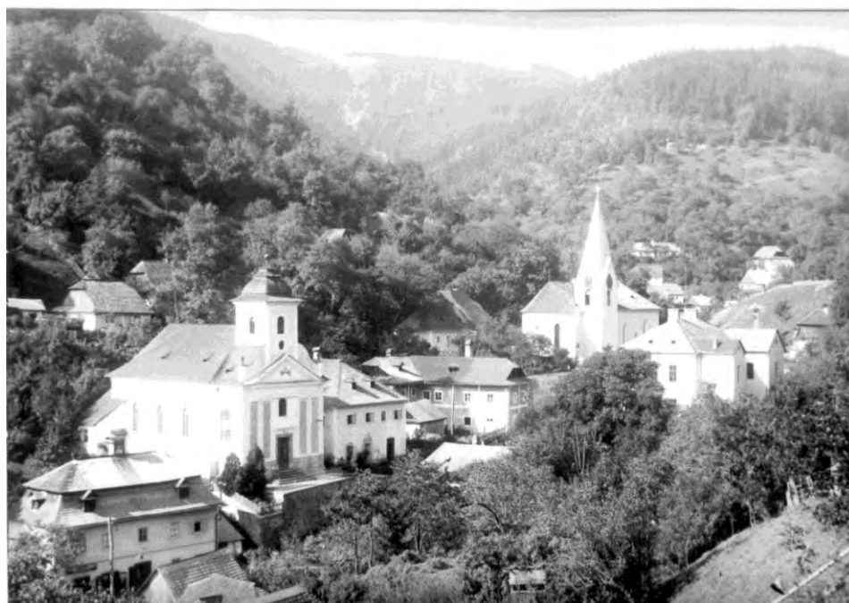
Obr. 2 – Centrum Banskej Hodruše v roku 1970 (zdroj: archív KPÚ Banská Bystrica, pracovisko B. Štiavnica)
