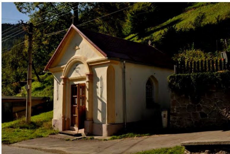
Obr. 28 Kaplnka sv. Jána Nepomuckého, parc. C-KN č. 769
