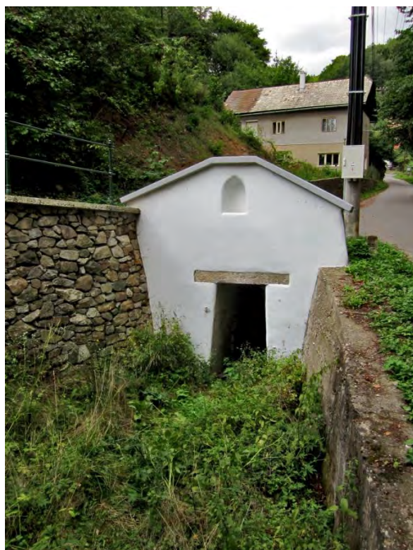
2. Vstupný portál štólne Birnbaum (parc. C-KN č. 1105)
