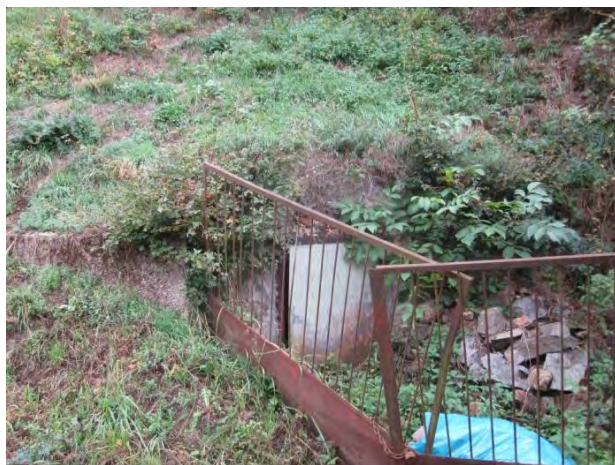
4. Vstupný portál štólne Ignác (parc. C-KN č. 1444/2)
