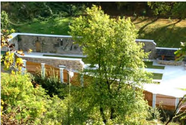
16. Pozostatky stupovej úpravne na parc. C-KN č. 1553/1 - 7
