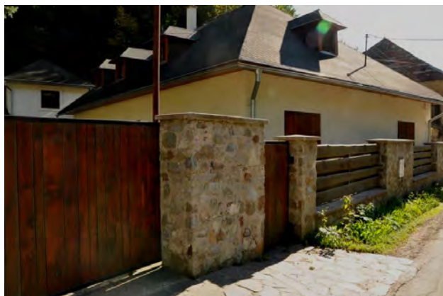
Nevhodný tvar strechy a presvetlenia podkrovia, nevhodná strešná krytina, cudzorodé architektonické riešenie oplotenia
