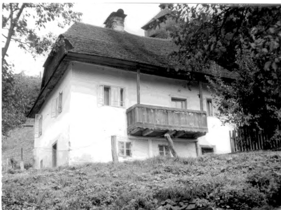
Obr. 11 –Banská Hodruša, dom č. 156 (zdroj: archív KPÚ Banská Bystrica, pracovisko B. Štiavnica)
