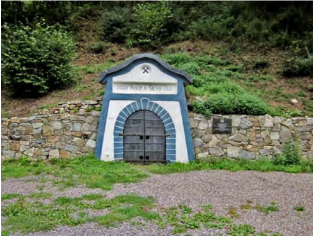
18. Dolný prekop k šachte Lill (parc. C-KN č. 1568/2)
