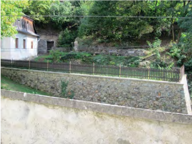
5. Ústie štôlne za budovou bývalej správy závodu šachty Michal so svojou haldou (parc. C-KN č. 1386)
