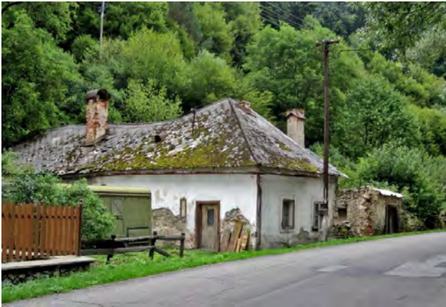
24. Prevádzkový objekt bane Všetkých svätých (parc. C-KN č. 1597/1)
