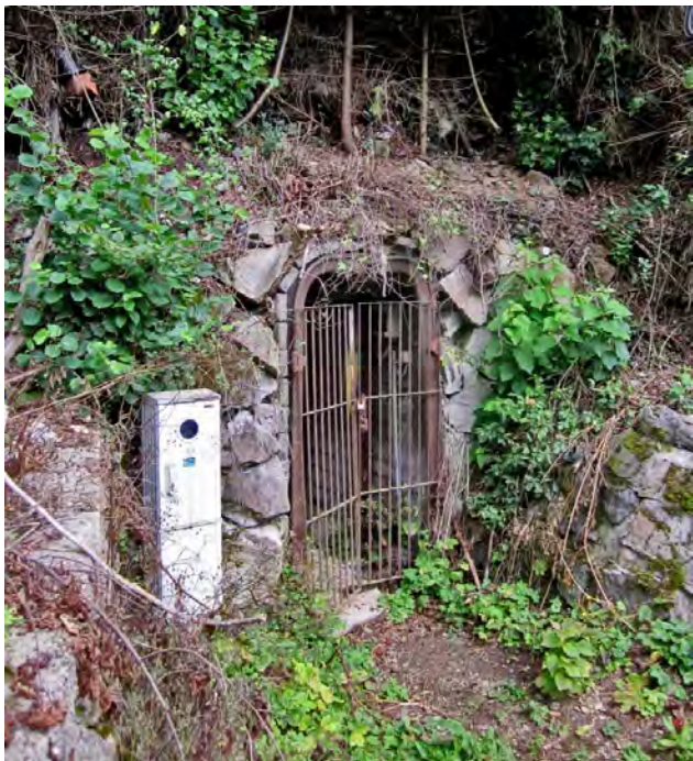
1. Vstupný portál štólne Mikuláš (parc. C-KN č. 1303)
