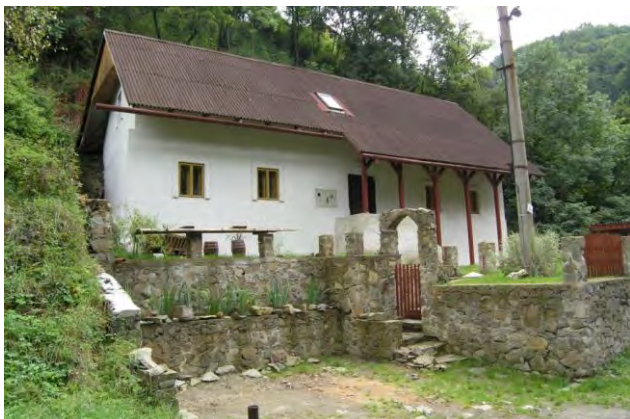
Nadstavba vysokej strešnej nadmurovky
