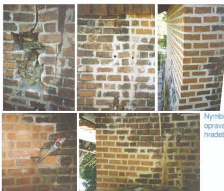
Nymburk – oprava hradieb
