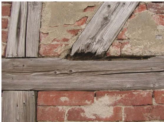
► Obr. 63 a, b. Typické poruchy hrazdeného muriva, a – hniloba spojov; b – hniloba v styku so soklom; stodola, Opálka, 19. storočie.
