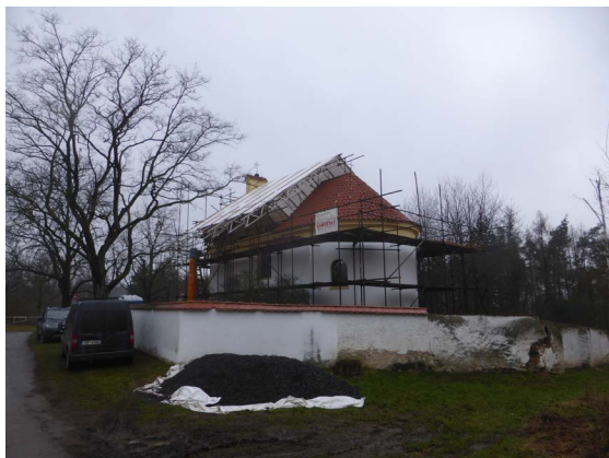
► Obr. 58 a, b. Provizórne zastrešenie celej stavby; kaplnka sv. Václava, Praha-Suchbát; kostol sv. Michala, Praha-Petřín.
