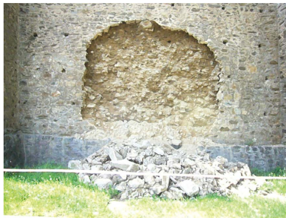
► Obr. 21. Hradba z lomového muriva, ktorá tvorí líce zemného násypu, bola vyškárovaná cementovou maltou. Utesnené líce zadržovalo vodu prenikajúcu z násypu, pôsobením vlastnej tiaže sa narušené líce zrútilo; Hrad Klenová.
