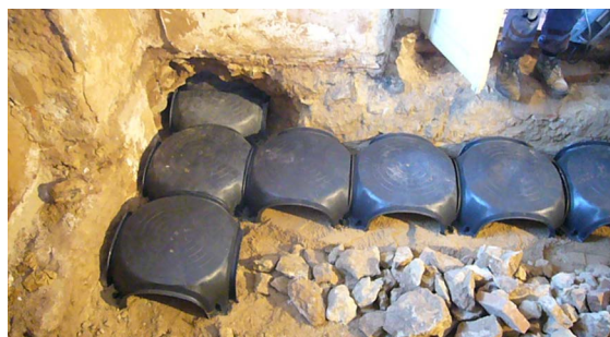
► Obr. 15. Vetrací kanál pod podlahou z tvarovek iglú; Stranské.
