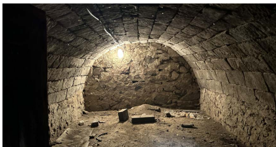
► Obr. 20. Časť valenej klenby z kameňa formátovaného do blokov (soklové murivo je z lomového kameňa), Pivnica, Sklabína.
