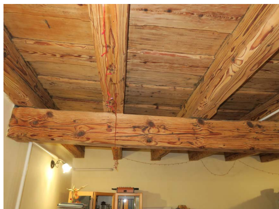
► Obr. 25. Drevený trámový strop podopretý meštanicou. Historické nátery boli odstránené brúsením a strop je ponechaný bez povrchovej úpravy, evanjelická fara, Banská Štiavnica.
