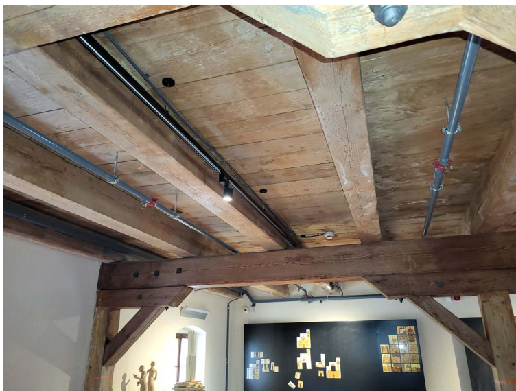
► Obr. 46. Pohľad na drevený trámový strop s novým osvetlením a požiarnymi zariadeniami, Pivovar, Plasy.
