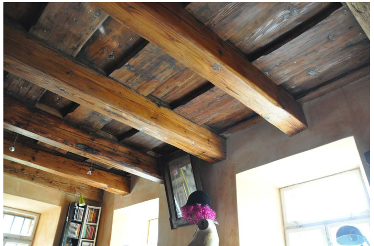
► Obr. 7. Drevený trámový strop po oprave. Historické náterové vrstvy boli odstránené brúsením a povrch stropu je upravený bezfarebným lazúrovým náterom, banický dom, Banská Štiavnica.
