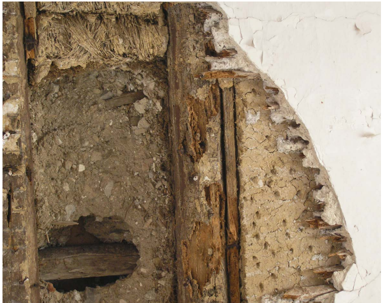
► Obr. 31. Drevený trámový strop počas obnovy (detail) so spodným záklopom z drevených latiek omotanými slamenými povrieskami impregnovanými v hlinenej kaši, meštiansky dom, Banská Štiavnica.
