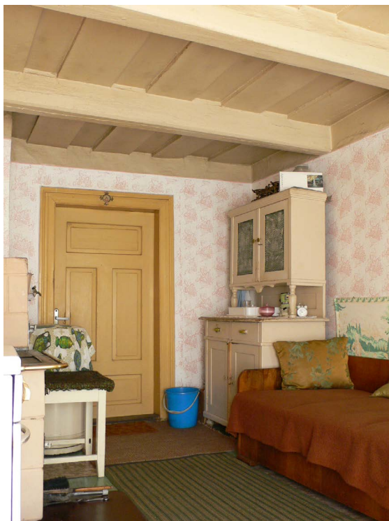
►► Obr. 9. Drevený trámový strop natretý náterom na báze vápna, meštiansky dom, Banská Štiavnica.
