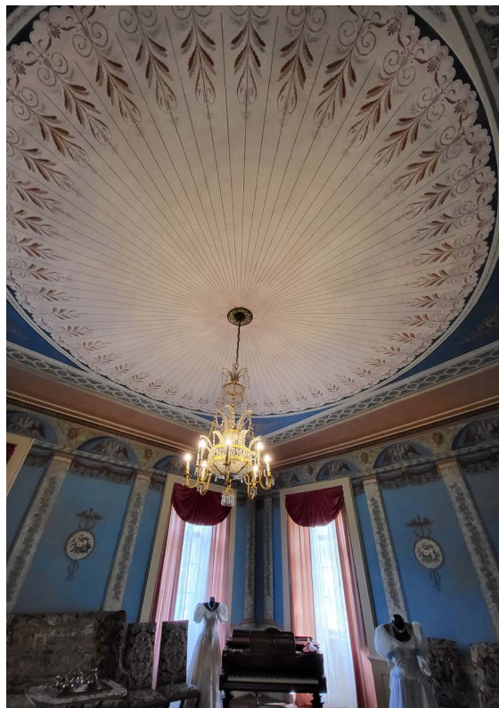
► Obr. 35. Drevený povalový strop so spodným omietaným záklopom s dekoratívnou maľbou, kaštieľ, Svätý Anton.
