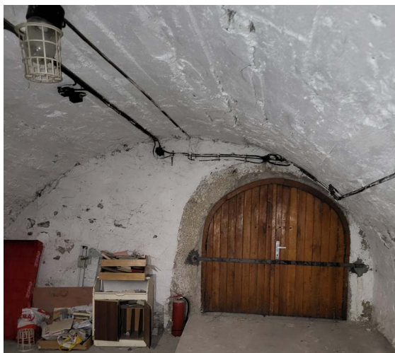
►► Obr. 21. Vstupná hala zaklenutá sériou pruských klenieb, Kaštieľ, Tajná.
