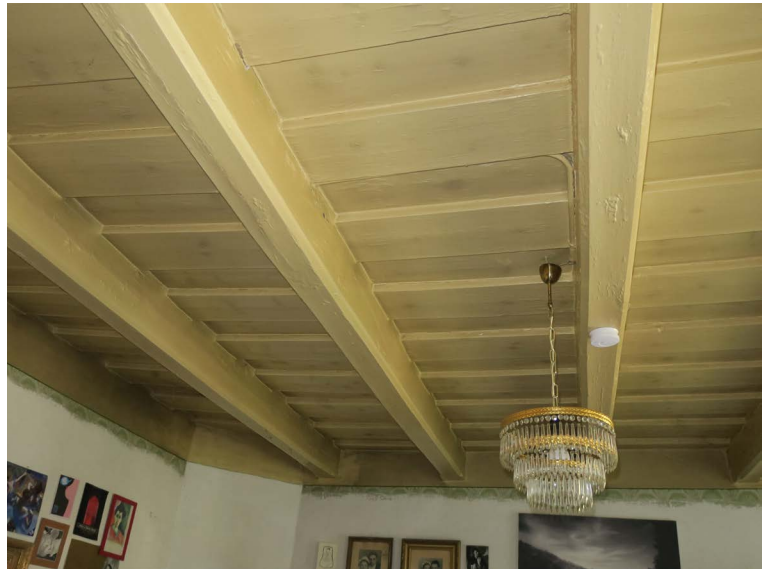
► Obr. 6. Zachovaný drevený trámový strop v obytnej izbe, povrch upravený krycím náterom na báze oleja, evanjelická fara, Beluj.
