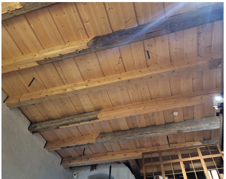
► Obr. 32. Oprava dreveného trámového stropu protézovaním, Pivovar, Plasy.
