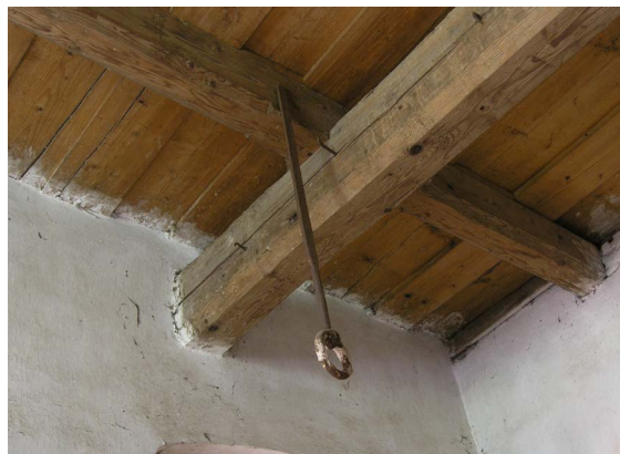
► Obr. 28. Drevený trámový strop podopretý spodnou mešternicou, Banská Štiavnica.
