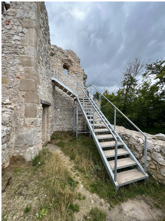
► Obr. 23. Hrad Tematín, schodisko situované vo východnom paláci.
