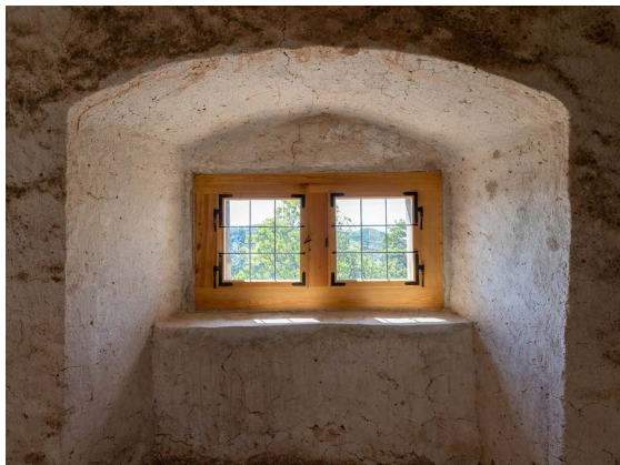
► Obr. 42, 43. Hrad Uhrovec, nika okna s pôvodnými omietkami.
