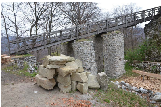
► Obr. 37. Hrad Uhrovec, drevený prístupový most osadený na murovaných pilieroch a skalnom previse.
