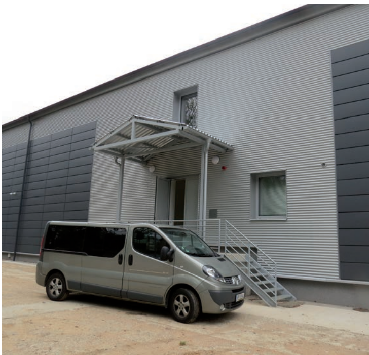
2. Nový depozitář TMB v Brně – Řečkovicích
