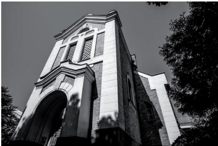
16. Exteriér čerpacej stanice, 2017
