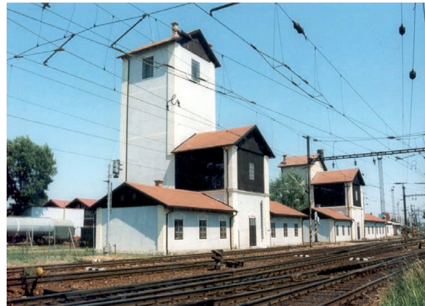
3. Obnovené vodárne v roku 1998
