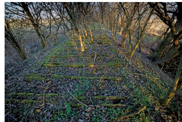
24. Zachované teleso trate Viedenskej električky z obdobia Nemeckých ríšskych dráh na Kapitulských poliach. Stav k 21. 3. 2016. Foto Miroslav Pokorný.
