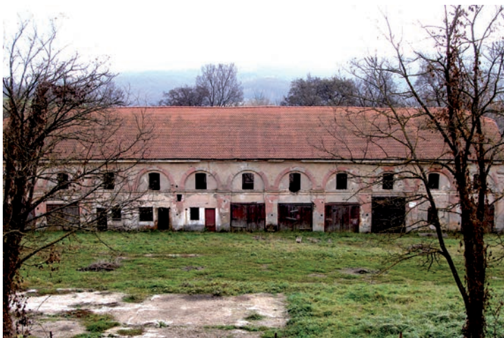
5. Sklad bývalej Andrásyovskej železiarne v Drnave
